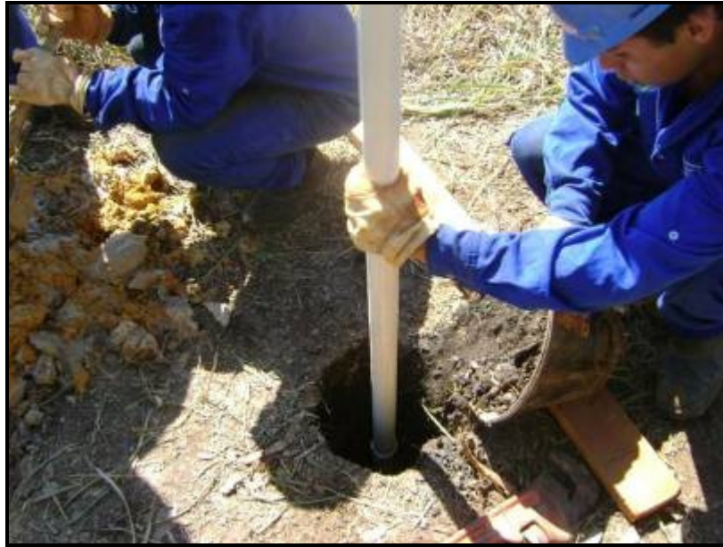
Figura 143 – Inserção da tubulação do poço PP-08.
