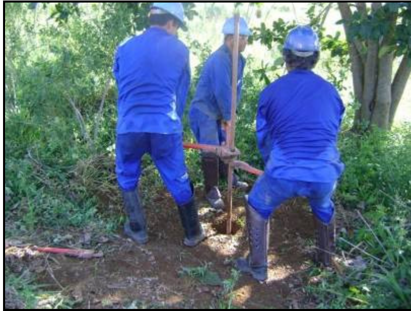
Figura 42 – Execução da sondagem ST-01.
