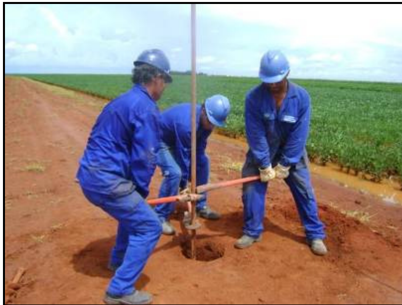
Figura 82 – Execução da sondagem ST-18.
