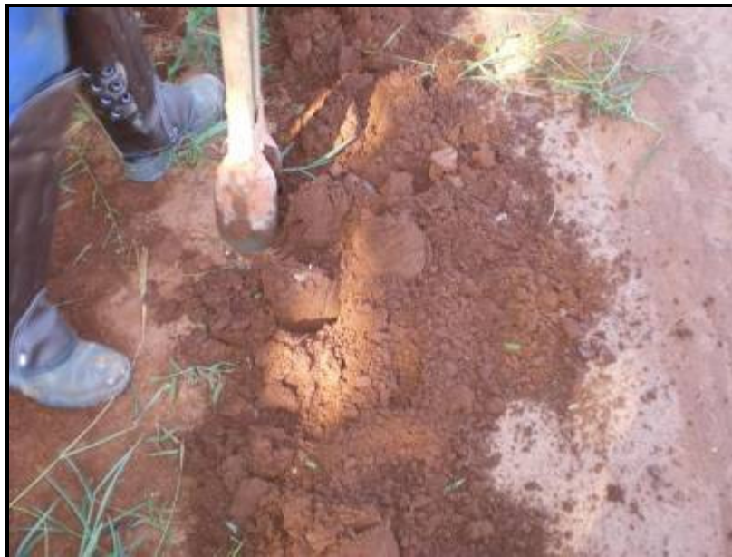
Figura 50 – Solo argiloso residual da ST-04.
