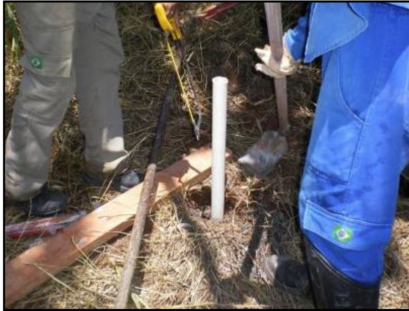
Figura 149 – Instalação do poço PP-07.
