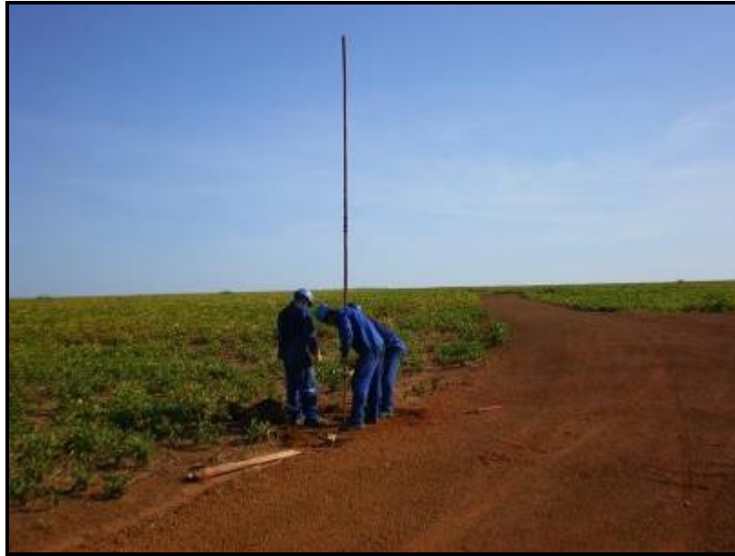
Figura 52 – Execução da sondagem ST-05.
