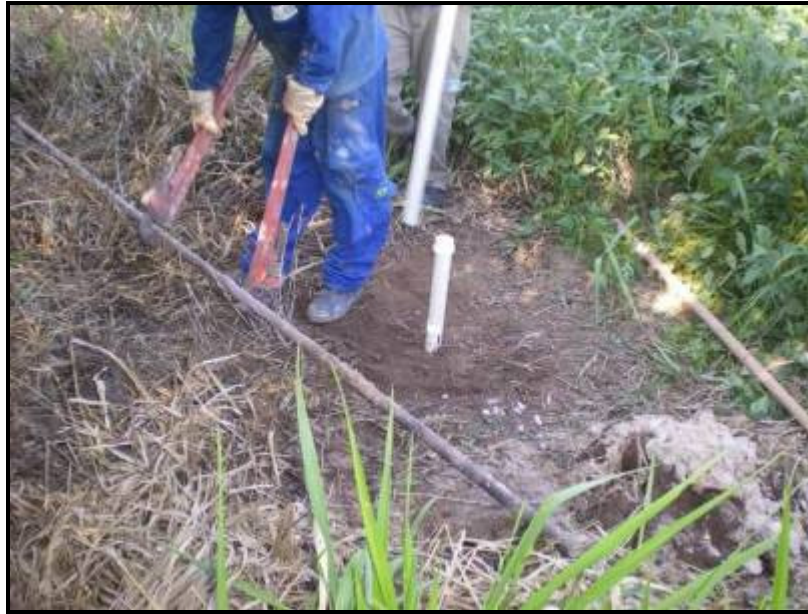
Figura 151 – Poço PP-14 finalizado.
