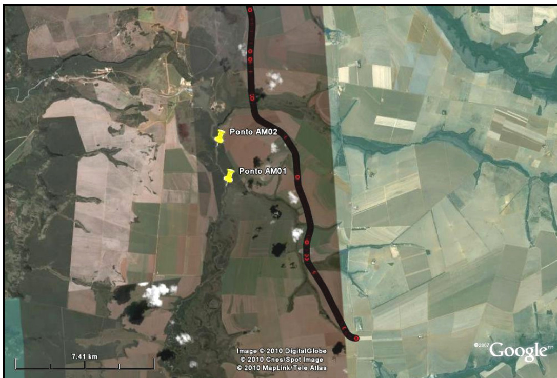
Figura 107 - Indicação dos pontos de coleta sobre o rio Itiquira e a proximidade com o traçado da ferrovia.
