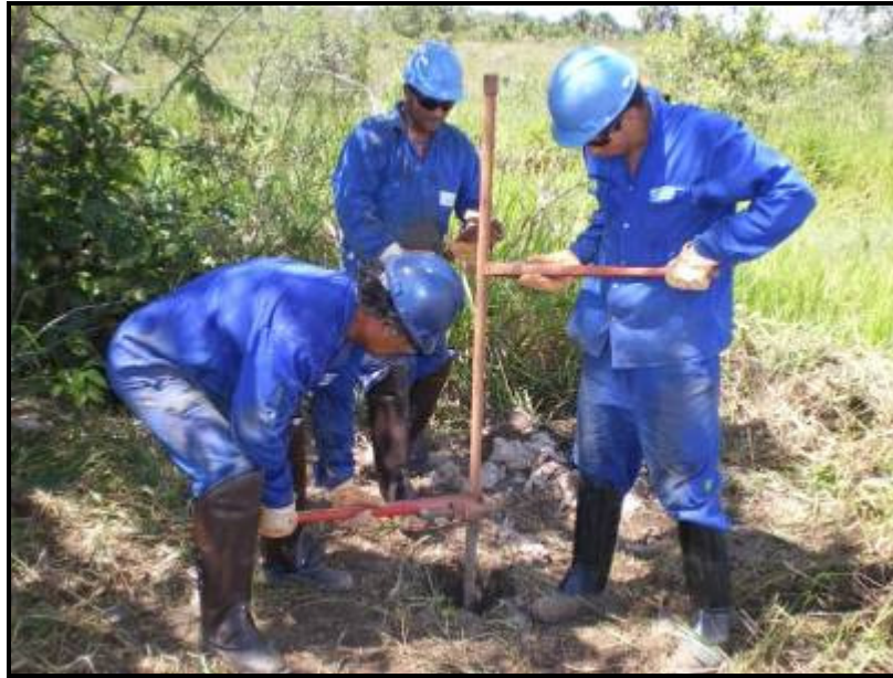
Figura 59 – Execução da sondagem ST-08.
