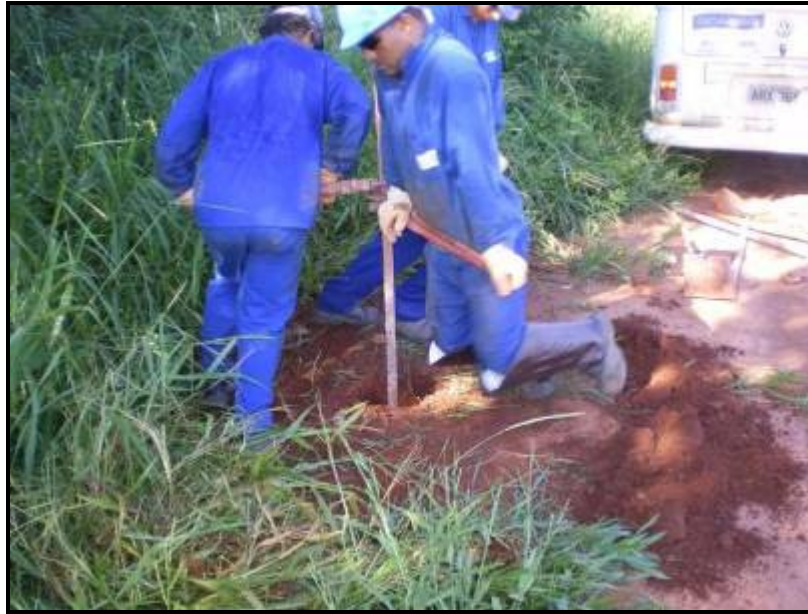
Figura 49 – Execução da sondagem ST-04
