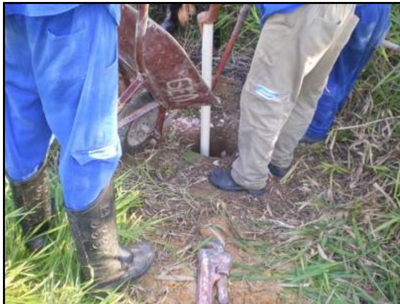
Figura 152 – Instalação do poço PP-15.
