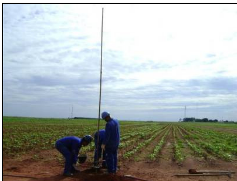
Figura 80 – Execução da sondagem ST-16
