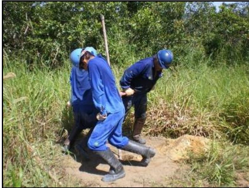
Figura 54 – Execução da ST-06.
