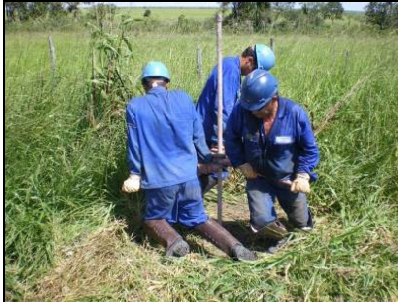
Figura 67 – Execução da sondagem ST-12.
