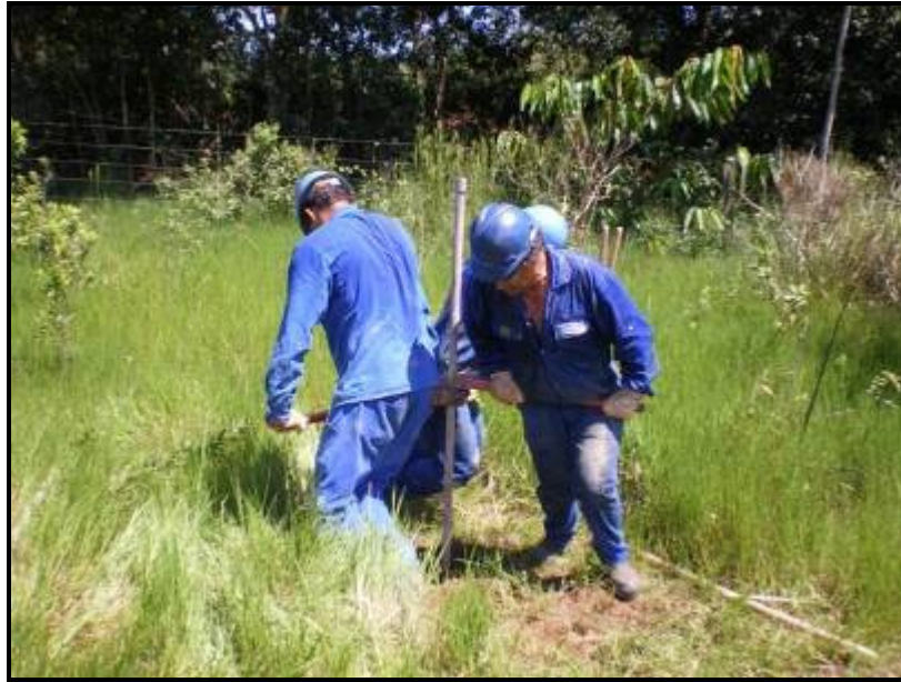
Figura 69- execução sondagem ST-11.
