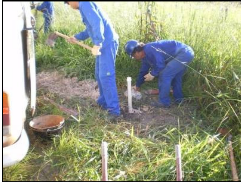
Figura 147- Instalação do poço PP-12.
