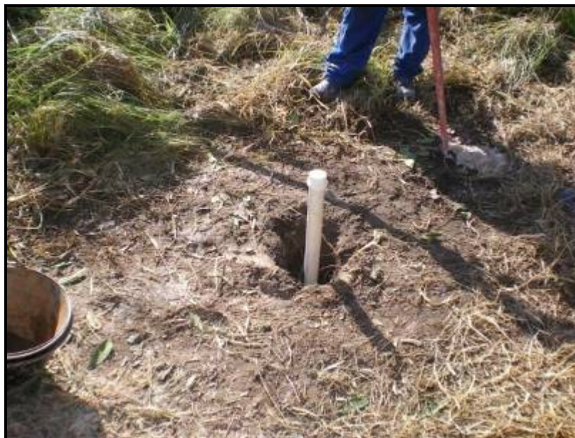
Figura 148 – Poço PP-03 sendo finalizado.
