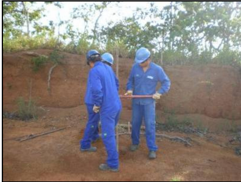
Figura 64 – Execução da sondagem ST-10.
