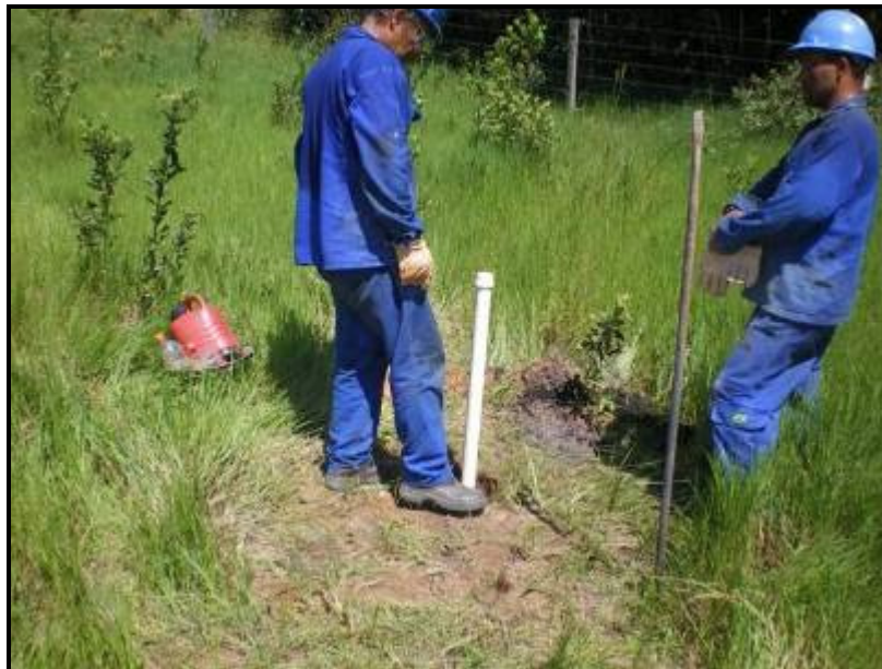
Figura 150 – Instalação do poço PP-11.
