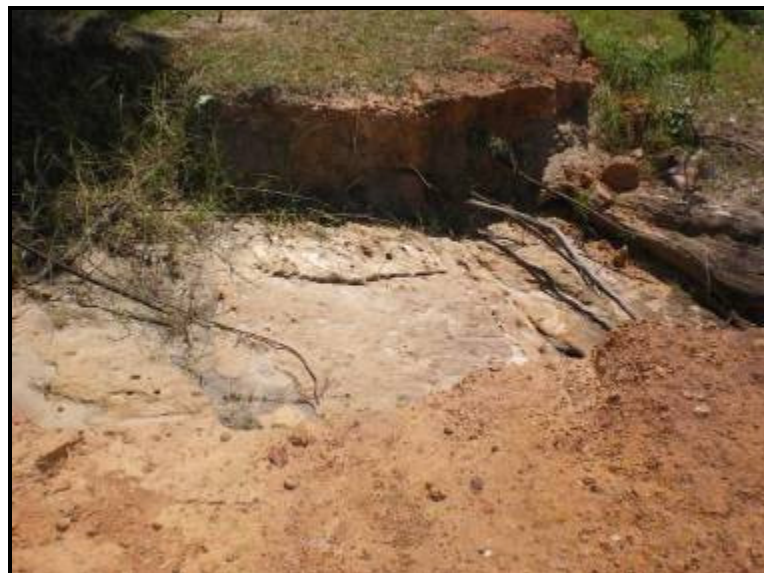
Figura 37 – Detalhe da espessura de solo residual.
