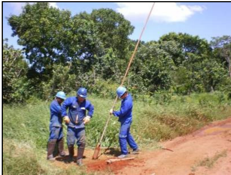
Figura 73- Execução da sondagem ST-13.
