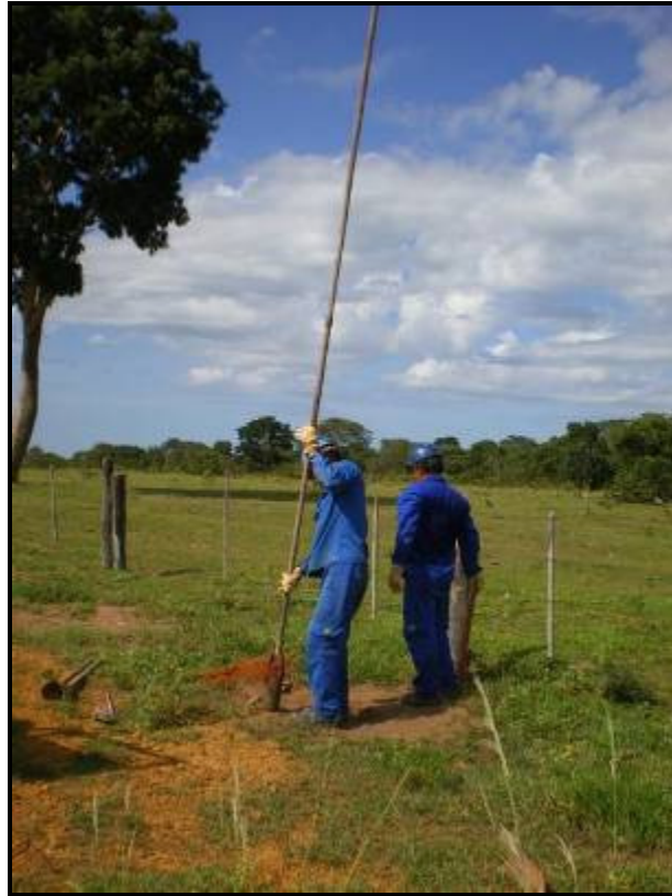
Figura 62 – Execução da sondagem ST-09
