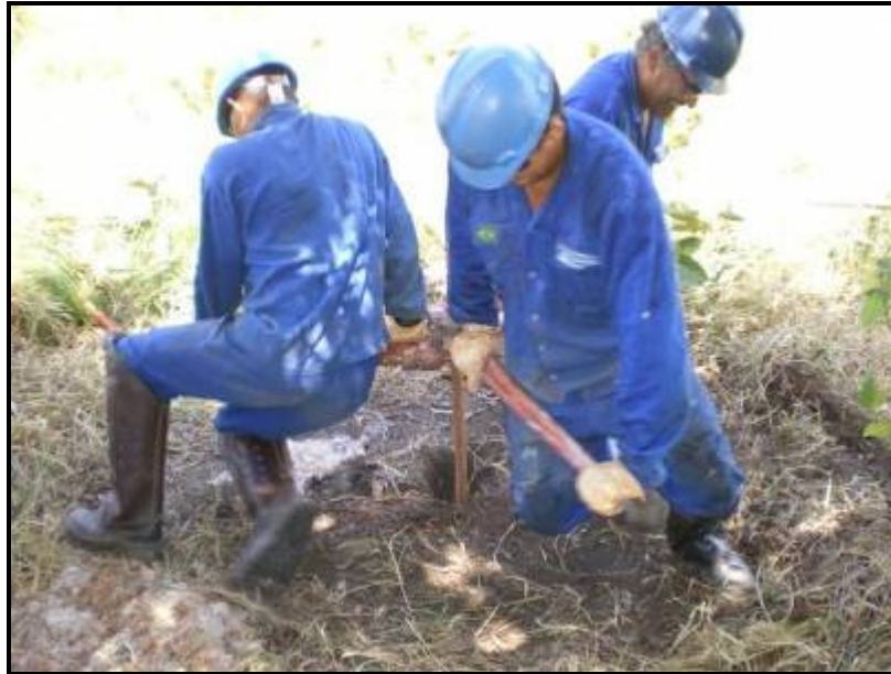
Figura 47 – Execução da sondagem ST-03.
