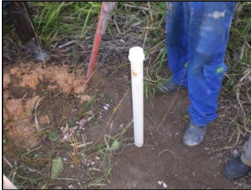
Figura 153 – Poço PP-15 instalado.
