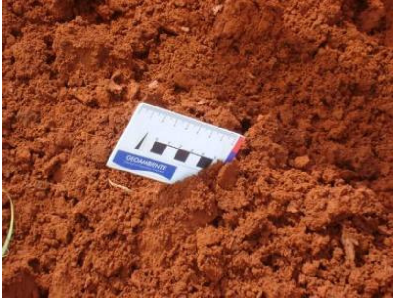
Figura 83 – Solo argiloso friável retirado da sondagem ST-18.
