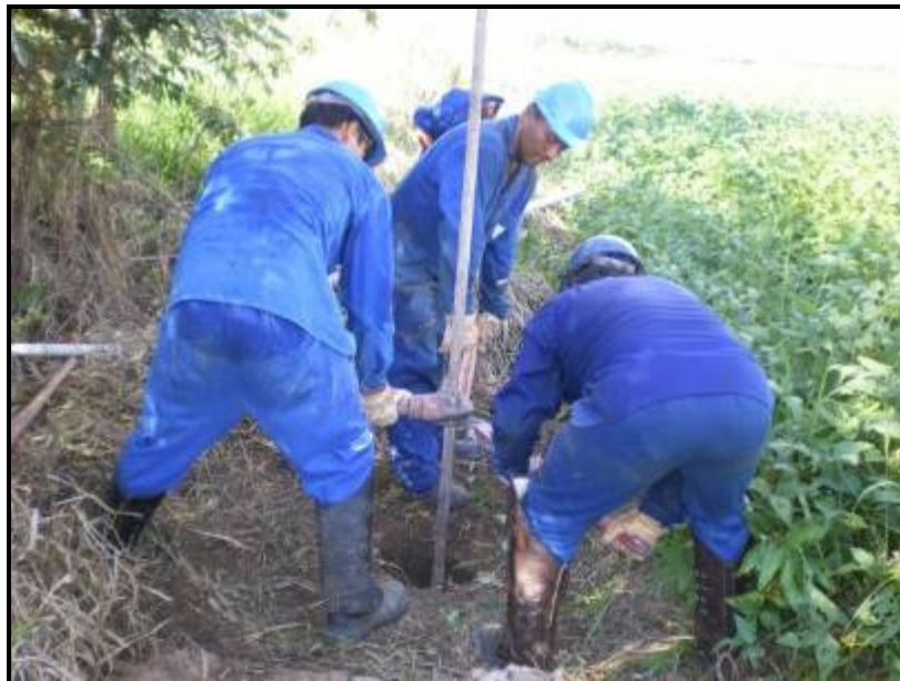
Figura 75- Execução da sondagem ST-14.
