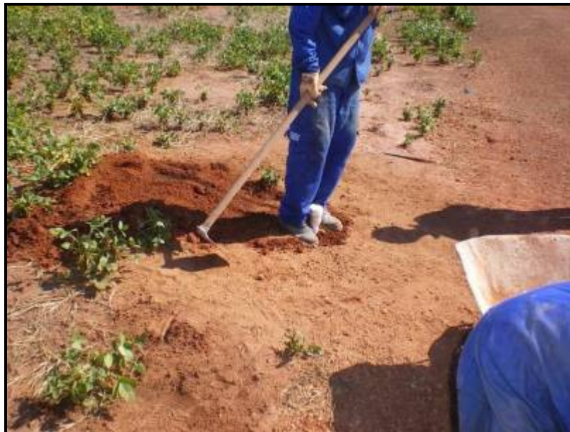
Figura 146- Acabamento do poço PP-05.
