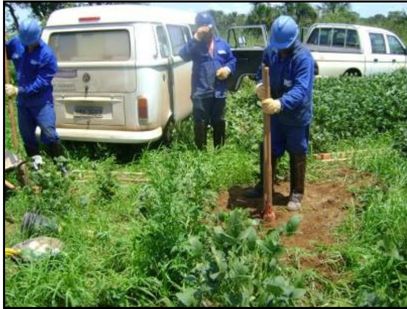
Figura 44- Abertura da sondagem ST-02.
