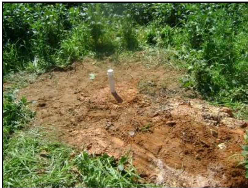
Figura 144 – Poço PP-02 instalado.
