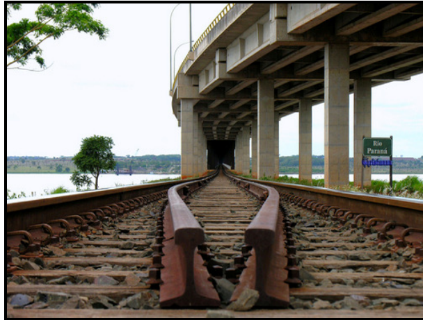
Figura 10 – Ponte sobre o Rio Paraná, ligando Santa Fé do Sul e Aparecida do Taboado, 2006.
