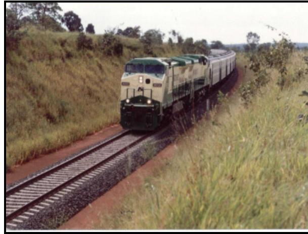
Figura 11 – Dormentes de concreto instalados na Ferronorte.
