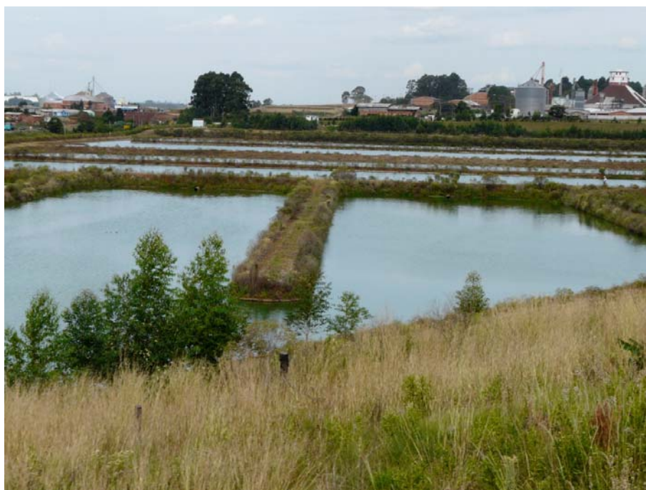
Figura 17.7-6 – Estação de Tratamento de Esgoto Presente no Município de Passo Fundo, Foto PC054
