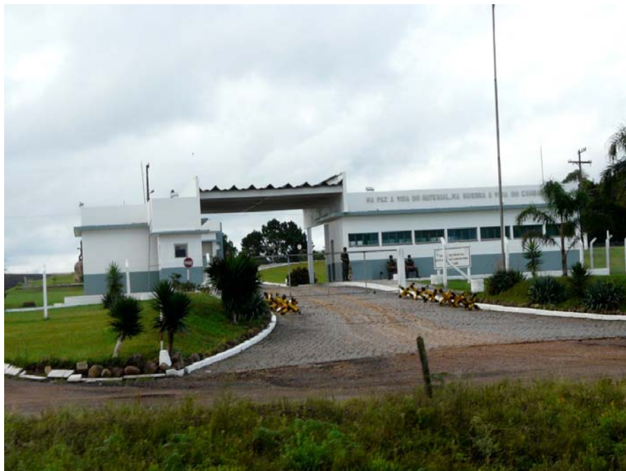
Figura 17.7-12 – Quartel Militar no Município de Itaara, Foto PC096
