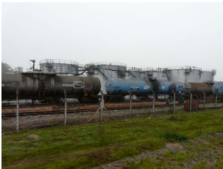
Figura 17.7-26 – Local de Armazenamento e Carregamento de Combustível no Município de Santa Maria, Foto PC146
