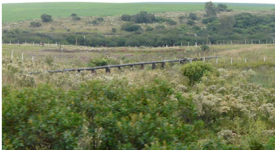
Figura 17.7-18 – Tubulação de Água para Abastecimento no Município de Santiago, Foto PC103
