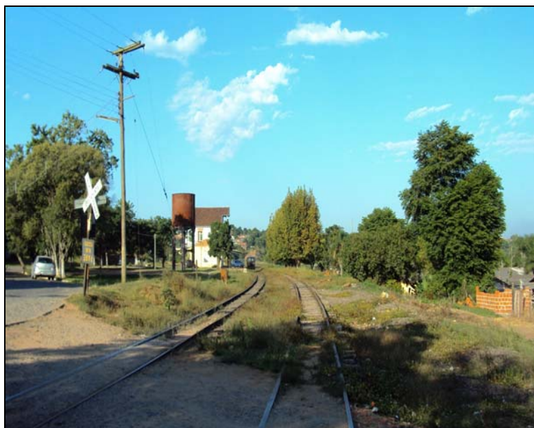
Figura 16.7-27 – Trecho Urbano Próximo a Passagem de Nível da Rua Praça da Ponte no Bairro Bonfim no Município de Rio Pardo (RS), Foto CE 269
