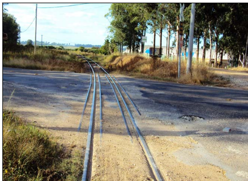
Figura 16.7-21 – Passagem de Nível da Av. Visconde Ribeiro de Magalhães no Bairro Vila de Santa Tereza no Município de Bagé (RS), Foto CE 240.
