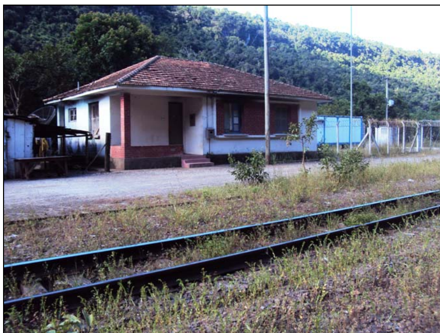
Figura 16.7-2 – Edificação no Pátio da Estação Ferroviária do Município de Jaboticaba (RS), Foto CE 31.
