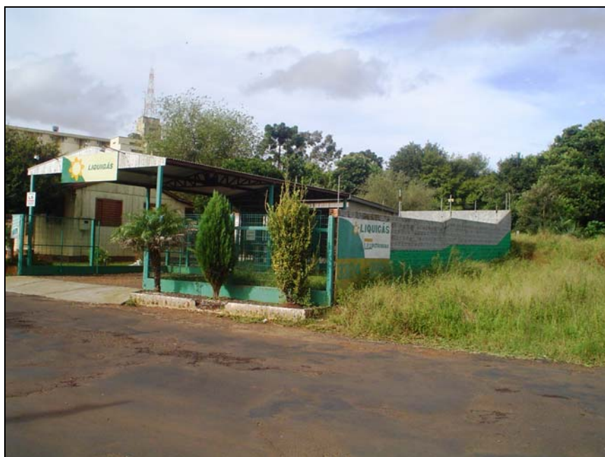
Figura 16.7-6 – Área de Ocupação da Faixa de Domínio por Comércio de Gás, com Distância Inferior a 3m da Ferrovia, no Bairro São Genaro, Município de Cruz Alta (RS), foto 162.
