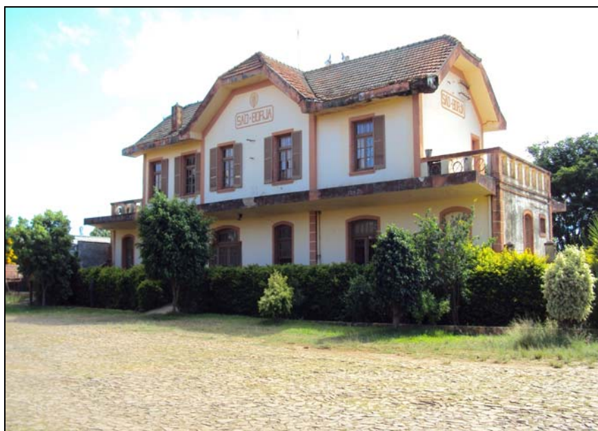
Figura 16.7-17 – Estação Ferroviária de São Borja Bairro Sede Ferro, Município de São Borja (RS), Foto CE 200
