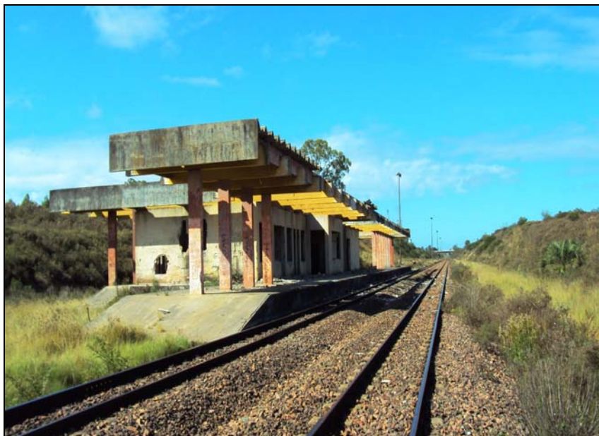
Figura 16.7-20 – Linha Férrea Desviada da concentração Urbana no Município de São Gabriel (RS), Foto CE 234.
