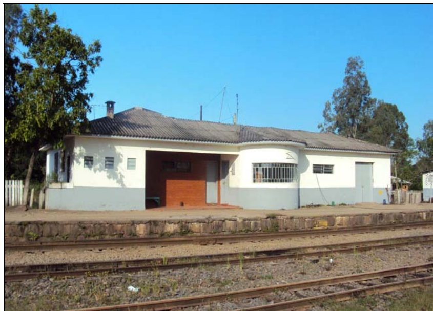
Figura 16.7-31 – Prédio da Estação de Montenegro no Bairro São Paulo, no Município de Montenegro (RS), Foto CE 273
