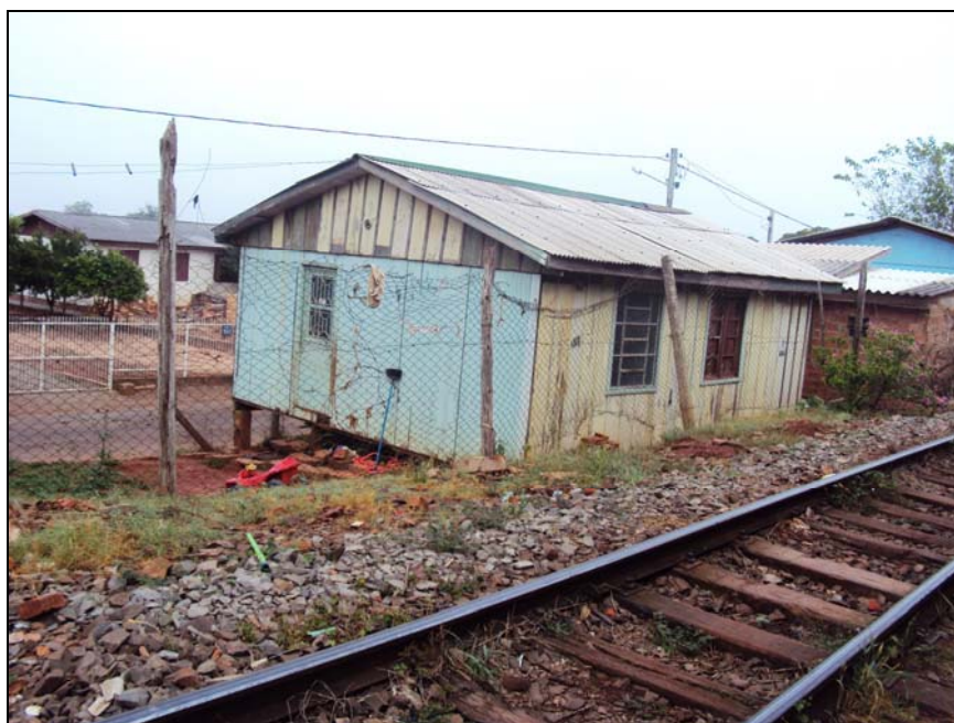
Figura 16.7-4 – Área de Ocupação da Faixa de Domínio por Residência no Bairro Vera Cruz, no Município de Passo Fundo (RS), Foto CE 84.
