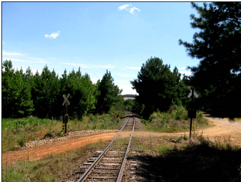
Figura 15.7-4 – Passagem de Nível em Área Rural do Município de Gentil, com Presença de Placa como Sistema de Controle em Bom Estado de Conservação, Foto PN80.
