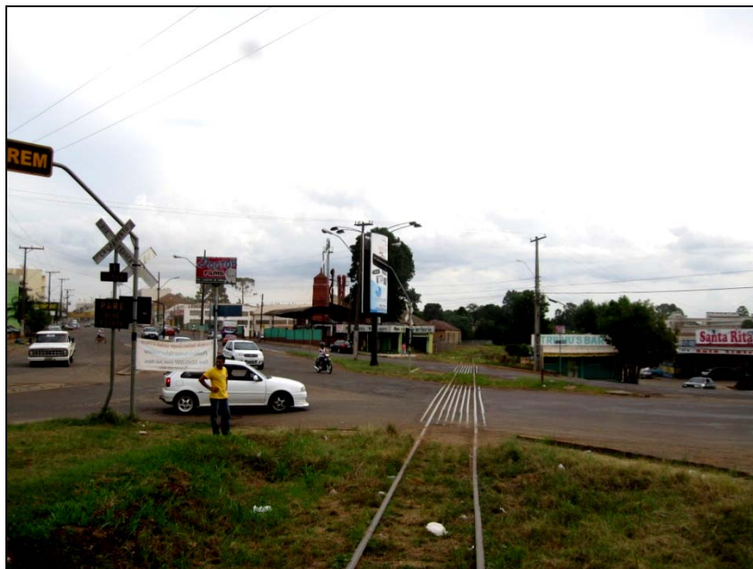
Figura 15.7-6 – Passagem de Nível em Área Urbana do Município de Carazinho, com Presença de Placa como Sistema de Controle em Bom Estado de Conservação, Foto PN132.
