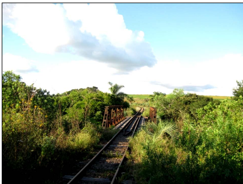
Figura 15.7-35 – Ponte com Proteção Lateral no Município de Santo Ângelo, Foto OA148.
