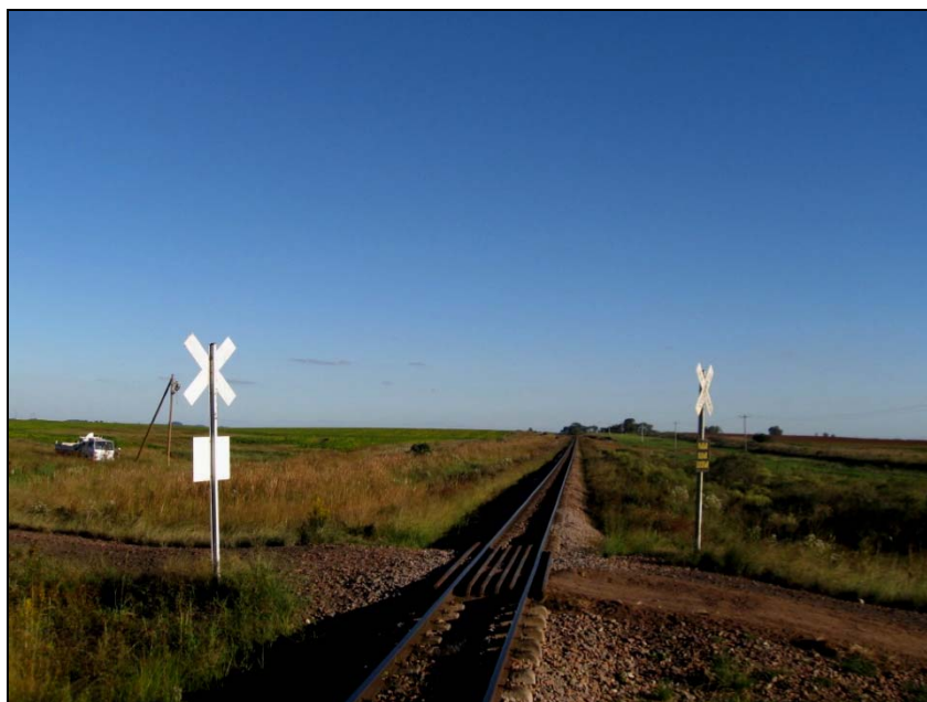
Figura 15.7-17– Passagem de Nível em Área Rural do Município de Dom Pedrito, com a Presença de Placas com Sistema de Controle em Bom Estado de Conservação, Foto PN610.
