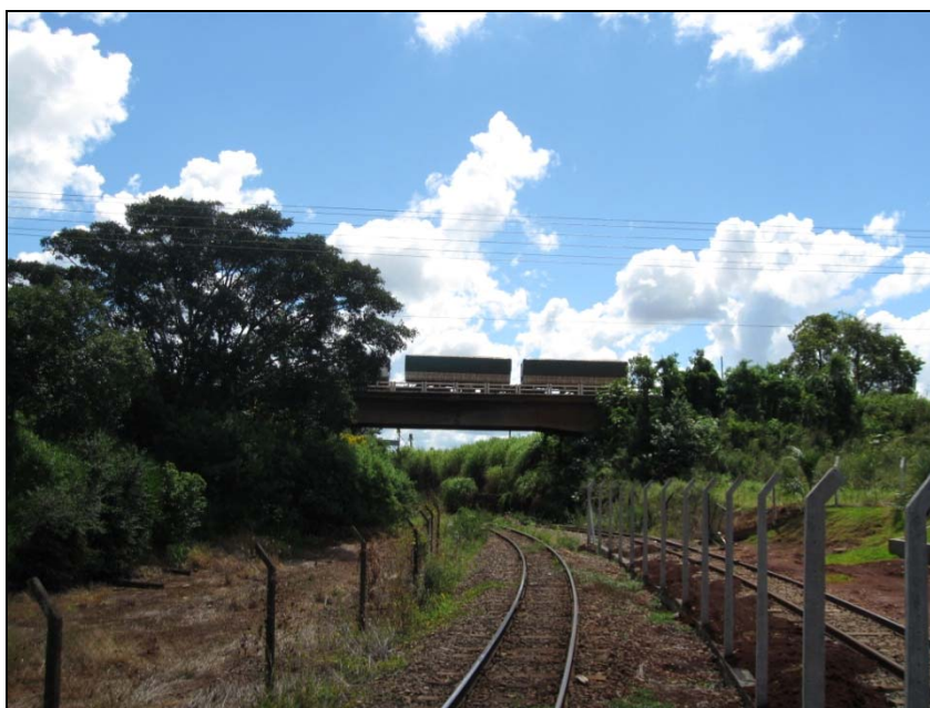
Figura 15.7-34 – Passagem Superior em Rodovia no Município de Ijuí, Foto OA136.
