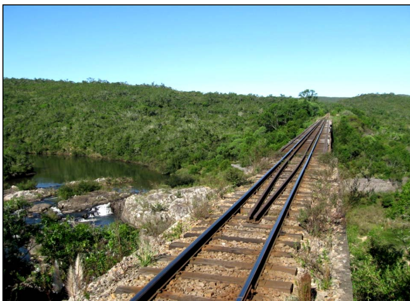
Figura 15.7-36 – Ponte sobre Rio Cascavel, no Município de Pinheiro Machado, Foto OA392.
