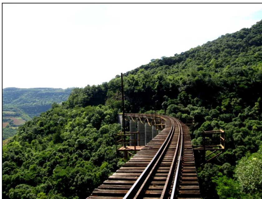
Figura 15.7-28 – Viaduto no Município de Dois Lajeados, Foto OA88.
