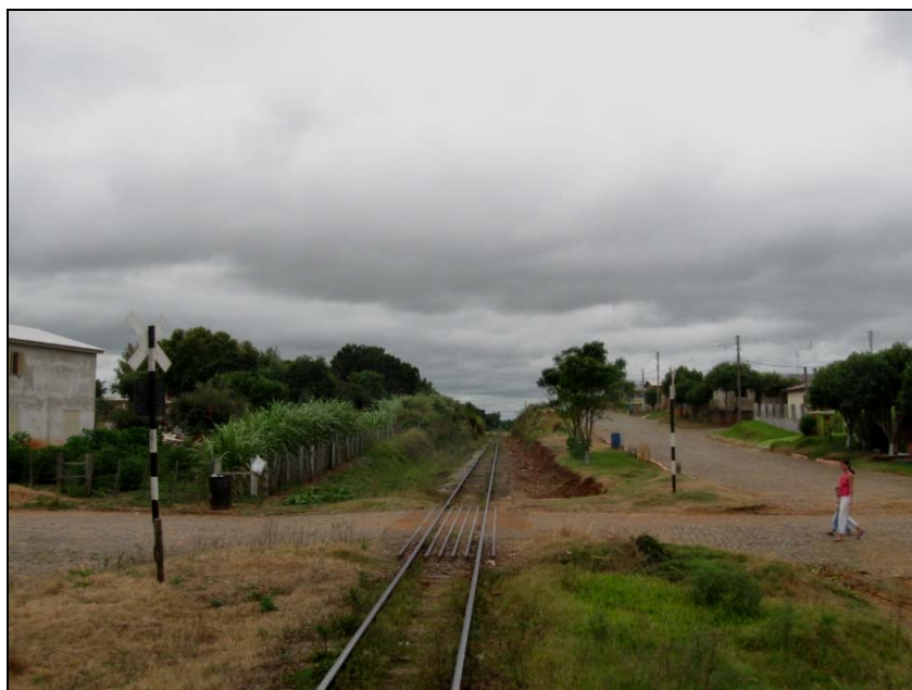
Figura 15.7-7 – Passagem de Nível em Área Urbana do Município de Tupanciretã, com Presença de Placa como Sistema de Controle em Bom Estado de Conservação, Foto PN285.
