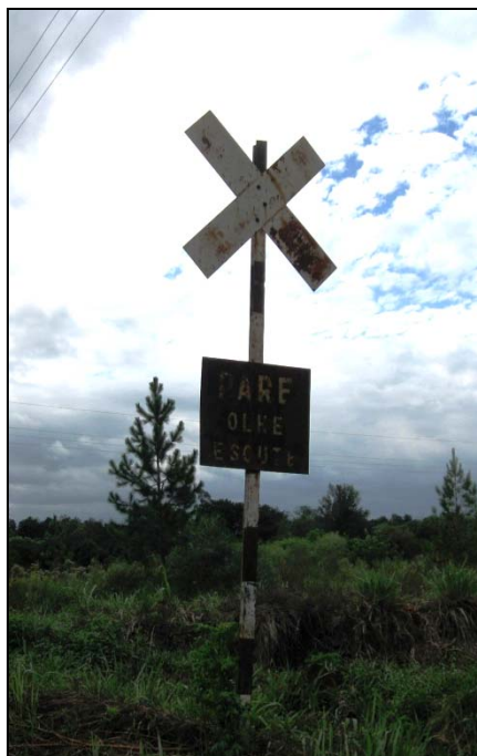
Figura 15.7-11 – Placa de Passagem de Nível em Área Rural do Município de Bossoroca, em Estado de Conservação Ruim – Placa Enferrujada e Apagada, Foto PN457.
