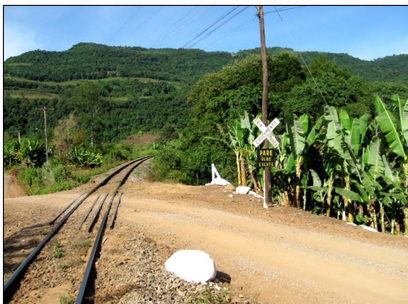
Figura 15.7-1 – Passagem de Nível no Município de Bento Gonçalves, com Presença de Placas como Sistemas de Controle em Estado de Conservação Bom, Foto PN023.
