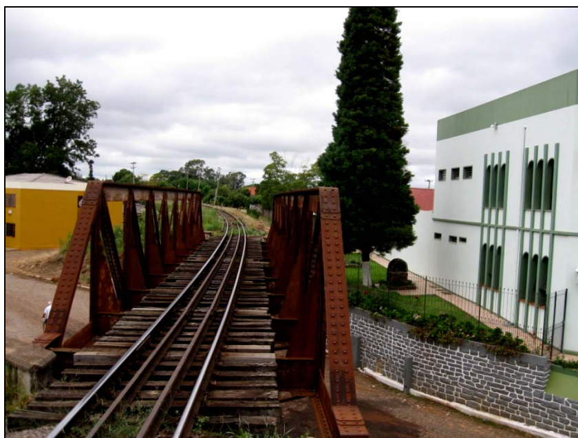
Figura 15.7-31 – Passagem Inferior no Município de Tupanciretã, Foto OA152.
