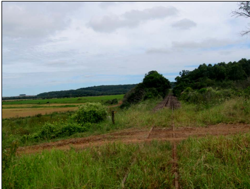
Figura 15.7-8 – Passagem de Nível Clandestina entre Propriedades Rurais, no Município de Mata, sem a Presença Sistema de Controle, Foto PN361.
