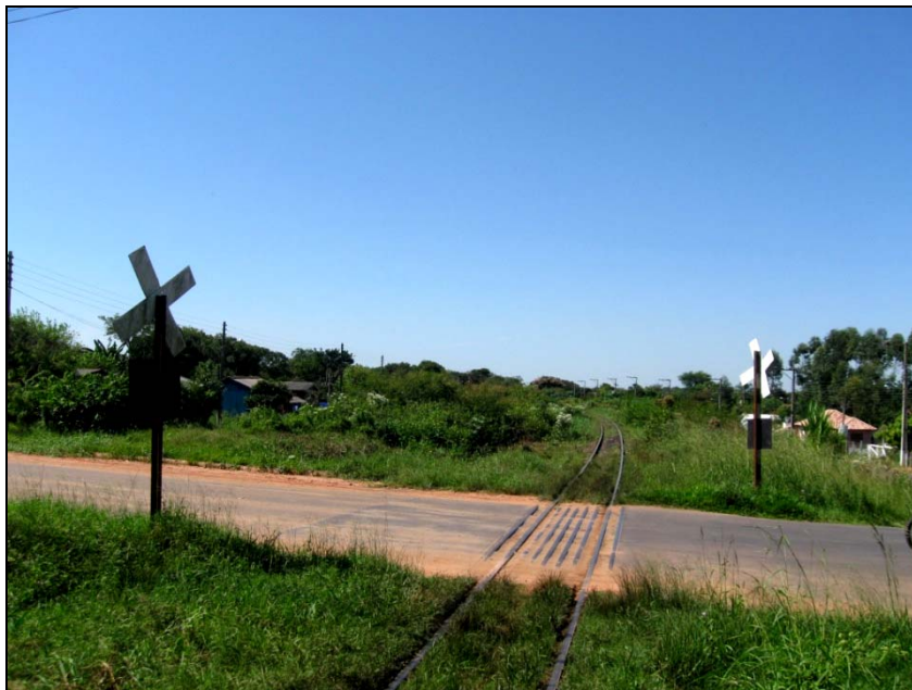
Figura 15.7-21– Passagem de Nível em Rodovia na Área Rural do Município de Triunfo, com a Presença de Placas com Sistema de Controle em Bom Estado de Conservação, Foto PN803.
