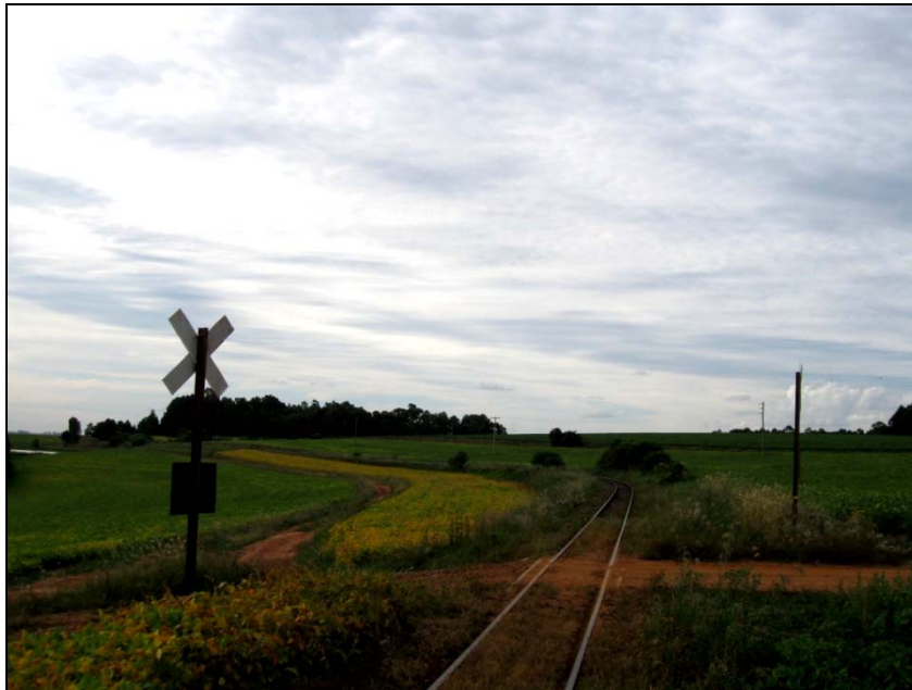
Figura 15.7-5 – Passagem de Nível em Área Rural do Município de Santo Antônio do Planalto, com Presença de Placa como Sistema de Controle em Bom Estado de Conservação, Foto PN117.
