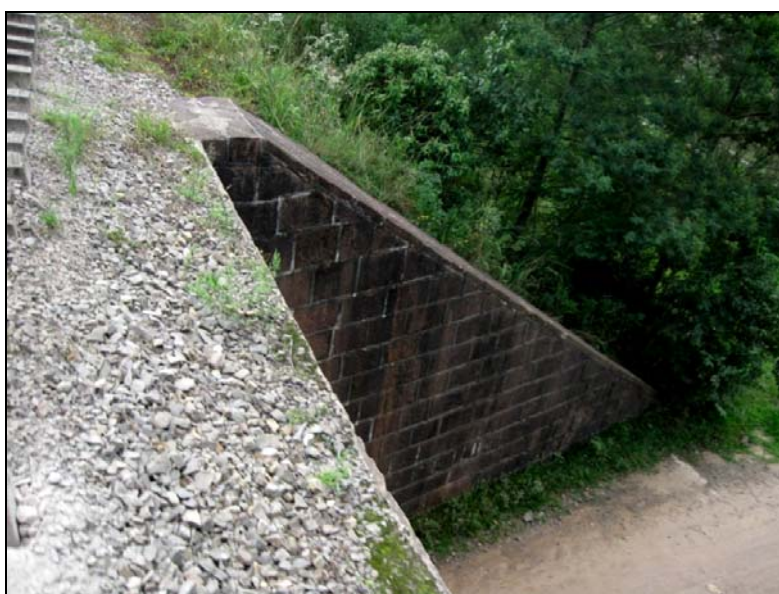
Figura 15.7-43 – Passagem Inferior no Município de Montenegro, Foto OA502.
