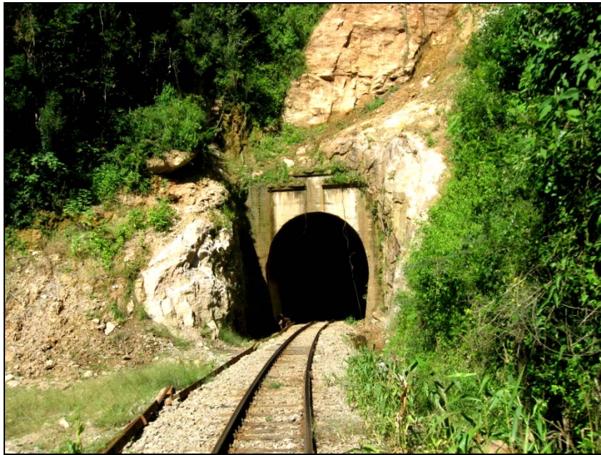
Figura 15.7-26 – Túnel no Município de Ipê, Foto OA8.
