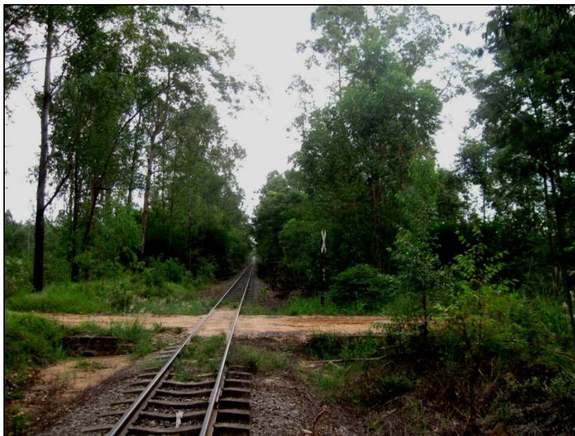
Figura 15.7-23– Passagem de Nível em Área Rural do Município de Montenegro, com a Presença de Placas com Sistema de Controle em Bom Estado de Conservação, Foto PN829.
