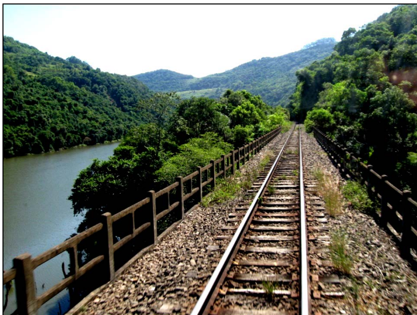
Figura 15.7-27 – Viaduto sobre Rio das Antas no Município de Veranópolis, Foto OA29.
