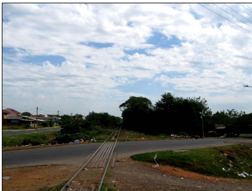
Figura 15.7-22– Passagem de Nível em Avenida na Área Urbana do Município de Canoas, com a Presença de Placas Danificadas com Sistema de controle, Foto PN819.
