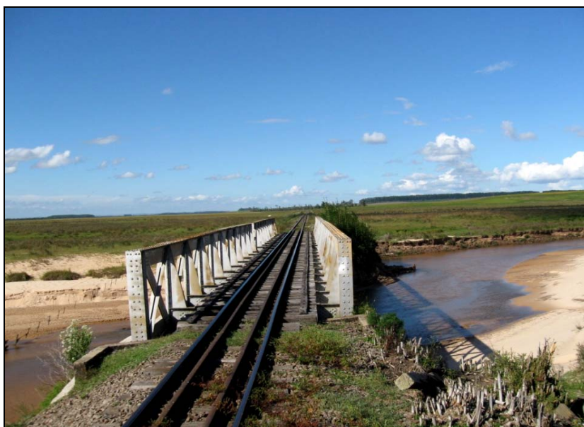
Figura 15.7-39 – Ponte com Proteção Lateral no Município de Cacequi, Foto OA315.
