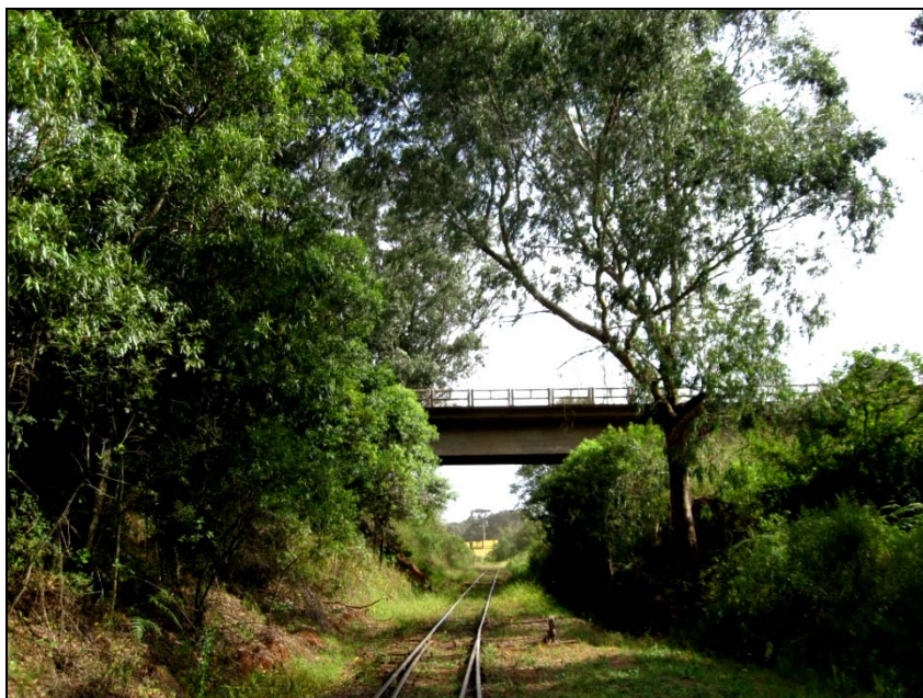
Figura 15.7-30 – Passagem Superior no Município de Passo Fundo, Foto OA131.
