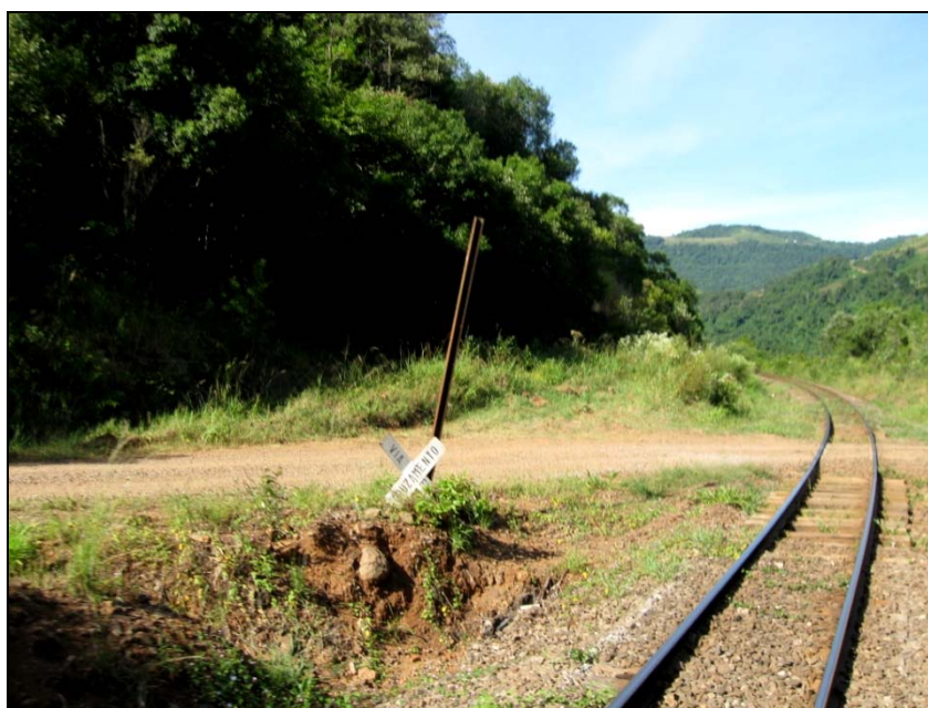
Figura 15.7-2 – Passagem de Nível em Área Rural no Município de Bento Gonçalves, com Presença de Placa como Sistema de Controle em Estado de Conservação Ruim, Foto PN22.
