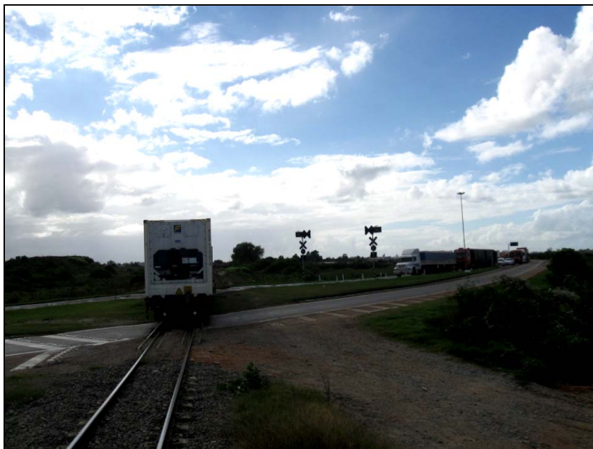
Figura 15.7-16– Passagem de Nível em Rodovia no Município de Pelotas, com a Presença de Placas com Sistema de Controle em Bom Estado de Conservação, Foto PN905.
