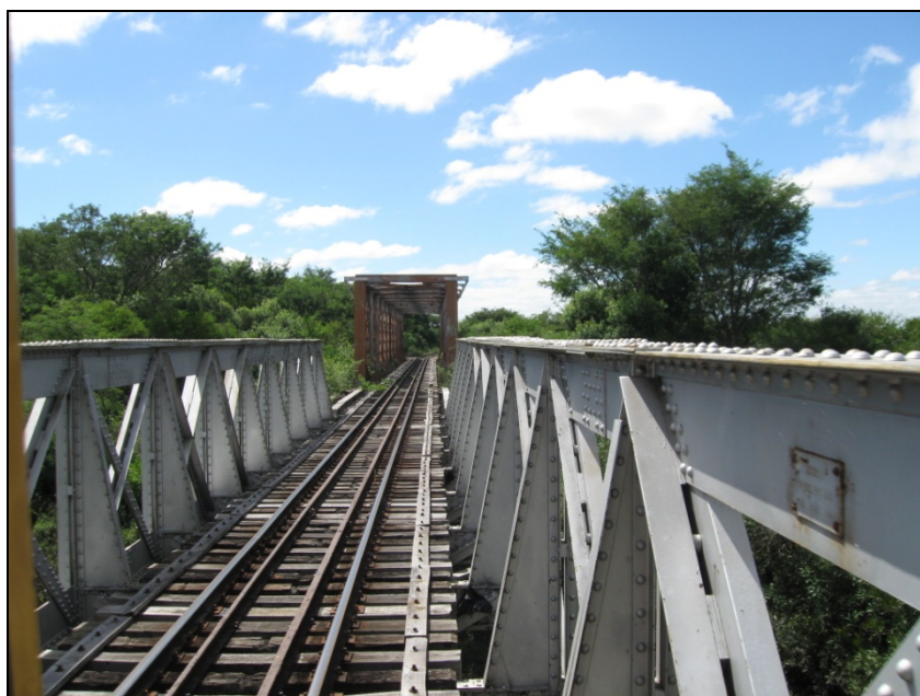
Figura 15.7-38 – Ponte com Proteção Lateral no Município de Uruguaiiana, Foto OA242.
