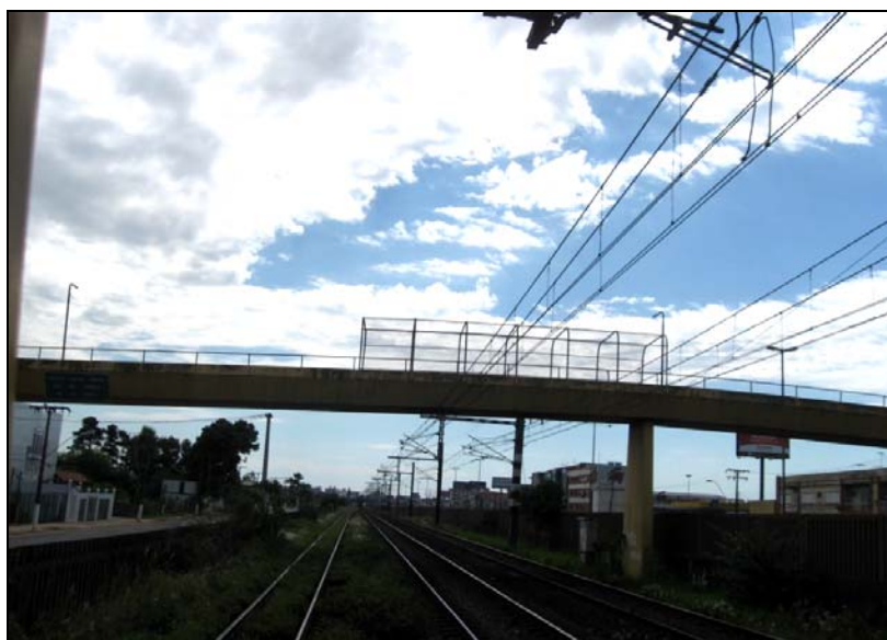
Figura 15.7-42 – Passagem Superior para Pedestres no Município de Canoas, Foto OA494.
