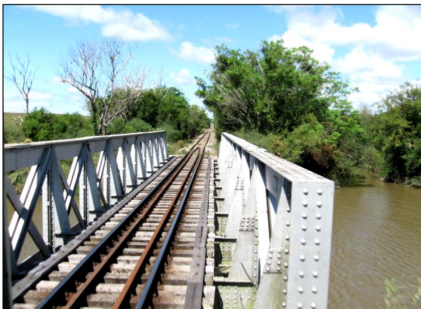
Figura 15.7-37 – Ponte com Proteção Lateral no Município de São Gabriel, Foto OA353.
