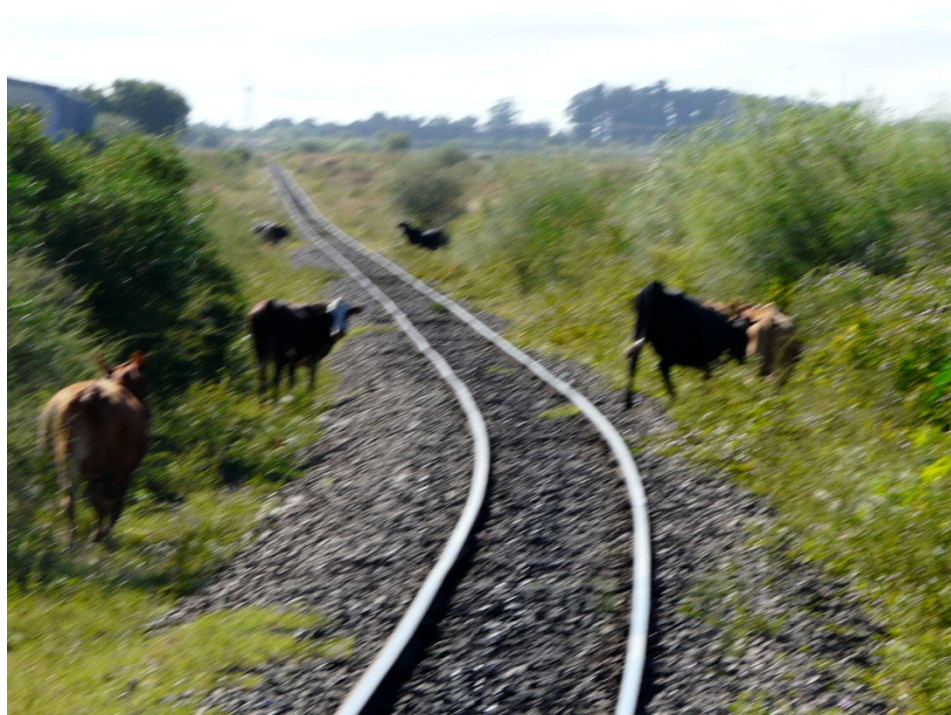
Figura 9.7-1 – Ocorrência de Gado Próxima à Via Férrea.
