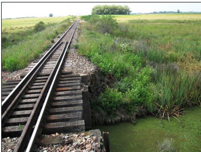
Figura 8.7-35 – Sistema de Drenagem (Ponte) em Estado Médio de Conservação (Assoreado), Município de Hulha Negra, Foto SD3898
