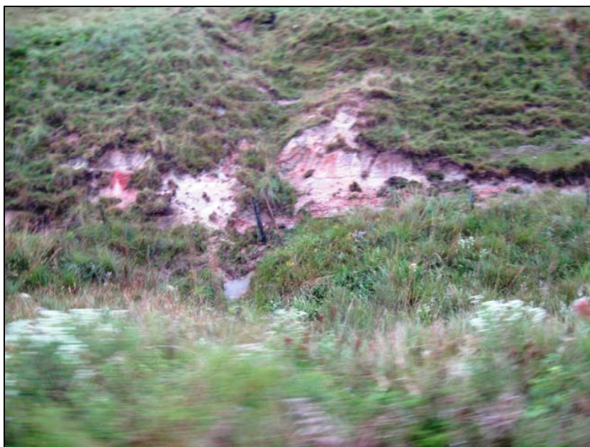
Figura 8.7-20 – Sistema de Drenagem (Galeria) em Estado Médio de Conservação (Falta de Limpeza), Município de Santa Maria, SD2450
