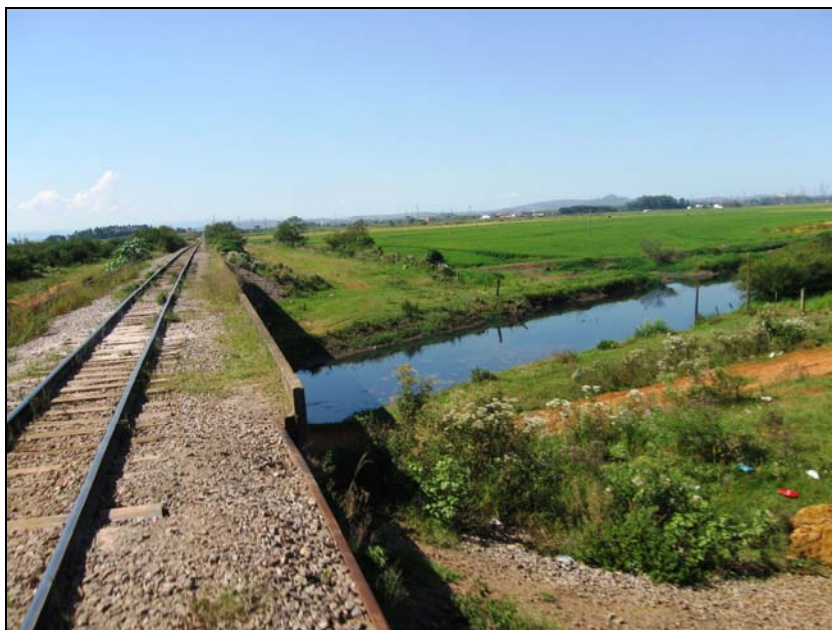
Figura 8.7-41 – Sistema de Drenagem (Galeria) em Bom Estado de Conservação, Município de Canoas, Foto SD4503
