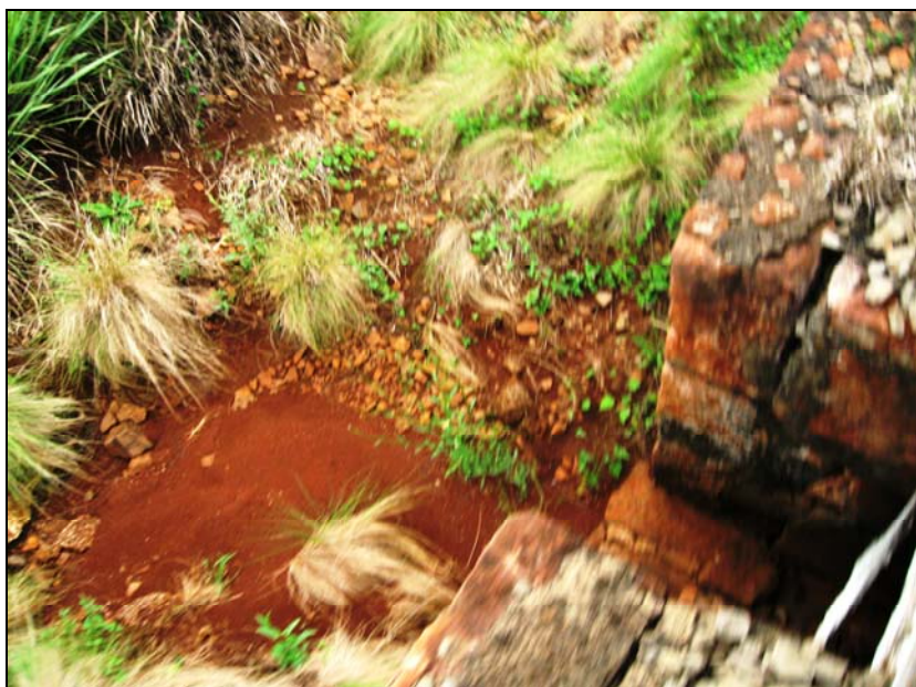
Figura 8.7-26 – Sistema de Drenagem (Galeria) em Estado Médio de Conservação (Assoreado), Município de Bossoroca, Foto SD2858
