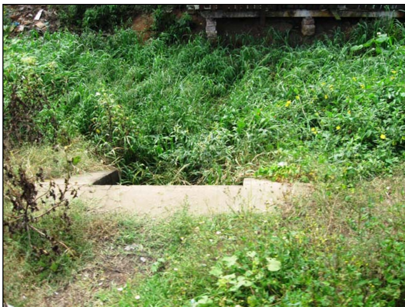
Figura 8.7-44 – Sistema de Drenagem (Galeria) em Bom Estado de Conservação, Município de Canoas, Foto SD4528
