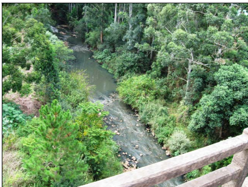
Figura 8.7-9 – Sistema de Drenagem (Ponte) em Bom Estado de Conservação, Município de Passo Fundo, Foto SD1943
