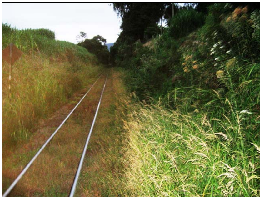
Figura 8.7-47 – Sistema de Drenagem (Canaletas laterais) em Estado Ruim de Conservação (Ausentes ou Obstruídas), Município de Roca Sales, Foto SD4657
