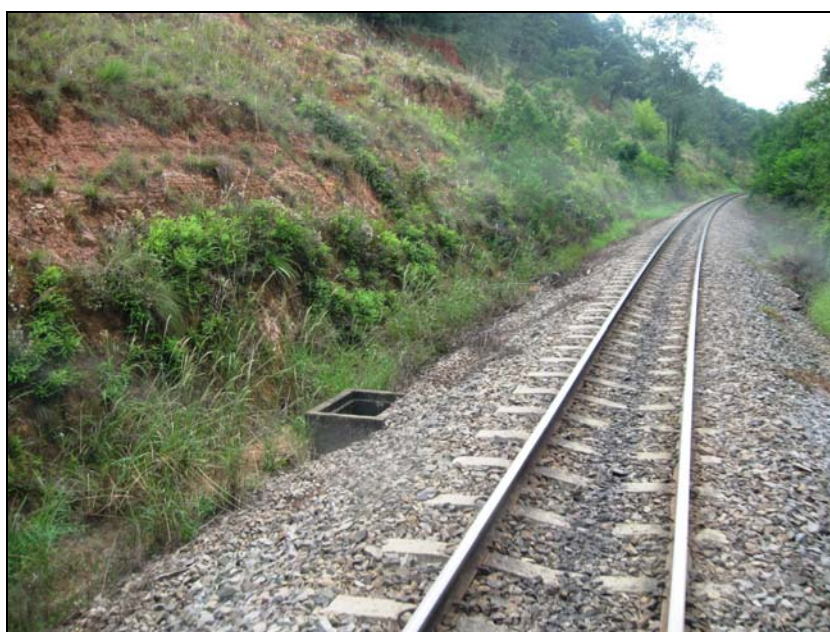
Figura 8.7-46 – Sistema de Drenagem (Galeria) em Bom Estado de Conservação, Município de Montenegro, Foto SD4547
