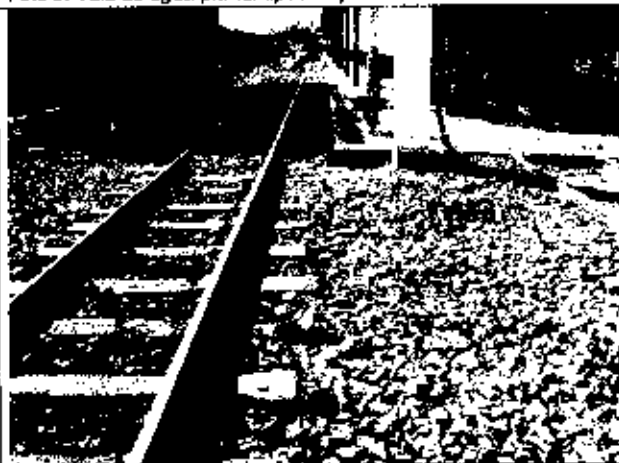
Foto 7: Linha lateral à área de lavagem
