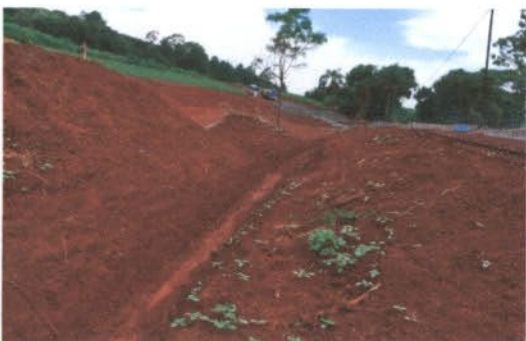
Foto 5 – Após finalização da infra e superestrutura, foi iniciada as obras de recuperação do sistema de drenagem.
