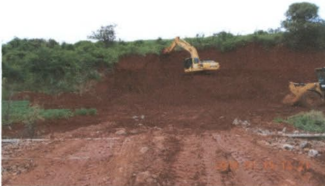
Foto 1 - Área de empréstimo realizada por coleta de material para terraplanagem.
