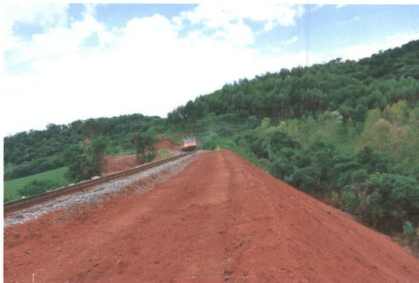
Foto 9 – Finalização dos trabalhos de compactação e banquetas do aterro.
