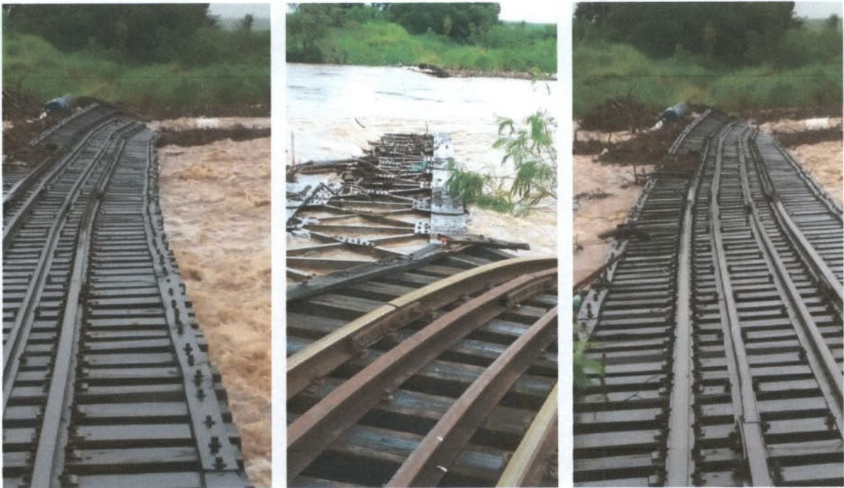
Imagens da ponte;
