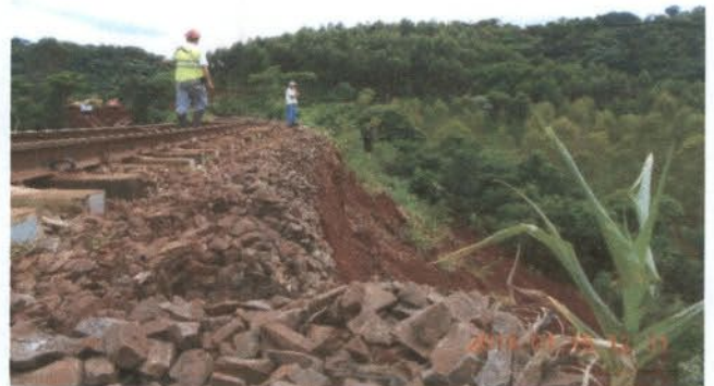
Foto 4 - Vista geral dos deslizamentos. Detalhe ao fundo da imagem das máquinas trabalhando no outro lado da via permanente, demonstrando a abrangência dos deslizamentos.
