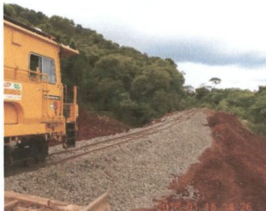
Foto 3 – Restruturação da via após primeiro deslizamento de terra.
