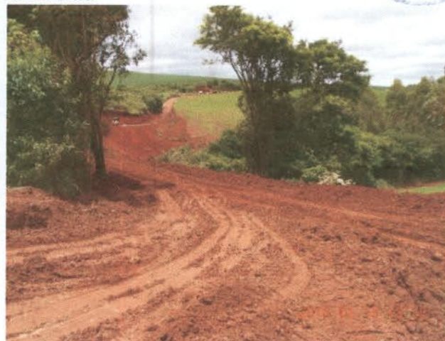
Foto 8 - Detalhe dos cortes para controle dos processos erosivos e movimentos de massa.
