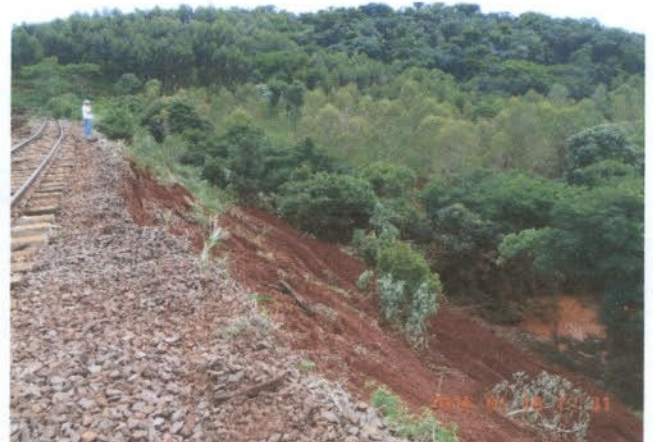
Foto 2 - Detalhe de um dos lados do deslocamento de terra, mostrando ao fundo do corte a vegetação típica da área de estudo.
