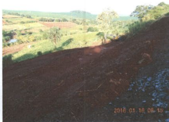
Foto 4 – Novo deslizamento de terra após a continuidade das chuvas.
