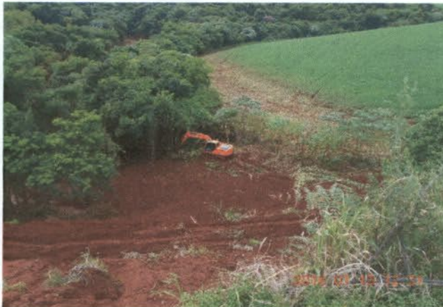
Foto 3 - Detalhe para os trabalhos de terraplanagem em uma das margens da via.
