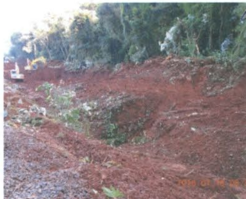
Foto 6 – Supressão da vegetação para definição do novo traçado.
