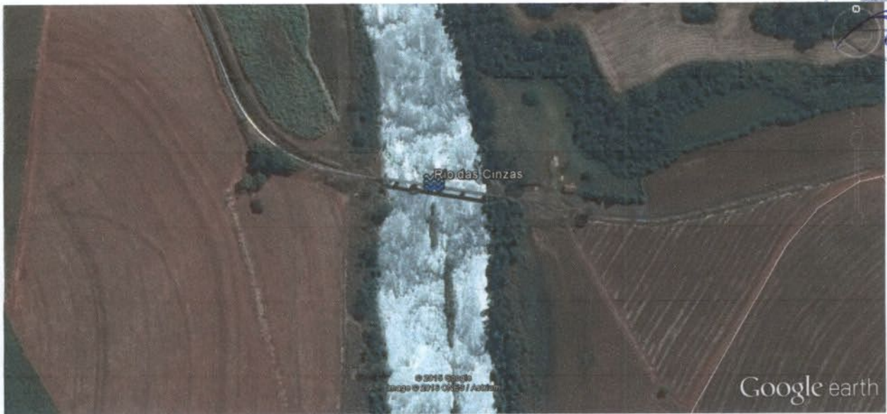
Imagem extraída do Google Earth com a localização da ponte;
