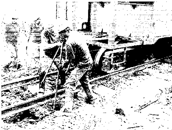
Equipe de via realizando manutenção.
