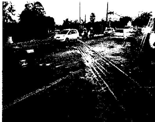
Limpeza da passagem de nível
