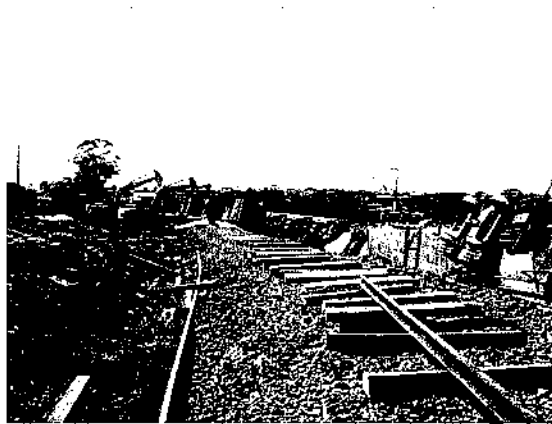
Reconstrução da via permanente.
