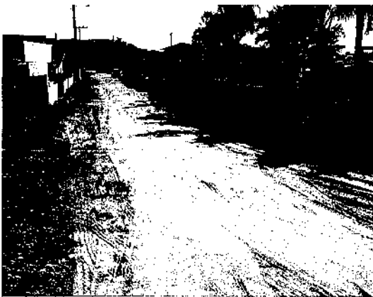
Rua lateral a passagem de nível após ser feita a raspagem de solo.
