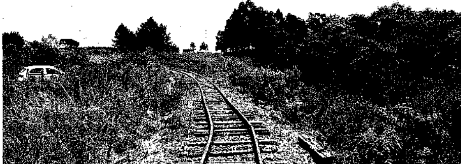
Foto 4 - Passagem de nível.
