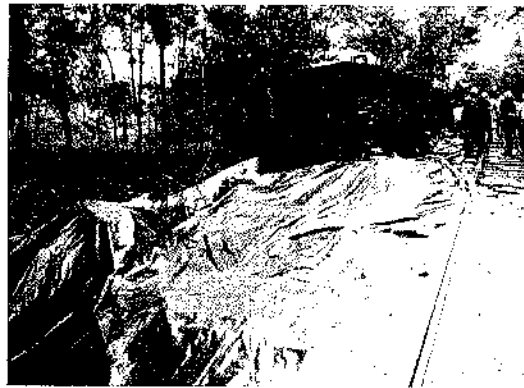
Instalação de lona sobre o produto derramado;
