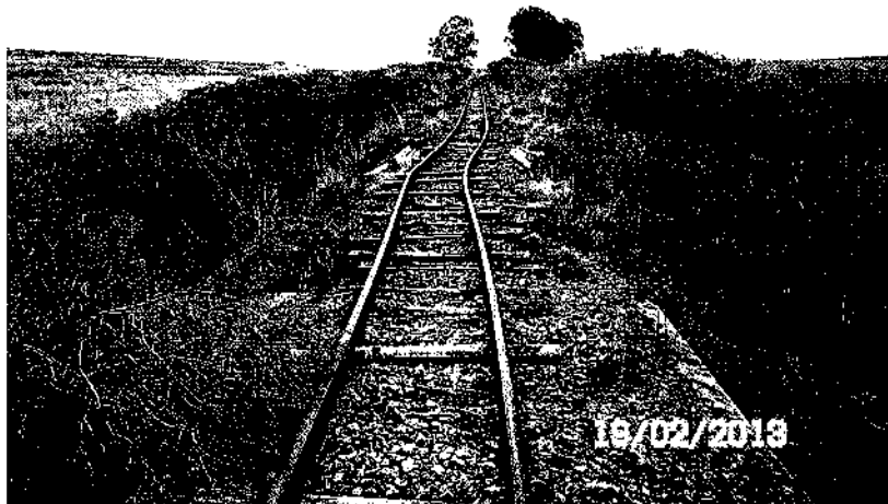
Foto 1 - Desalinhamento da via em decorrência do aterro cedido.
