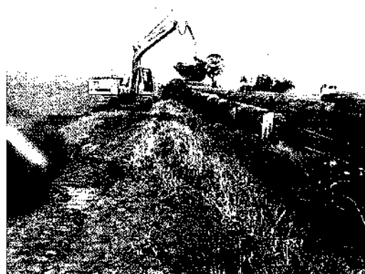
Retro fazendo valas de sacrifício, enquanto caminhões a vácuo realizam a sucção;
