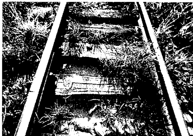
Material assoreado para a Via
