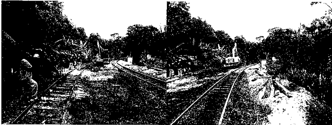
Local após a retirada dos vagões da linha férrea e o recolhimento de parte da carga vazada
