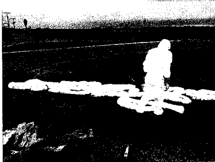
Imagem 3 – Barreiras de Contenção colocadas ao longo da área.
