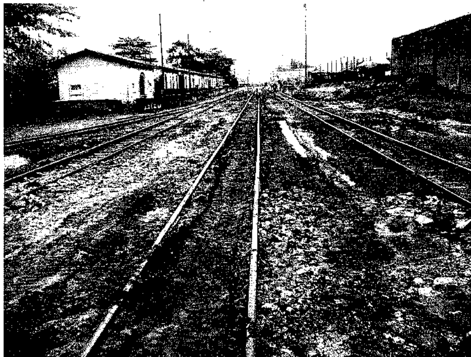
Figura 09 – Vista geral do local do acidente após a remoção do produto químico.
