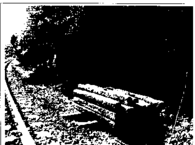
FIGURA 06 – Dormentes antigos recolhidos e empilhados no Pátio de Roça Nova.
