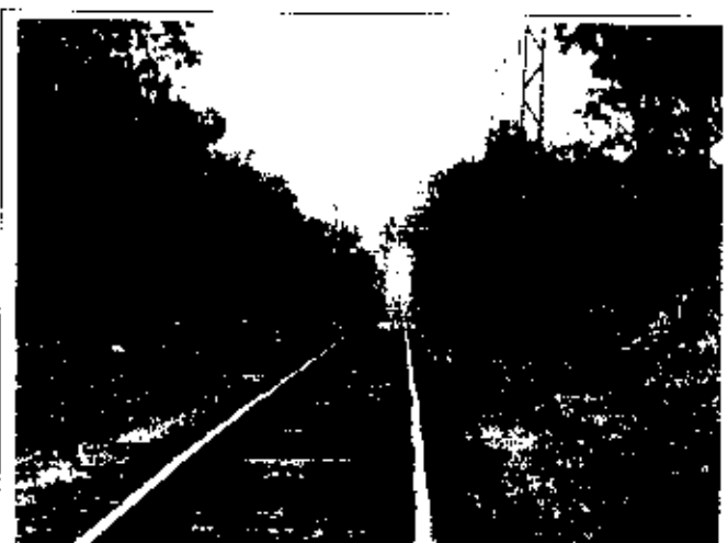
FIGURA 05 - Trecho final do Pátio de Ventania - antes da rampa.
