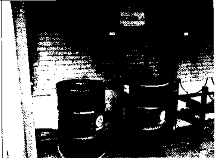
Foto 6 - Depósito de inflamáveis em área coberta, mas sem bacia de contenção.
