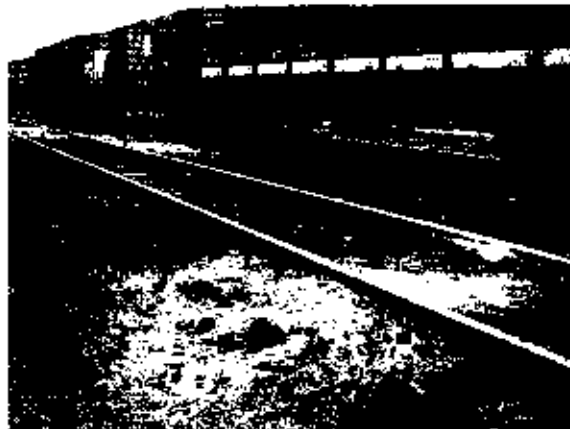
Figura 5 - Lastro colmatado e contaminado com óleo.
