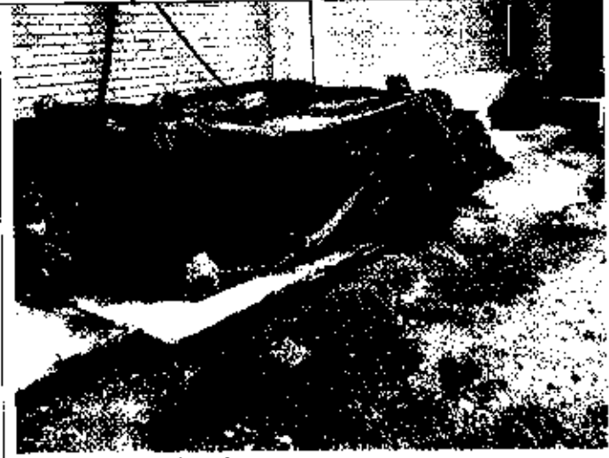
Foto 9 - Indícios de vazamento no armazenamento precário de óleo diesel.
