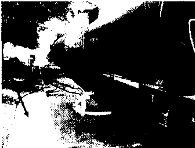
FIGURA 3 – Local de descarregamento de óleo dos vagões. A seta indica a canaleta na qual se localizam todas as tubulações de transferência.
