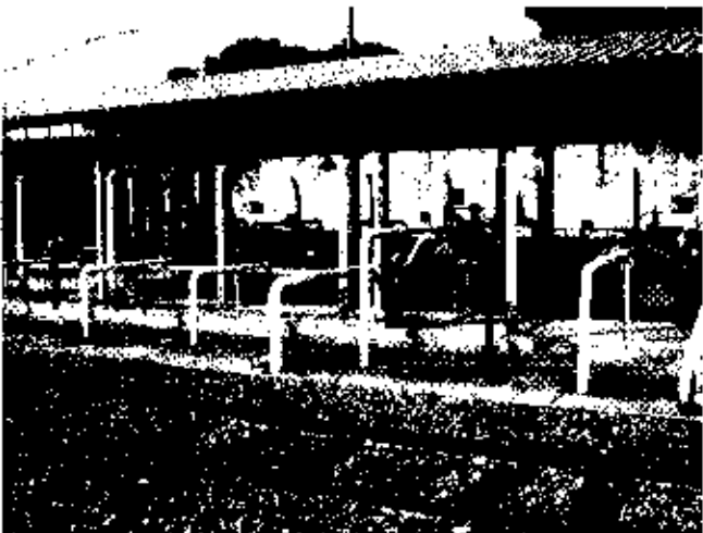
FIGURA 7 – Área das bombas para abastecimento, (a) vista frontal e (b) lateral. As setas indicam a canaleta comum a todas as tubulações, que segue desde o ponto de descarregamento até o ponto de abastecimento no interior da oficina.
