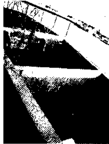
FIGURA 25 - Antigo SAO, hoje utilizado como tanque de equalização.
