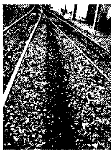
FIGURA 18 – Mancha forte de vazamento de óleo de locomotivas entre as linhas de entrada/saída da oficina.
