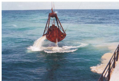
Figura 3.1-3: Operação da draga Clam-Shell carregando o material escavado misturado com água do mar.
