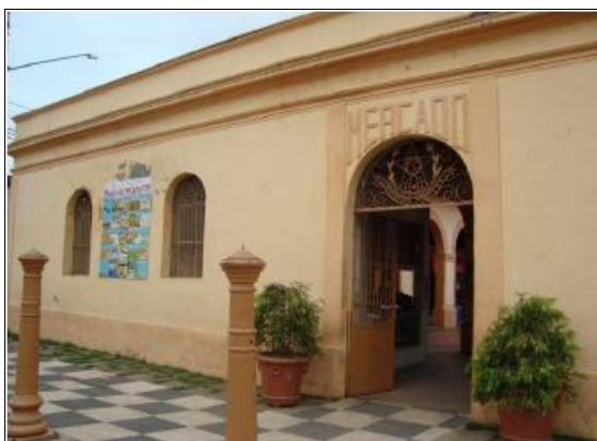
Figura 17 - Mercado Municipal de Jambeiro construído em 1896 9
