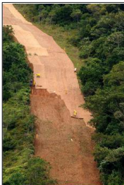
Foto VII.4.1.7.3-1 - Exemplo do uso de biomanta para a proteção de superfícies expostas. Fonte: Petrobras.
