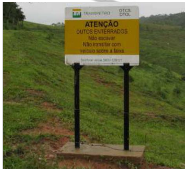
Foto VII.4.1.3-1 - Placa de Sinalização em Faixa de Servidão. Fonte: PETROBRAS
