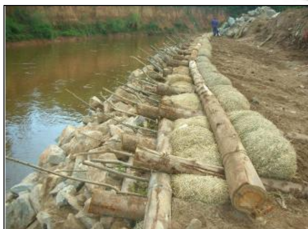
Foto VII.4.1.7.3-2 - Exemplo do uso de madeira, biomanta, aterro compactado e estacas vivas na proteção de margens de cursos d'água. Fonte: Petrobras.
