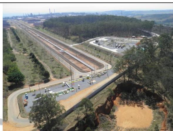
**Foto V.2.8.6-14** - Vista para faixa GASTAU próxima da chegada à Refinaria Henrique Lage. Detalhe para processo erosivo com acúmulo de água na porção inferior, à direita da foto. Coordenadas UTM: 7.433.207 / 416.904. Município de São José dos Campos. Fonte: Mineral 2011
