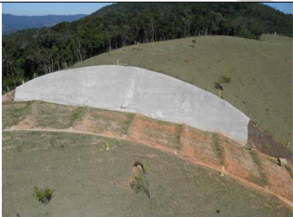
**Foto V.2.8.6-9** – Vista da faixa do GASTAU, onde serão implantados os dutos OCVAP I e II. Detalhe para proteção do talude próximo à faixa visando a contenção de processos erosivos/escorregamentos. Coordenadas UTM: 7.399.331 / 437.212. Município de Paraibuna. Fonte: Mineral 2011
