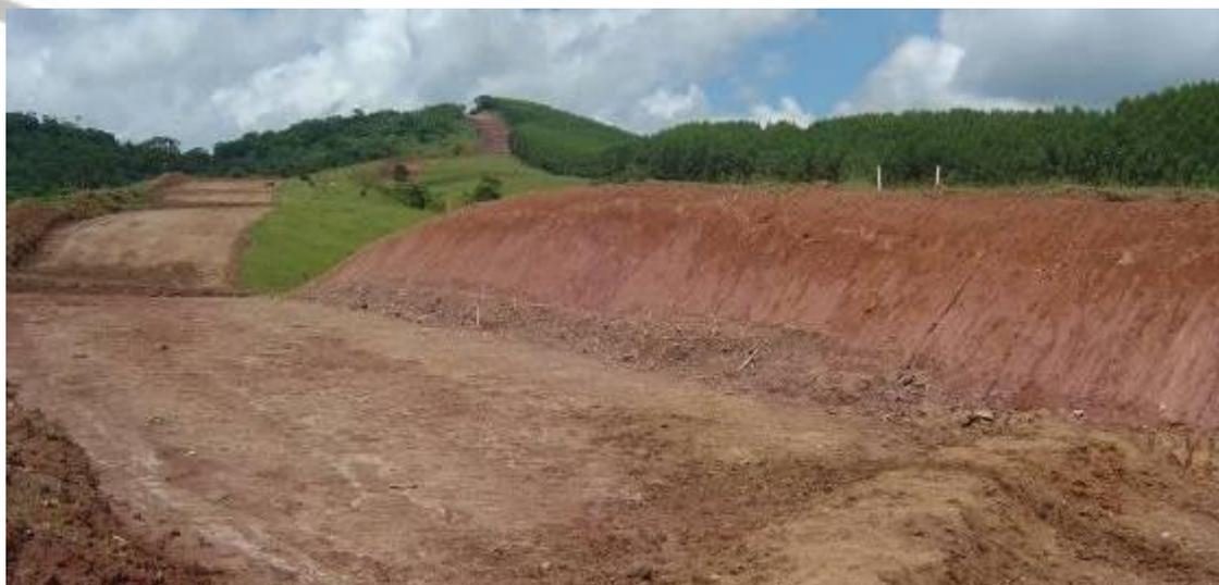
**Foto V.2.5.1-2**– Abertura da faixa GASTAU com exposição do Complexo Embu com gnaisses localmente migmatizados com intercalações de quartzitos (Megn). Região de Morros Cristalinos do Médio Vale do Paraíba (a norte) e os Morros Paralelos do Planalto de Paraitinga (para sul - vista da foto). Região do km 58 da Faixa da AID. Município de Jambeiro. Coordenadas UTM: 7.425.941/ 421.576. Fonte: Mineral/2011.
