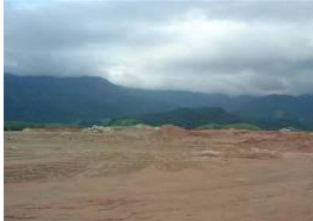
**Foto V.2.10.2-4** - Vista geral de área de empréstimo nos terrenos da UTGCA, com remoção de antiga colina isolada da Baixada Litorânea. Predomínio de solos residuais derivados de migmatitos e granito-gnaiss porfiroclástico do Complexo Costeiro. Coordenadas UTM: 7.384.033 / 449.243. Município de Caraguatatuba. Fonte: Mineral, 2011.
