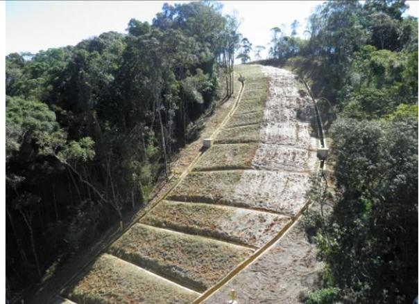
**Foto V.2.8.6-8** – Vista da faixa GASTAU, onde serão implantados os dutos OCVAP I e II. Detalhe para alta inclinação do terreno e estrutura com sistema de canaletas de drenagens. Coordenadas UTM: 7.399.073/ 437.465. Município de Paraibuna. Fonte: Mineral 2011
