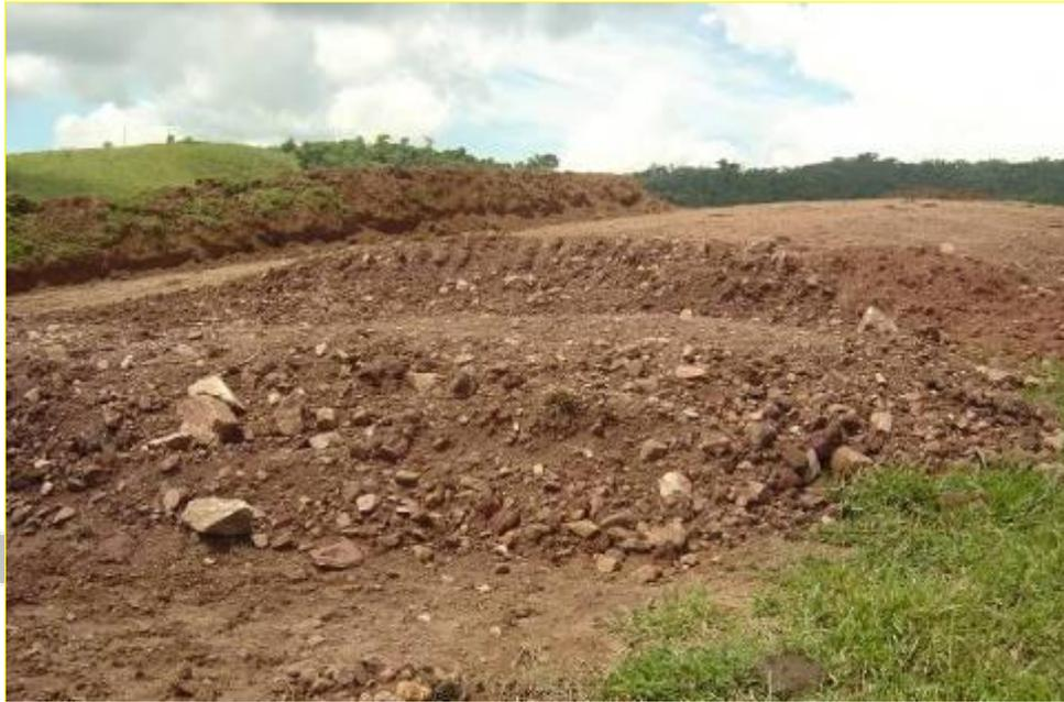
**Foto V.2.8.3-5** – Vista de corte de morro durante a implantação do duto GASTAU, com exposição de fragmentos de quartzitos intercalados aos gnaisses do Complexo Embu. Município de Jambeiro. Coordenadas UTM: 7.426.014/ 421.518. Fonte: Mineral, 2011.
