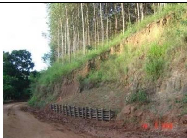
**Foto V.2.8.6-4** – Obras de recuperação do talude marginal afetado por processo de escorregamento parcial do horizonte de solo. Retaludamento, implantação de pontaletes de eucalipto cravados na base com manta geotêxtil (bidin) e proteção superficial com placas de grama. Coordenadas UTM: 7.411.226 / 430.188. Município de Paraibuna. Fonte: Mineral, 2009.
