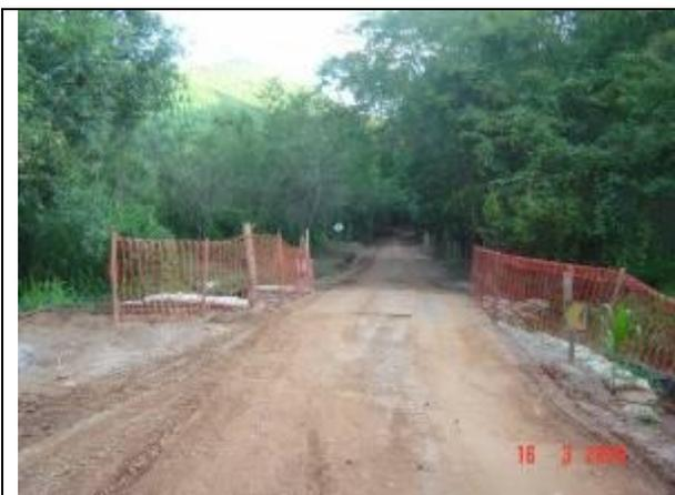
**Foto V.2.8.6-3** – Instalação de estrutura metálica provisória sobre drenagem em estrada de acesso às obras do GASTAU. Recuperação das margens da drenagem e proteção da fundação contra processos erosivos com sacos de solo silto-argiloso. Coordenadas UTM: 7.411.226 / 430.188. Município de Paraibuna. Fonte: Mineral, 2009.
