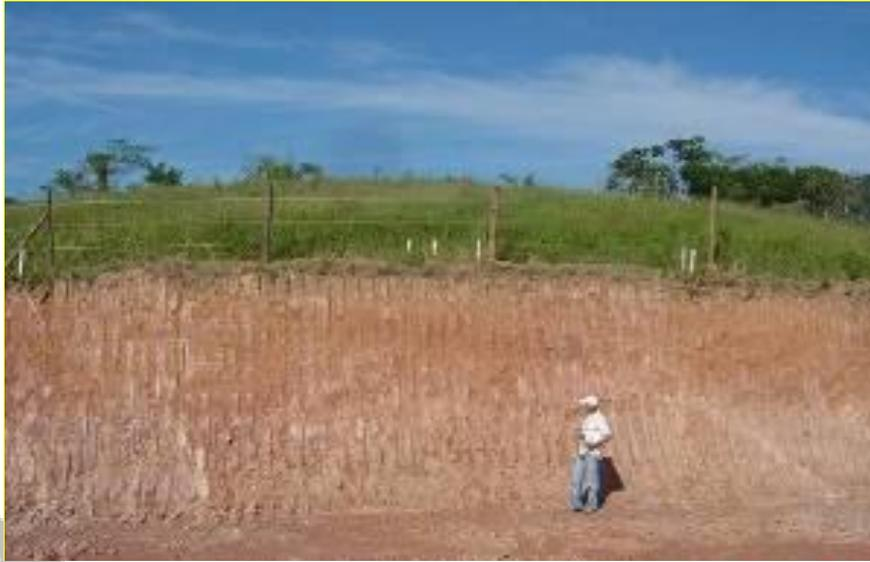
**Foto V.2.8.3-8** – Corte de morro para a implantação da faixa do GASTAU com exposição de solos eluviais derivados de rochas gnáissico-migmatíticas. Município de Paraibuna. Coordenadas UTM: 7.402.872/ 435.109. Fonte: Mineral, 2011.
