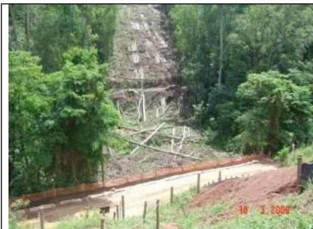
**Foto V.2.8.6-1** – Obra realizada na estrada de acesso com recuperação e contenção do aterro marginal do caminho da terra, nos arredores do cruzamento com a faixa do GASTAU implantada. Coordenadas UTM: 7.426.203 / 421.508. Município de Jambeiro. Fonte: Mineral, 2009.
