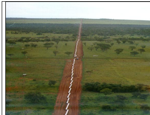
Foto IV.5.3.3-2 – Configuração típica de um “Desfile de tubos” ao longo da faixa. Fonte: PETROBRAS
