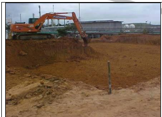
Foto IV.5.3.6-1 - Execução de terraplenagem. Fonte: PETROBRAS.
