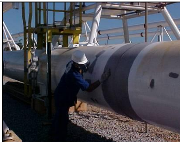
Foto IV.5.3.6-3 - Pintura das tubulações. Fonte: PETROBRAS
