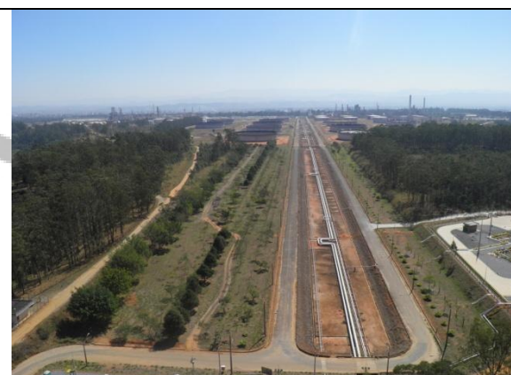
Foto IV.2.2.3-4 – Faixa de servidão próxima à REVAP, em São José dos Campos, 16/08/2011 (Coordenadas UTM 23K O 416811 S 7433289).
