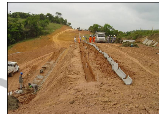
Foto IV.5.3.3-8 – Montagem dos dispositivos de drenagem/Sistema de canaletas longitudinais. Fonte: PETROBRAS.
