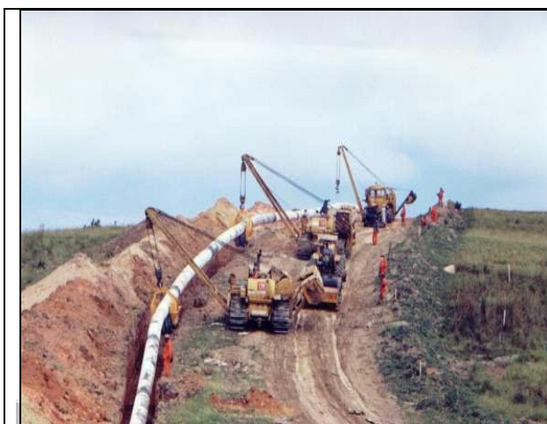
Foto IV.5.3.3-6 - Abaixamento do duto com Side Boom . Fonte: PETROBRAS.
