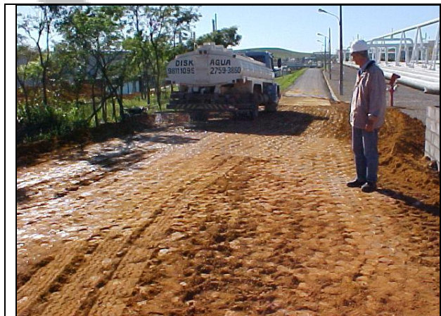
Foto IV.5.4.1-1 - Aspersão de água para minimização de sólidos em suspensão. Fonte: PETROBRAS.
