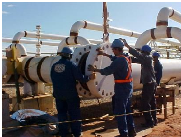
Foto IV.5.3.6-2 - Montagem das tubulações. Fonte: PETROBRAS
