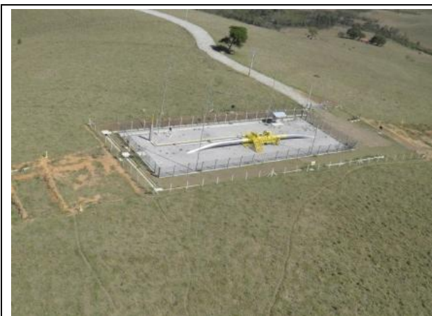
Foto IV.5.1.4-1 – Instalação típica de uma válvula de bloqueio, foto tirada em 16/08/2011. (Coordenadas UTM 23K O 432864 S 7406252)
