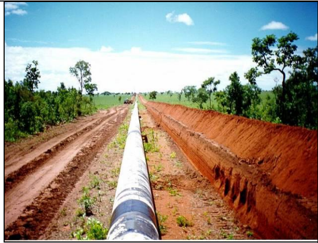
Foto IV.5.3.3-5 - Vala escavada à direita do duto. Fonte: PETROBRAS.
