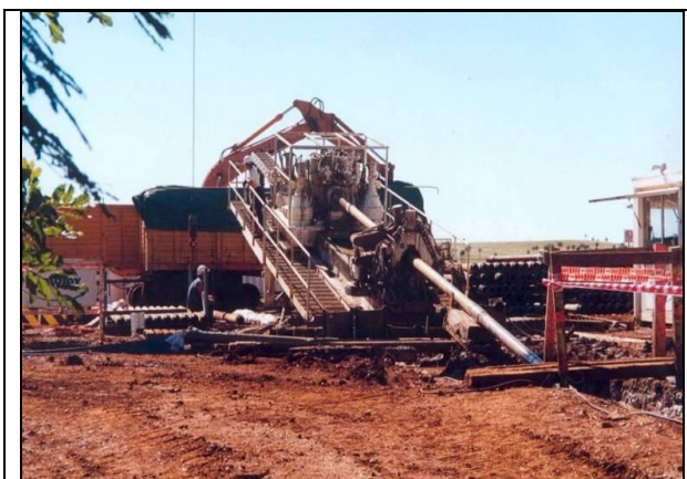
Foto IV.5.3.4-2 - Equipamento utilizado na execução de furos direcionais. Fonte: PETROBRAS
