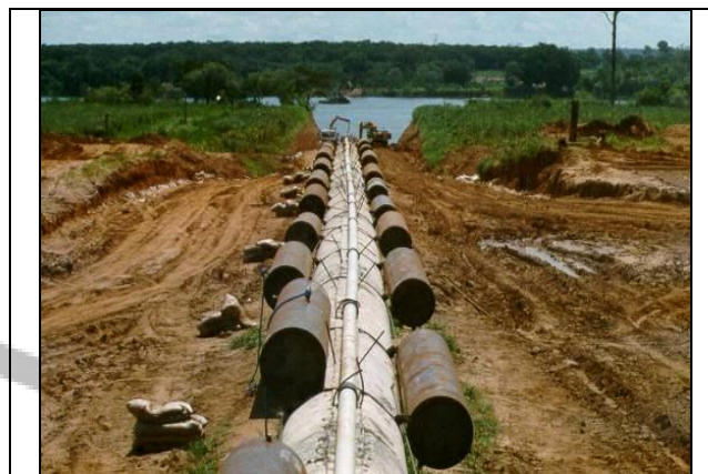
Foto IV.5.3.4-1 - Obra em travessia de rio. Fonte: PETROBRAS.
