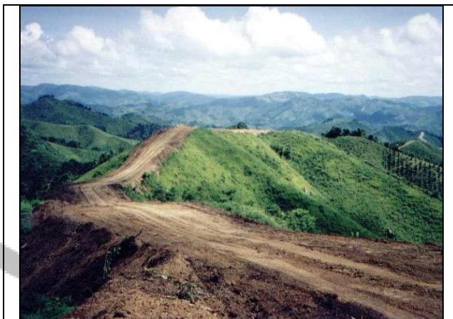
Foto IV.5.3.3-1 - Limpeza e abertura da faixa do GASTAU, durante sua implantação. Fonte: PETROBRAS
