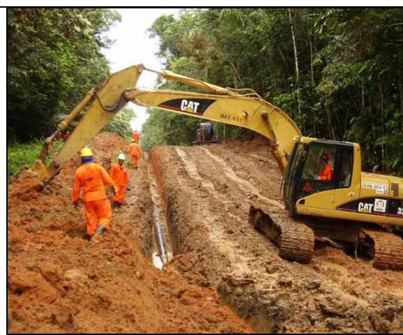
Foto IV.5.3.3-7 - Cobertura da vala utilizando uma escavadeira hidráulica. Fonte: PETROBRAS.
