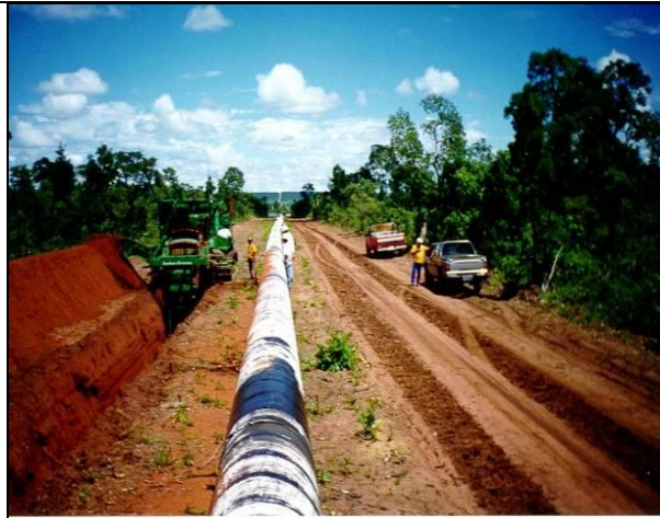
Foto IV.5.3.3-4 - Abertura de vala, à esquerda do duto, utilizando uma valetadeira. Fonte: PETROBRAS
