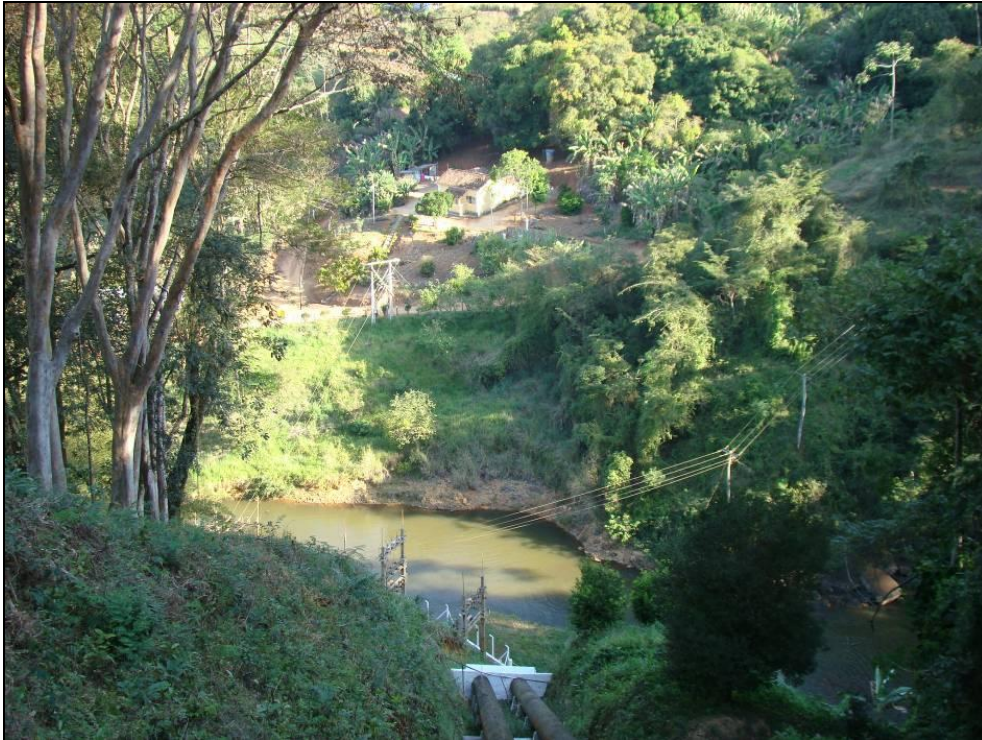
Foto 6.48 - Tubulação da Usina da Fumaça, com a fazenda homônima ao fundo, que terá o mineroduto no entorno próximo.
