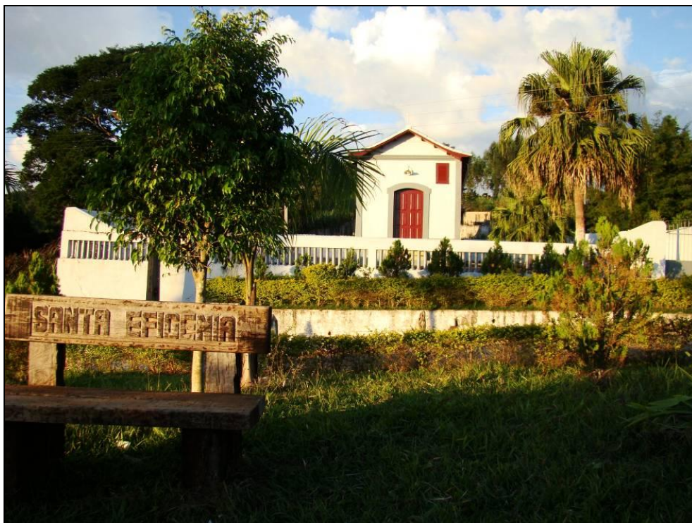
Foto 6.25 - Capela de Santa Efigênia, bairro Barra, em Itaverava, no entorno do futuro eixo do mineroduto
