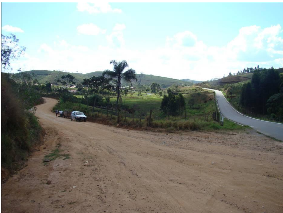
Foto 6.45 - Rodovia BR 356 na entrada para São Sebastião da Ventania (local onde será disposto o mineroduto)
