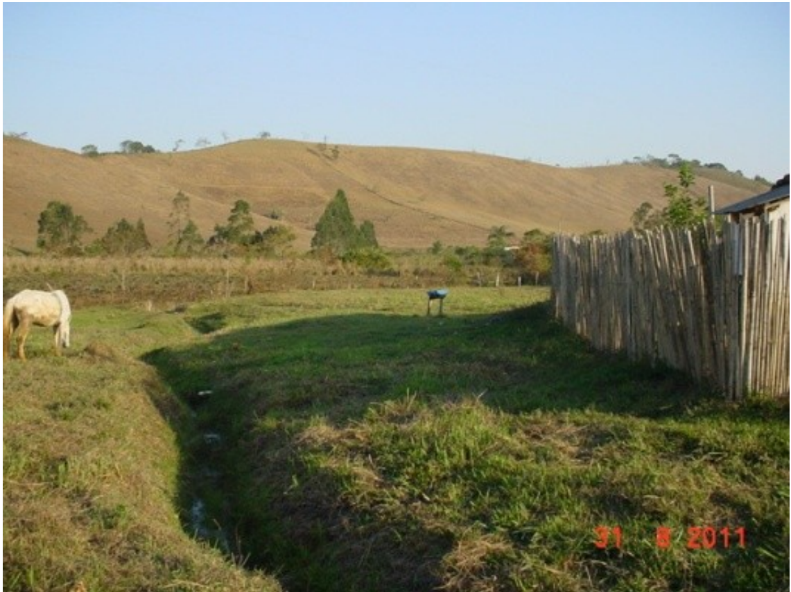
FOTO 371 – Vista geral do Ponto 3298.
