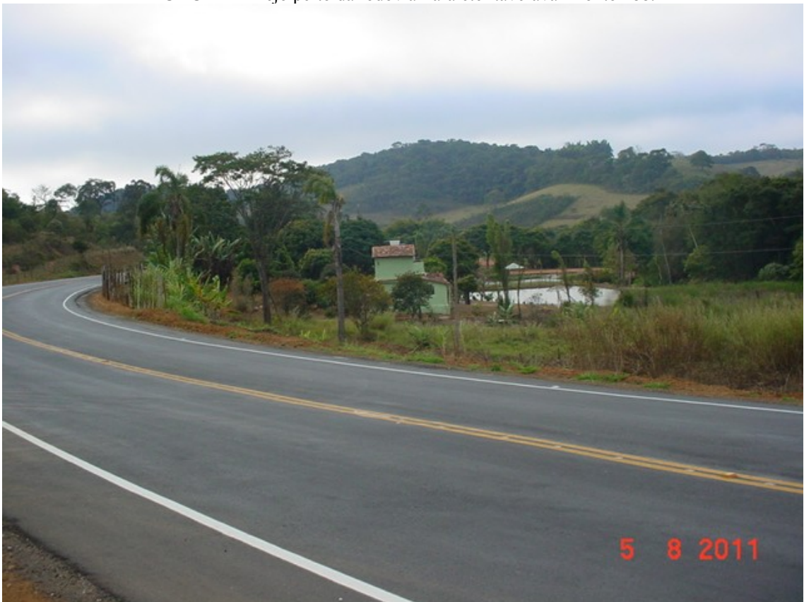
FOTO 15 – Vista da rodovia do Ponto 288.
