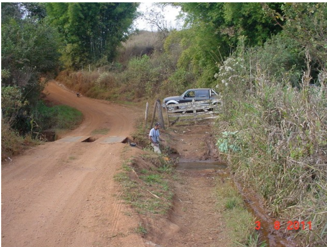
FOTO 11 – Vista geral do Ponto 246.
