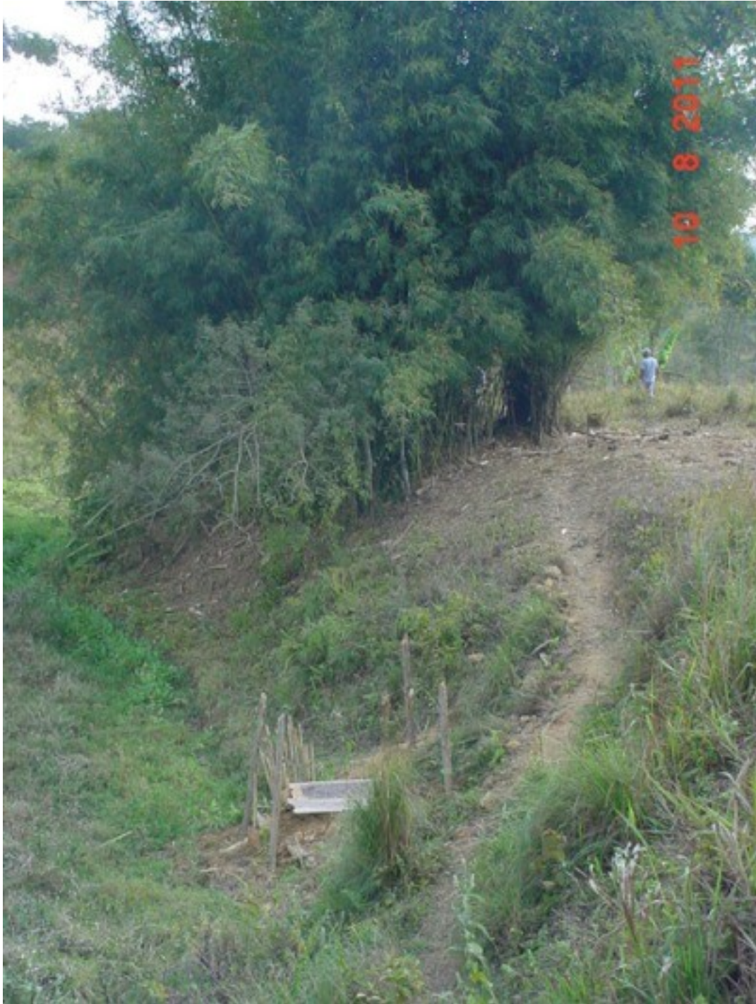
FOTO 111 – Nascente canalizada - Ponto 513.
