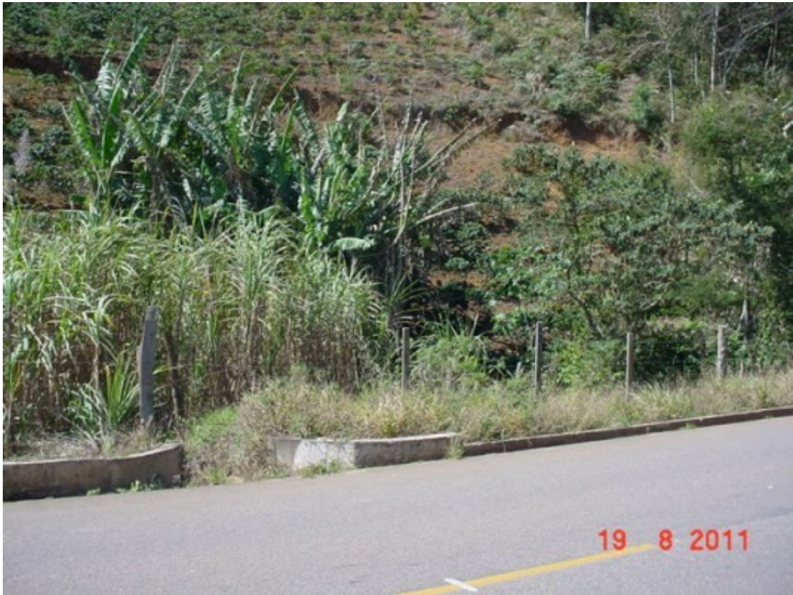
FOTO 207 – Vista geral do Ponto 3767.
