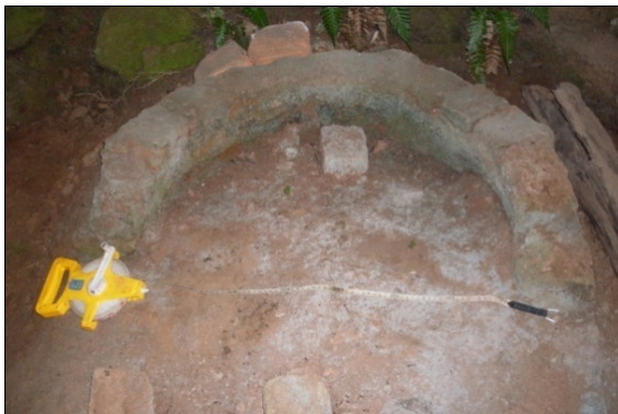
Foto 22 - Pequena estrutura de tijolo e concreto.
