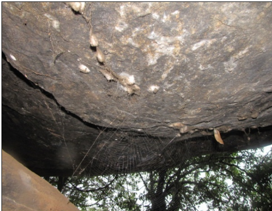
Foto 26 - Presença de teias e ninhos de Araneae na entrada da cavidade.
