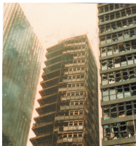
Figura 24 - Radiação de calor de um edifício para outro
