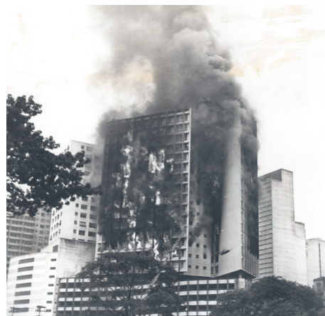
Figura 12 - Incêndio no Edifício Joelma
