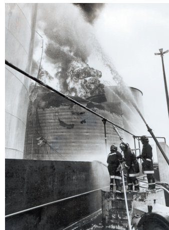
Figura 64 - Incêndio em parque de tanques
