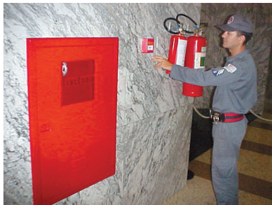
Figura 2 - Vistoria em edificação
