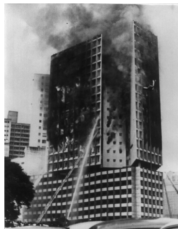
Figura 22 - Propagação por condução (contato direto das chamas)
