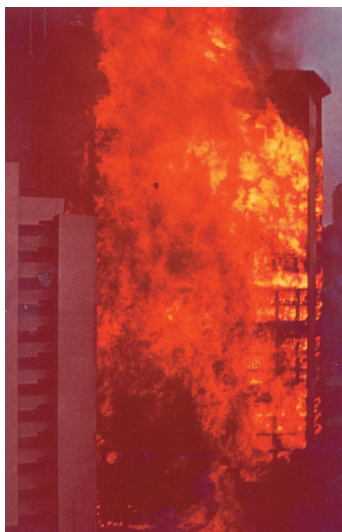
Figura 11 - Incêndio no Edifício Andraus
