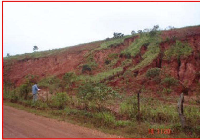
1 - Ocorrência de voçorocas as margens da estrada MG 010, próximo ao vilarejo de São Sebastião do Bom Jesus (km 15,5) com até 5 metros de profundidade. Solo do tipo latossolo vermelho-escuro associados ao Complexo Guanhaês e Suite Borrachudos
