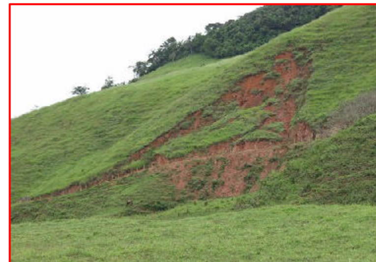
4 - Deslizamento em vertente íngreme no vale do córrego Agudo, município de Nova Era. O espesso manto de intemperismo, aliado a acentuada declividade do talude favorece a gênese dos processos erosivos.
