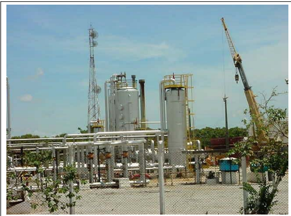
Foto 2 – Vista de uma unidade, semelhante à futura UTGCA
