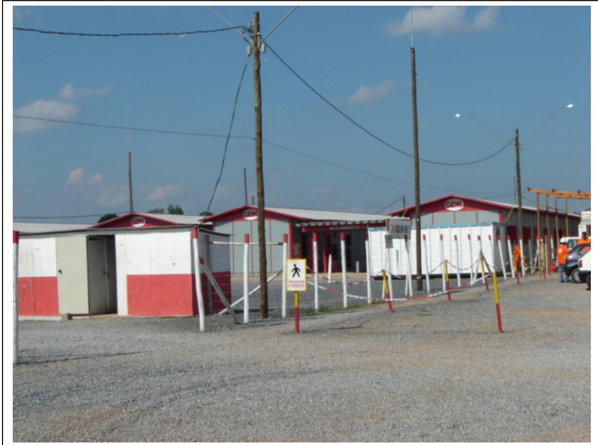
Foto 6 – Vista de um canteiro de obras
