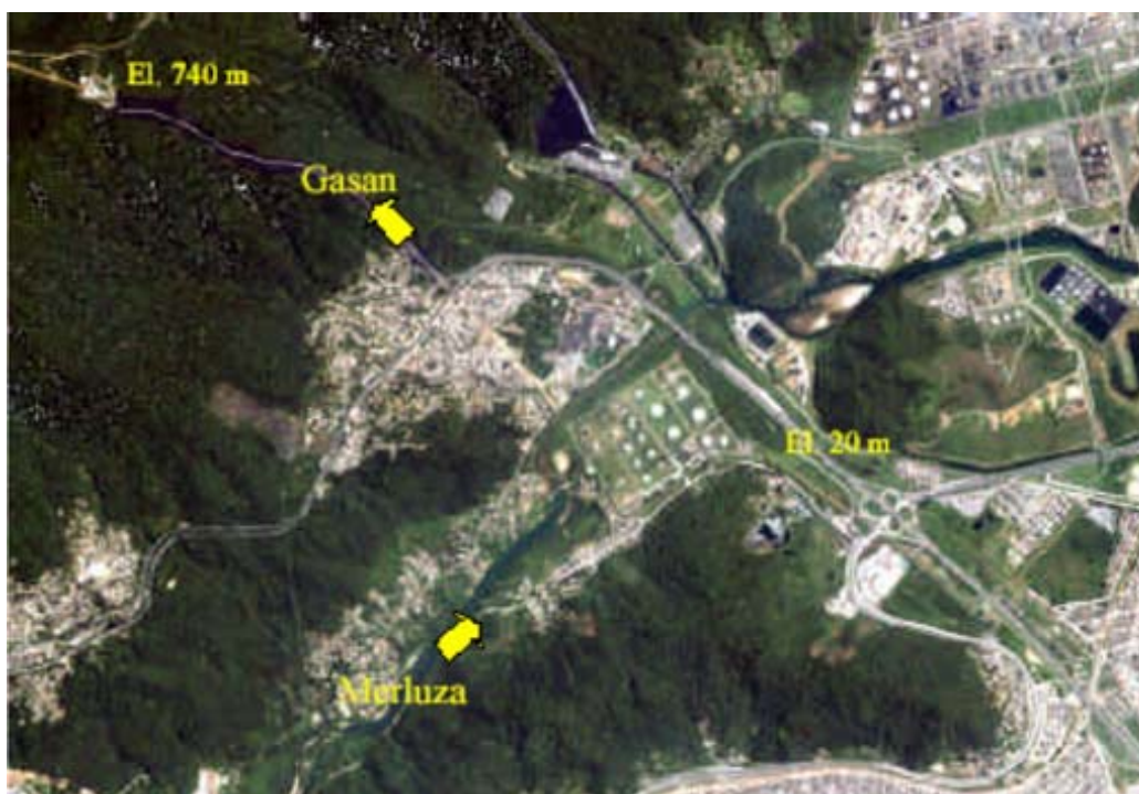
Foto 4-1 – Adensamento populacional urbano próximo às faixas existentes dos Gasodutos Merluza e GASAN.
