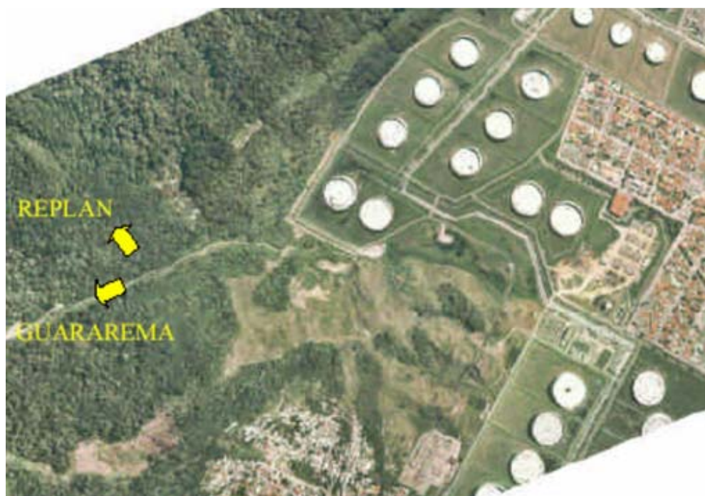
Foto 4-2 – Dificuldades construtivas no compartilhamento das faixas existentes em São Sebastião
