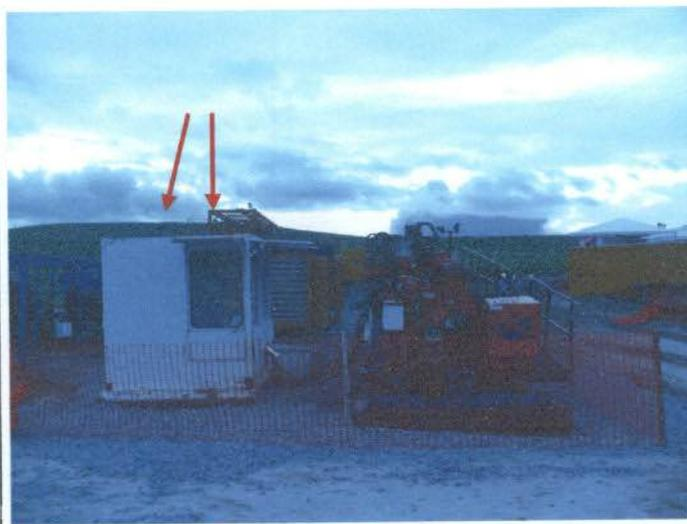
Foto 48: a raspagem do solo para o tráfego de veículos, e o aterro criado para locação da perfuratriz não contavam com qualquer contenção de sedimentos ou sistema de drenagem.
