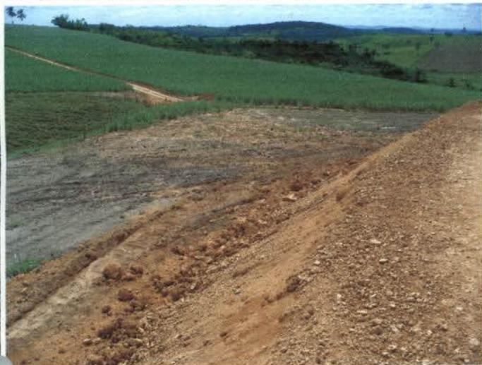
Foto 100: notar a formação de sulcos erosivos em razão da ausência de mecanismos de condução de águas pluviais.
