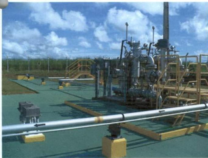
Foto 54: módulo de aquecedores, que fica posicionado após a filtragem.
