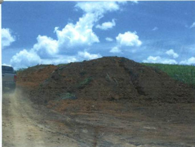
Foto 82: o solo superficial raspado do leito do acesso foi disposto sem qualquer contenção, permitindo sua dispersão pela chuva.
