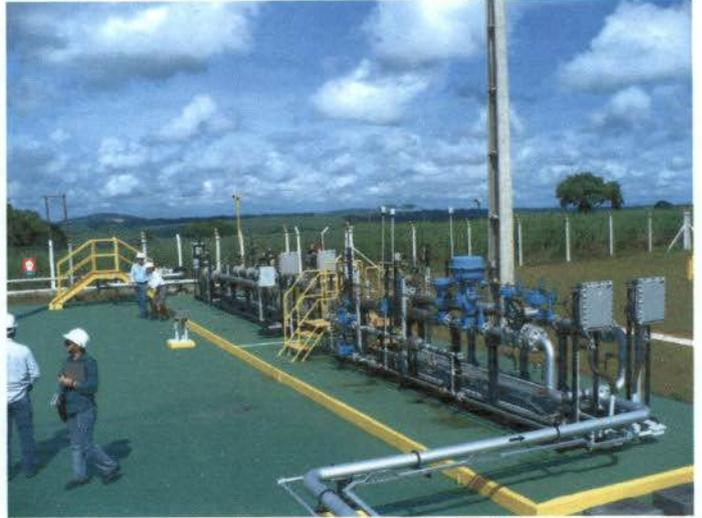
Foto 51: aspecto geral do PE de Rio Largo, com destaque para a casa que abriga equipamentos de controle remoto (shelter).
