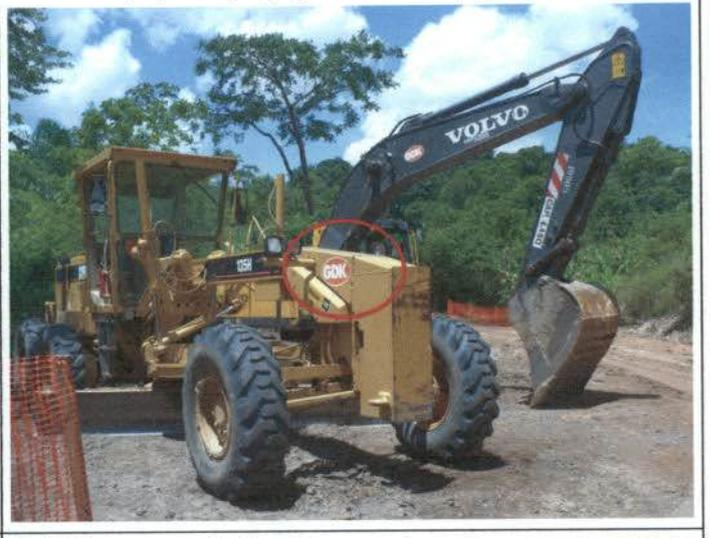
Foto 63: notar a camada superficial de solo raspado disposto inadequadamente junto a uma drenagem.
