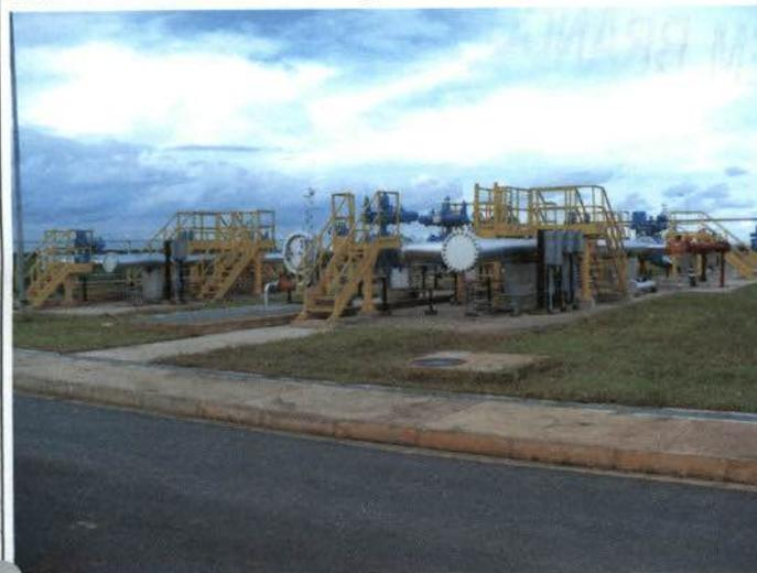
Foto 4: nova vista da área interna da EDG de Pilar. O local assinalado receberá os *scrappers* do Gasoduto Pilar-Ipojuca.
