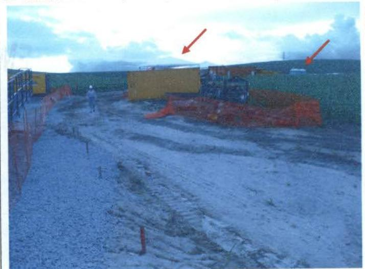
Foto 47: aterro criado para receber a perfuratriz. Ao fundo, à esquerda, o tanque de lama e equipamentos associados (setas)
