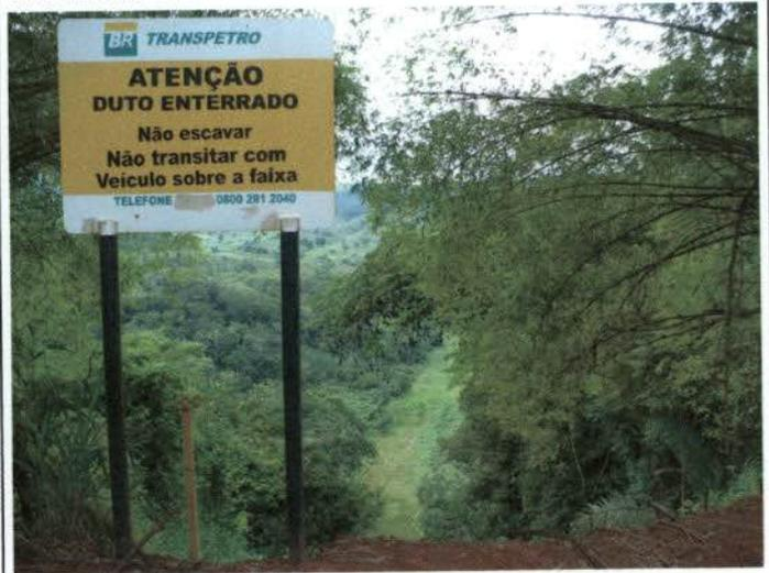
Foto 9: vista da faixa no sentido "norte" (para Ipojuca), a partir da estrada mostrada acima. Notar a elevada diferença de cota. O GASALP ocupa a porção esquerda da faixa. O alargamento de 12 para 20m exigirá supressão vegetal na lateral direita.
