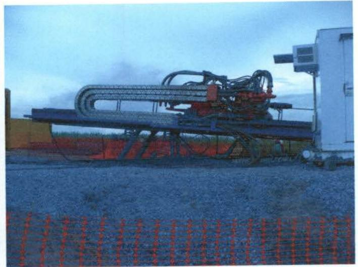
Foto 45: Nova vista da perfuratriz, cujo posicionamento demanda obras de terraplanagem e estabilização física do solo.
