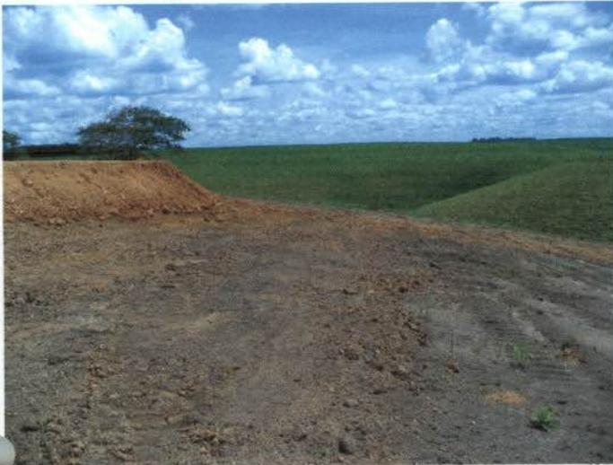
Foto 98: engenheiro da Petrobras alertou que seria instalado um sistema de drenagem. Tal fato não elimina a necessidade de contenções provisórias até a conclusão daquelas obras.
