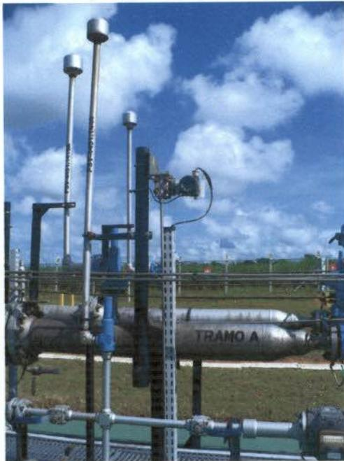
Foto 56: válvulas de alívio no módulo de filtragem. O uso do fogo no corte da cana preocupou os analistas pela proximidade
