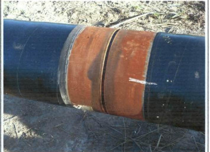
Foto 123: solda concluída, faltando apenas a aplicação da tripla camada de polietileno. Notar o cronograma riscado no tubo.
