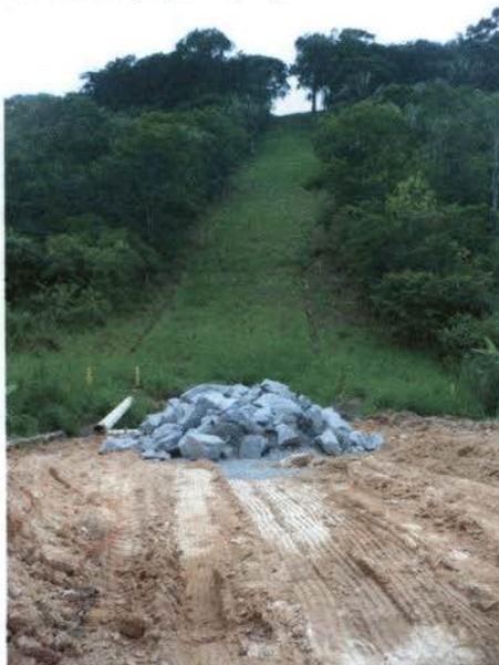
Foto 24: nota-se que os trabalhos foram interrompidos de modo abrupto e que não havia a proteção adequada das margens.
