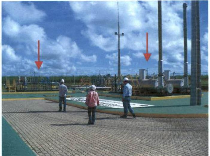
Foto 53: módulo de filtragem do gás natural que chega no PE Rio Largo através do GASALP.
