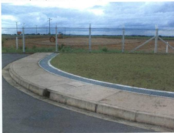
Foto 6: canaleta perimetral de condução de águas pluviais e cercamento da área da EDG de Pilar.
