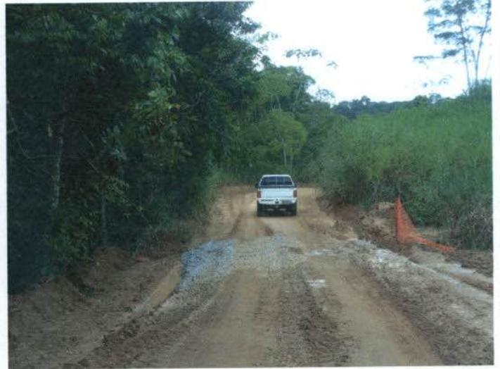
Foto 15: As cercas plásticas colocadas junto a corpos d'água são inadequadas para conter o carreamento de sedimentos da camada superficial de solo que, após a raspagem, ficou depositada indiscriminadamente nas laterais dos acessos.
