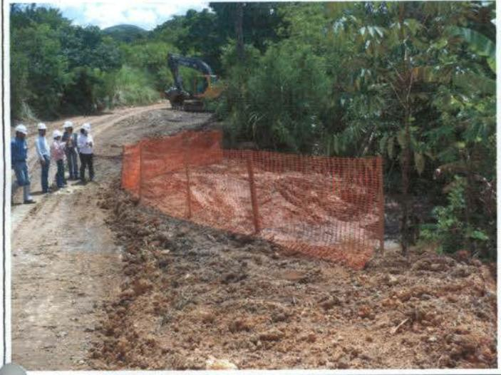
Foto 64: a cerca plástica é incapaz de conter o carregamento de sedimentos pela água das chuvas.
