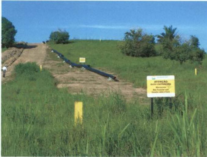
Foto 116: o solo raspado da superfície do novo acesso foi disposto nas suas laterais, de novo sem mantas de contenção.
