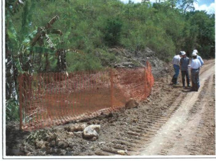
Foto 66: o assoreamento da drenagem atesta a necessidade de apresentação do projeto e aprovação prévia da intervenção.
