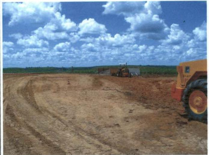
Foto 95: extremidade do terrapleno. A ausência de contenções possibilitou o aparecimento inicial de sulcos erosivos.
