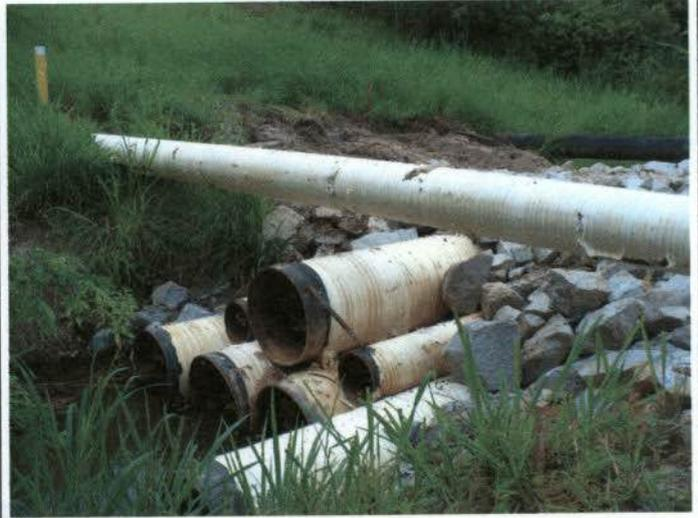
Foto 27: disposição de terra sem qualquer contenção, como por exemplo cercas-filtro, contra o carreamento de sedimentos.
