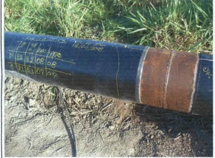
Foto 124: detalhe da solda acabada, o que comprova que a da foto acima foi de fato suspensa antes de sua conclusão.
