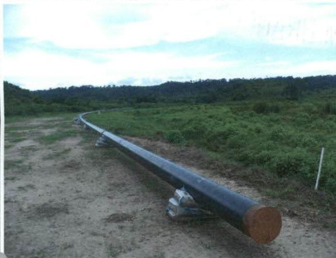
Foto 22: a coluna de tubos (foto anterior) está situada no local assinalado. Notar, pela distância até o marco de faixa situado junto à área de vivência (ver foto 17), a ordem de grandeza do sítio necessário à montagem da coluna.
