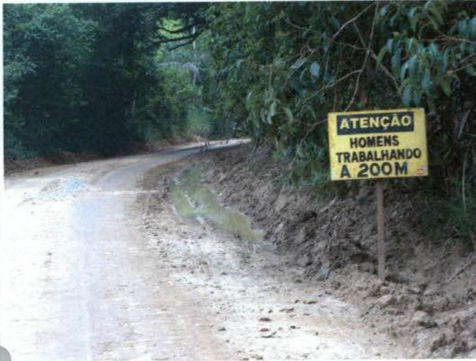
Foto 14: o acesso ao km 10 apresentava resultado da passagem de máquinas para raspagem da camada superficial de solo, com objetivo de melhorar a trafegabilidade e alargar o leito carroçável.
