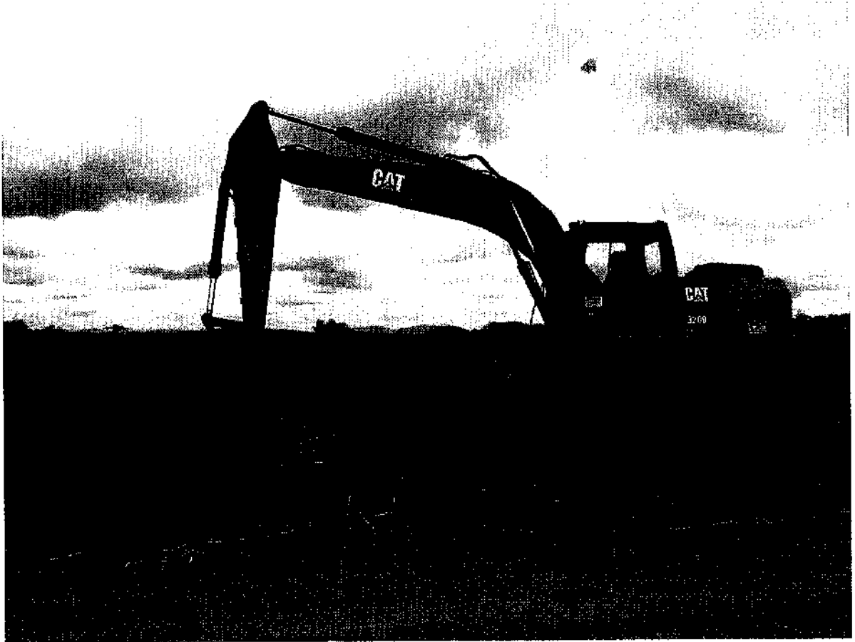
Início da Escavação Mecânica (região de canalial)
