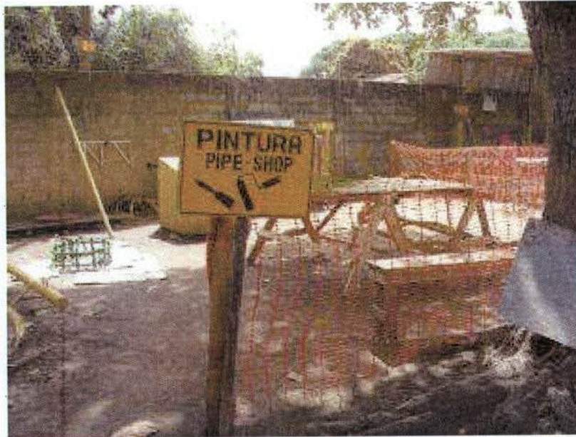
Foto 3- Área de Pintura Industrial.
