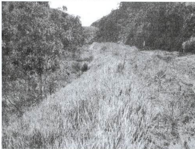
Foto 39: Km 156,5 – recuperação ótima de talude lateral (aterro).
