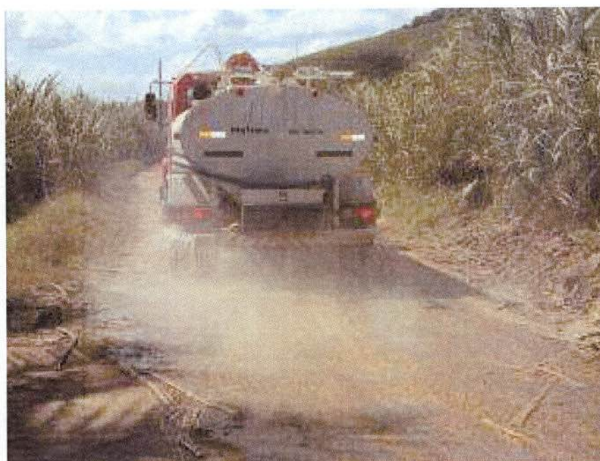
Foto 15- Umectação em área de acesso.
