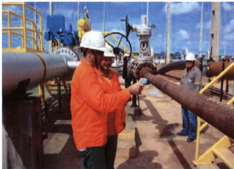
Foto 3. Acompanhamento da temperatura no ponto e injeção
