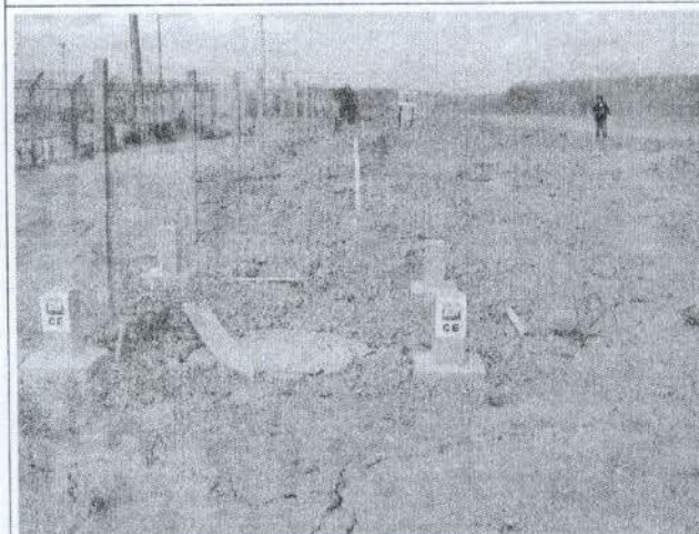
Foto 23: instalação de fibra-ótica.
