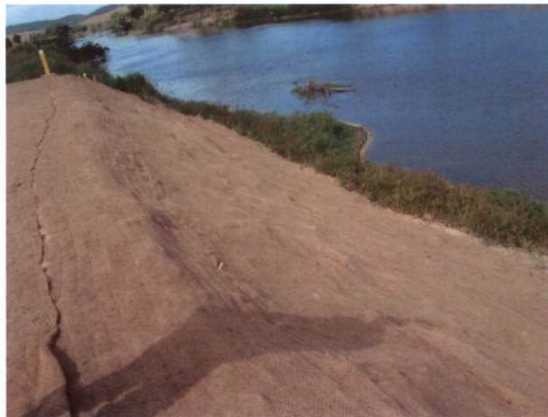
Figura 8- Rio Una – Km 117.
