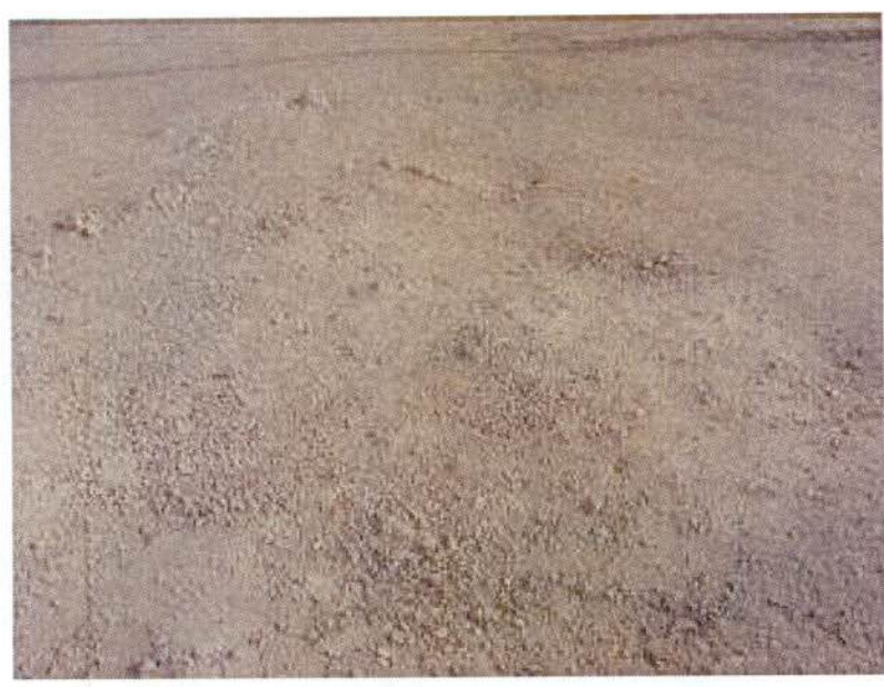
Foto 1- Piso do canteiro Rio Largo (AL).
