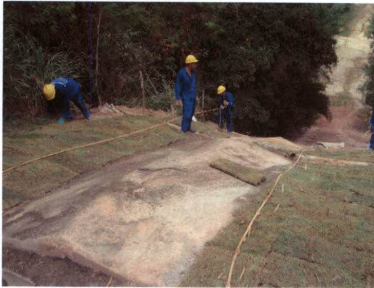
Figura 14- Instalação das Placas de Grama – Km 07.
