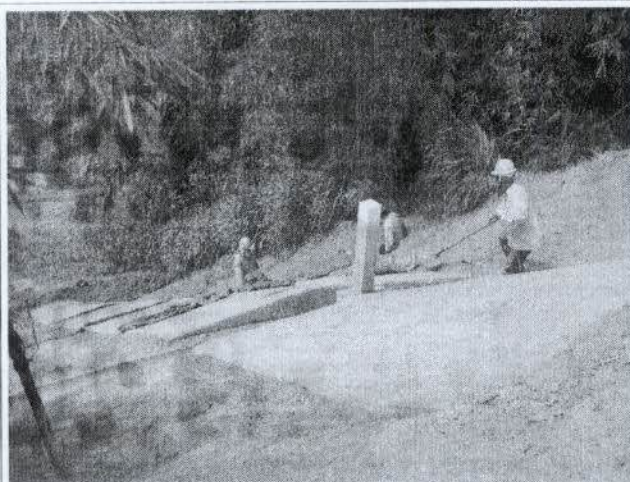
Foto 19: detalhe da atividade de coroamento.
