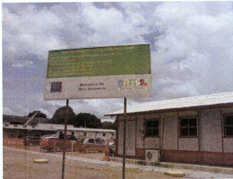
Foto 4- Placa com informações do empreendimento. Canteiro Rio Largo. Modelo IBAMA.
