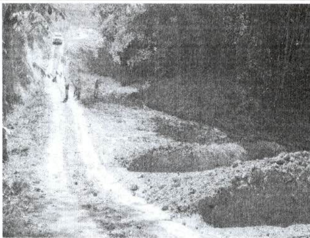
Foto 37: Km 157 – atividade de instalação de canaletas definitivas.
