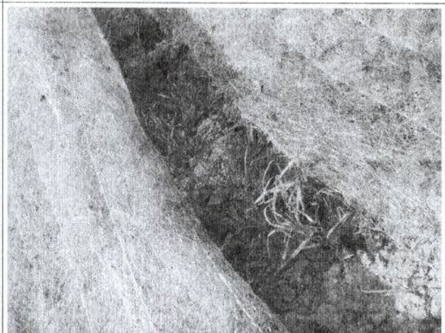
Foto 42: detalhe de brotamento sob a biomanta.
