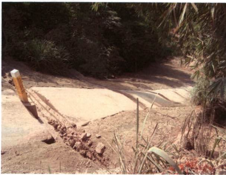
Figura 13- Coroamento em fase de conclusão – Km 07.
