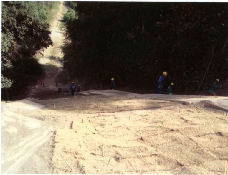
Figura 12- Instalação das Placas de Grama e Drenagem – Km 07.
