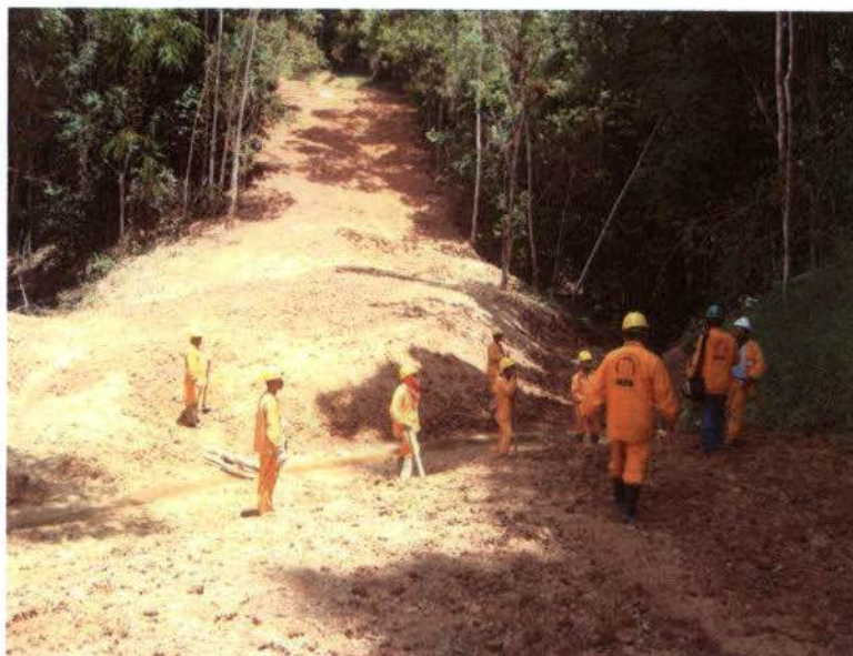
Figura 5- Equipe trabalhando – Km 157.
