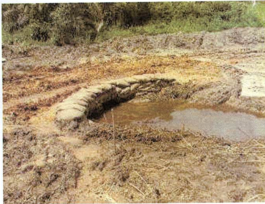
Foto 12- Contenção provisória próximo a corpo hídrico.
