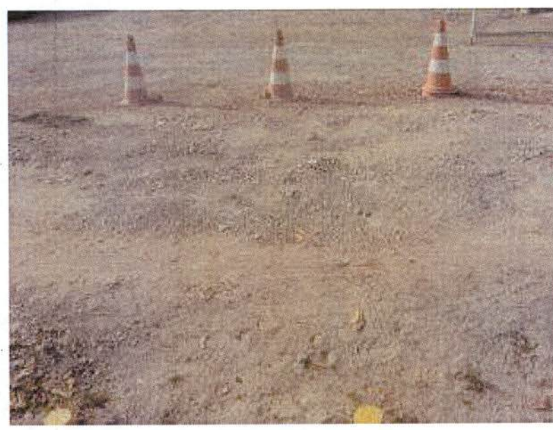
Foto 2- Piso do canteiro Rio Largo (AL).
