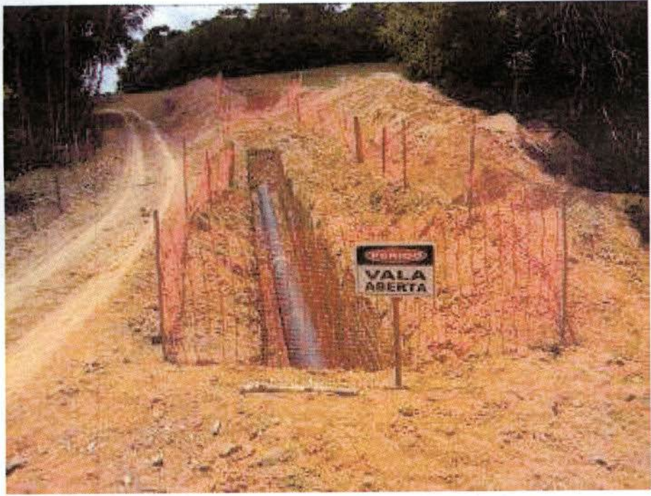
Foto 16- Disposição de cerca, rampa e placa no km 119.
