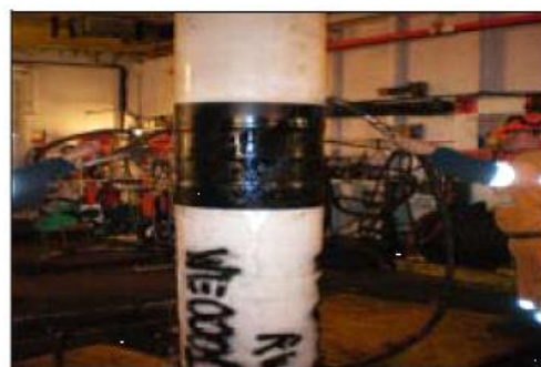
Figura 3.4-27 - Aplicação do revestimento e da manta termocontrátil na junta dos Quad Joints. Fonte: Petrobras.
