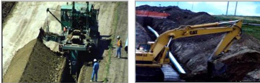
Figura II.2.4-56 - Abertura de vala com valetadeira e retroescavadeira. Fonte: PETROBRAS.
