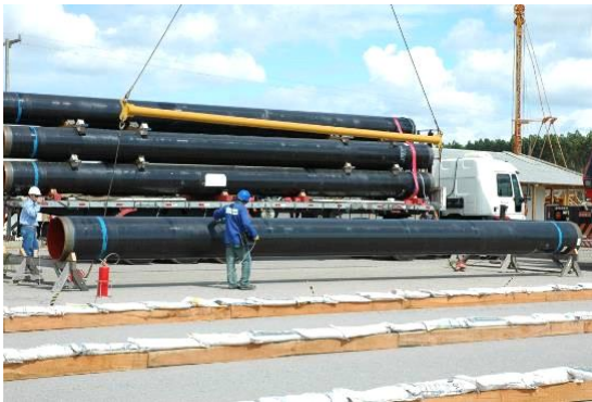
Figura 3.4-64 - Exemplo de movimentação e transporte de tubos. Fonte: Petrobras.
