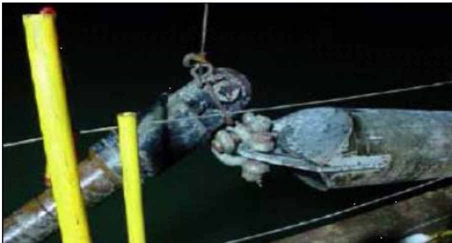
Figura 3.4-38 - Recuperação das hastes e do duto para conexão.
