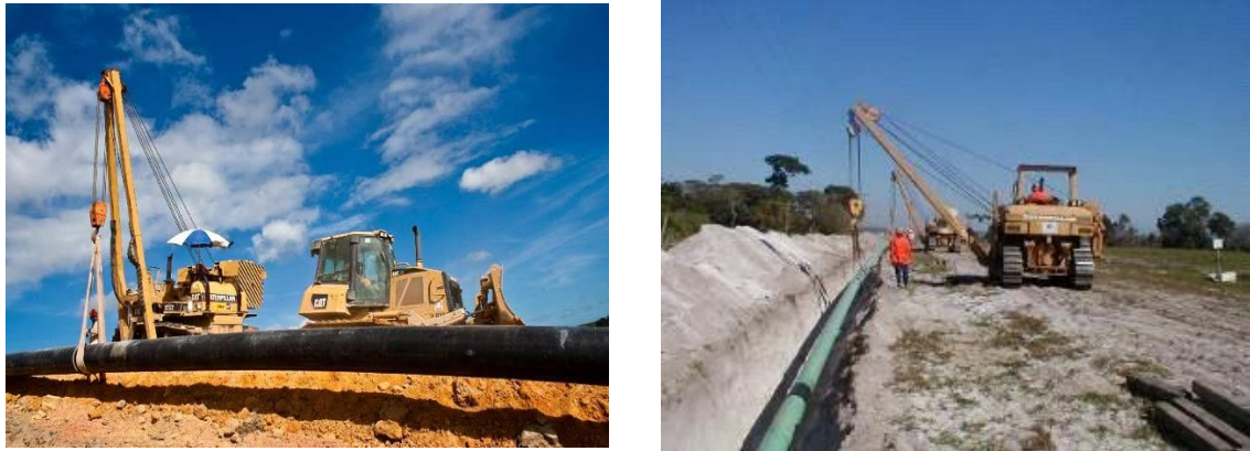
Figura 3.4-54 - Abaixamento da tubulação na vala. Fonte: Petrobras.
