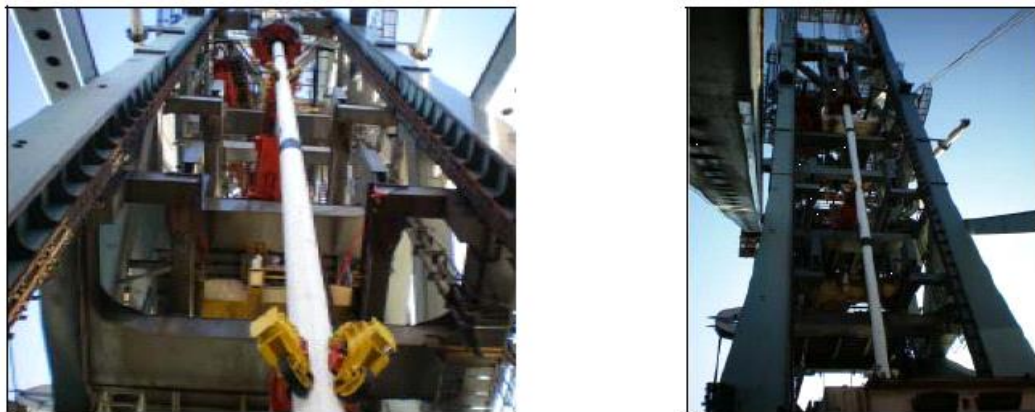
Figura 3.4-23 - Verticalização dos Quad Joints. Fonte: Petrobras.
