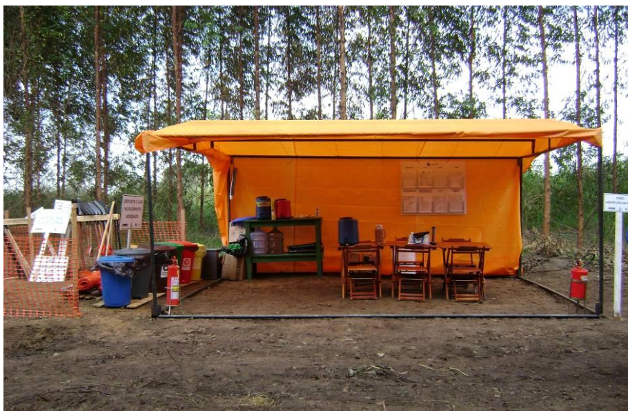
Figura 3.4-61 - Exemplo de área de convivência de frente de obra.
