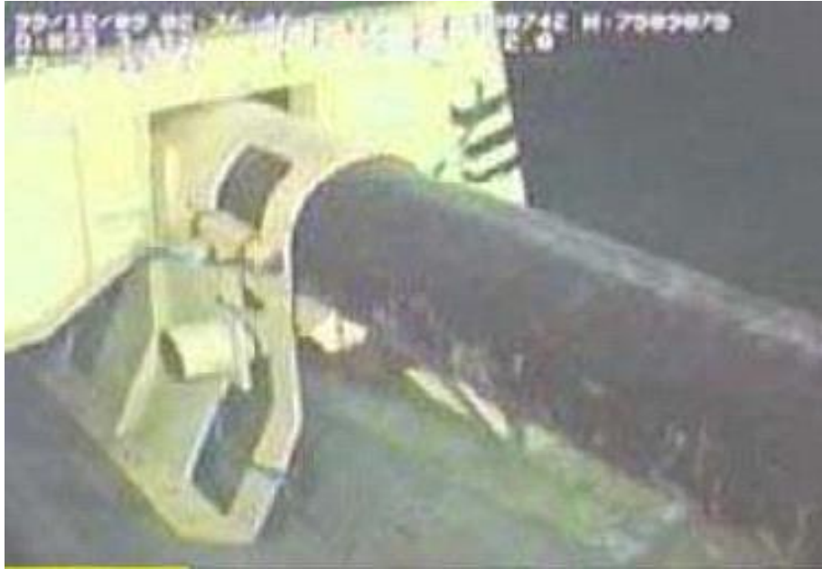
Figura 3.4-40 - Exemplo de calçamento com suporte metálico. Fonte: Petrobras.
