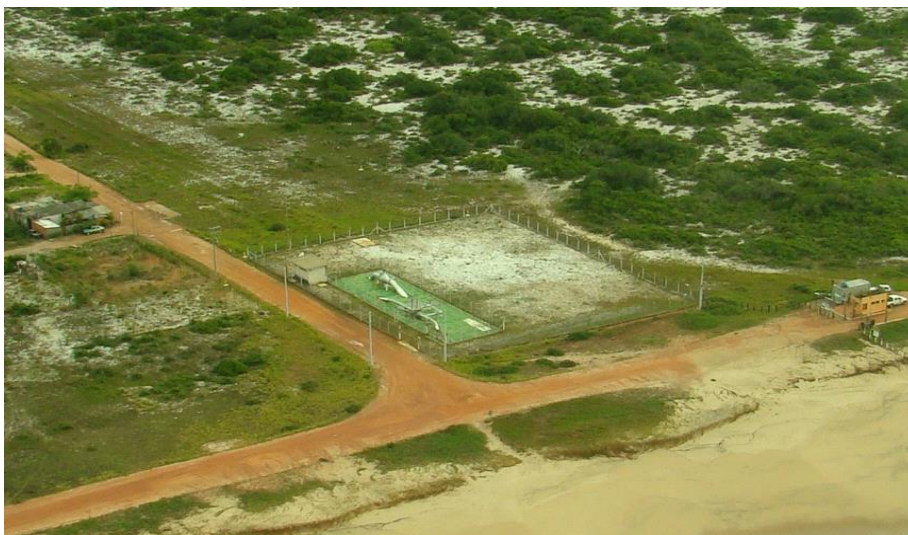
Figura 3.4-7 - Área de Scraper - típica. Fonte: Petrobras.
