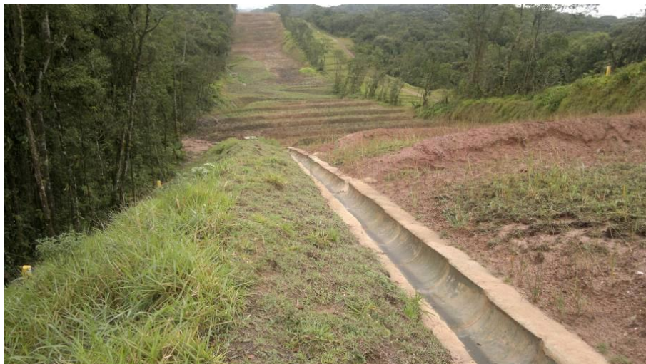
Figura 3.4-57 - Drenagem Superficial. Fonte: Petrobras
