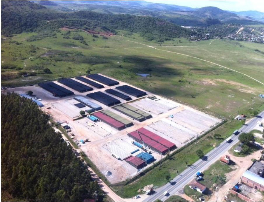
Figura 3.4-62 - Pátio de armazenamento de tubos existente de Itaboraí (RJ). Fonte: Petrobras.
