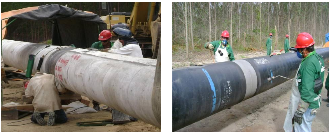
Figura 3.4-51 - Exemplo de concretagem e aplicação de manta nas juntas soldadas.
