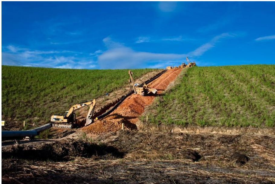
Figura 3.4-49 - Escavação de valas - típico. Fonte: Petrobras.
