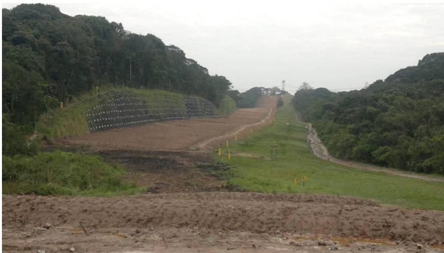
Figura 3.4-58 - Exemplo de Sinalização da faixa dos dutos.
