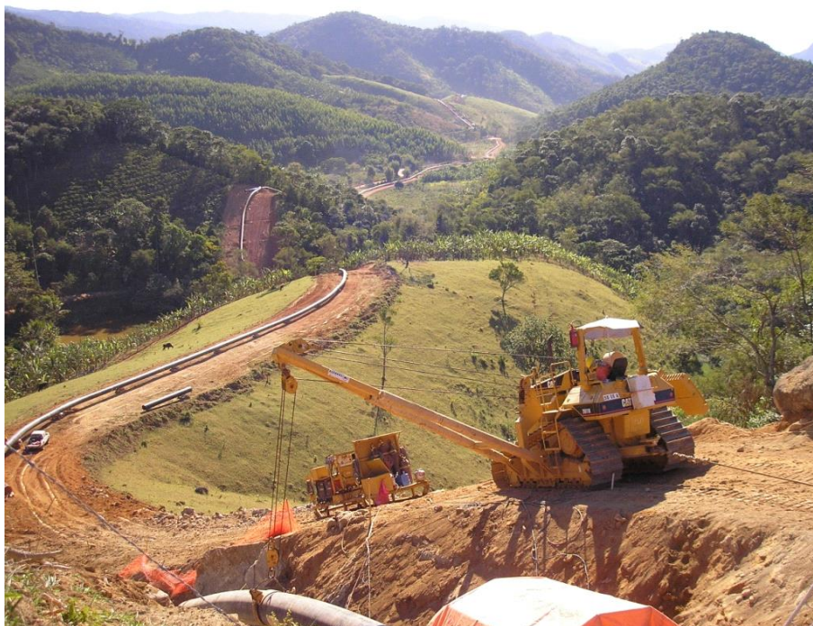
Figura 3.4-53 - Desfile de tubos e abaixamento na vala. Fonte: Petrobras.
