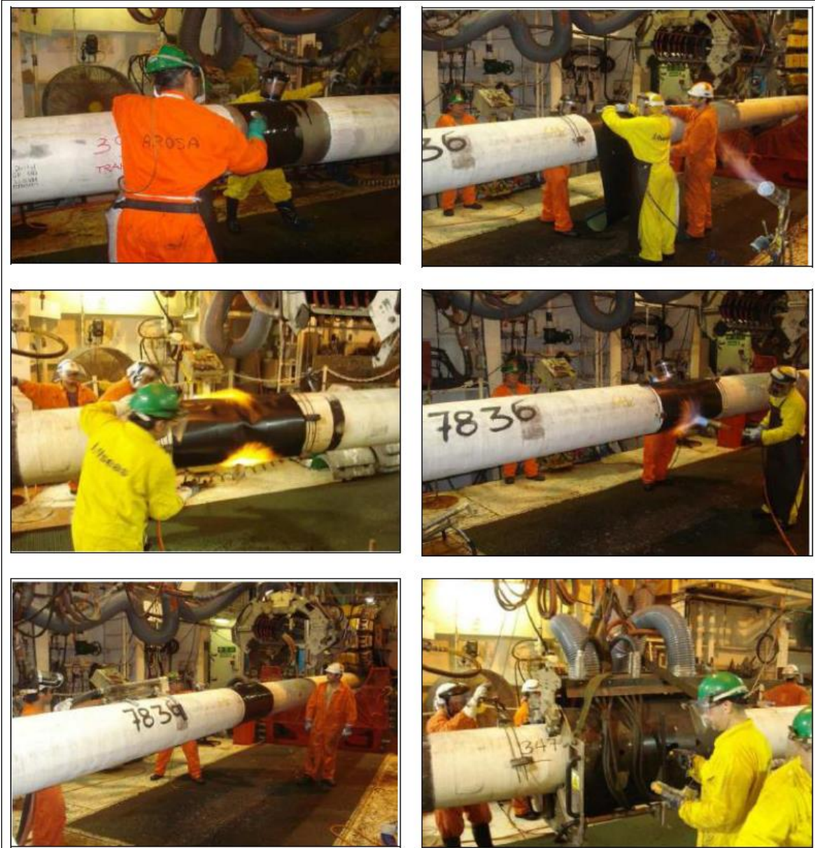
Figura 3.4-14 - Aplicação do revestimento (aplicação de prime e colocação da manta termocontrátil). Fonte: Petrobras.
