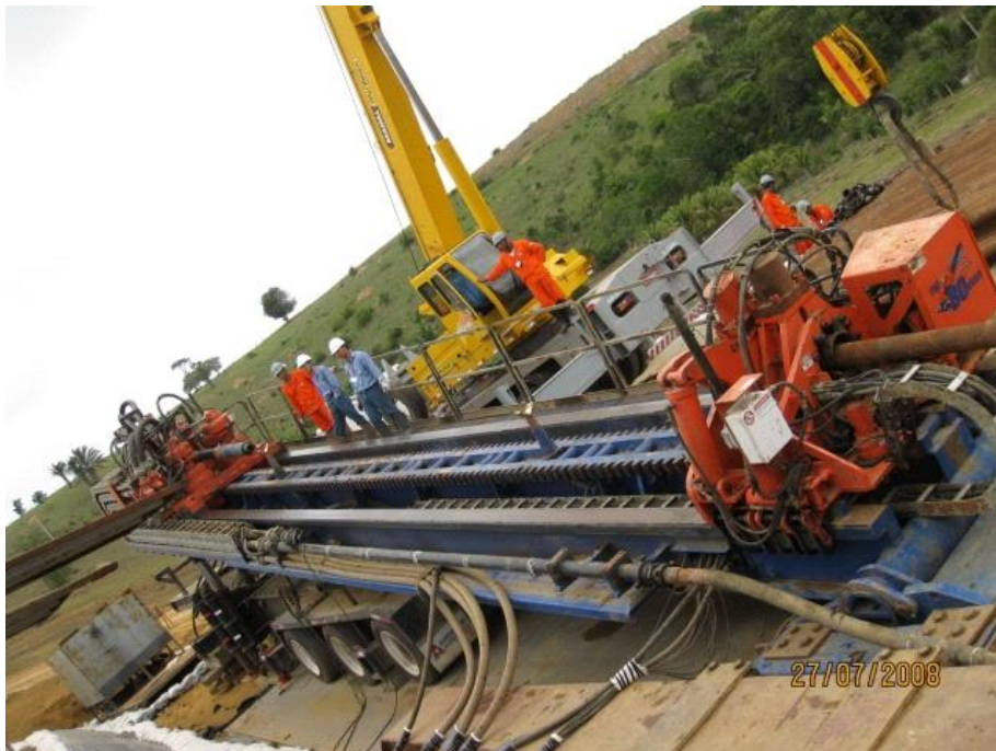
Figura 3.4-30 - Execução do Furo direcional - típico. Fonte: Petrobras.
