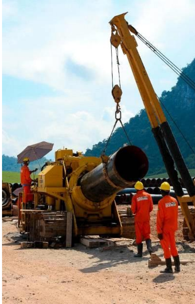
Figura 3.4-50 - Curvamento de tubos. Fonte: Petrobras.
