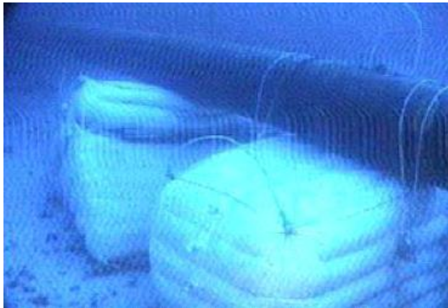
Figura 3.4-41 - Exemplo de calçamento com “grout bag”. Fonte: Petrobras.
