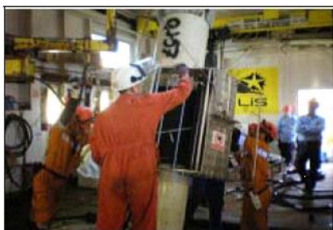
Figura 3.4-27 - Aplicação do revestimento e da manta termocontrátil na junta dos Quad Joints. Fonte: Petrobras.
