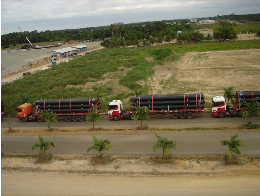
Figura 3.4-46 - Transporte de tubos em carretas- típico. Fonte: Petrobras.
