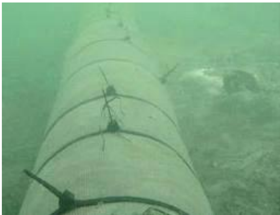
Figura 3.4-44 - Tubulação concretada - Típica.
