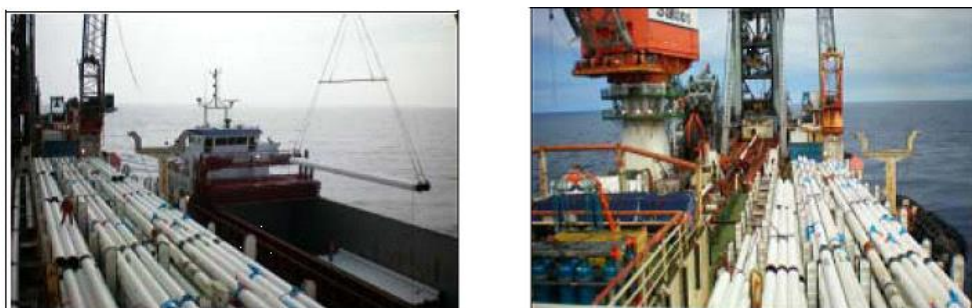
Figura 3.4-20 - Recebimento dos tubos na embarcação lançadora.
