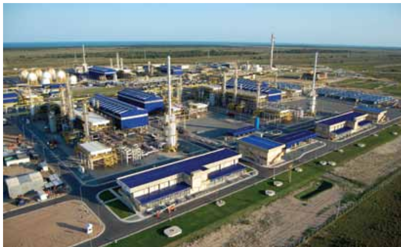
Vista aérea da UTGC (Unidade de Tratamento de Gás de Cacimbas).
