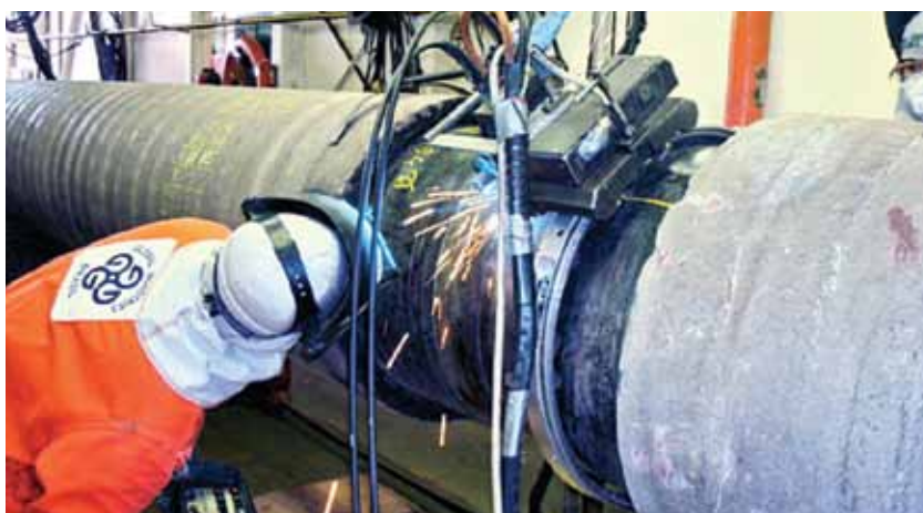
Dutos para transporte de gás, revestidos em concreto, sendo soldados.
