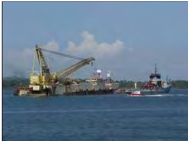
Figura II.2.4.1.1.4-1 – BGL-1 sendo rebocada para a locação
