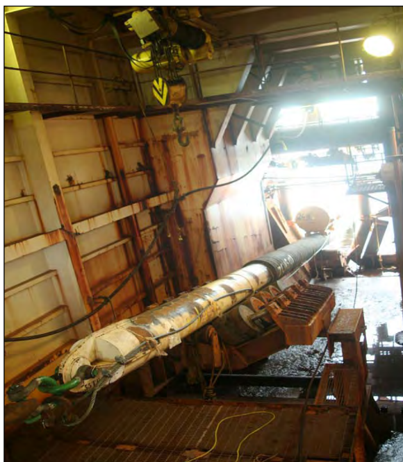
Figura II.2.4.2.1-4 – Foto exemplificando a cabeça de abandono e recolhimento do duto em embarcação Típica S-Lay.
