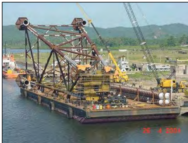
Figura II.2.4.1.1.3-1 – Balsa com jaqueta e estacas da Plataforma PPER-1 pronta para ser rebocada
