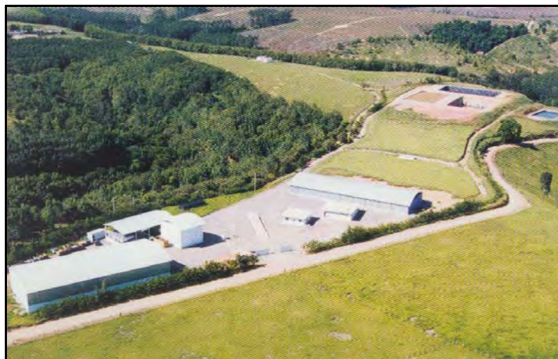
Figura II.5.3.2.3-4 - Vista aérea da empresa Vitória Ambiental no município da Serra-ES.
