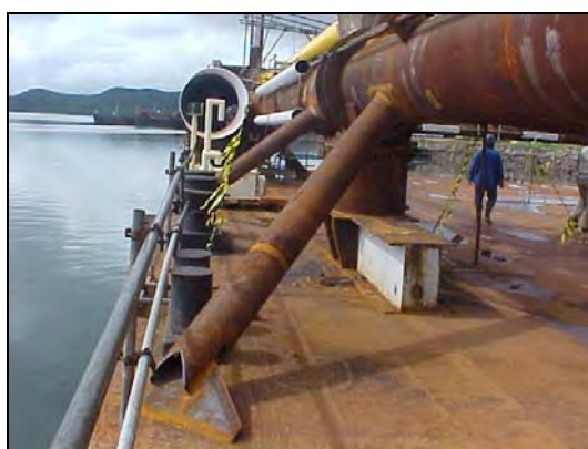
Figura II.2.4.1.1.2-3 – Jaqueta apoiada nas estruturas da balsa
