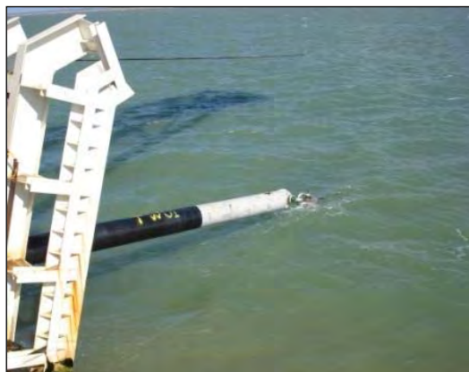
Figura II.2.4.2.1-5 – Foto exemplificando a operação de inicialização de uma linha em embarcação Típica S-Lay.
