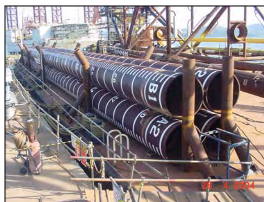
Figura II.2.4.1.1.2-4 – Estacas apoiadas nas estruturas da balsa
