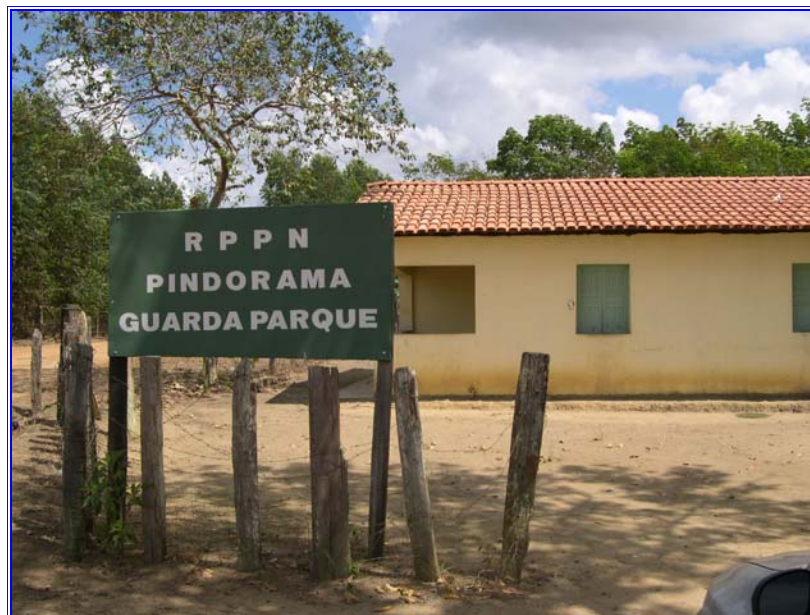
Foto 63. Recepção e apoio aos guarda-parques (UTM 436773/8158571). (Foto: Bourscheid S.A.)
