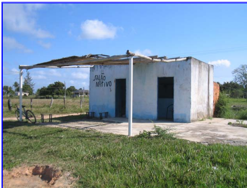
Foto 74. Construção atingida pela ampliação do traçado (E417420/N7907548). (Foto: Bourscheid S.A.)
