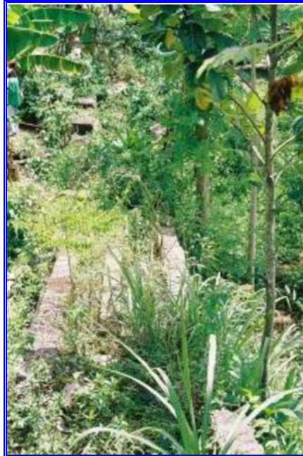
Foto 5.275- Ruínas da Canaleta de pedras escondida entre a vegetação. Foto Mirta Barbosa
