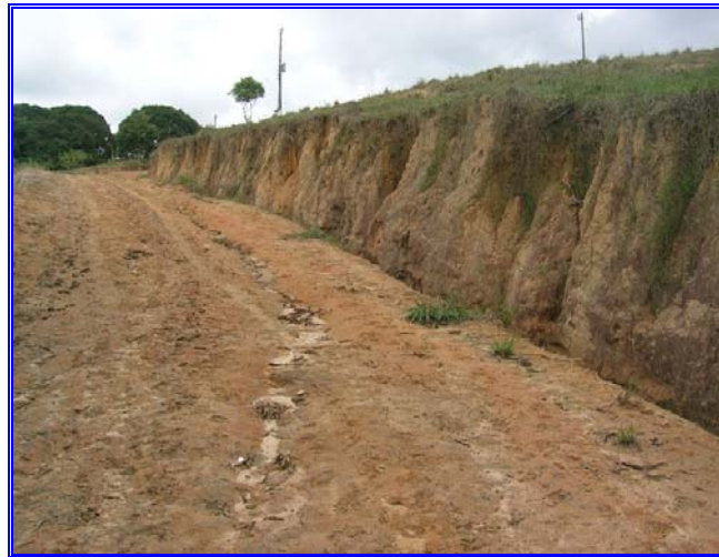
Foto 5.227- Barranco ao longo de estrada próximo ao eixo do gasoduto, utilizado para observação de sub-superfície. Foto Christiane Machado
