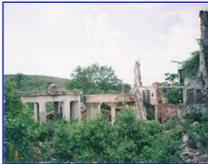
Foto 5.276- Ruínas da antiga Usina Passagem. Foto Mirta Barbosa
