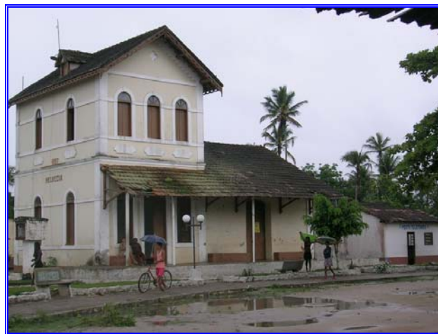
Foto 5.254- Estação ferroviária desativada do século XIX, em Helvécia. Foto Christiane Machado.
