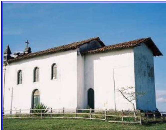
Foto 5.279- Vista da lateral da Capela. Foto Mirta Barbosa
