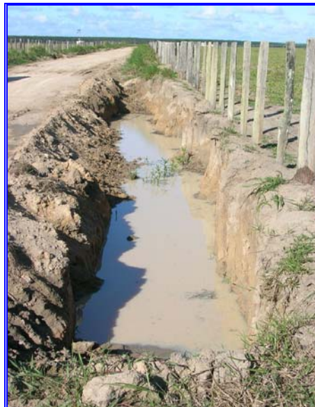
Foto 5.228- Vala ao longo de estrada próximo ao eixo do gasoduto, utilizado para observação de sub-superfície. Foto Christiane Machado
