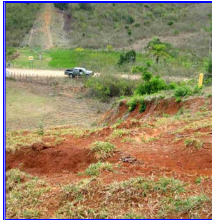
Foto 5.89- Área com problemas de conservação, coordenadas 436176 e 8414448. Foto BOURSCHEID
