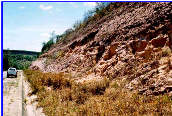
Foto 5.54- Perda diferencial da camada argilosa do Grupo Barreira em barranco de estrada – Coordenadas E: 415944, N: 8029900. Foto BOURSCHEID
