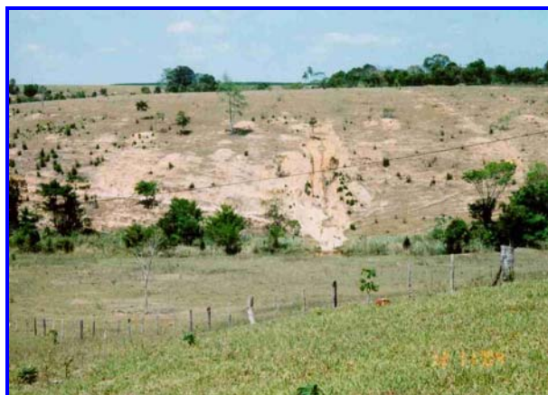
Foto 5.52- Processos erosivos nas quebras do tabuleiro – Coordenadas E: 419798, N: 8024179. Foto BOURSCHEID
