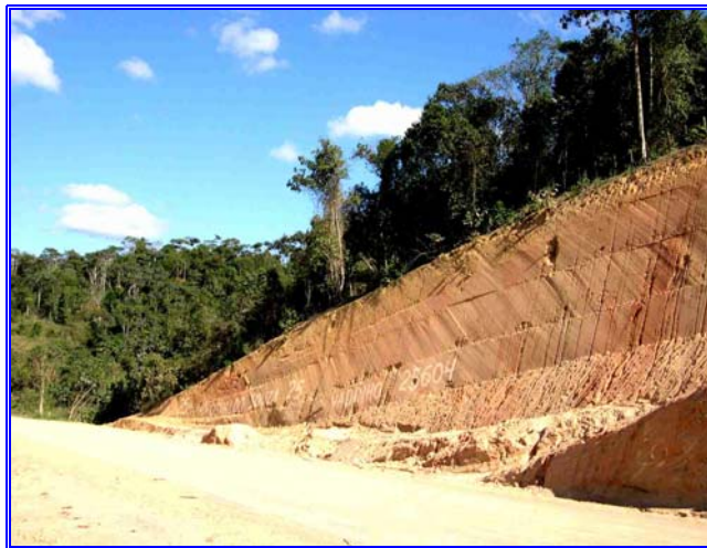
Foto 5.57- Taludes resistentes de granulitos da unidade A3jm – Coordenadas E: 442639, N: 8479761.
