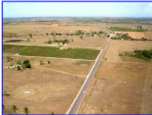
Foto 5.35- Tabuleiro Costeiro (TC) – Coordenadas E: 397074, N: 7931305. Foto BOURSCHEID
