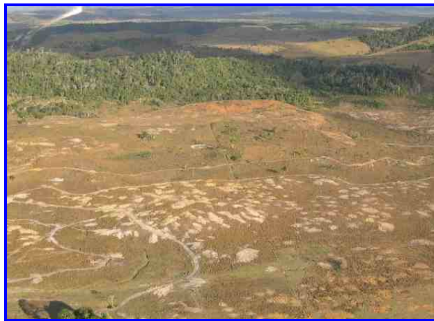
Foto 5.51- Processos erosivos nas quebras do tabuleiro – Coordenadas E: 449120, N: 8248218. Foto BOURSCHEID
