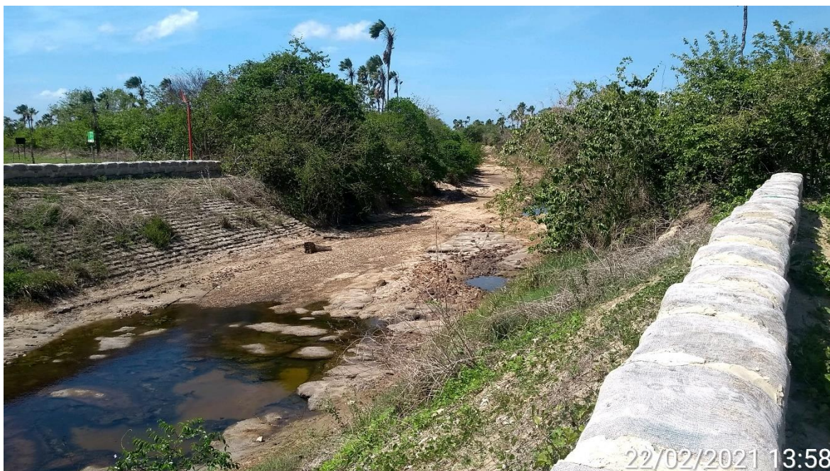
Figura 2.4-13 – Travessia do GASFOR II sobre o rio Cauipe, km 81 do traçado
