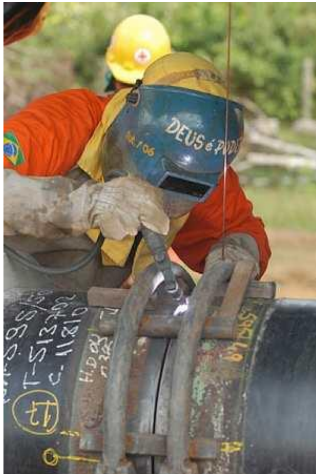
Figura 2.4-6 – Soldagem do GASFOR II
