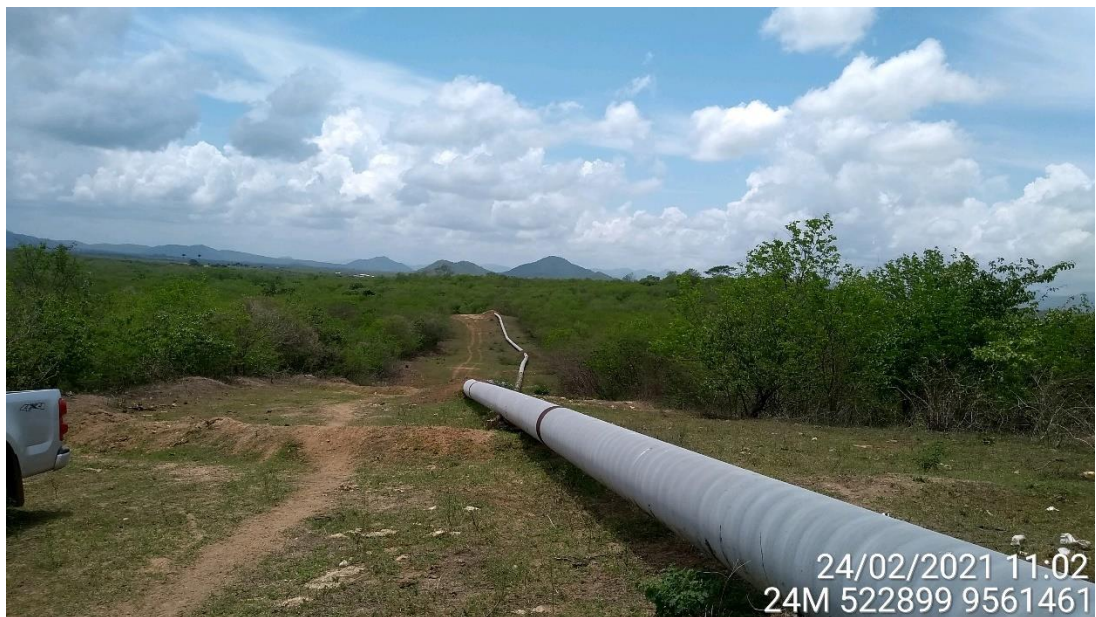
Figura 2.4-7 – Coluna soldada do GASFOR II, no km 51 do Gasoduto
