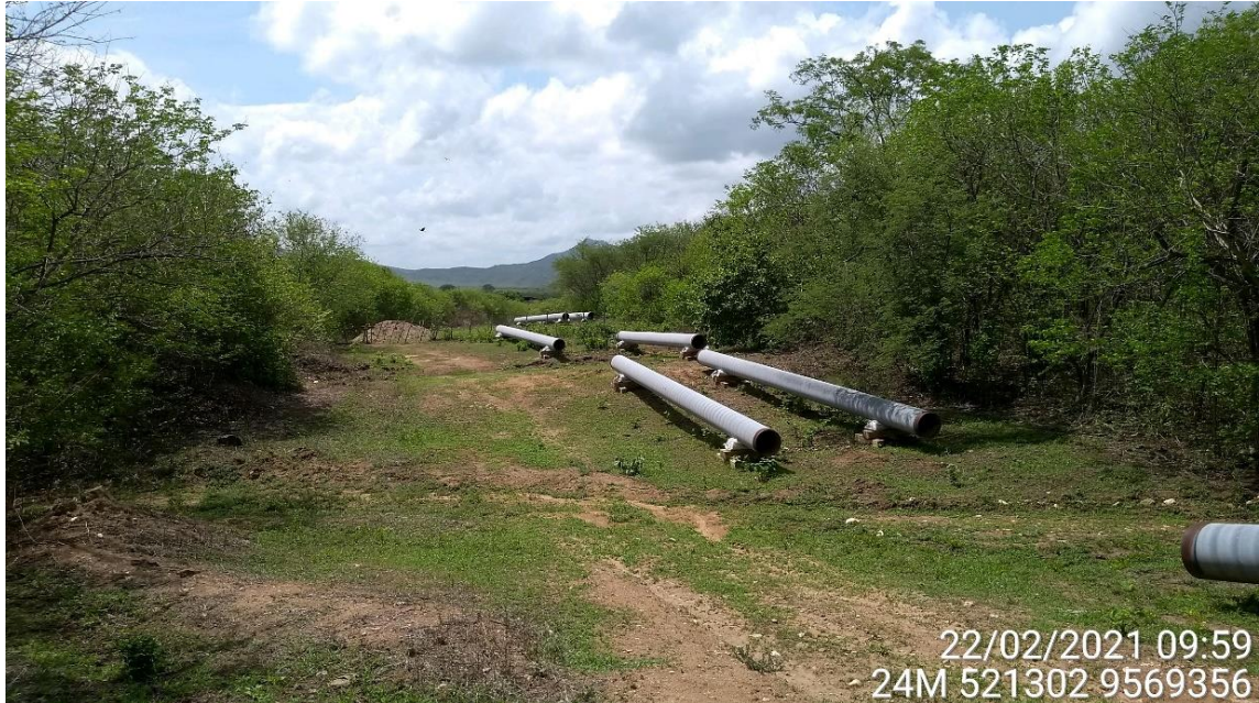
Figura 2.4-5 – Desfile de tubos do GASFOR II, no km 59 do Gasoduto
