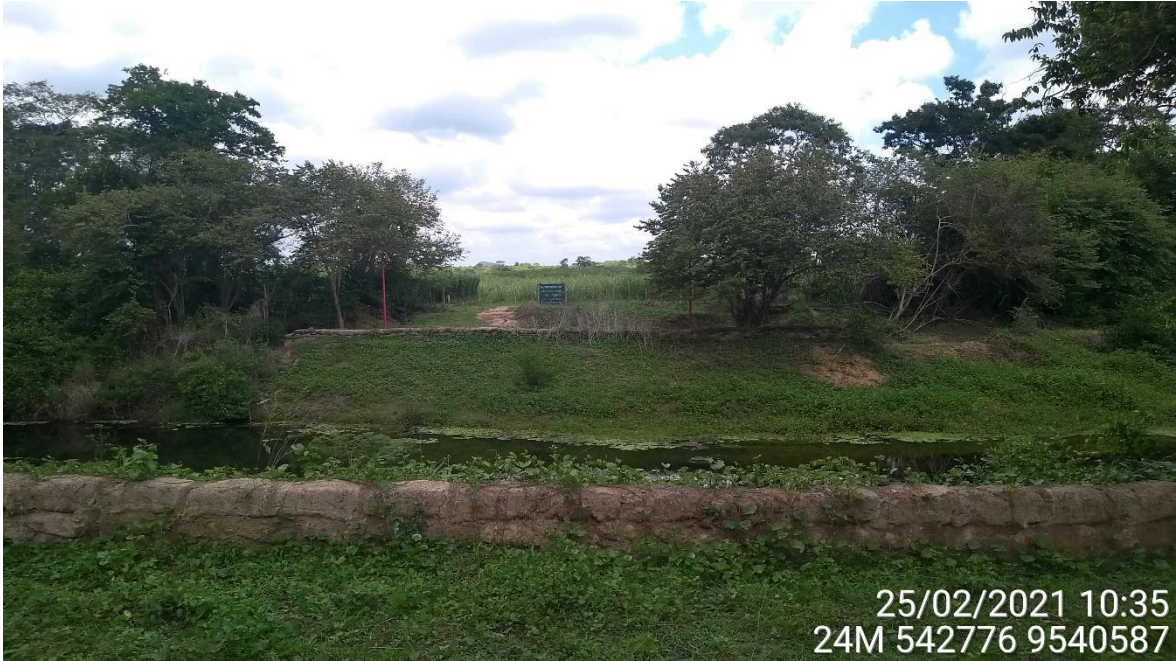
Figura 2.4-11 – Travessia do GASFOR II no rio Pacoti, km 18 do traçado
