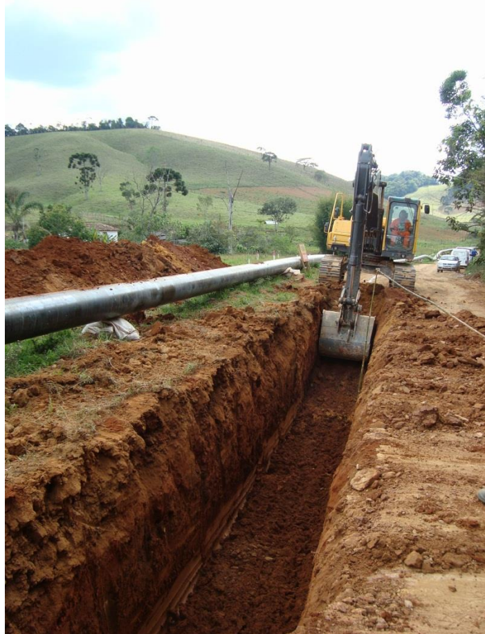
Figura 2.4-8 – Abertura de Valas do GASFOR II
