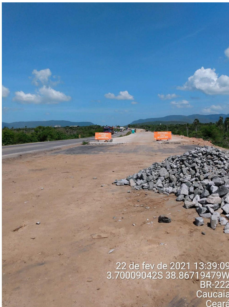
Figura 2.4-15 – BR-222 (em duplicação) sobre o trecho de cruzamento com o GASFOR II, km 82 do traçado
