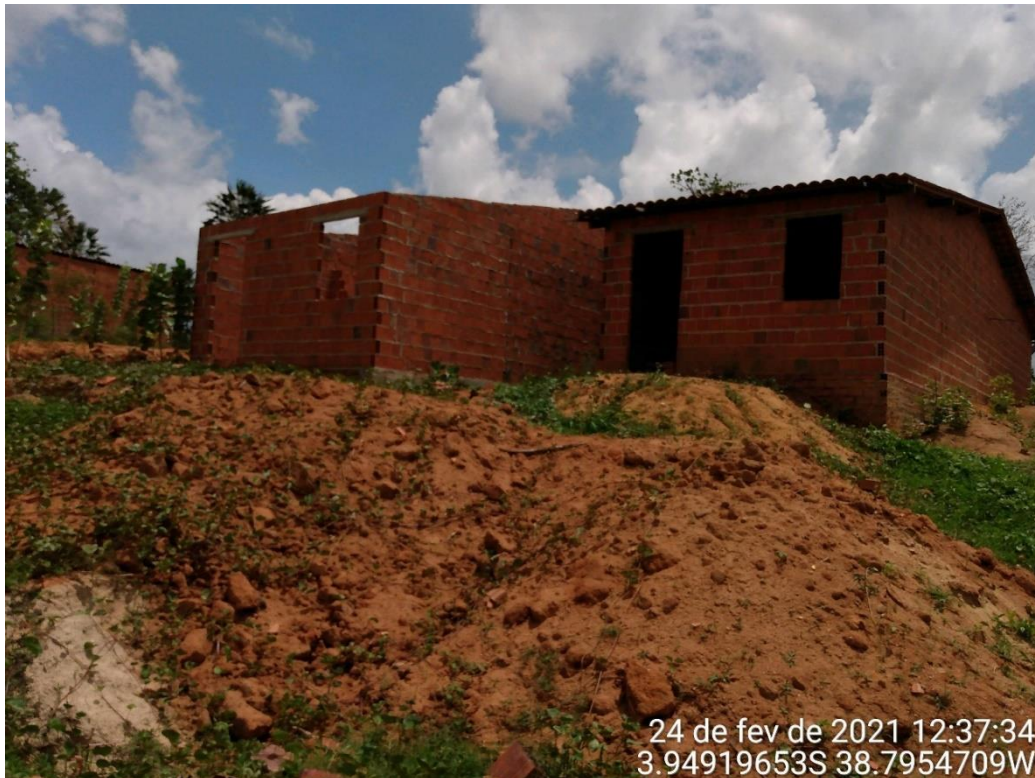
Figura 4.3-51 – Construção Civil - Trapiá
