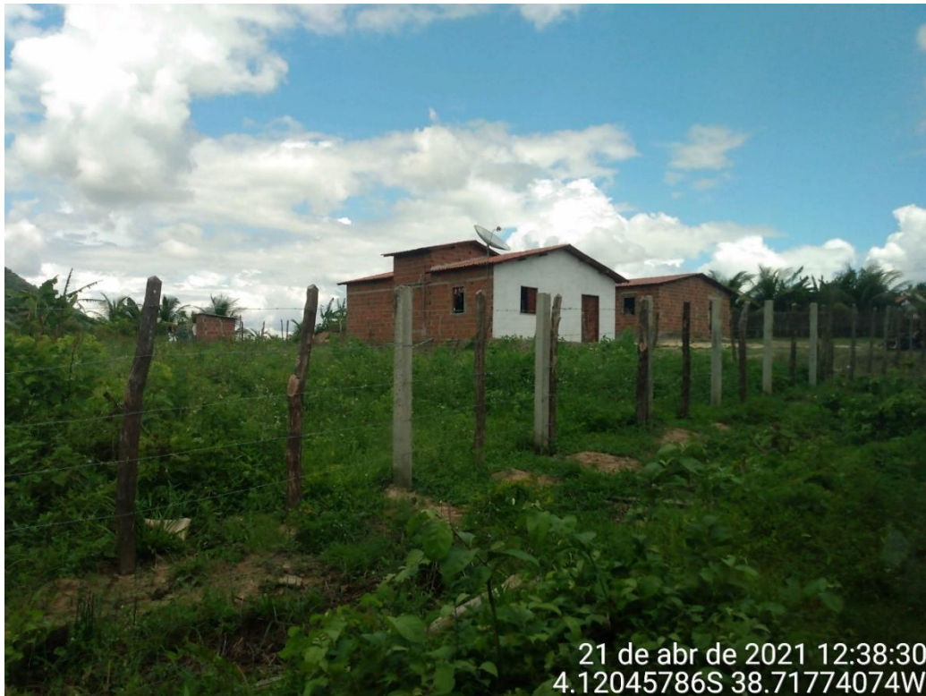
Figura 4.3-8 – Edificações Novas – Assentamento Rural Coaçu
