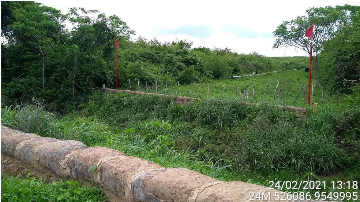
Figura 2.4-12 – Travessia do GASFOR II no rio Forquilha, km 38 do traçado
