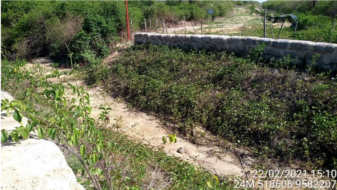
Figura 4.1-6 - Leito do Riacho do Sítio, transposto pela faixa de servidão do Gasoduto GASFOR II no km 72, no município de Caucaia-CE.
