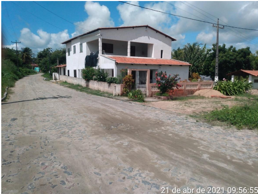
Figura 4.3-46 – Edificações em Cachoeira – Guaiuba
