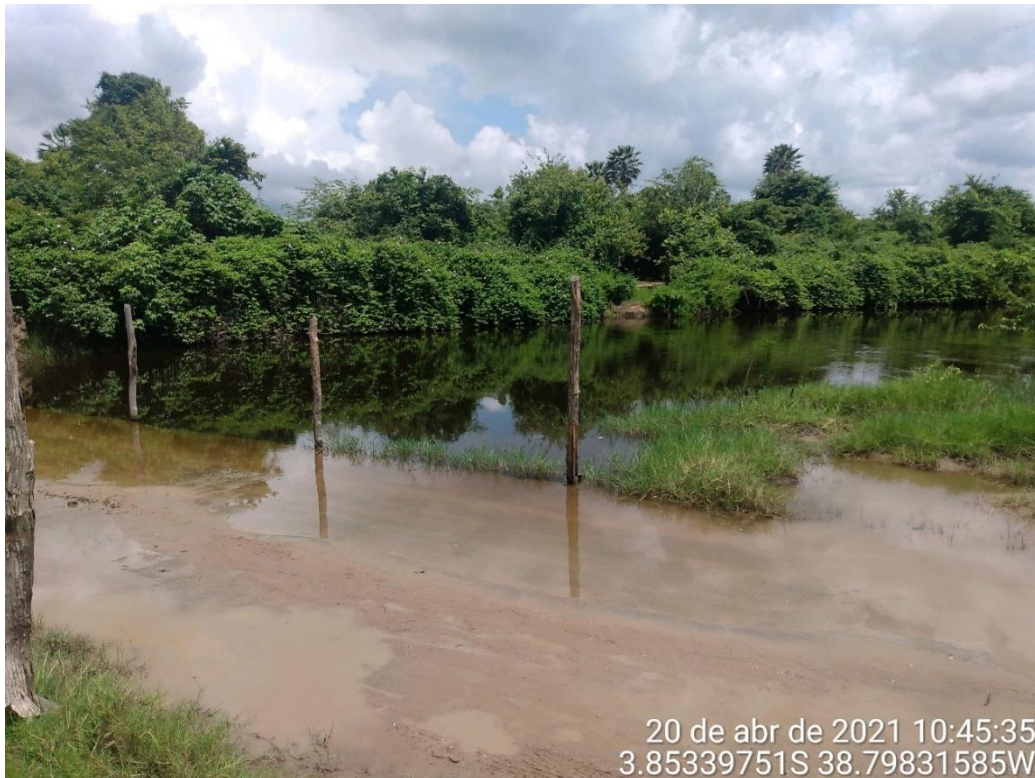
Figura 4.3-29 – Ponte no rio Ceará – Caminho para Muquém – acesso aos km 64, 65 e 66 do Gasoduto GASFOR II
