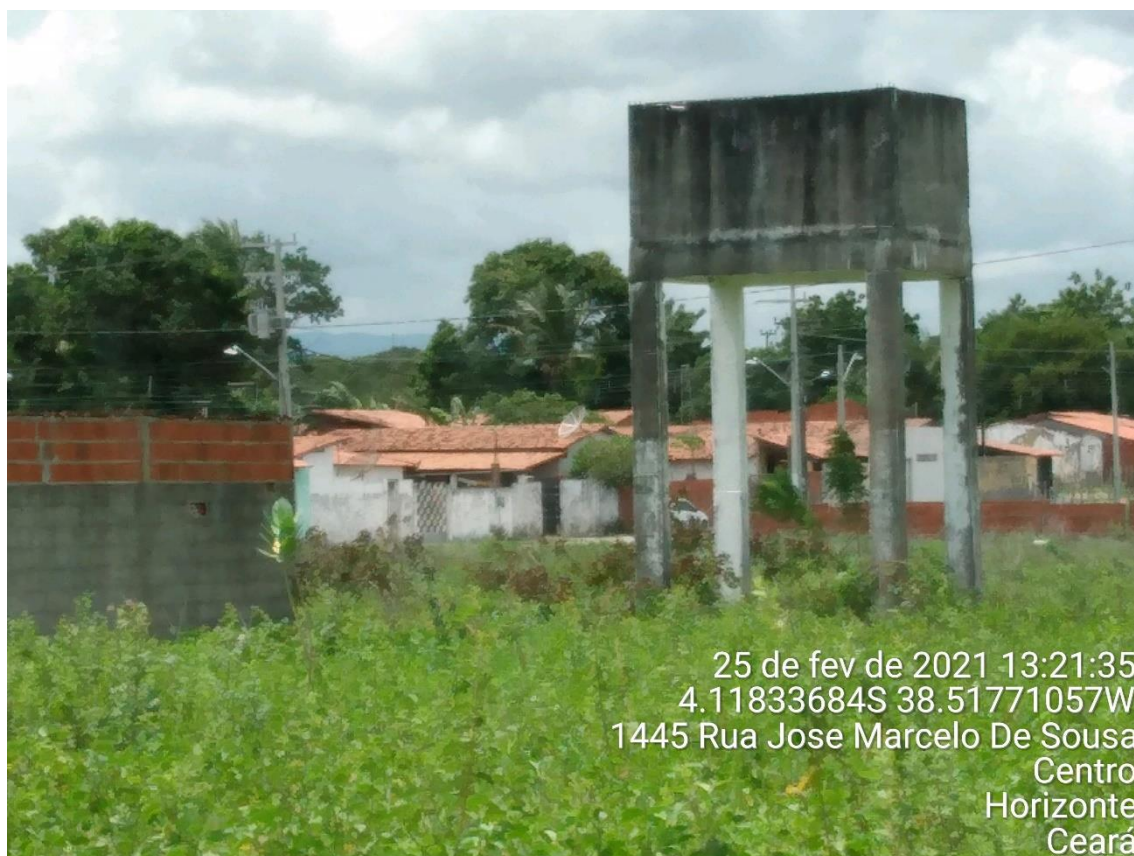
Figura 4.3-57 – Edificações em Cajueiro da Malhada – Horizonte – Área Urbana 1
