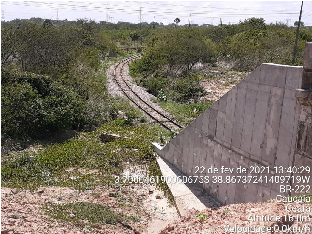
Figura 4.2-17 - Estruturas urbanas localizadas na ADA do GASFOR II.
