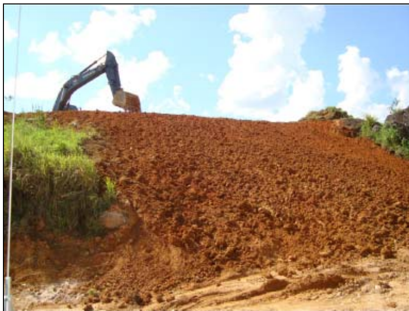
FOTO 6.3-9: Recomposição mecânica da faixa no km 122+800, coordenadas em UTM N= 7.564.464/E= 655.991 (Fonte: Remma - GDK, mar/10).
