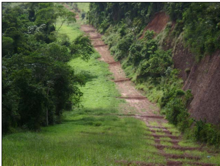
FOTO 6.3-81: Faixa de servidão com recomposição vegetal e leiras definitivas no km 106+200, coordenadas em UTM N= 7.552.770/E= 657.444 (Fonte: Lenc, mai/10).
