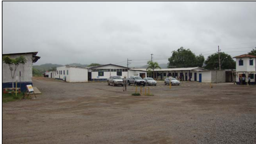
FOTO 6.1.1-99: Vista geral do canteiro, limpo e organizado, coordenadas em UTM N=7.512.069/E=601.305 (Fonte: Lenc, mar/10).
