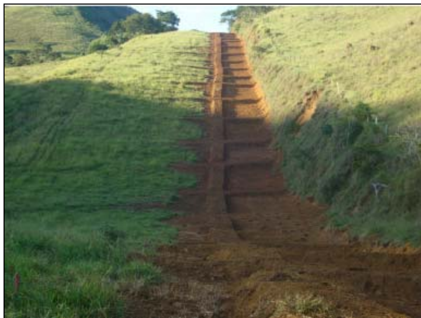
FOTO 6.3-20: Dispositivo de drenagem definitivo (leiras) no km 135+400, coordenadas em UTM N= 7.580.393 /E= 656.288 (Fonte: Remma - GDK, fev/10).
