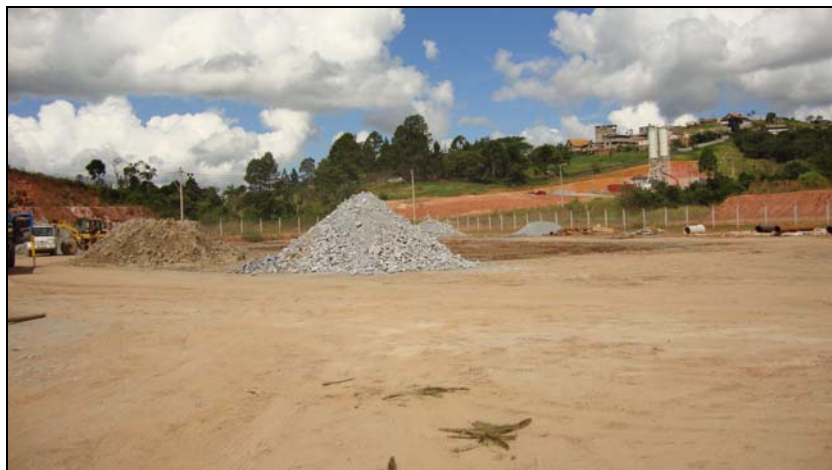
FOTO 6.1.1-32: Material depositado no canteiro destinado à recomposição da faixa de servidão do gasoduto, coordenadas em UTM N=7.652.927/E=630.639 (Fonte: Lenc, mar/10).
