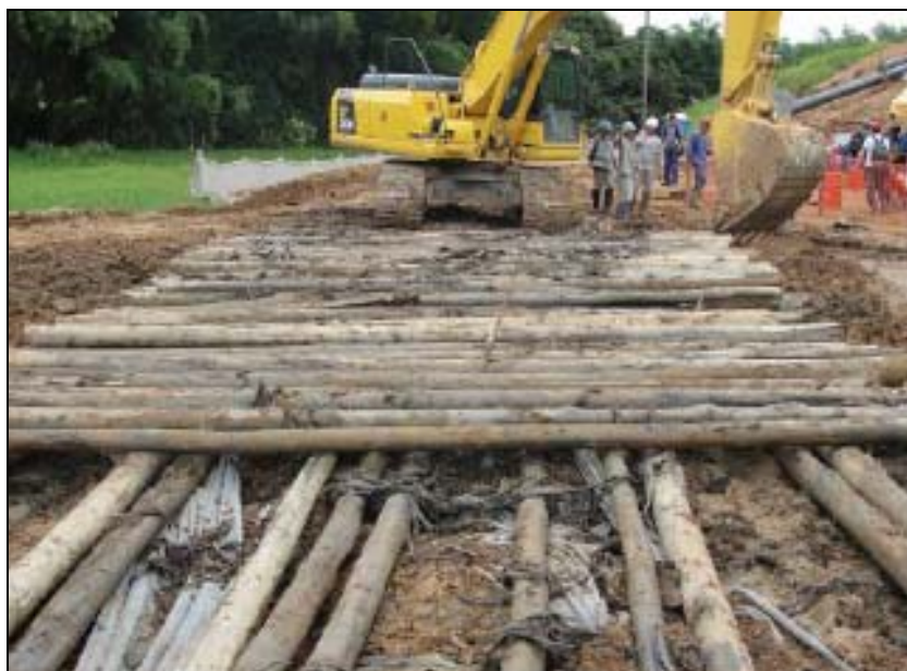
FOTO 6.2-93: Construção de estiva para passagem de máquinas e equipamentos, no km 28, coordenadas em UTM: N= 7.510.252 /E= 622.844 (Fonte: Remma – Azevedo Travassos, jan/10).
