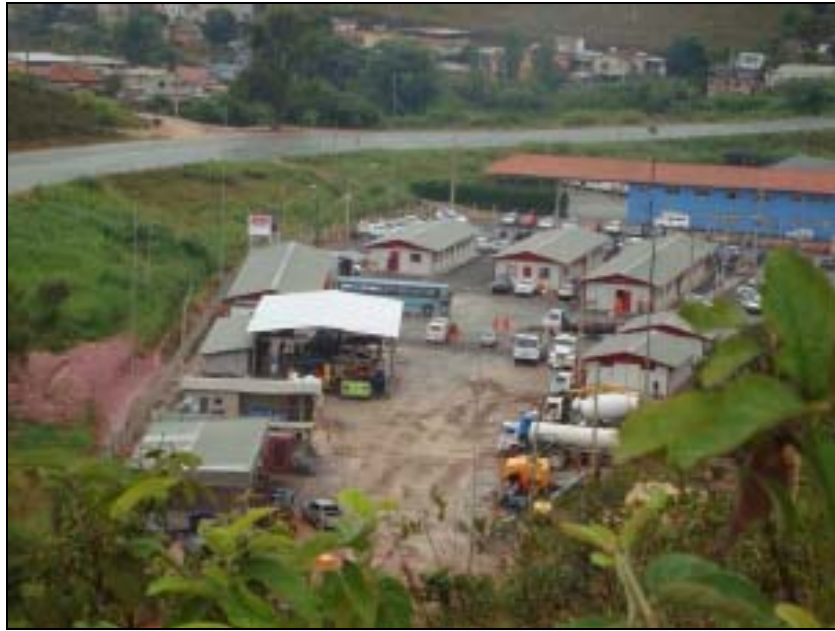
FOTO 6.1.1-3: Vista panorâmica do Canteiro Central de Carandaí, coordenadas em UTM N=7.683.285/E=624.859 (Fonte: Remma Egesa, fev/2010).
