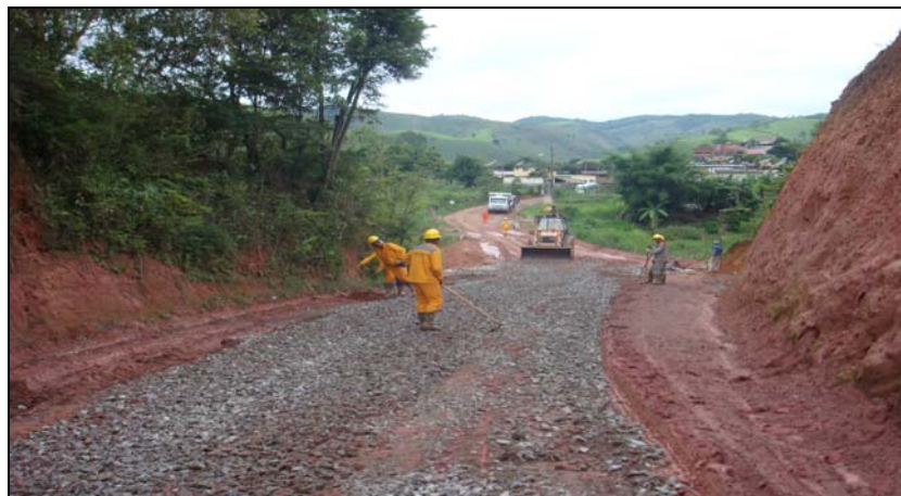
FOTO 6.3-87: Melhoria do acesso ao km 147 da faixa de servidão, coordenadas em UTM N= 7.591.330/E= 655.610 (Fonte: Remma – Construcap, dez/09).
