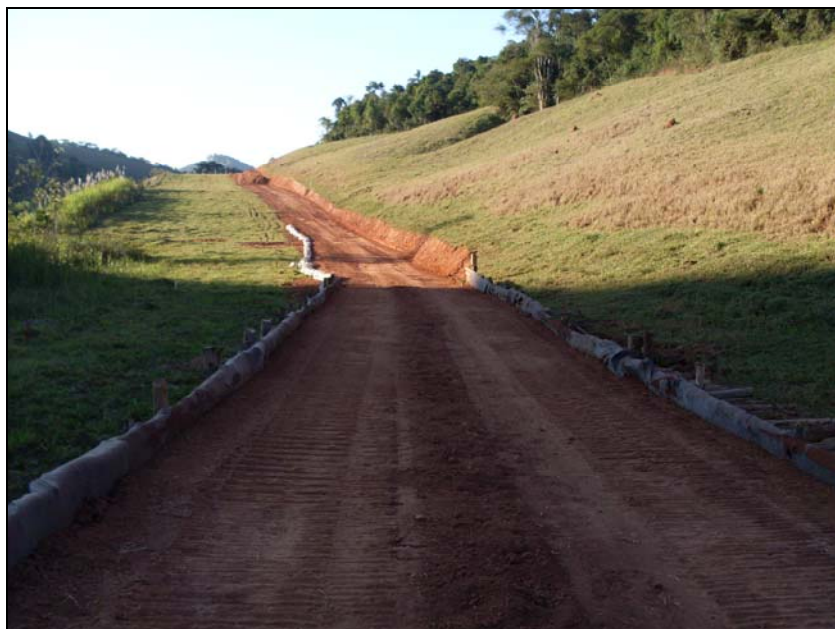
FOTO 6.2-20: Proteção na lateral da estiva para evitar o carreamento de sedimentos sólidos no km 149, coordenadas em UTM N= 7.593.463/E= 655.656 (Fonte: Remma Construcap, out/09).
