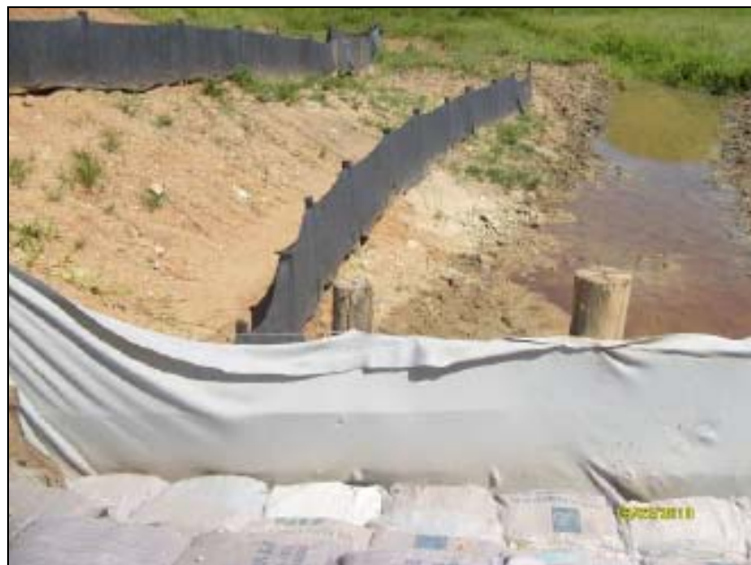
FOTO 6.2-72: Proteção de curso d'água contra carreamento de sedimentos sólidos com manta geotêxtil, km 7+3,00 coordenadas N= 7.506.352 / E= 605.038 (Fonte: Remma – Azevedo Travassos, fev/10).
