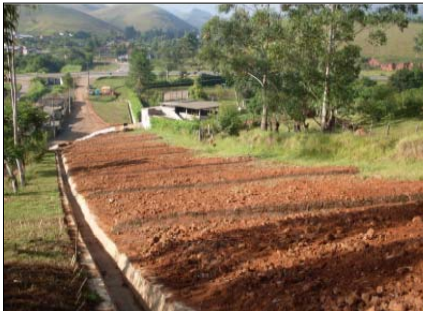
FOTO 6.3-24: Drenagem superficial e plantio de grama em placa estaqueada, para proteção da faixa de servidão no km 154, próximo à comunidade de Igrejinha, coordenadas em UTM N= 7.597.721/E= 655.937 (Fonte: Remma - Construcap, fev/10).
