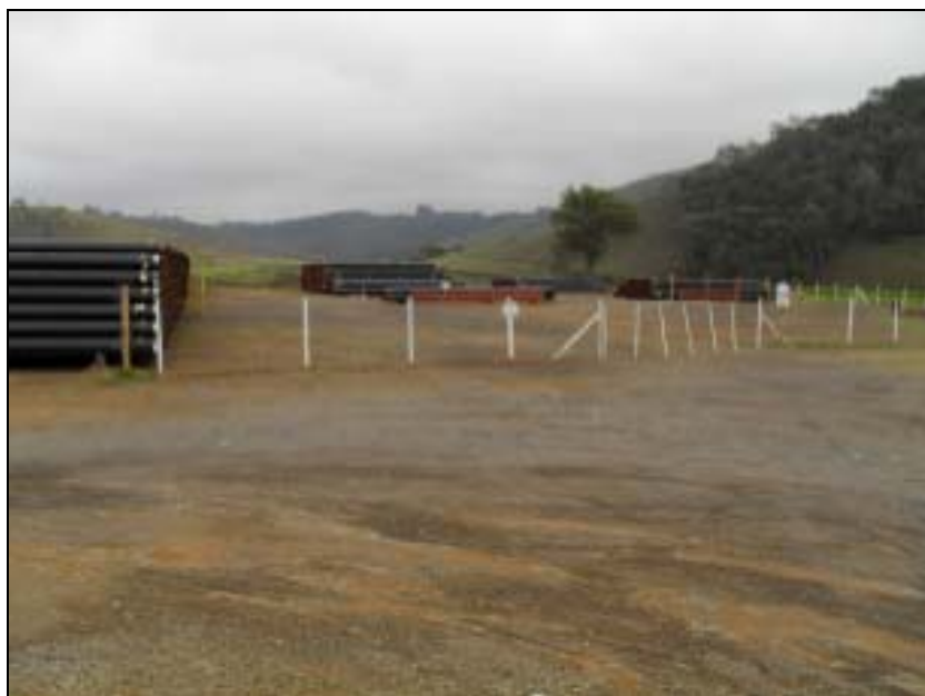
FOTO 6.1.1-34: Vista da entrada do canteiro de Santos Dumont/MG (Pulmão de Tubos), em dezembro de 2009, coordenadas em UTM N=7.628.775/E=649.474 (Fonte: Remma Construcap, fev/10).
