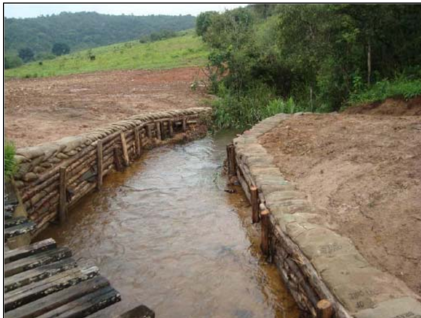
FOTO 6.2-64: Contenção às margens de curso d'água – APP, no km 252+728, coordenadas em UTM N= 7.680.488 /E= 622.727 (Fonte: Remma - Egesa, dez/09).
