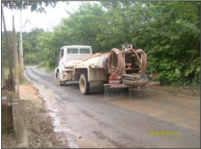
FOTO 6.1.1-131: Umectação do acesso ao km 124 (Comunidade Fortaleza), coordenadas em UTM N=7.569.6197/E=656.242 (Fonte: Remma GDK, mar/10).
