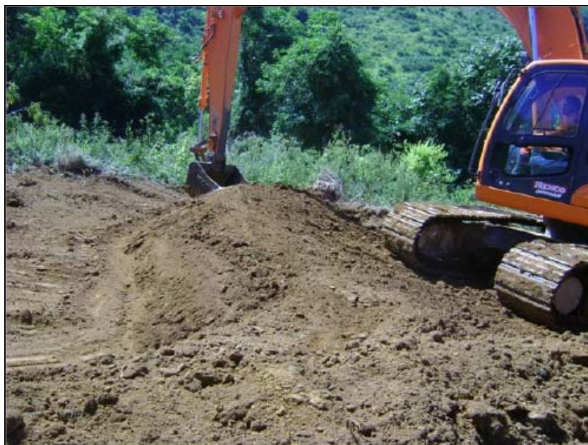
FOTO 6.2-119: Execução de leiras no km 137, coordenadas em UTM N= 7.581.962/ E= 656.018 (fonte: Remma - GDK, fev/10).
