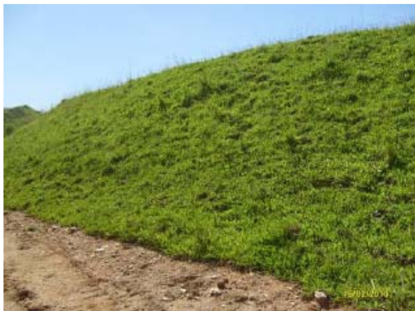
FOTO 6.3-65: Plantio de grama em placas no km 10, coordenadas em UTM N= 7.507.305/E= 607.389 (Fonte: Remma – Azevedo Travassos, fev/10).
