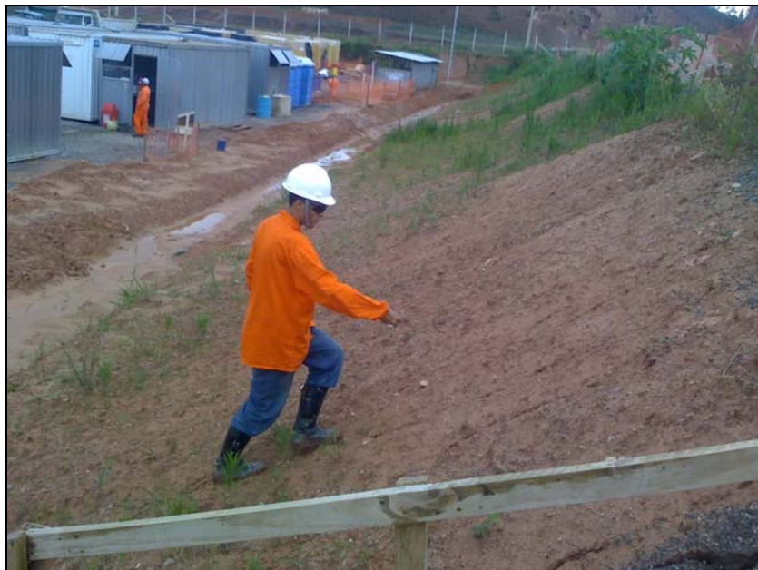
FOTO 6.3-43: Atividades de semeadura manual no talude de corte no canteiro de apoio de Barbacena-MG, coordenadas em UTM N= 7.652.927/E= 630.639 (Fonte: Remma Egesa, nov/09).
