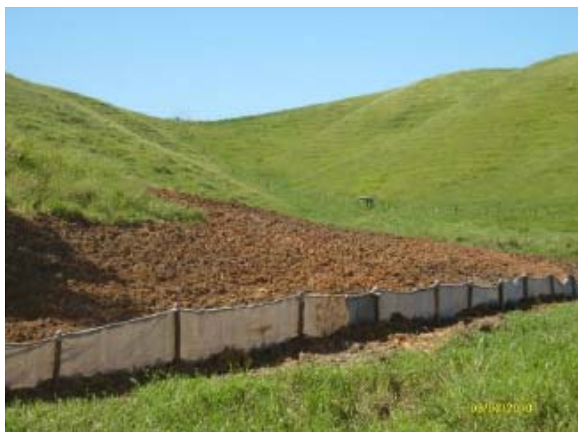
FOTO 6.3-66: Plantio de grama em placas no km 28+012, coordenadas em UTM N= 7.510.252/E= 622.844 (Fonte: Remma – Azevedo Travassos, fev/10).
