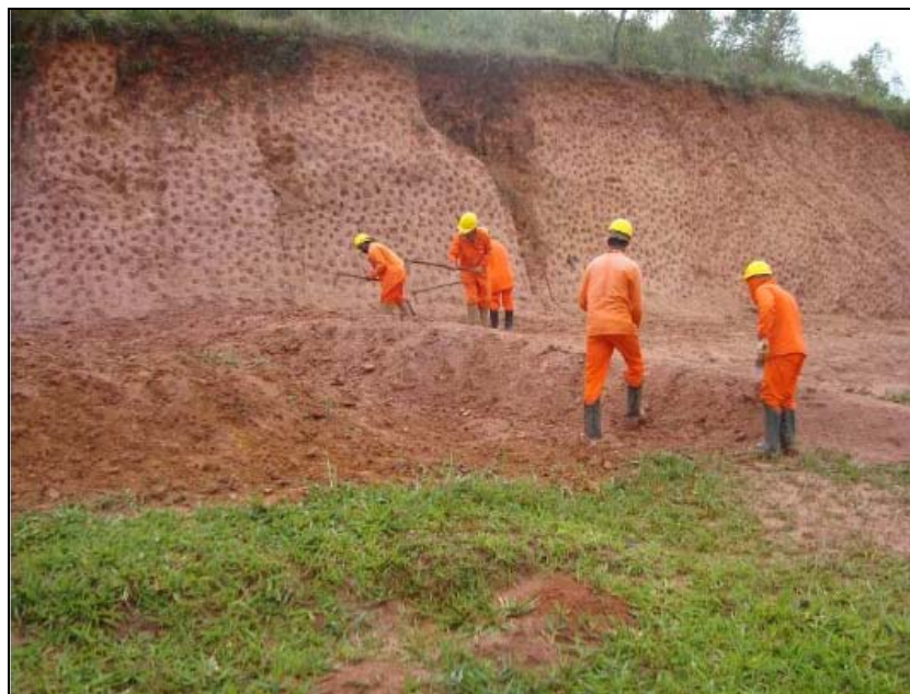
FOTO 6.3-57: Atividades de sementeira no km 254+105 da faixa de servidão, coordenadas em UTM N= 7.682.281/E= 622.051 (Fonte: Remma - Egesa, jan/10).
