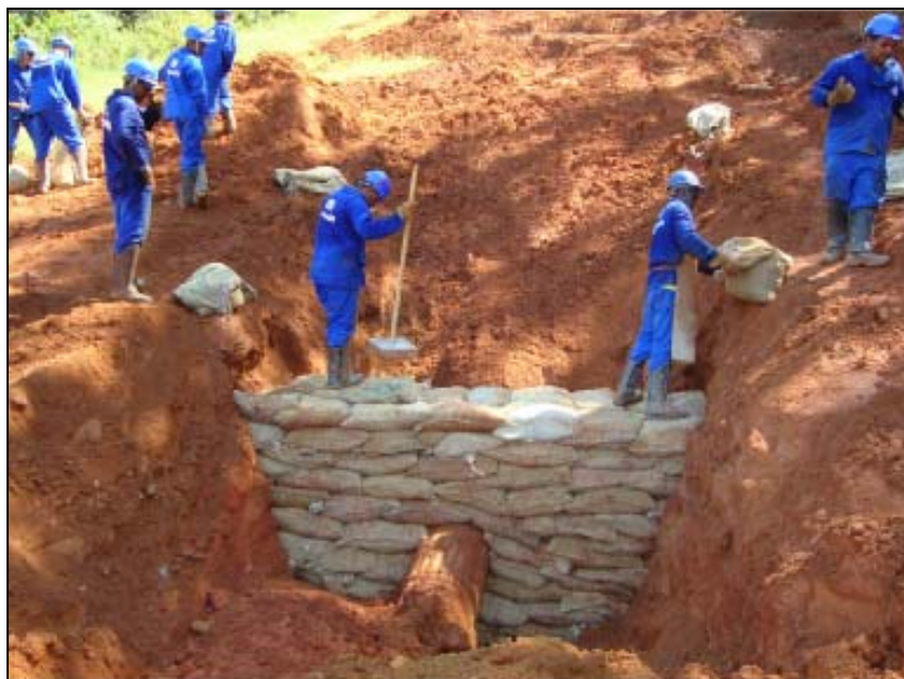
FOTO: 6.2-49: Construção de dique no km 123+841, coordenadas em UTM N= 7.569.458/E= 656.231 (fonte: Remma – GDK, mar/10).
