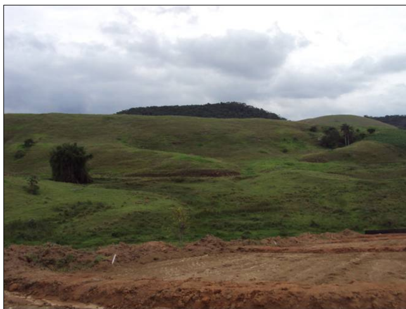
FOTO 6.1.2-19: Área designada para bota-fora (23), antes da utilização, coordenadas em UTM N=7.527.122/E=645.576 (Fonte: Remma Azevedo&Travassos, mar/10).
