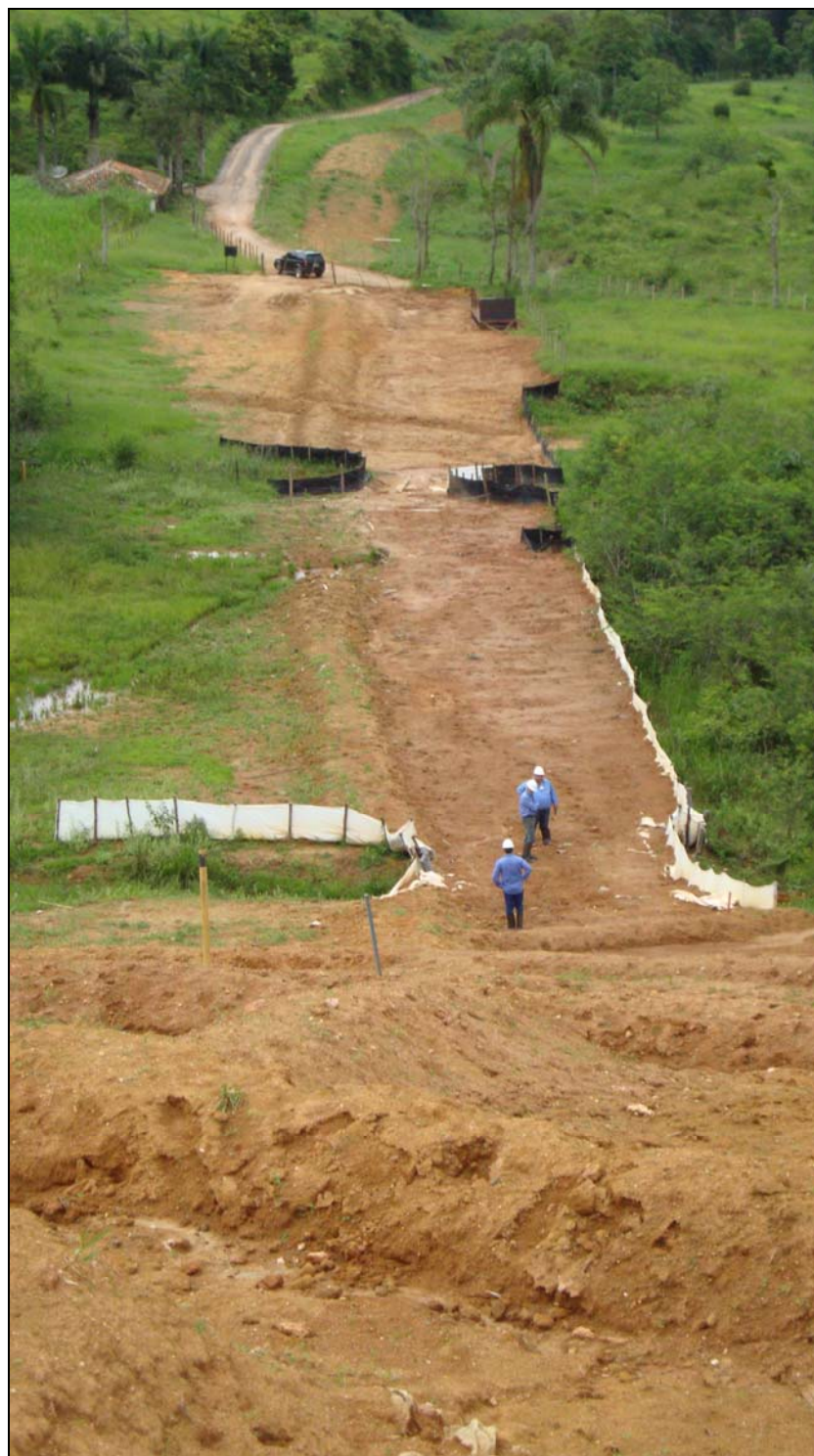
FOTO 6.2-32: Barreiras de contenção de sedimentos sólidos ao longo da faixa de servidão no km 141+600, coordenadas em UTM N= 7.586.385/ E= 655.529 (Foto: Lenc, jan/10).
