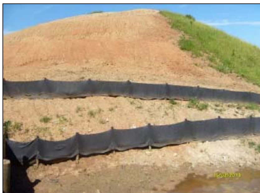
FOTO 6.2-73: Proteção de curso d'água contra carreamento de sedimentos sólidos com manta geotêxtil, km 07+3,00, coordenadas N= 7.506.352 / E= 605.038 (Fonte: Remma – Azevedo Travassos, fev/10).
