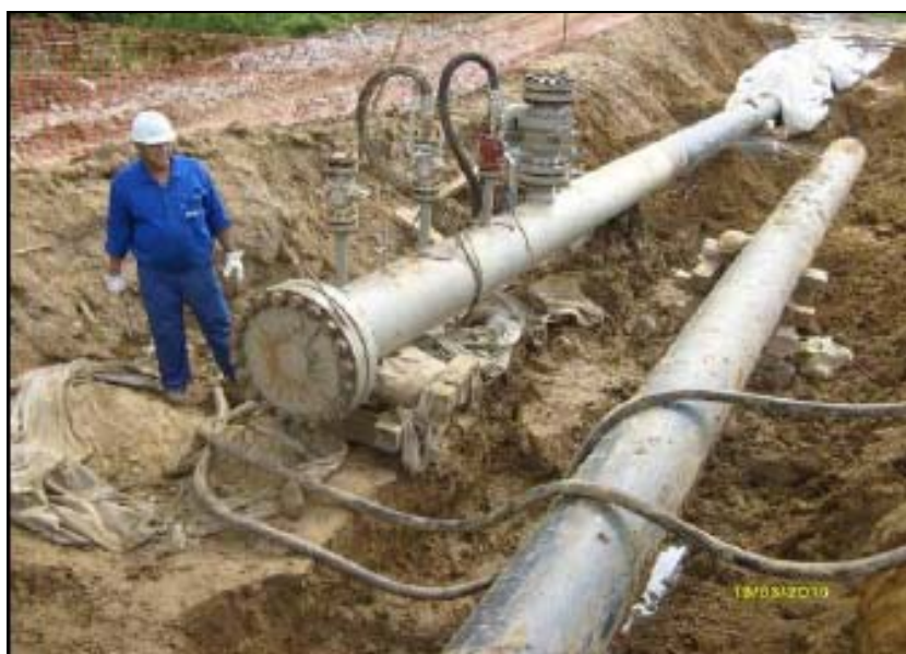
FOTO 6.1.2-57: Atividade de preenchimento com água da linha do duto no km 63+900, coordenadas em UTM N=7.529.813 / E= 649.074 (Fonte: Remma Azevedo & Travassos, mar/10).
