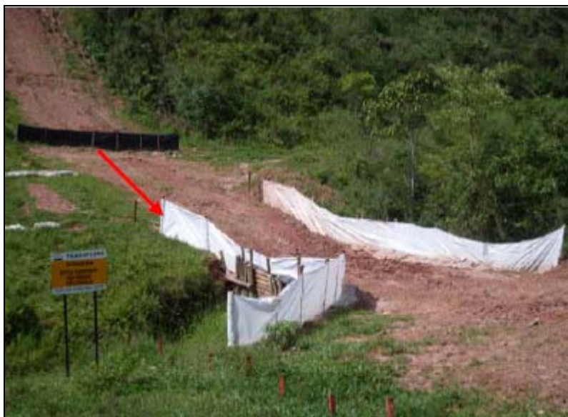
FOTO 6.2-69: Barreira de contenção com o objetivo de evitar o carreamento de sedimentos sólidos para o curso d'água – APP, no km 174, coordenadas em UTM N= 7.615.638/E= 651.389 (Fonte: Remma - Construcap, jan/10).
