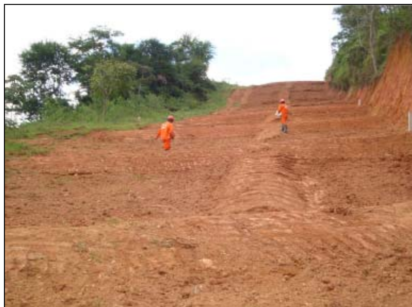
FOTO 6.3-73: Atividades de sementeira manual no km 123+100, coordenadas em UTM N= 7.568.730/E= 656.124 (Fonte: Remma – GDK, mar/10).
