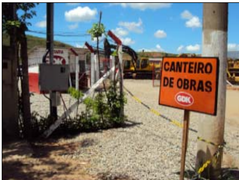
FOTO 6.1.1-39: Placa de sinalização na entrada do canteiro, coordenadas em UTM N=7.590.689/E=673.579 (Fonte: Remma GDK, fev/10).
