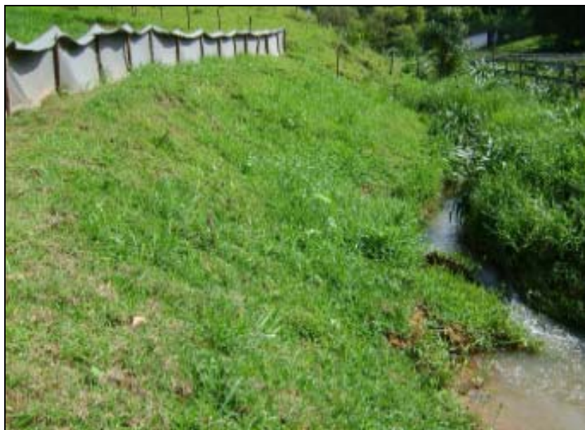
FOTO 6.3-46: Recomposição em APP no km 192, coordenadas em UTM N= 7.631.367/E= 648.379 (Fonte: Remma Construcap, nov/09).
