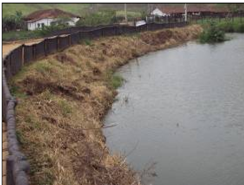
FOTO 6.2-55: Proteção de curso d'água no km 16, coordenadas em UTM N= 7.509.284/E= 612.646 (Fonte: Remma Azevedo Travassos, set/09).
