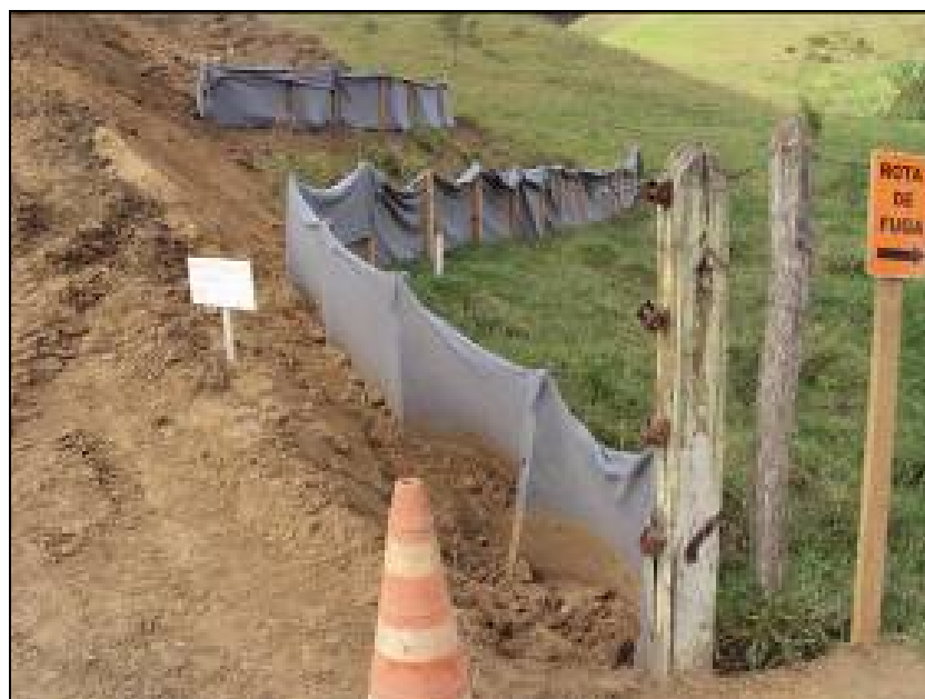
FOTO 6.2-14: Contenção de sedimentos sólidos em encosta com manta geotêxtil no km 10, coordenadas em UTM N= 7.507.305/E= 607.389 (Fonte: Remma Azevedo Travassos, jul/09).
