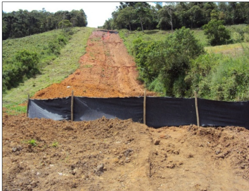
FOTO 6.2-25: Instalação de barreiras com manta geotêxtil visando conter o carreamento de sedimentos sólidos, no km 216, coordenadas em UTM N= 7.649.245 /E= 638.936 (Fonte: Remma – Egesa, dez/09)
