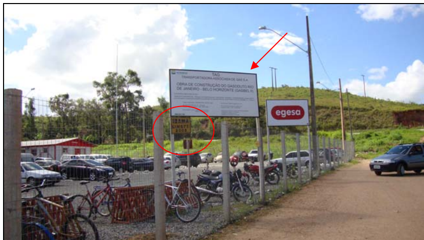
FOTO 6.1.1-4: Entrada do canteiro de Carandaí, placa da obra e placa contendo o órgão licenciador e nº da LI, coordenadas em UTM N=7.688.225/E=621.993 (Fonte: Lenc, mar/10).
