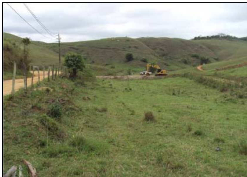
FOTO 6.3-124: Área designada para bota-fora e atualmente coberta com gramíneas, coordenadas em UTM N= 7.530.384/E= 649.592 (Fonte: Remma - Azevedo Travassos, mar/10).
