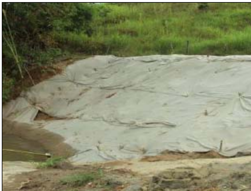
FOTO 6.2-78: Barreira de contenção (manta geotêxtil) às margens de curso d'água, no km 47, coordenadas em UTM N= 7.522.225/E= 635.782(fonte: Remma – Azevedo Travassos, mar/10).
