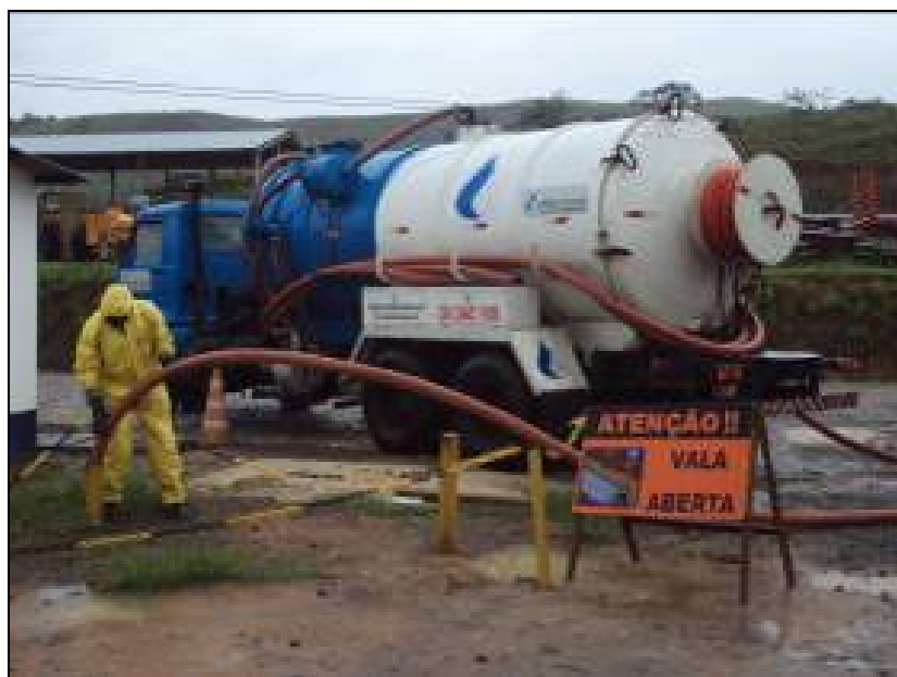
FOTO 6.4.4-1: Controle de efluente (limpeza de fossa) no canteiro de Pinheiral/RJ, coordenadas em UTM N= 7.512.069/E= 601.305( Fonte: Remma – Azevedo Travassos, out/09).
