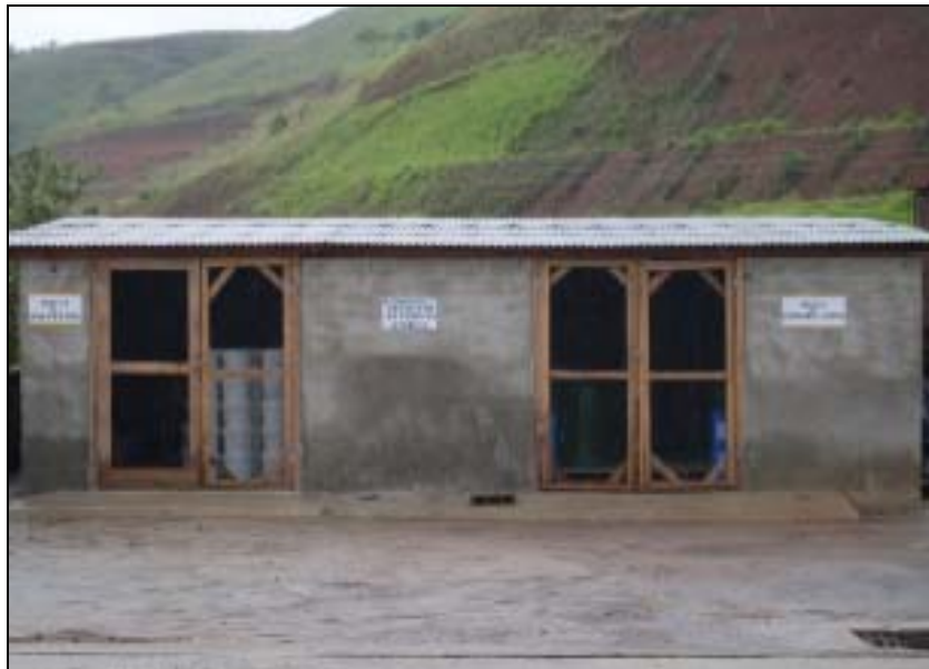
FOTO 6.1.1-54: Baías de acondicionamento de óleo lubrificante (direita) e de acondicionamento de produtos químicos (esquerda), coordenadas em UTM N=7.597.952/E=661.072 (Fonte: Remma Construcap, fev/10).
