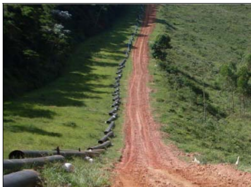
FOTO 6.1.2-34: Desfile de tubos no km 178, coordenadas em UTM N= 7.619.463/ E=651.577 (Fonte: Remma Construcap, fev/10).
