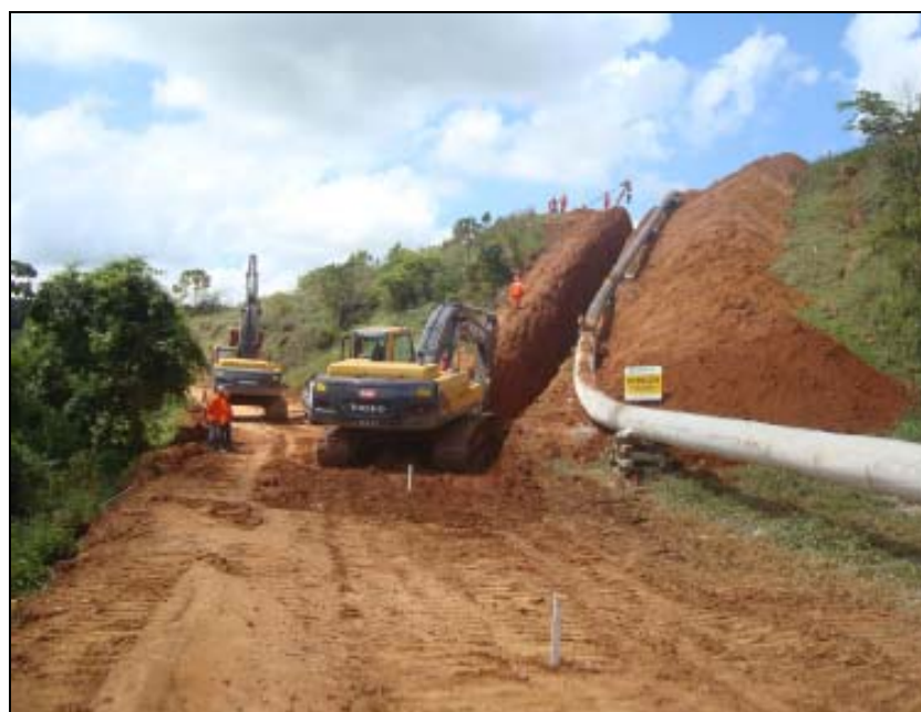
FOTO 6.1.2-48: Abertura de vala km 136+630, coordenadas em UTM N=7.581.613/E=656.158 (Fonte: Remma GDK, fev/10).
