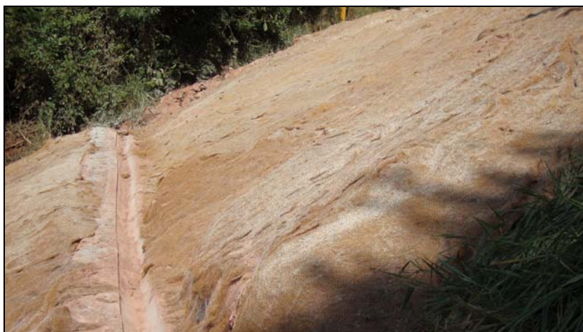
FOTO 6.3-82: Recomposição de faixa de servidão – canaleta transversal de direcionamento de água e aplicação de biomanta no km 107, coordenadas em UTM N= 7.553.924/E= 657.129 (Fonte: Lenc, mai/10).
