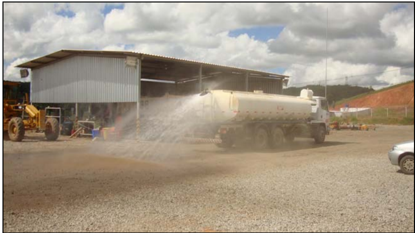
FOTO 6.1.1-132: Umectação do canteiro de Barbacena/MG, coordenadas em UTM N=7.652.927/E=630.639 (Fonte: Lenc, mar/10).
