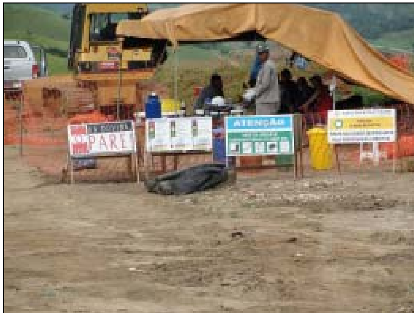
FOTO 6.1.1-123: Área de vivência no km 75; destaque para os informativos de SMS dispostos na área, coordenadas em UTM N= 7.535.840/E= 657.538 (Fonte: Remma Azevedo & Travassos, jan/10).
