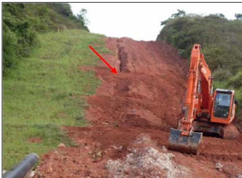
FOTO 6.2-114: Sistema de drenagem provisória (leiras transversais) no km 116+134, coordenadas em UTM: N= 7.562.098 /E= 655.366 (Fonte: Remma – Construcap, jan/10).
