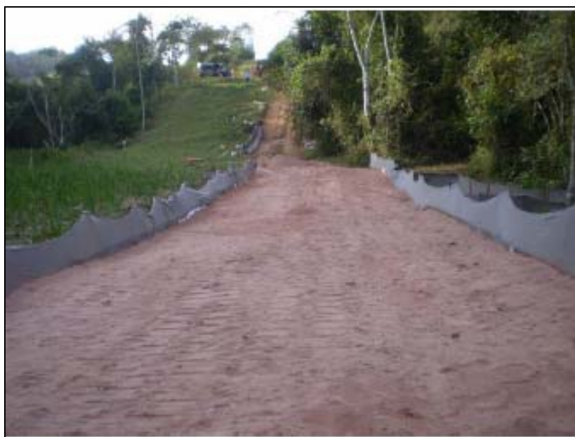
FOTO 6.2-85: Estiva para passagem de máquinas e equipamentos no km 103, coordenadas em UTM: N= 7.549.634/E= 657.784 (Fonte: Remma Construcap, nov/09).
