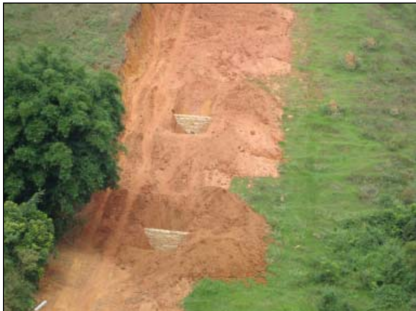
FOTO: 6.2-51: Diques construídos no km 124, coordenadas em UTM N= 7.569.619/E= 656.242 (fonte: Remma – GDK, mar/10).
