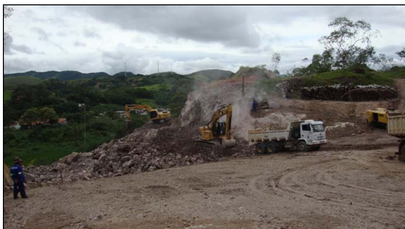
FOTO 6.1.3-39: Máquinas trabalhando no desmonte de rocha no km 26+800, próximo ao bota-fora 12B, coordenadas em UTM N=7.510.141/E=621.915 (Fonte: Lenc, mar/10).
