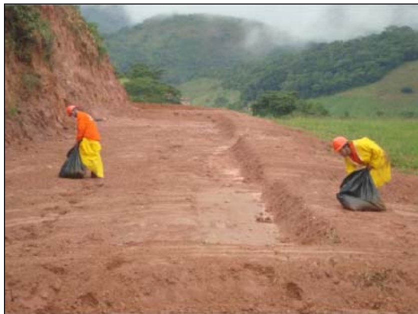
FOTO 6.3-70: Atividades de semeadura manual no km 135+900, coordenadas em UTM N= 7.580.879/E= 656.215 (Fonte: Remma – GDK, mar/10).
