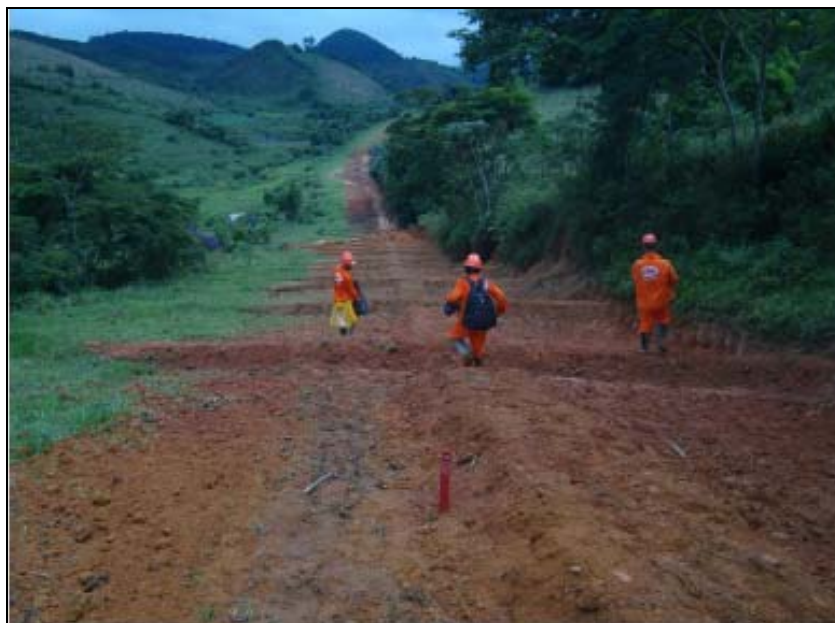
FOTO 6.3-72: Atividades de semeadura manual no km 138+600, coordenadas em UTM N= 7.583.536/E= 655.894 (Fonte: Remma – GDK, mar/10).
