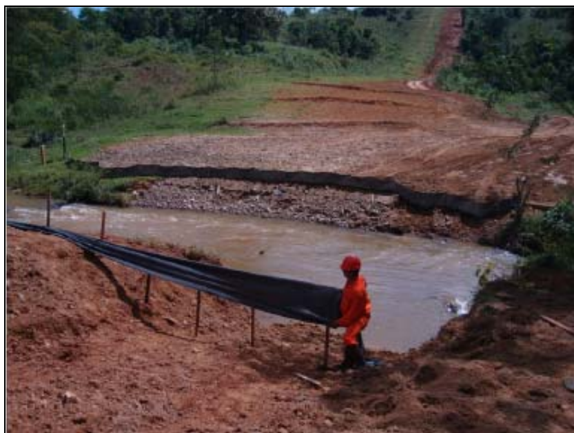
FOTO 6.2-79: Barreira de contenção (manta geotêxtil) às margens de curso d'água (Ribeirão da Conceição), no km 137+910, coordenadas em UTM N= 7.582.809/E= 655.913 (fonte: Remma – GDK, mar/10).
