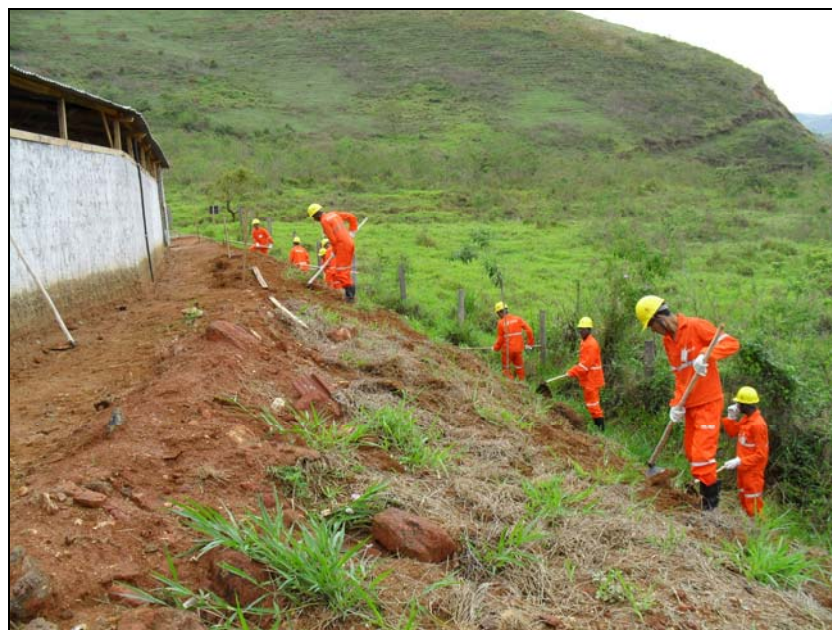
FOTO 6.2-1: Preparação do talude para execução de atividades de hidrossemeadura no canteiro operacional de Rio das Flores-RJ, coordenadas em UTM N= 7.556.630/E= 648.601 (Fonte: Remma, Construcap/2009).
