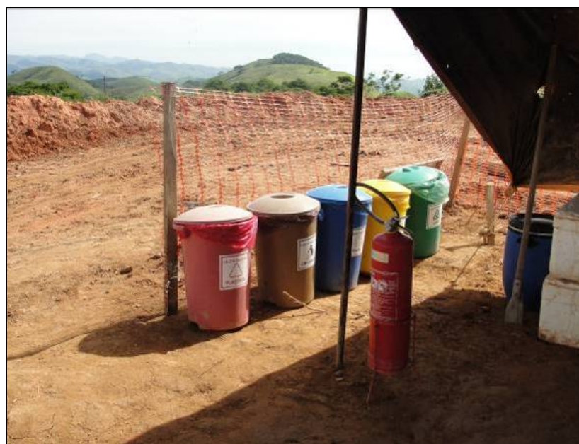
Foto 6.4.3-16: Kit de coleta seletiva na frente de obra no km 69, coordenadas em UTM N= 7.532.609/E= 652.987 (Fonte: Remma – Azevedo Travassos, dez/09).
