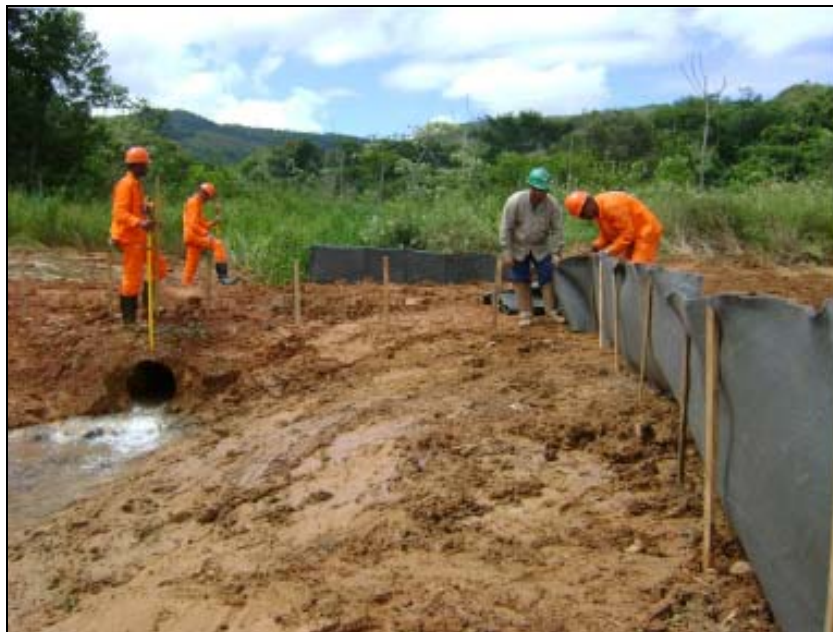
FOTO 6.2-80: Barreira de contenção (manta geotêxtil) às margens de curso d'água, no km 132+500, coordenadas em UTM N= 7.577.574/E= 656.220 (fonte: Remma – GDK, mar/10).
