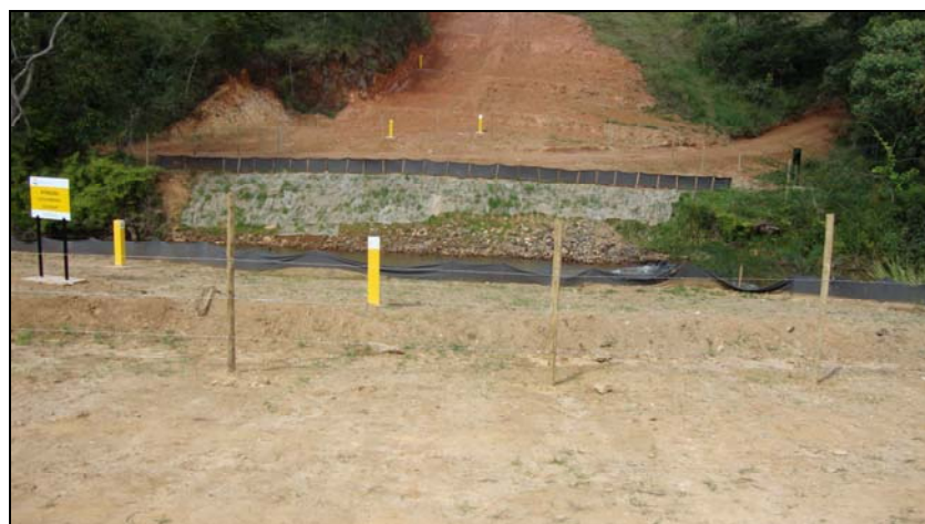
FOTO 6.3-74: Recuperação de APP – Córrego Ribeirão da Conceição I - km 137+ 985, coordenadas em UTM N= 7.582.893/E= 655.925 (Fonte: Lenc, mai/10).
