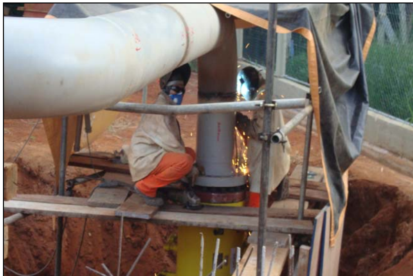
FOTO 7.1.7.2-1: Colaboradores utilizando adequadamente os EPIs na frente de obra, no km 282+790 do empreendimento, coordenadas em UTM: N=7.708.202/E=614.705 (Fonte: LENC, abr/10).
