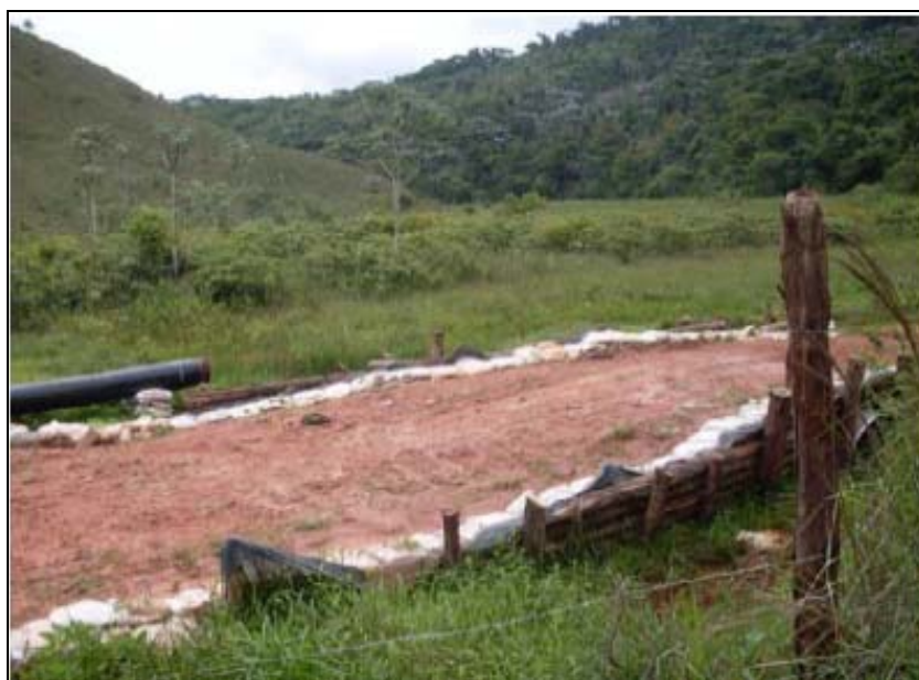
FOTO 6.2-91: Estiva para passagem de máquinas e equipamentos, no km 167, coordenadas em UTM: N= 7.609.700 /E= 654.650 (Fonte: Remma – Construcap, dez/09).
