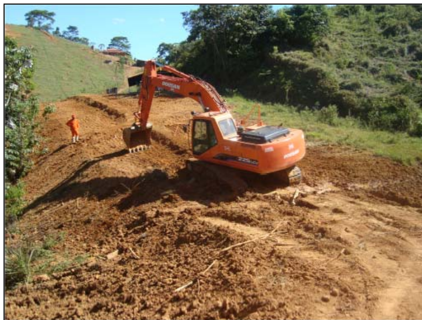
FOTO 6.2-120: Execução de leiras no km 136+200, coordenadas em UTM N= 7.568.645/ E= 656.082 (fonte: Remma - GDK, fev/10).
