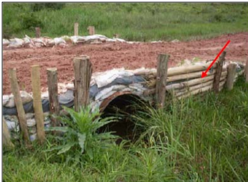
FOTO 6.2-63: Barreira de contenção com o objetivo de evitar o carreamento de sedimentos sólidos para o curso d'água, no km 163+760, coordenadas em UTM N= 7.606.858/E= 655.857 (Fonte: Remma - Construcap, dez/09).
