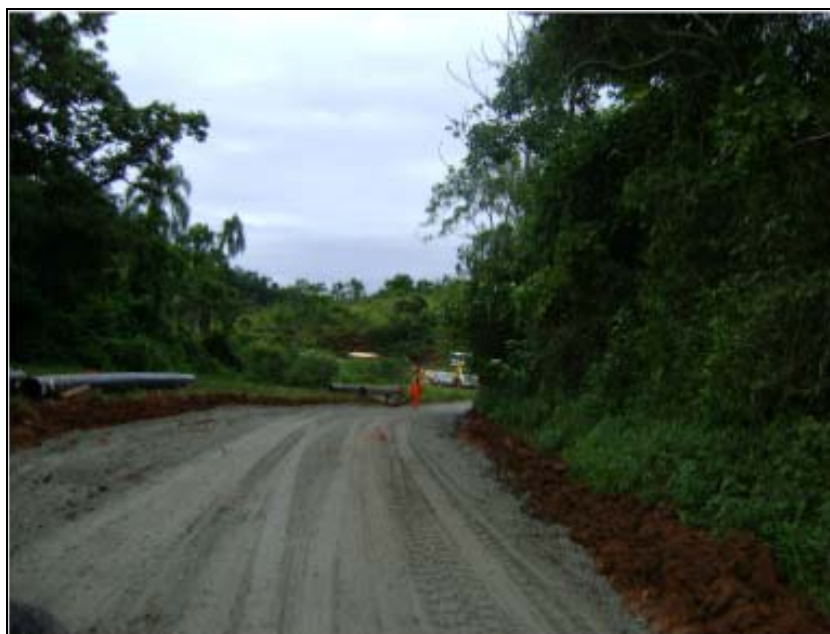
FOTO 6.3-108: Melhoria do acesso ao km 131 da faixa de servidão, coordenadas em UTM N= 7.576.276/E= 655.909 (Fonte: Remma – GDK, fev/10).
