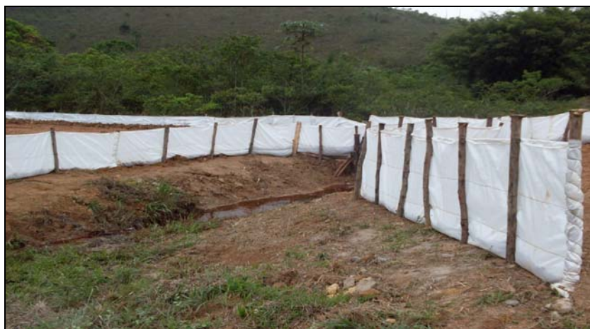
FOTO 6.2-59: Barreira de contenção com o objetivo de evitar o carregamento de sedimentos sólidos para o curso d'água, no km 141+740, coordenadas em UTM N= 7.586.437/E= 655.518 (Fonte: Remma Construcap, nov/09).
