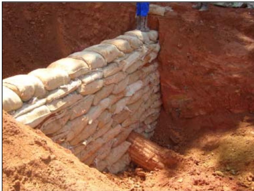
FOTO: 6.2-50: Construção de dique no km 123+938, coordenadas em UTM N= 7.569.551/E= 656.237 (fonte: Remma – GDK, mar/10).
