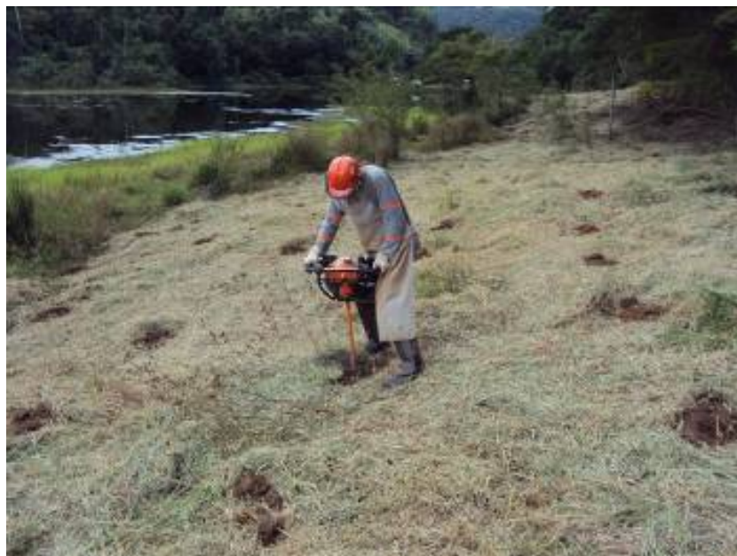
FOTO 7.4-10: Abertura de covas, coordenadas UTM N=7636956 / E=647752 (Fonte: Lenc, abr/10).
