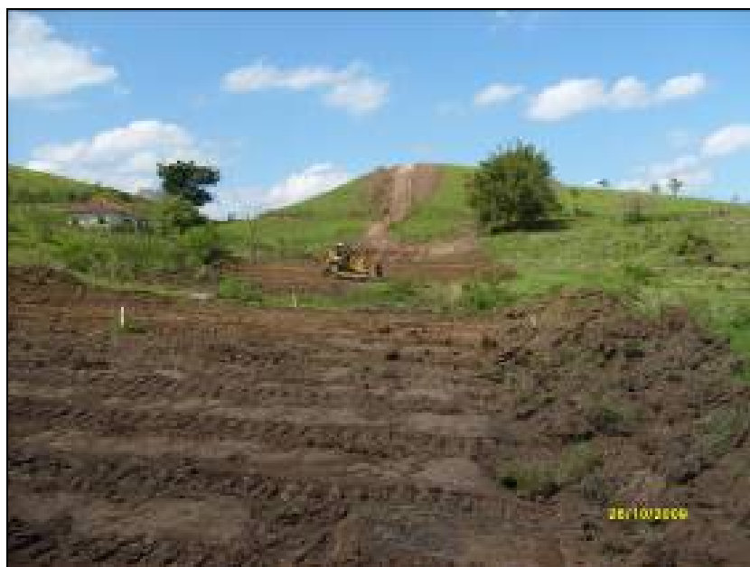
FOTO 6.2-97: Abertura de pista no km 73+840, coordenadas em UTM: N= 7.535.046/E= 656.706 (Fonte: Remma Azevedo Travassos, out/09).
