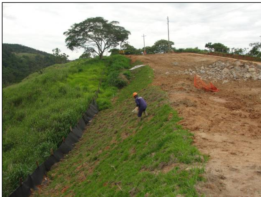
FOTO 6.2-4: Revegetação da saia do aterro, no km 66, coordenadas em UTM N= 7.530.925 /E= 650.665 (Fonte: Remma - Azevedo Travassos, dez/09).
