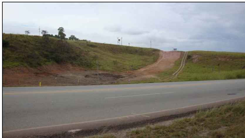
FOTO 6.1.3-42: Cruzamento com a rodovia BR040 (método não-destrutivo), faixa de servidão do duto km 233, coordenadas em UTM N=7.662.950 /E=628.419 (Fonte: Lenc, maio/10).
