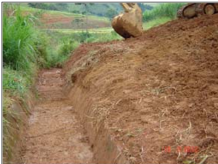
FOTO 6.2-123: Limpeza de canaletas de concreto, no km 186, coordenadas em UTM N= 7.626.348/E= 647.443 (fonte: Remma - Egesa, fev/10).
