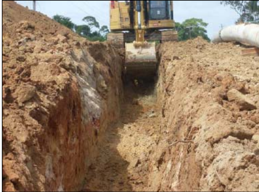
FOTO 5.2-1: Monitoramento da atividade de abertura de vala no km 68 (Fonte: MAEA/UFJF, jan/10).
