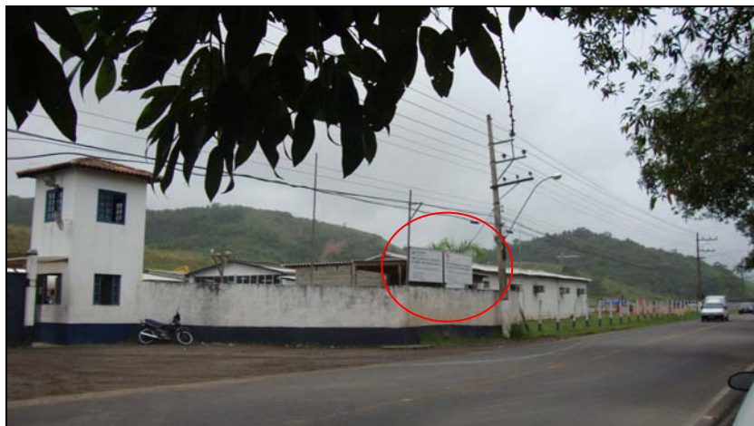
FOTO 6.1.1-96: Entrada do canteiro de Pinheiral; destaque (círculo) para as placas de obra, coordenadas em UTM N=7.512.069/E=601.305 (Fonte: Lenc, mar/10).
