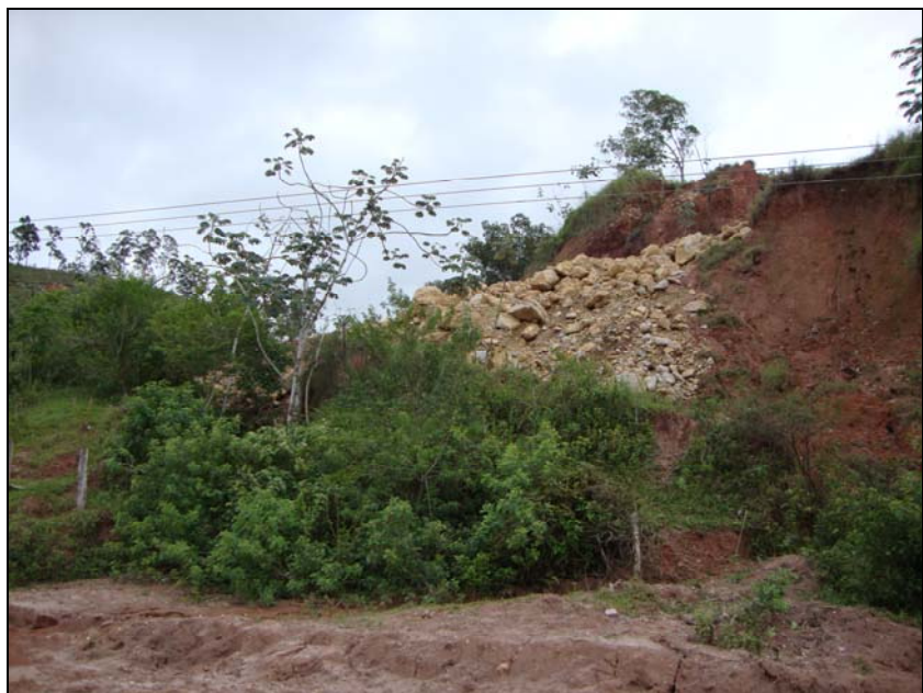
FOTO 6.1.2-15: Área designada para bota-fora (12E), em utilização, coordenadas em UTM N= N=7.510.316 /E=621.401 (Fonte: Lenc, mar/10).
