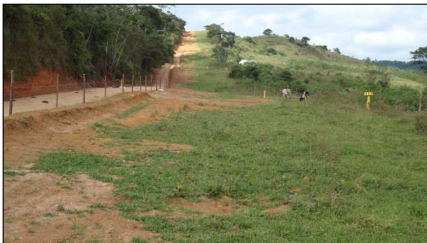
FOTO 6.3-78: Faixa de servidão cercada e com recomposição vegetal no km 140, coordenadas em UTM N= 7.585.431/E= 655.674 (Fonte: Lenc, mai/10).
