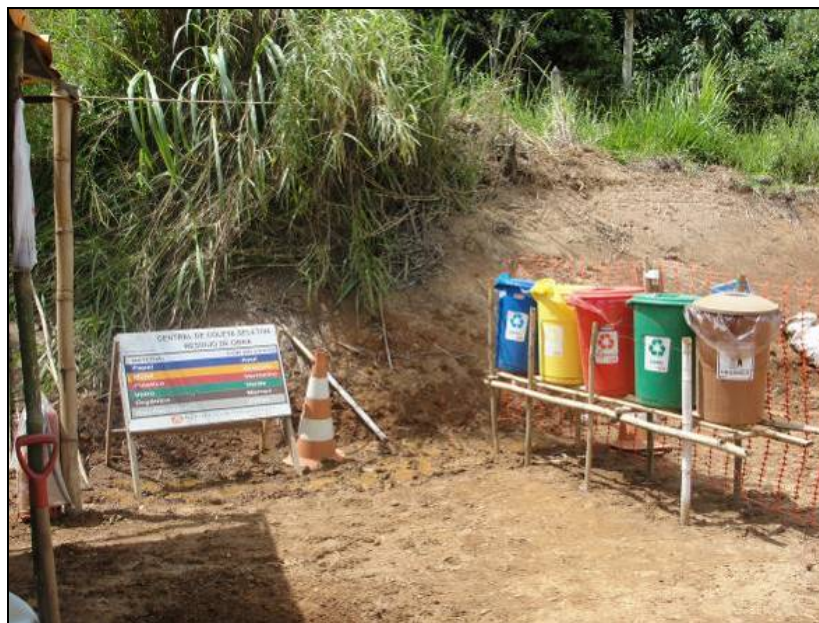
Foto 6.4.3-15: Kit de coleta seletiva na frente de obra no km 65+100, coordenadas em UTM N= 7.530.549/E= 650.417 (Fonte: Remma – Azevedo Travassos, dez/09).
