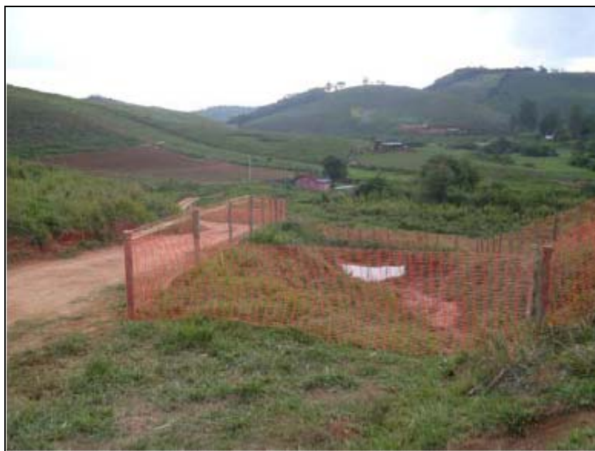
FOTO 6.3-121: Delimitação da área de bota-fora em Santos Dumont – MG no km 191+060, coordenadas em UTM N= 7.629.590/E= 648.524 (Fonte: Remma - Construcap, jan/10).
