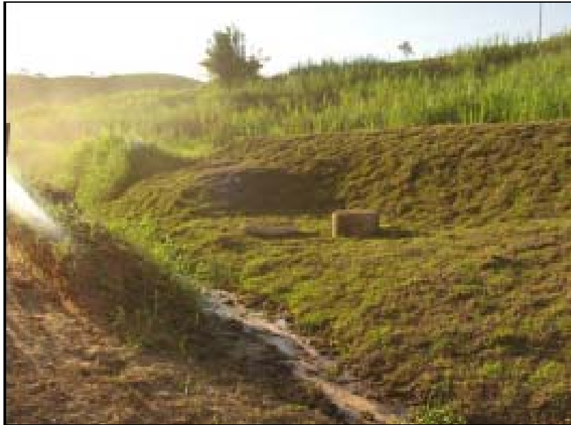
FOTO 6.1.1-133: Revegetação de talude do acesso aos Km's 65 e 66, coordenadas em UTM N= 7.599.120/E=656.286 (Fonte: Remma Azevedo & Travassos, mar/10).
