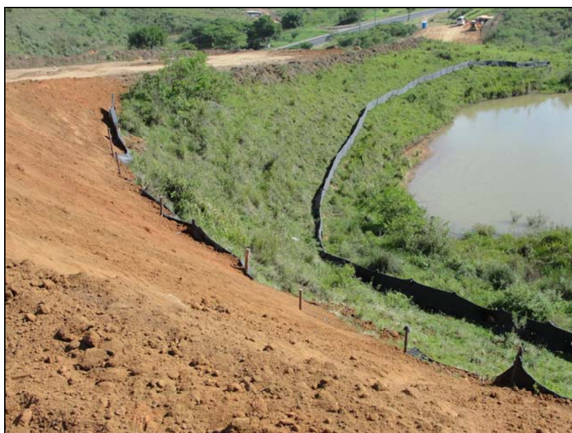
FOTO 6.2-57: Estrutura de proteção de curso d'água no km 64, coordenadas em UTM N= 7.530.376/E= 649.561 (Fonte: Remma Azevedo Travassos, nov/09).
