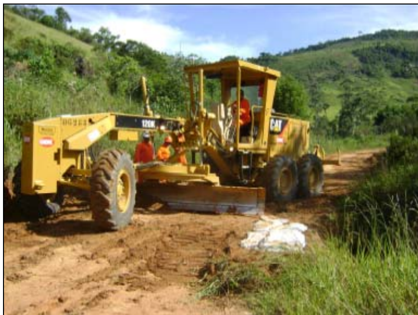
FOTO 6.3-106: Melhoria do acesso ao km 128 da faixa de servidão, coordenadas em UTM N= 7.569.619/E= 656.242 (Fonte: Remma – GDK, fev/10).
