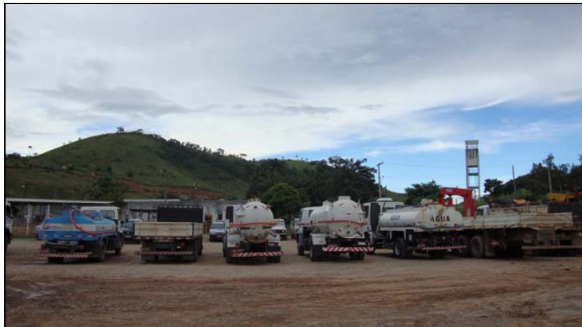
FOTO 6.1.1-51: Pátio do canteiro limpo e organizado, coordenadas em UTM N=7.597.952/E=661.072 (Fonte: Lenc, abr/10).
