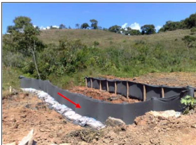
FOTO 6.2-77: Contenção para evitar carreamento de sedimentos sólidos para o corpo d'água, no km 182, coordenadas em UTM N= 7.622.886/E= 649.940 (fonte: Remma - Construcap, mar/10).
