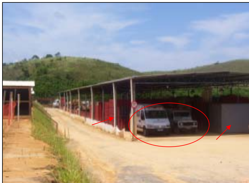
FOTO 6.1.1-64: Vista do canteiro a partir da entrada. Disposição dos containers e ambulâncias, coordenadas em UTM N=7.556.706/E=648.650 (Fonte: Remma Construcap, mar/10).
