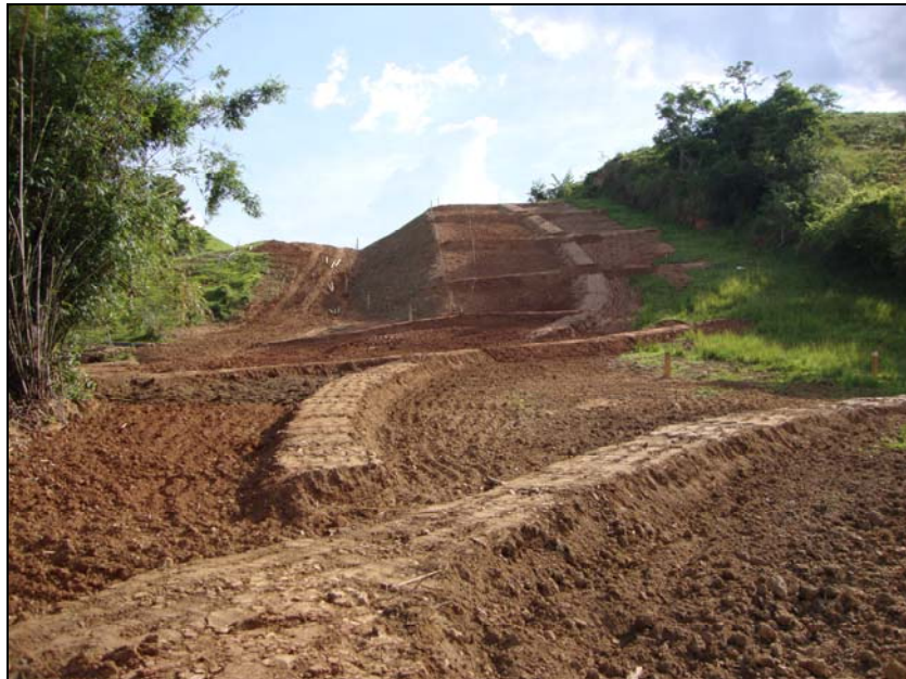
FOTO 6.3-23: Dispositivo definitivo de drenagem (leiras) no km 81, coordenadas em UTM N= 7.542.332/E= 658.345 (Fonte: Lenc, jan/10).
