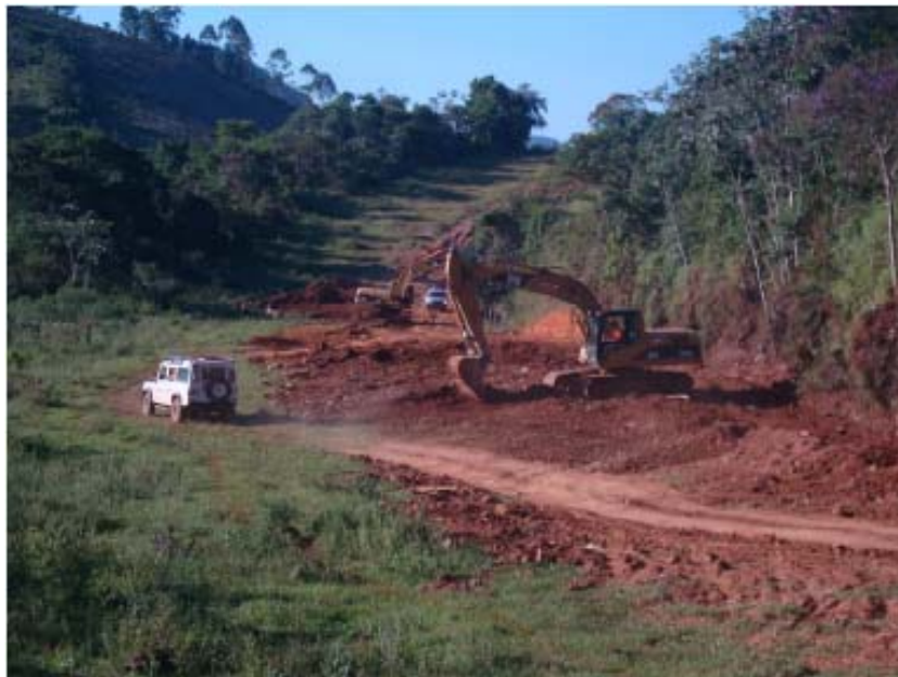
FOTO 6.3-8: Reposição do solo superficial no km 138, coordenadas em UTM N= 7.582.937/E= 655.916 (Fonte: Remma - GDK, fev/10).
