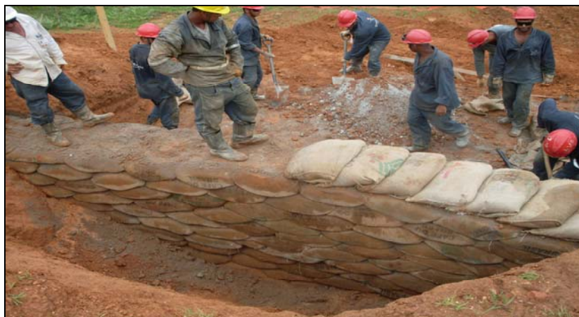
FOTO 6.2-21: Atividades de execução de diques de proteção no km 140, coordenadas em UTM N= 7.584.841/E= 655.841 (Fonte: Remma Construcap, nov/09).
