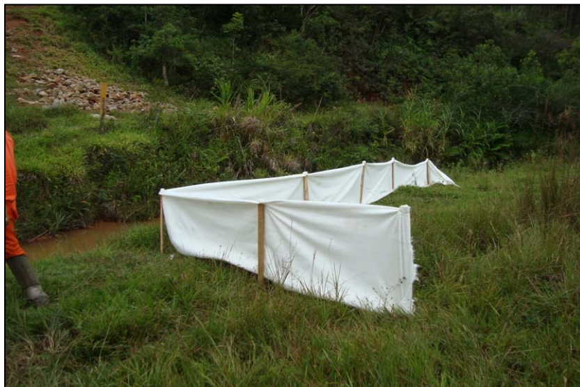
FOTO 6.2-76: Proteção do corpo d'água (APP) com manta geotêxtil contra carreamento de sedimentos sólidos, no km 240, coordenadas em UTM N= 7.668.811/E= 626.254 (fonte: Remma - Egesa, fev/10).
