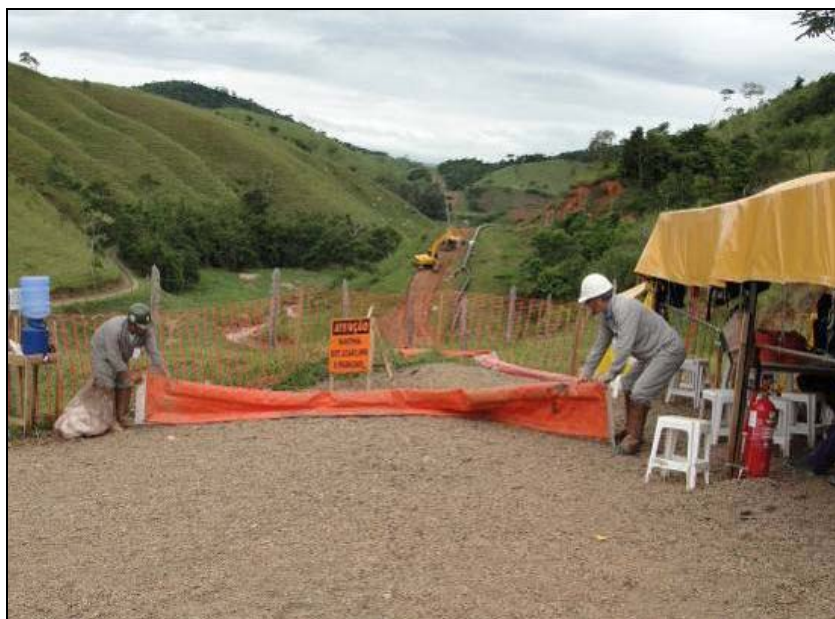
FOTO 7.2.4-1: Treinamento para uso de barreira de contenção de óleo em travessia de cursos d'água no km 83 do empreendimento, coordenadas em UTM: N=7.543.079/E=658.751 (Fonte: REMMA Azevedo & Travassos, mar/10).
