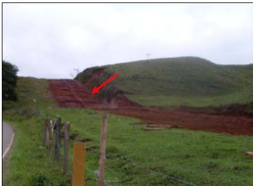
FOTO 6.2-105: Sistema de drenagem provisória (leiras transversais), no km 151, coordenadas em UTM: N= 7.594.817/E= 655.385 (Fonte: Remma Construcap, nov/09).
