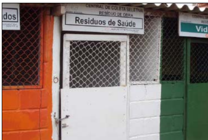
FOTO 6.1.1-80: Baías de armazenamento de resíduos; destaque para a baía de resíduos de saúde, coordenadas em UTM N=7.536.965/E=659.432 (Fonte: Remma Azevedo & Travassos, fev/10).
