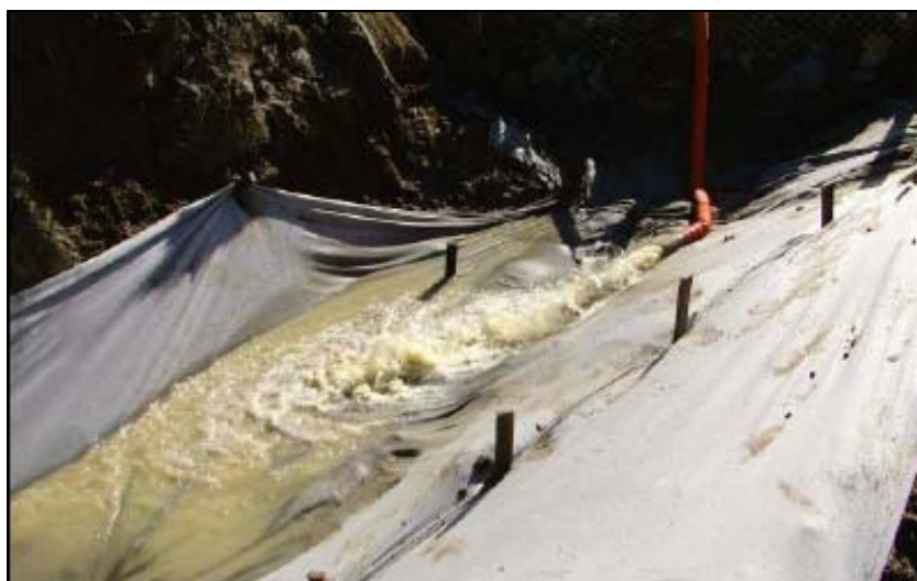
FOTO 6.1.2-59: Estrutura montada para a passagem da água de descarte no km 47+700, coordenadas em UTM N=7.522.673 / E= 636.215 (Fonte: Remma Azevedo & Travassos, mar/10).
