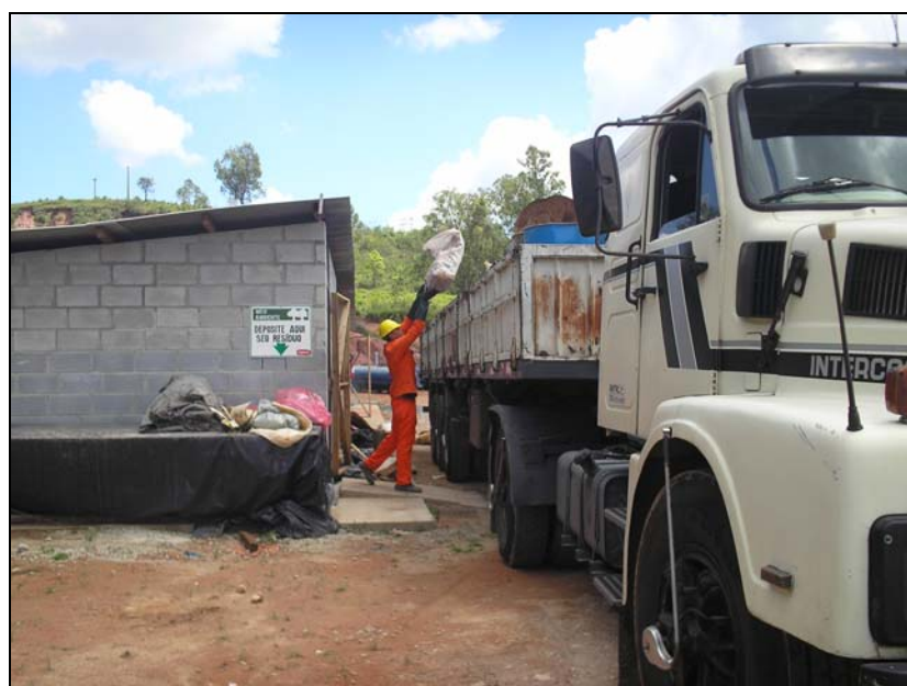
FOTO 6.4.3-12: Coleta de resíduos perigosos realizada pela empresa CNT AMBIENTAL no canteiro de Carandaí-MG, coordenadas em UTM N= 7.683.285/E= 624.859 (Fonte: Remma – Egesa, nov/09).
