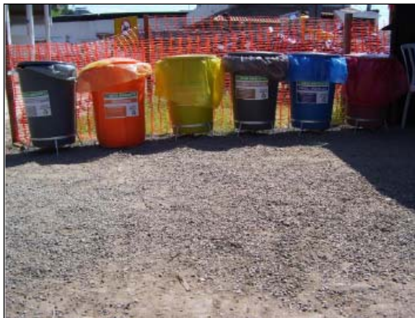
FOTO 6.4.3-7: Kit de coleta seletiva no canteiro operacional de Juiz de Fora - MG, coordenadas em UTM N=7.599.146/E=661.818( Fonte: Remma – Construcap, nov/09).
