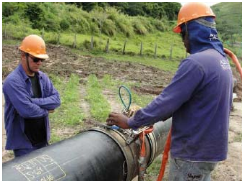
FOTO 6.1.2-45: Atividade de ultrassom, km 64+780, coordenadas em UTM N=7.530.369/ E=649.635 (Fonte: Remma Azevedo & Travassos, mar/10).
