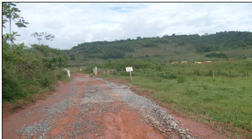
FOTO 6.3-91: Melhoria do acesso ao km 166 da faixa de servidão, coordenadas em UTM N= 7.608.857/E= 655.061 (Fonte: Remma – Construcap, dez/09).
