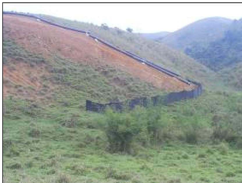
FOTO 6.2-17: Contenção de sedimentos sólidos com manta geotêxtil no km 10 + 200, coordenadas em UTM N= 7.507.307/E= 607.578 (Fonte: Remma Azevedo Travassos, set/09).
