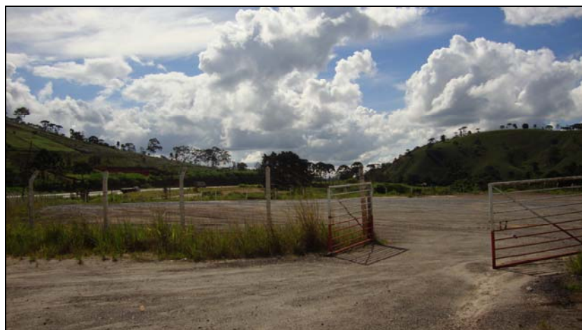
FOTO 6.1.1-21: Vista do Pulmão de Tubos de Correa de Almeida após desmobilização, coordenadas em UTM N=7.644.210/E=642.228 (Fonte: Lenc, mar/10).
