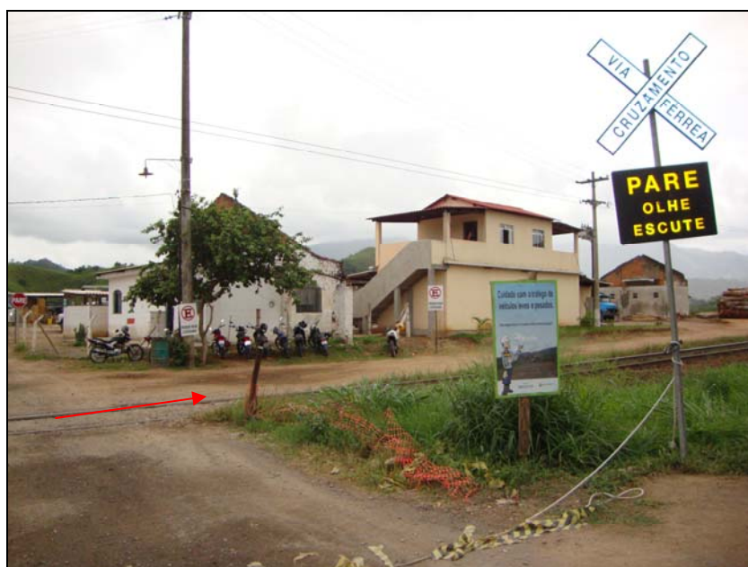
FOTO 6.1.1-87: Sinalização próxima à linha férrea, coordenadas em UTM N=7.519.877/E=627.938 (Fonte: Lenc, mar/10).
