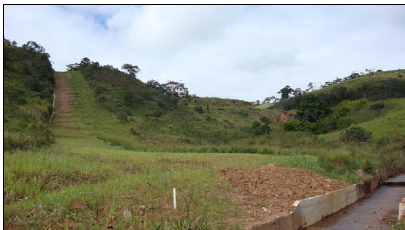
FOTO 6.1.2-69: Faixa de servidão já recomposta, km 202, coordenadas em UTM N=7.638.341/ E=646.979 (Fonte: Lenc, abril/10).
