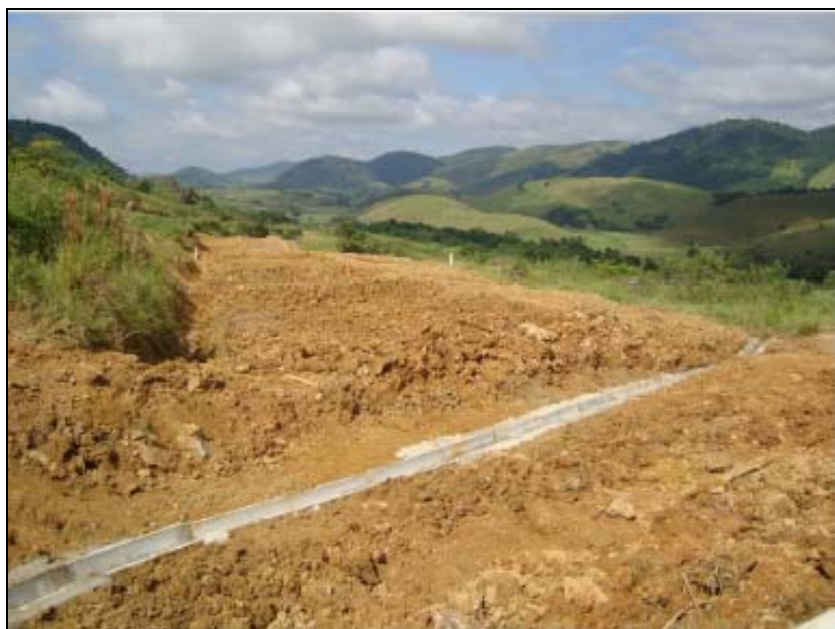
FOTO 6.3-31: Dispositivo definitivo de drenagem, instalação de canaleta pré-fabricada DN 300 no km 122+900, coordenadas em UTM N= 7.568.634/E= 656.077 (Fonte: Remma - Gdk, mar/10).
