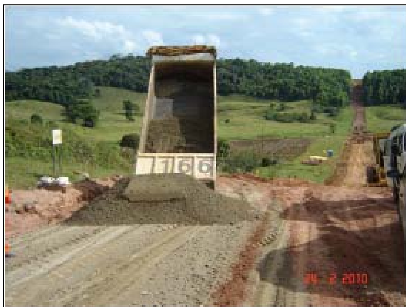
FOTO 6.3-110: Melhoria do acesso ao km 192 da faixa de servidão, coordenadas em UTM N= 7.631.725 /E= 648.339 (Fonte: Remma – Egesa, fev/10).
