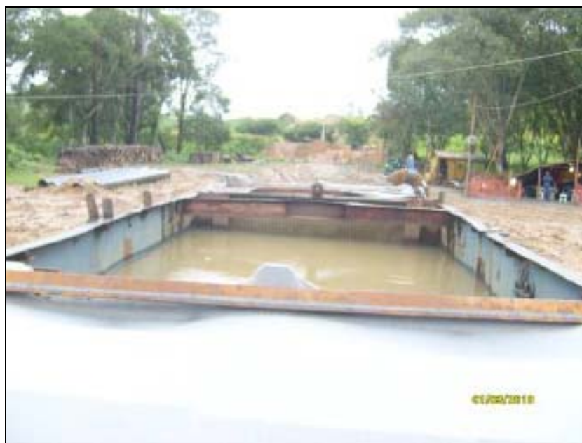
FOTO 6.1.2-56: Container para filtragem da água de captação no km 26, coordenadas em UTM N=7.509.948 / E= 621.018 (Fonte: Remma Azevedo & Travassos, mar/10).
