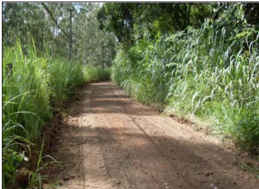
FOTO 6.3-101: Melhoria do acesso ao km 168 da faixa de servidão, coordenadas em UTM N= 7.610.672/E= 654.533 (Fonte: Remma – Construcap, fev/10).
