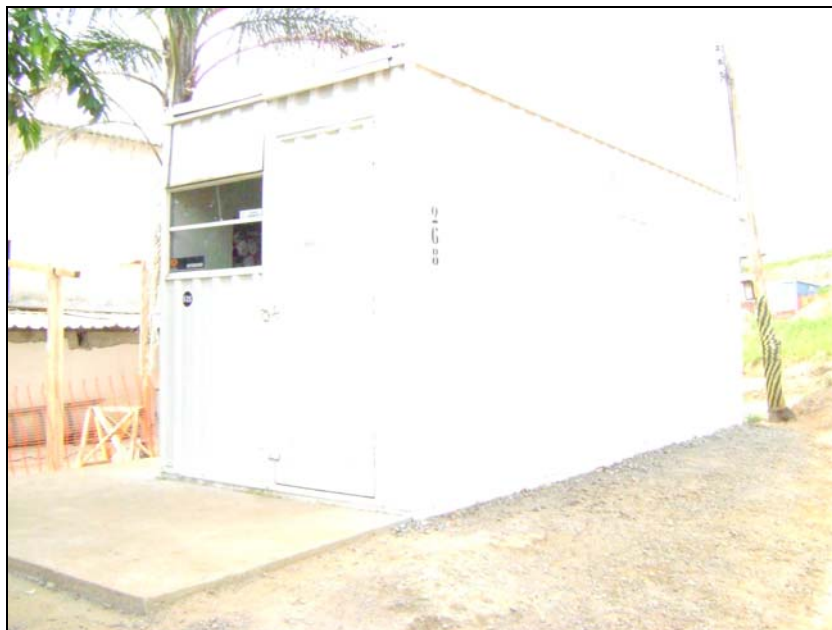
FOTO 6.1.1-82: Containers destinado a abrigar o ambulatório, coordenadas em UTM N=7.536.965/E=659.432 (Fonte: Lenc, jan/10).
