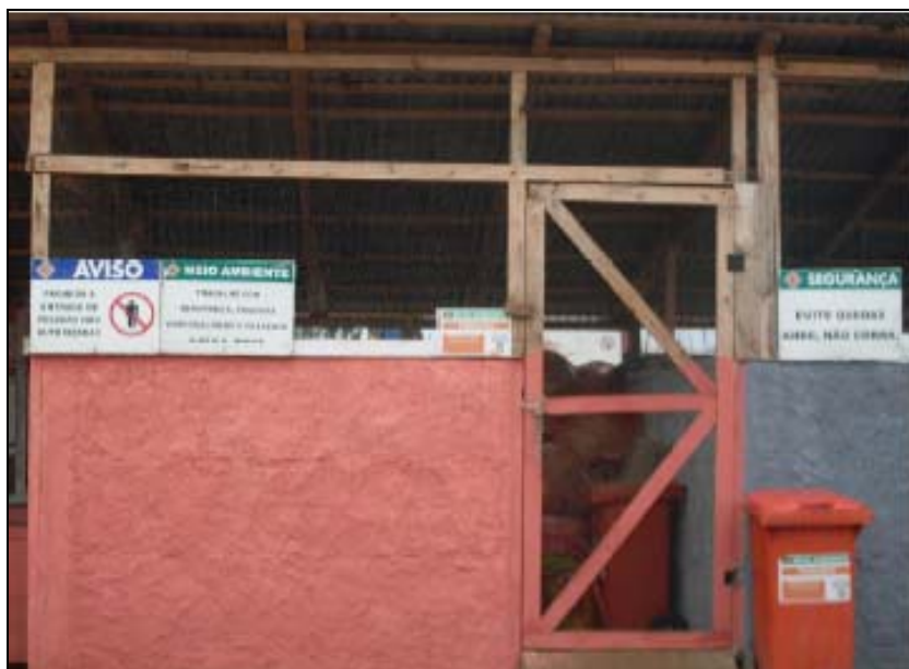
FOTO 6.4.3-6: Baia para acondicionamento de resíduo perigoso, canteiro operacional de Juiz de Fora – MG, coordenadas em UTM N=7.599.146/E=661.818 (Fonte: Remma – Construcap, nov/09).
