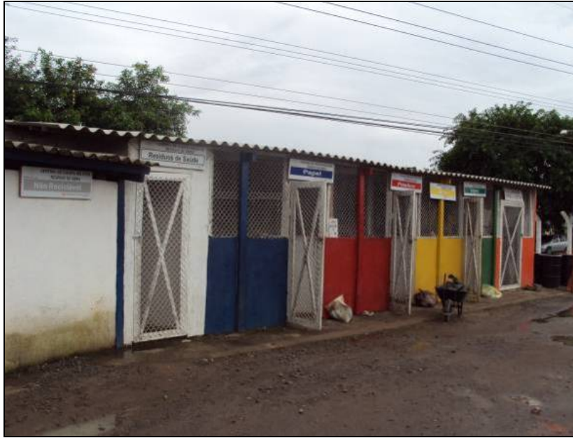
FOTO 6.4.3-13: Baias de acondicionamento de resíduos no Canteiro central de Pinheiral, município de Pinheiral – RJ, coordenadas em UTM N= 7.512.069/E= 601.305 ( Fonte: Remma – Azevedo Travassos, dez/09).
