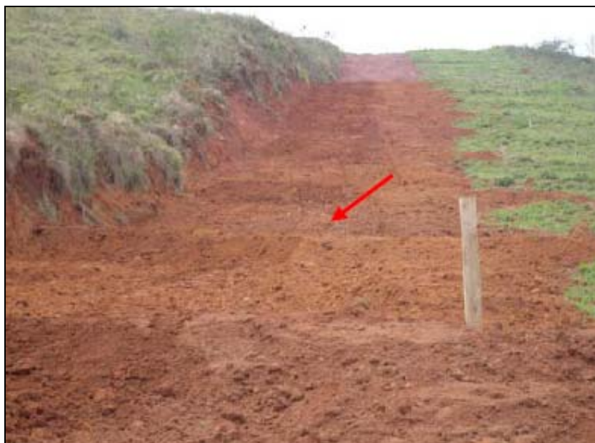
FOTO 6.2-109: Sistema de drenagem provisória (leiras transversais) no km 103, coordenadas em UTM: N= 7.549.634 /E= 657.784 (Fonte: Remma – Construcap, dez/09).
