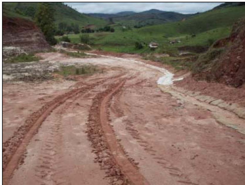
FOTO 6.1.2-29: Área designada para bota-fora (31), em utilização, coordenadas em UTM N=7.592.618/E=655.032 (Fonte: Construcap, mar/10).
