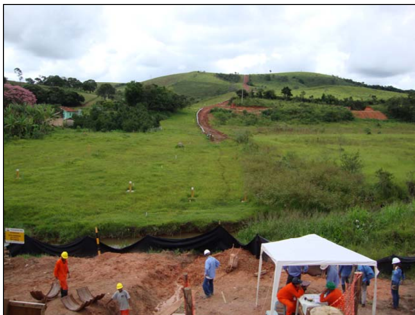
FOTO 6.2-70: Proteção de curso d'água contra carreamento de sedimentos sólidos com manta geotêxtil, km 234, coordenadas N= 7.662.950 / E= 628.419 (Fonte: Lenc, jan/10).
