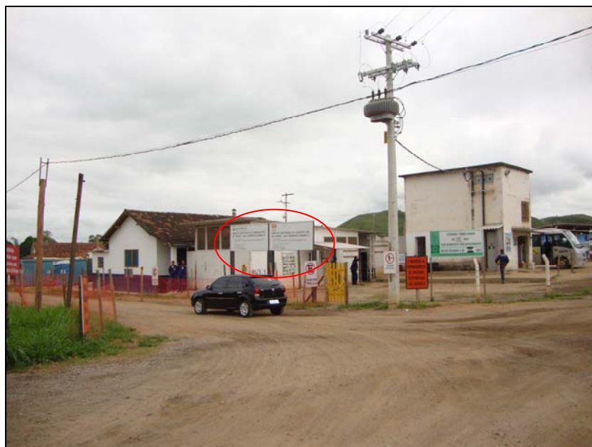
FOTO 6.1.1-85: Vista de parte da entrada do canteiro de Itakamosy/RJ, com destaque para as placas de obra, coordenadas em UTM N=7.519.877/E=627.938 (Fonte: Lenc, mar/10).
