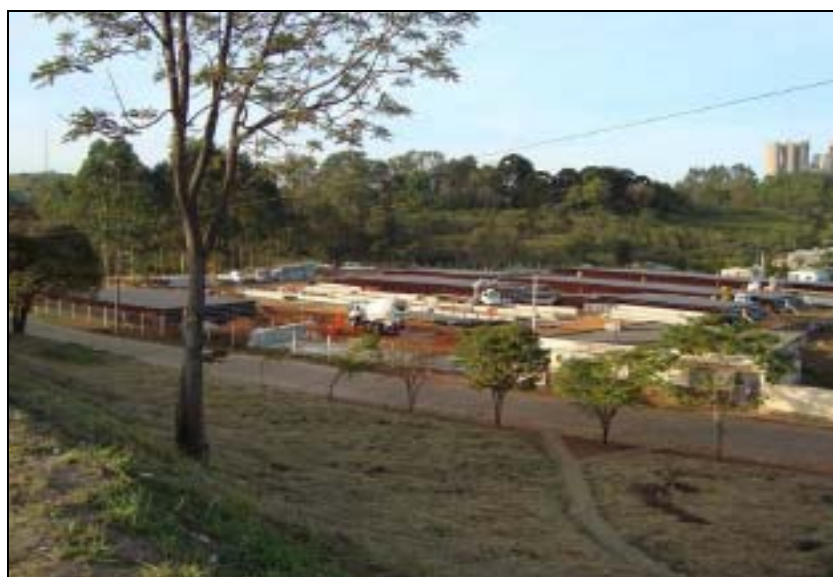
FOTO 6.1.1-1: Vista do Canteiro Pulmão de Tubos de Pedra do Sino em julho de 2009, coordenadas em UTM N=7.688.225/E=621.993 (Fonte: Remma Egesa, jul/2009).
