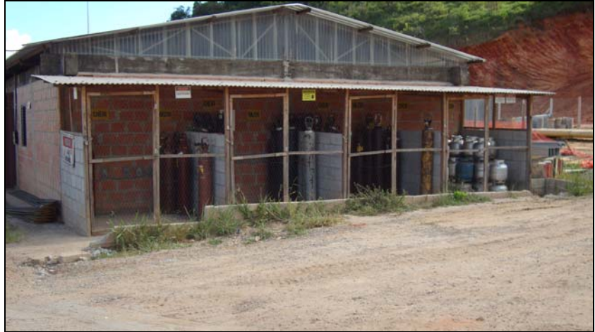
FOTO 6.1.1-17: Baias de acondicionamento de produtos inflamáveis, coordenadas em UTM N=7.688.225/E=621.993 (Fonte: Lenc, mar/10).
