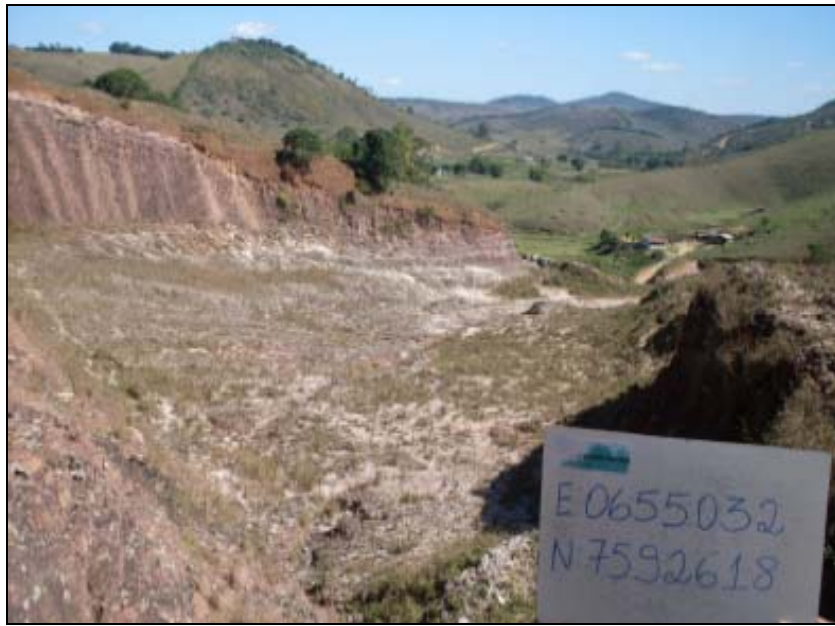
FOTO 6.1.2-28: Área designada para bota-fora (31), antes da utilização, coordenadas em UTM N=7.592.618/E=655.032 (Fonte: Construcap, mar/10).
