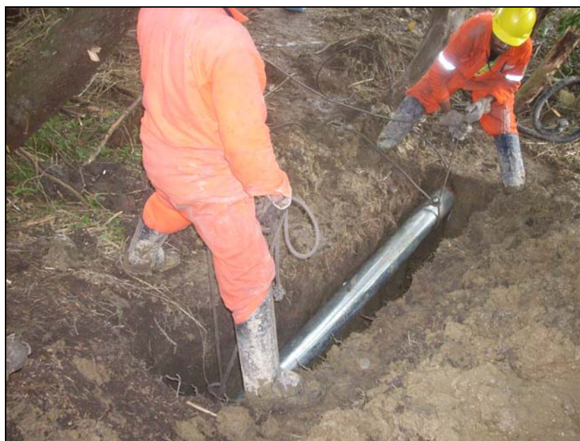
FOTO 6.1.2-63: Instalação de leitos de anodos, km 260, coordenadas em UTM N= 7.687.420/ E=621.487 (Fonte: Petrobrás, mar/10).
