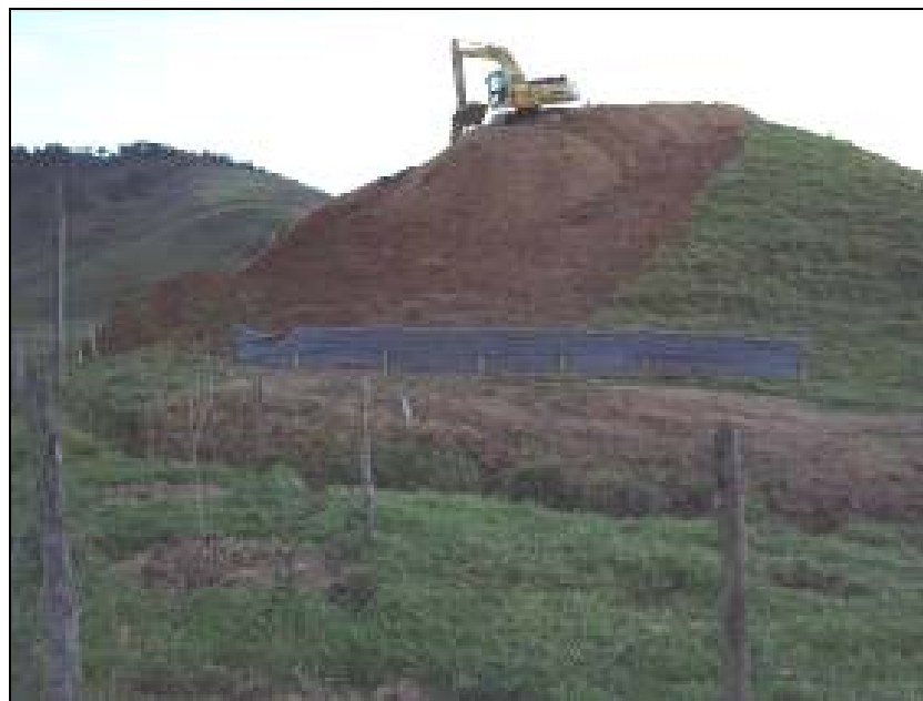
FOTO 6.2-13: Contenção de sedimentos sólidos com manta geotêxtil no km 07, coordenadas em UTM N= 7.506.330/E= 604.916 (Fonte: Remma Azevedo Travassos, jul/09).
