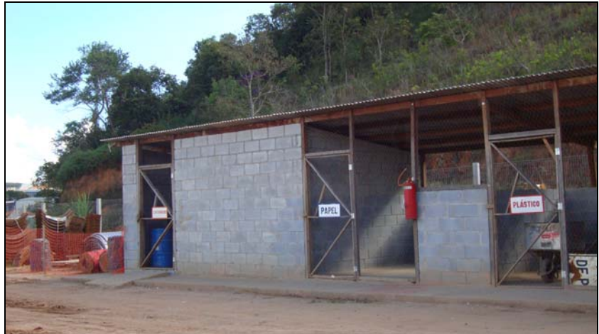
FOTO 6.1.1-16: Baias destinadas ao acondicionamento de resíduos gerados durante a obra, coordenadas em UTM N=7.688.225/E=621.993 (Fonte: Lenc, mar/10).
