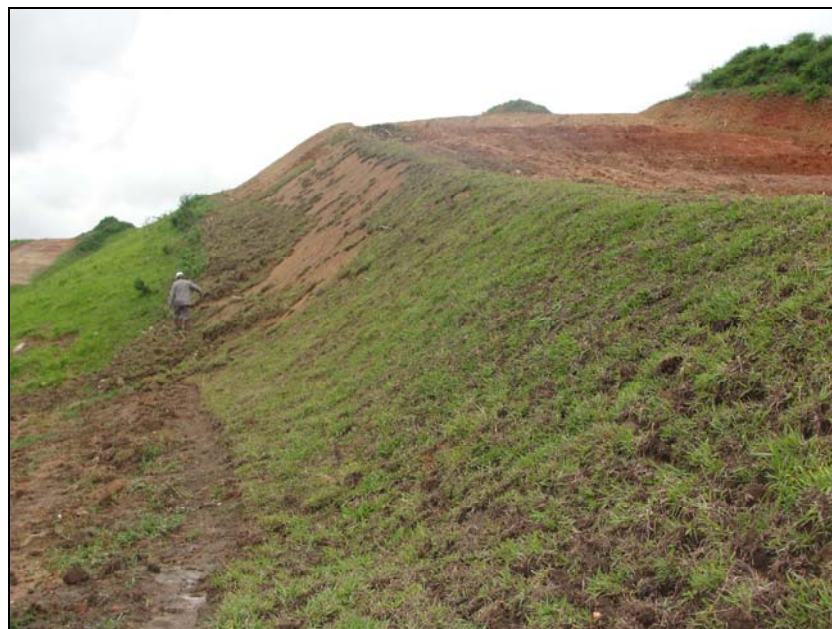
FOTO 6.2-2: Saia de aterro revegetada no km 7, coordenadas em UTM N= 7.506.330/E= 604.916 (Fonte: Remma, Azevedo Travassos/2009).
