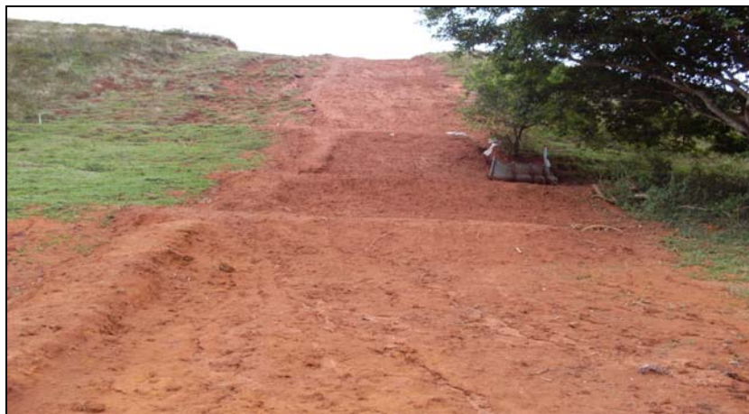
FOTO 6.3-1: Recomposição mecânica da faixa após as intervenções no km 101, coordenadas em UTM N= 7.547.730/E= 658.291 (Fonte: Remma Construcap, nov/09).
