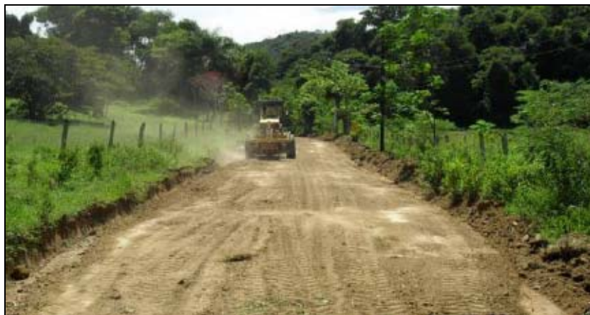
FOTO 6.3-115: Melhoria do acesso ao km 38 da faixa de servidão, coordenadas em UTM N= 7.516.579/E= 630.120(Fonte: Remma – Azevedo Travassos, mar/10).
