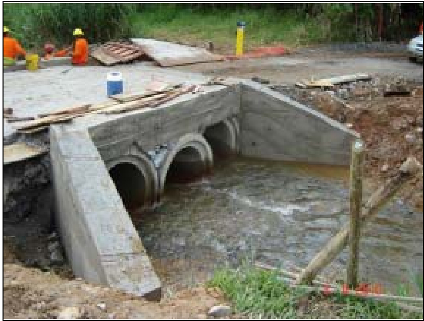
FOTO 6.1.1-129: Construção de ponte sobre o Ribeirão Perobas, próximo ao km 194+800, coordenadas em UTM N= 7.627.485/E= 647.503 (Fonte: Remma Egesa, mar/10).
