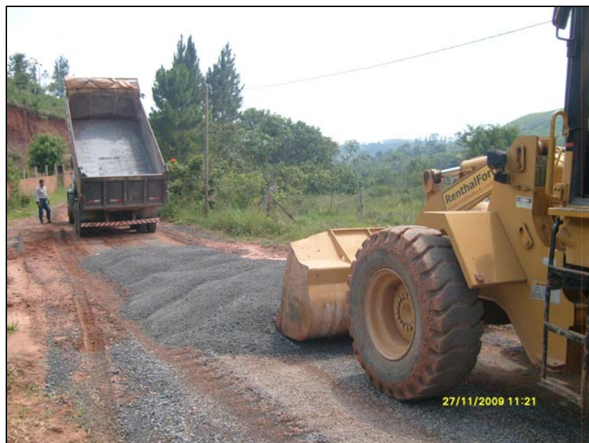
FOTO 6.3-84: Melhoria do acesso ao km 167, coordenadas em UTM N= 7.609.700/E= 654.650 (Fonte: Construcap, nov/09).
