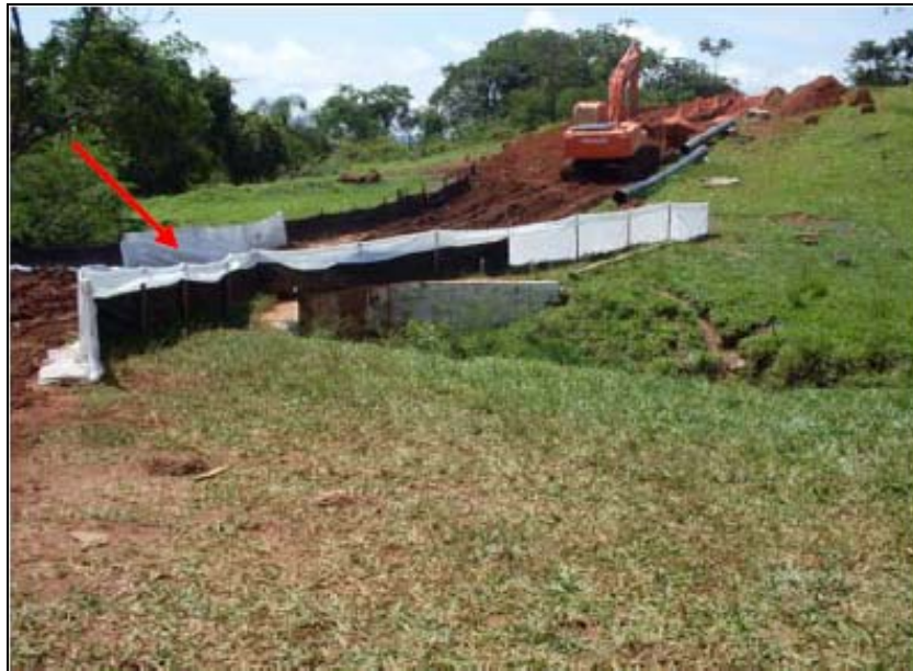
FOTO 6.2-62: Barreira de contenção com o objetivo de evitar o carreamento de sedimentos sólidos para o curso d'água, no km 115, coordenadas em UTM N= 7.561.002/E= 655.465 (Fonte: Remma - Construcap, dez/09).
