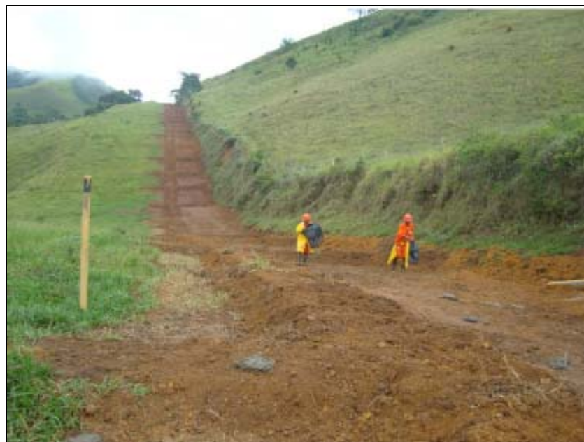
FOTO 6.3-69: Atividades de semeadura manual no km 135+400, coordenadas em UTM N= 7.580.393/E= 656.288 (Fonte: Remma – GDK, mar/10).
