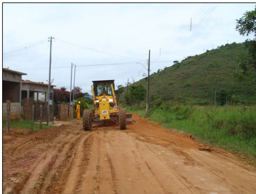
FOTO 6.3-85: Melhoria do acesso ao km 126 (nivelamento de pista), coordenadas em UTM N= 7.571.480/E= 656.206 (Fonte: Construcap, nov/09).
