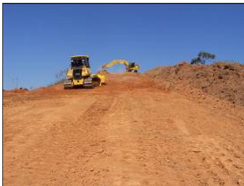
FOTO 6.2-96: Abertura de pista no km 21, coordenadas em UTM: N= 7.509.980/E= 617.216 (Fonte: Remma Azevedo Travassos, set/09).
