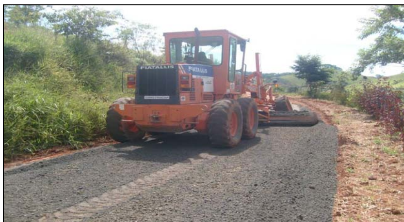
FOTO 6.3-96: Melhoria do acesso ao km 169 da faixa de servidão, coordenadas em UTM N= 7.611.542/E= 654.082 (Fonte: Remma – Construcap, dez/09).
