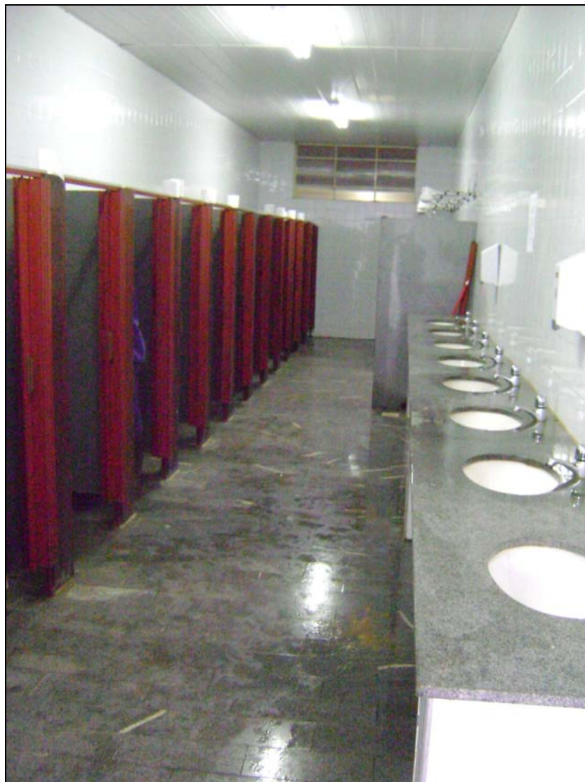
FOTO 6.1.1-76: Vestiário dos funcionários, coordenadas em UTM N=7.536.965/E=659.432 (Fonte: Lenc, jan/10).
