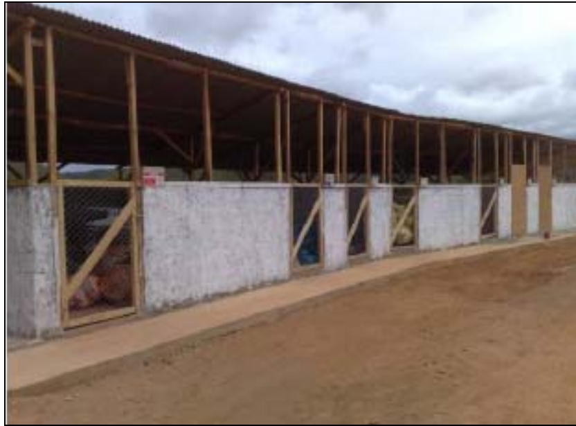
FOTO 6.1.1-68: Baias de armazenamento temporário de resíduos, coordenadas em UTM N=7.556.706/E=648.650 (Fonte: Remma Construcap, mar/10).
