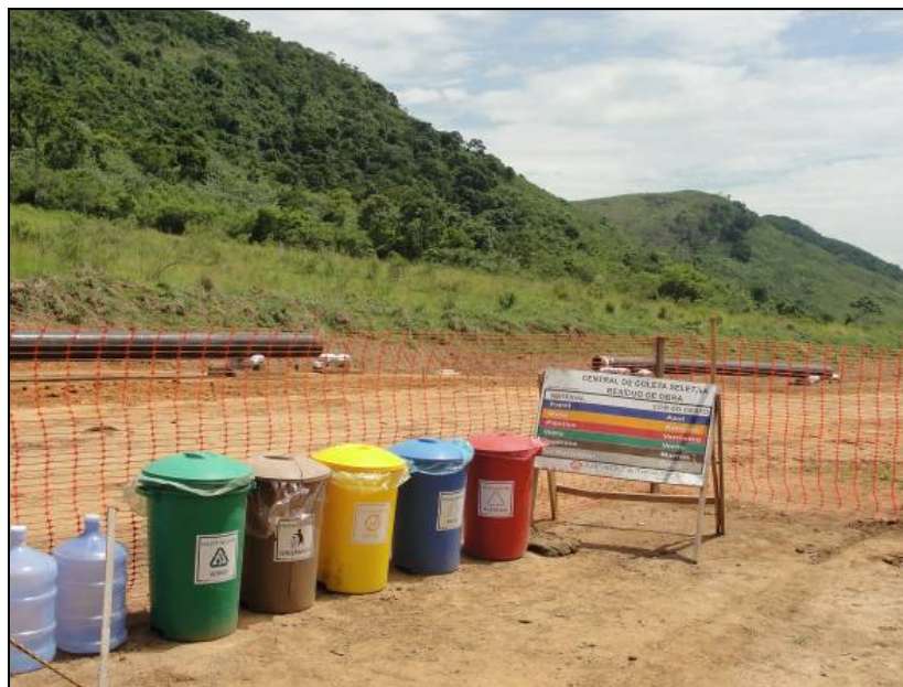
FOTO 6.4.3-3: Kit de coleta seletiva na frente de obra no km 71+050, coordenadas em UTM N= 7.533.229/E= 654.643 (Fonte: Remma Azevedo Travassos, out/09).
