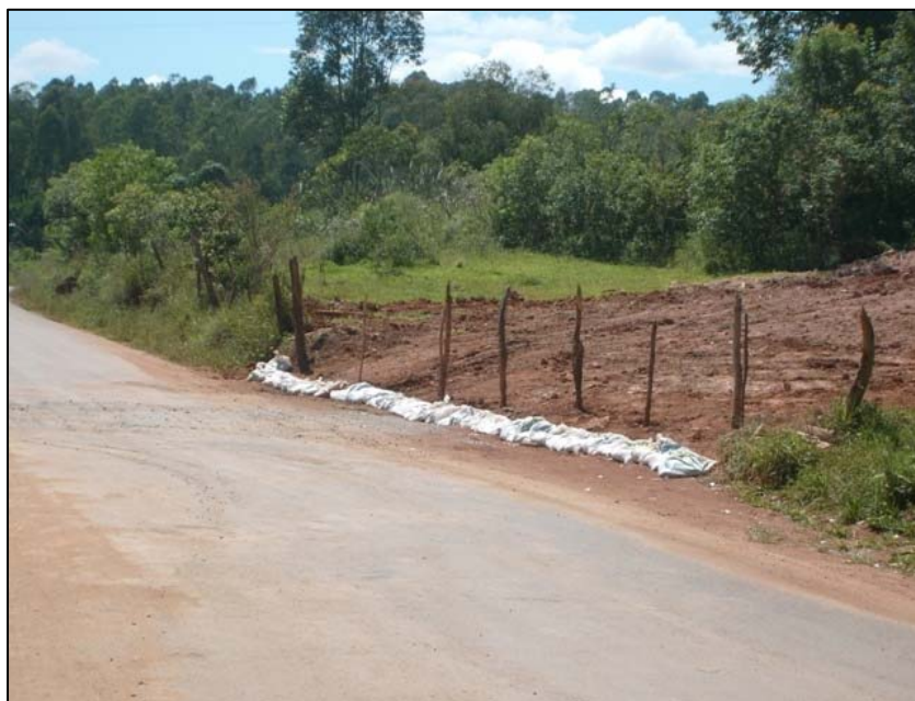
FOTO 6.2-44: Contenção de sedimentos sólidos com sacaria de solo-cimento, no km 232, coordenadas em UTM N= 7.661.367/E= 629.053(fonte: Remma - Egesa, fev/10).
