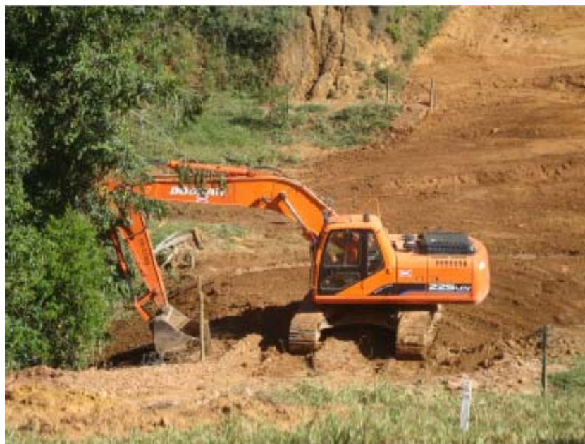
FOTO 6.3-6: Reposição do solo superficial no km 136, coordenadas em UTM N= 7.580.990/E= 656.200 (Fonte: Remma - GDK, fev/10).
