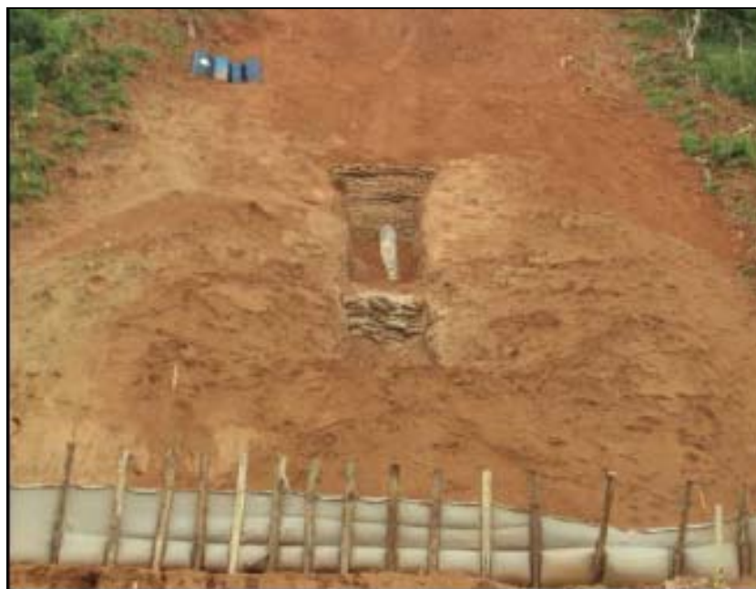
FOTO 6.1.2-52: Construção de dique com solo ensacado no km 44, coordenadas em UTM N=7.520.544/ E= E=633.668. (Fonte: Remma Azevedo & Travassos, mar/10).
