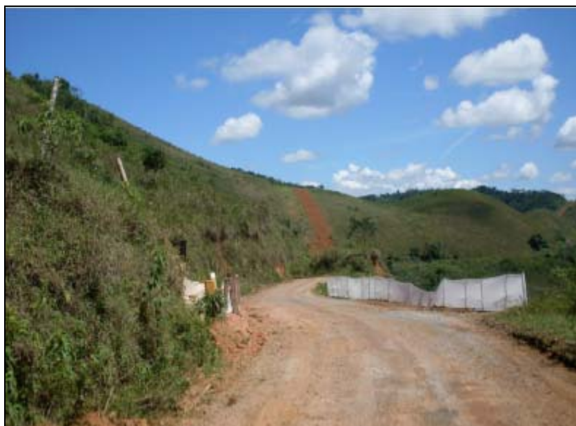
FOTO 6.3-102: Melhoria do acesso ao km 166 da faixa de servidão, coordenadas em UTM N= 7.608.857/E= 655.061 (Fonte: Remma – Construcap, fev/10).
