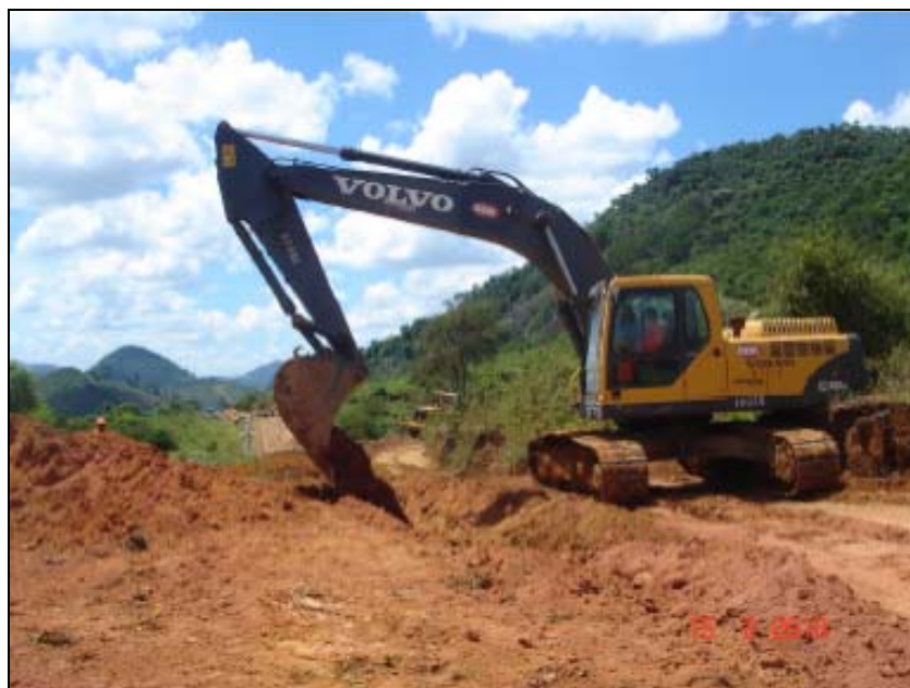
FOTO 6.1.2-50: Cobertura da vala, km 138, coordenadas em UTM N=7.582.937/ E=655.916 (Fonte: Remma GDK, fev/10).
