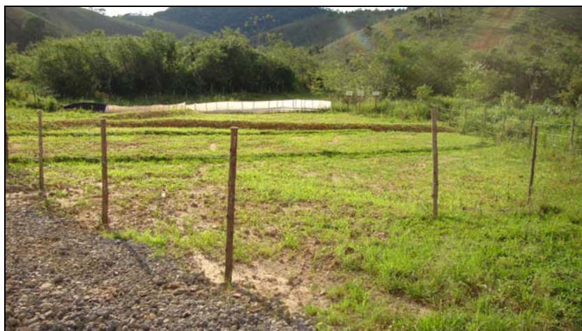
FOTO 6.3-60: Trecho da faixa de servidão com recomposição vegetal no km 140, coordenadas em UTM N= 7.584.623/E= 655.797 (Fonte: Lenc, mar/10).
