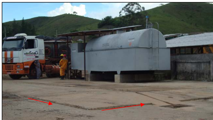
FOTO 6.1.1-58: Ponto de abastecimento de veículos; no detalhe, (setas) canaletas de captação, coordenadas em UTM N=7.597.952/E=661.072 (Fonte: Lenc, abr/10).
