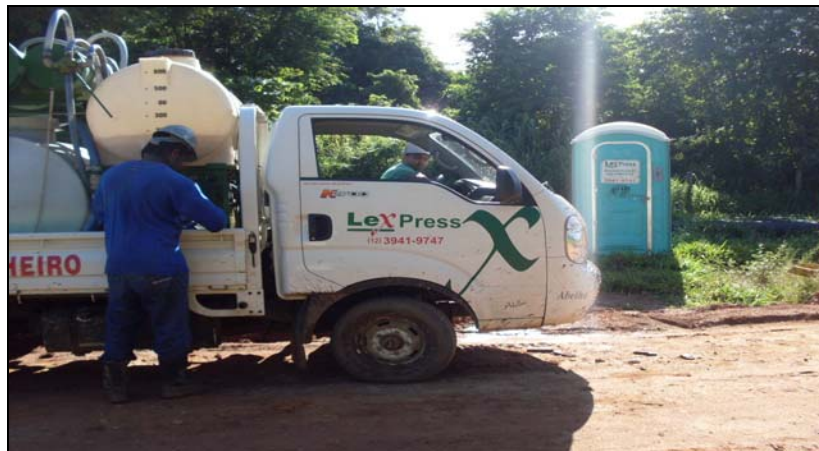
FOTO 6.4.4-18: Limpeza de banheiro químico localizado na faixa de servidão no km 116, coordenadas em UTM N= 7.561.937/E= 655.350(Fonte: Remma- Construcap, dez/09).
