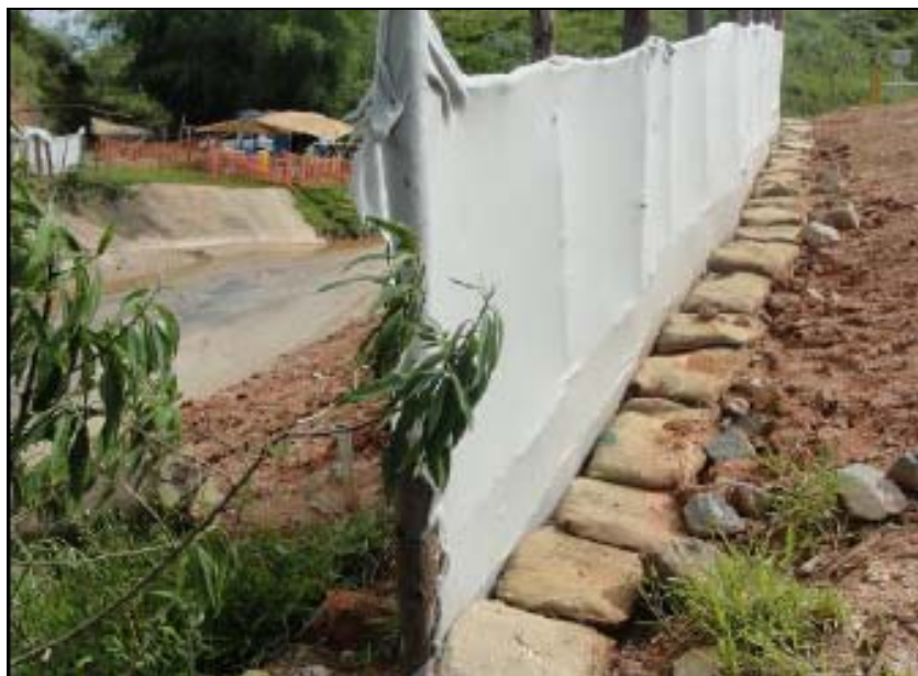
FOTO 6.2-66: Barreiras de contenção com manta geotêxtil e sacarias para proteção do córrego Cachimbal, no km 04, coordenadas em UTM N= 7.507.470 / E= 602.257 (Fonte: Remma – Azevedo Travassos, jan/10).
