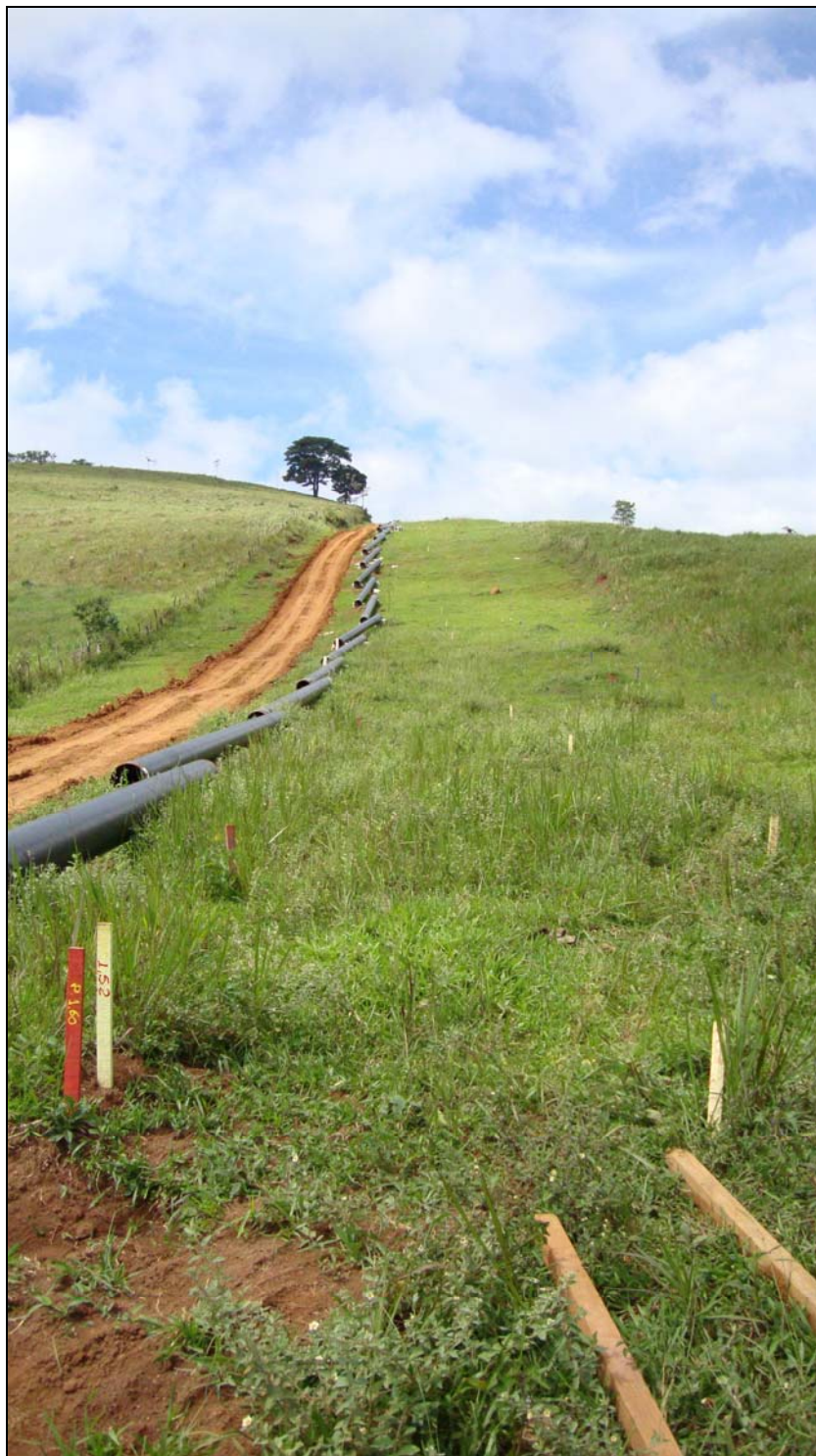
FOTO 6.1.2-35: Desfile de tubos no km 190, coordenadas em UTM N= 7.629.549/ E=648.282 (Fonte: Lenc, jan/10).
