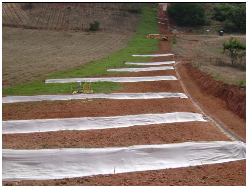
FOTO 6.3-77: Aplicação de biomanta e execução de canaleta longitudinal no km 101, coordenadas em UTM N= 7.548.117/E= 658.116(Fonte: Lenc, mai/10).
