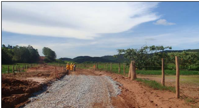
FOTO 6.3-89: Melhoria do acesso ao km 156 da faixa de servidão, coordenadas em UTM N= 7.599.654/E= 656.321 (Fonte: Remma – Construcap, dez/09).
