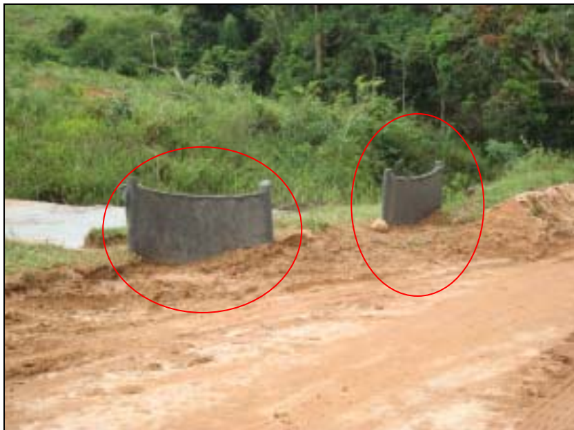
FOTO 6.1.1-134: Proteção de curso d'água (barreira de contenção) no acesso ao km 125+235, coordenadas em UTM N= 7.570.790/E=656.483 (Fonte: Remma GDK, mar/10).
