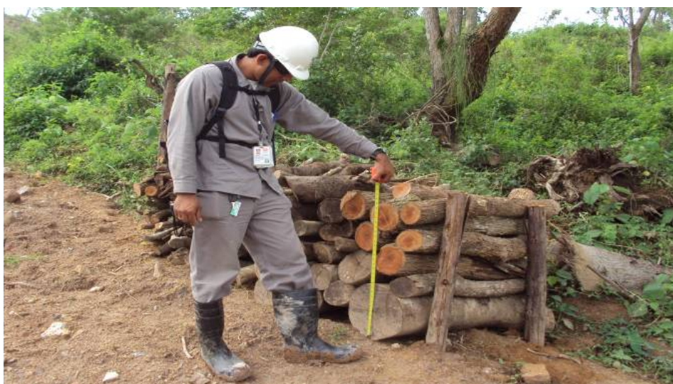
FOTO 5.4-1: Cubagem do material lenhoso suprimido e empilhado no km 26+960 (coordenadas em UTM: N=7.510.223/E=621.840), Fonte: AZT, 2009.
