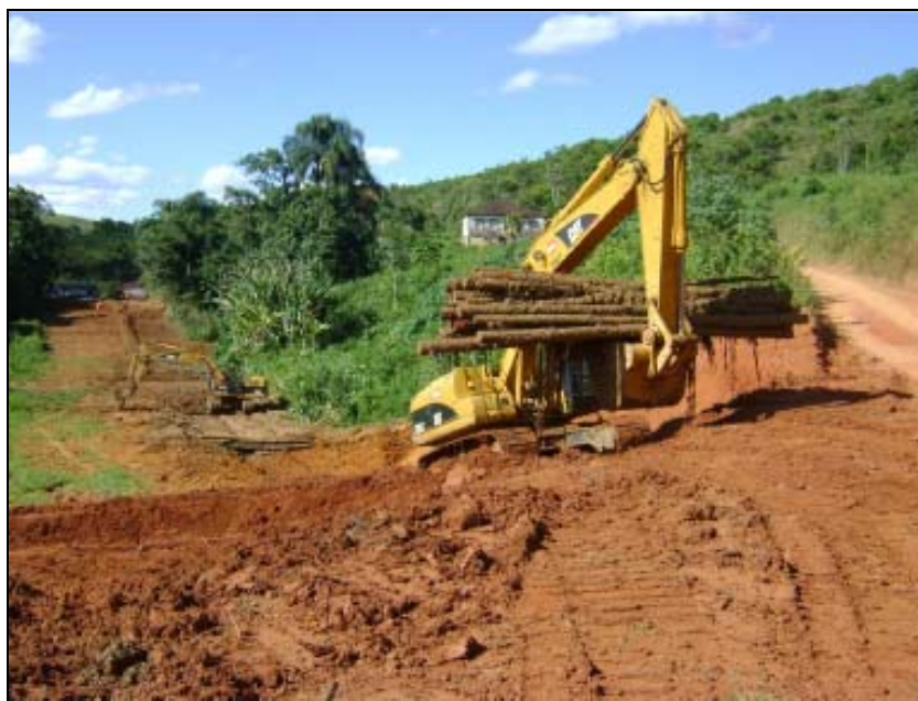
FOTO 6.2-95: Retirada de estiva de área brejosa, no km 130+740, coordenadas em UTM: N= 7.576.062 /E= 655.764 (Fonte: Remma – GDK, mar/10).
