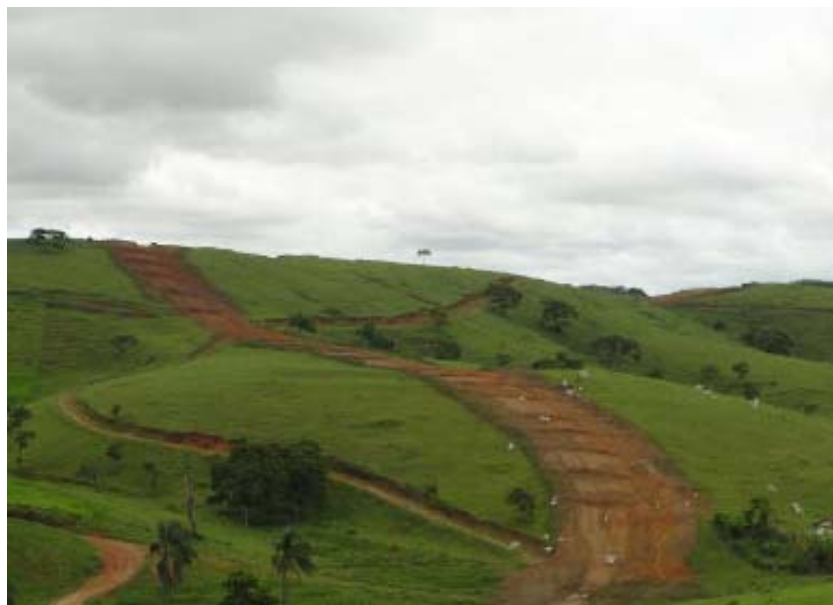
FOTO 6.3-14: Dispositivo de drenagem definitivo (leiras) no km 62, coordenadas em UTM N= 7.528.598 /E= 647.912 (Fonte: Remma - Azevedo Travassos, dez/09).
