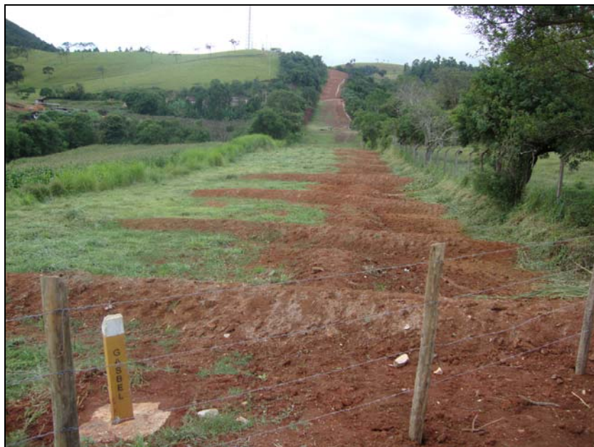
FOTO 6.3-67: Sistema de drenagem definitivo (leiras) e recomposição vegetal (hidrossemeadura) no km 260+950, coordenadas em UTM N= 7.688.253/E= 621.723 (Fonte: Lenc, mar/10).
