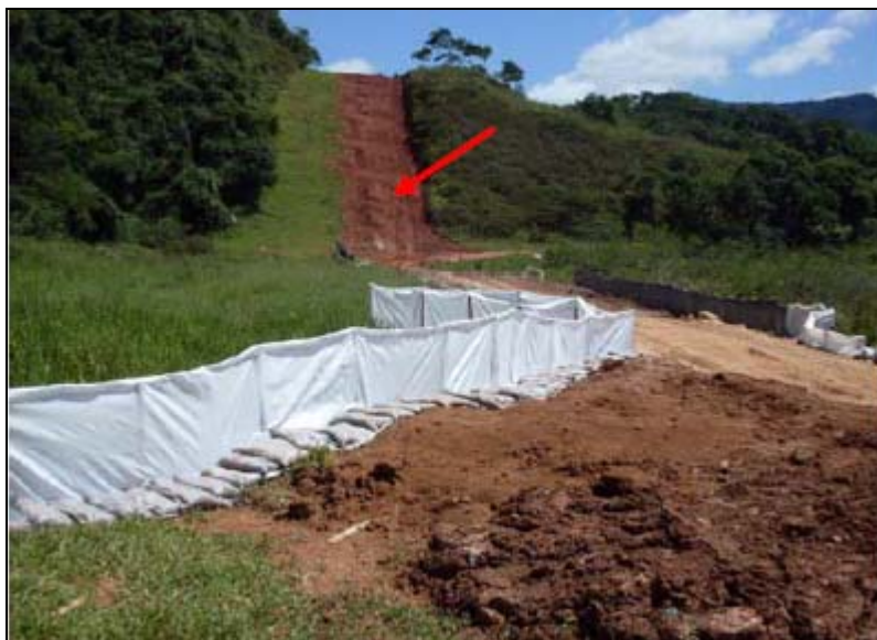
FOTO 6.2-68: Barreira de contenção com o objetivo de evitar o carreamento de sedimentos sólidos para o curso d'água – APP, no km 116+134, coordenadas em UTM N= 7.562.098/E= 655.366 (Fonte: Remma - Construcap, jan/10).
