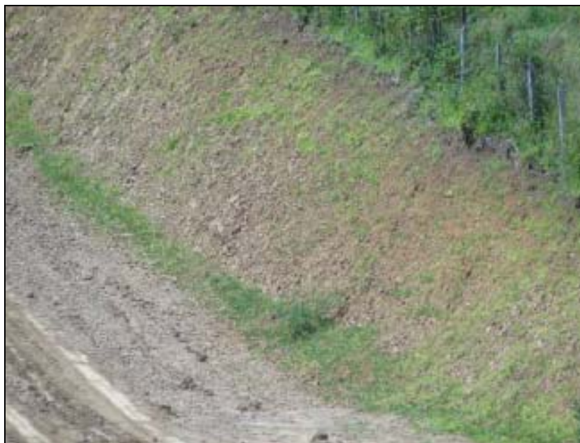
FOTO 6.2-11: Talude em recuperação com hidrossemeadura no km 42+020, coordenadas em UTM N= 7.519.453/E= 632.073 (Fonte: Remma - Azevedo Travassos, mar/10).
