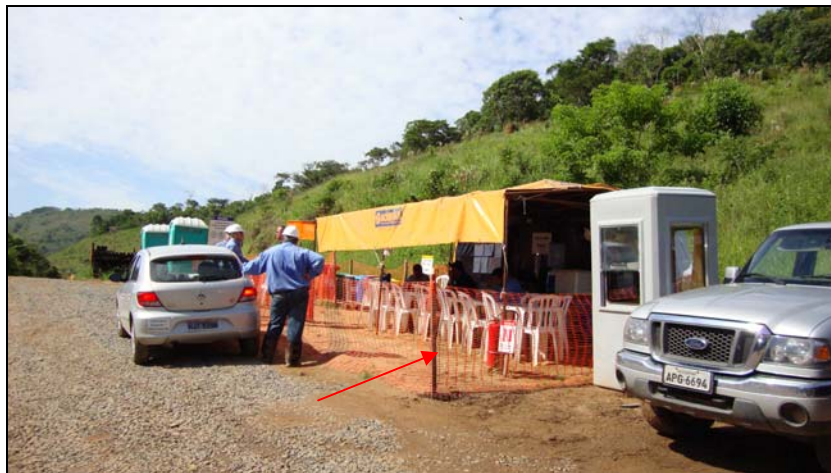
FOTO 6.1.1-117: Área de vivência no km 134+700; destaque para a delimitação por cerquites , coordenadas em UTM N=7.579.567/E=656.406 (Fonte:Lenc, jan/10).
