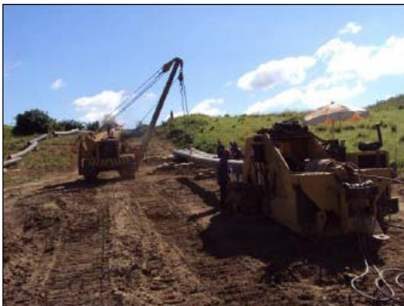
FOTO 6.1.2-36: Curvamento da tubulação no km 54, coordenadas em UTM N=7.525.563 / E=640.844 (Fonte: Remma Azevedo & Travassos, jan/10).
