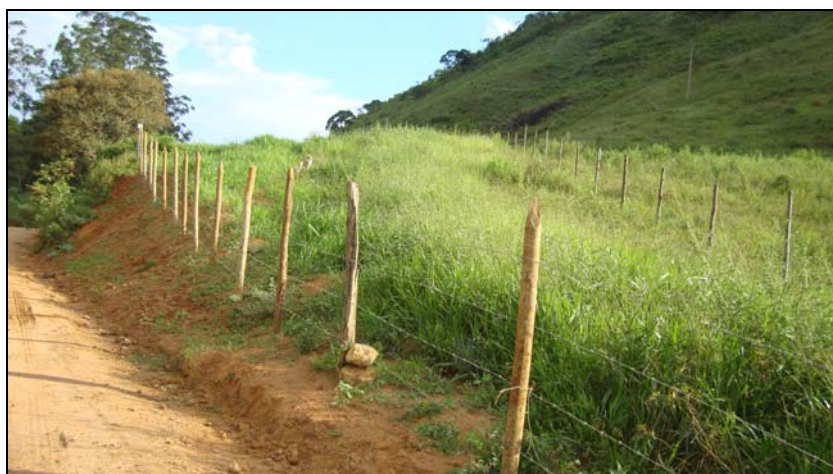
FOTO 6.3-62: Trecho da faixa de servidão com recomposição vegetal no km 142+480, coordenadas em UTM N= 7.587.173/E= 655.274 (Fonte: Lenc, mar/10).
