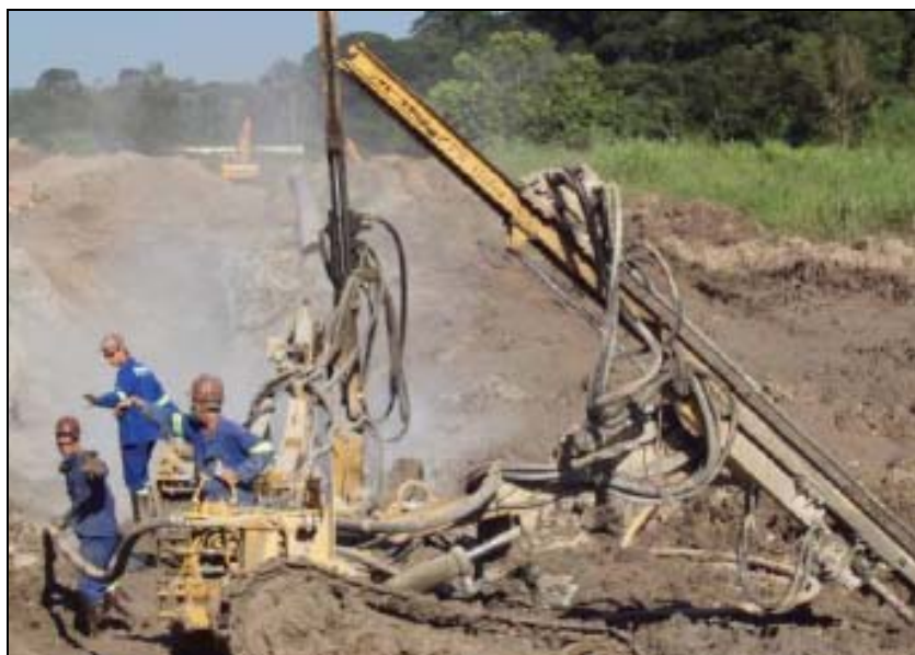
FOTO 6.1.3-40: Perfuração de rocha para o uso de explosivos no km 59, coordenadas em UTM N=7.527.348/E=645.431 (Fonte: Remma Azevedo & Travassos, mar/10).
