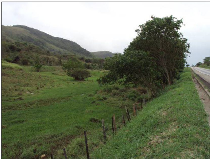
FOTO 6.1.2-24: Área designada para bota-fora (24A), antes da utilização, coordenadas em UTM N=7.532.712/E=654.227 (Fonte: Remma Azevedo&Travassos, mar/10).
