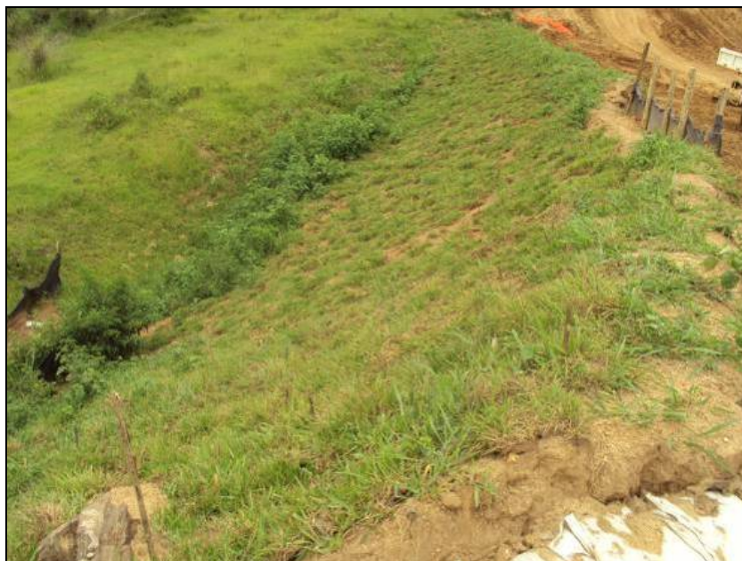
FOTO 6.2-5: Revegetação da saia do aterro, no km 73+420, coordenadas em UTM N= 7.574.749 /E= 656.411 (Fonte: Remma - Azevedo Travassos, dez/09).
