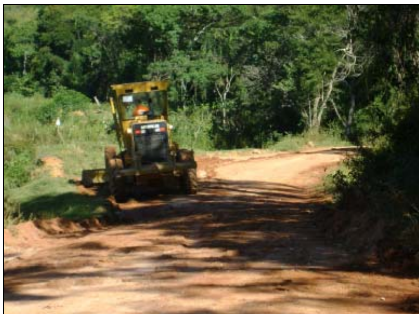
FOTO 6.3-104: Melhoria do acesso aos km 125, 126 e 127 da faixa de servidão, coordenadas em UTM N= 7.570.568/E= 656.476 (Fonte: Remma – GDK fev/10).
