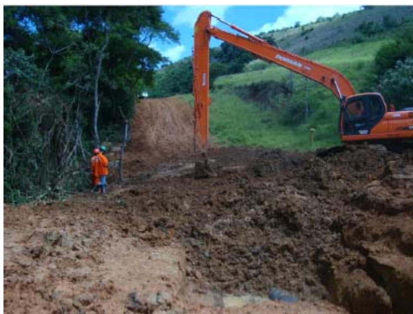
FOTO 6.3-4: Reposição do solo superficial no km 137+400, coordenadas em UTM N= 7.582.353/E= 655.924 (Fonte: Remma - GDK, fev/10).
