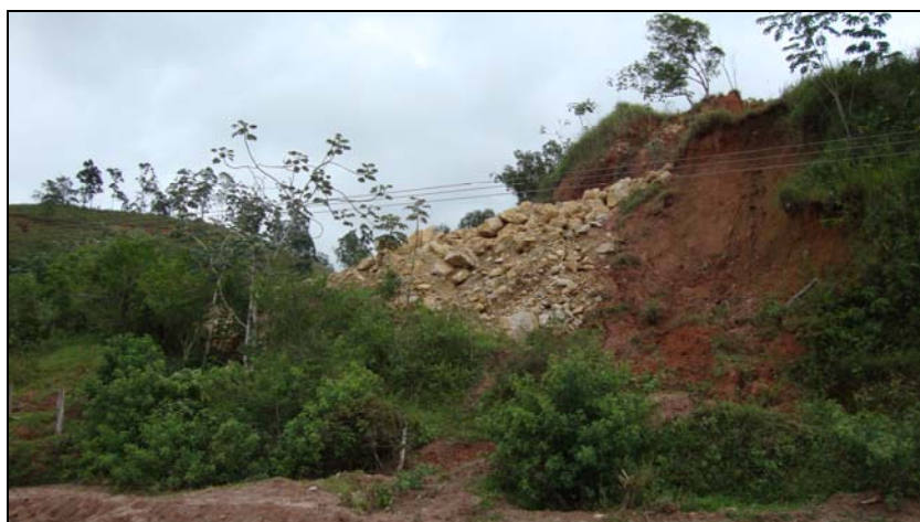
FOTO 6.1.3-41: Área designada para bota-fora (12E) de rocha, coordenadas em UTM N=7.510.316 /E=621.401 (Fonte: Lenc, mar/10).
