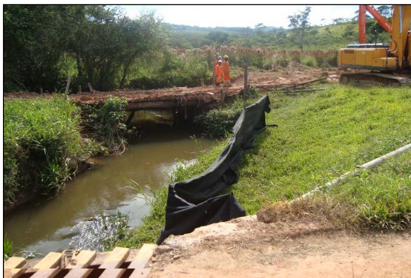
FOTO 6.2-75: Proteção do corpo d'água (APP) com manta geotêxtil contra carreamento de sedimentos sólidos, no km 273, coordenadas em UTM N= 7.699.187/E= 618.156(fonte: Remma - Egesa, fev/10).
