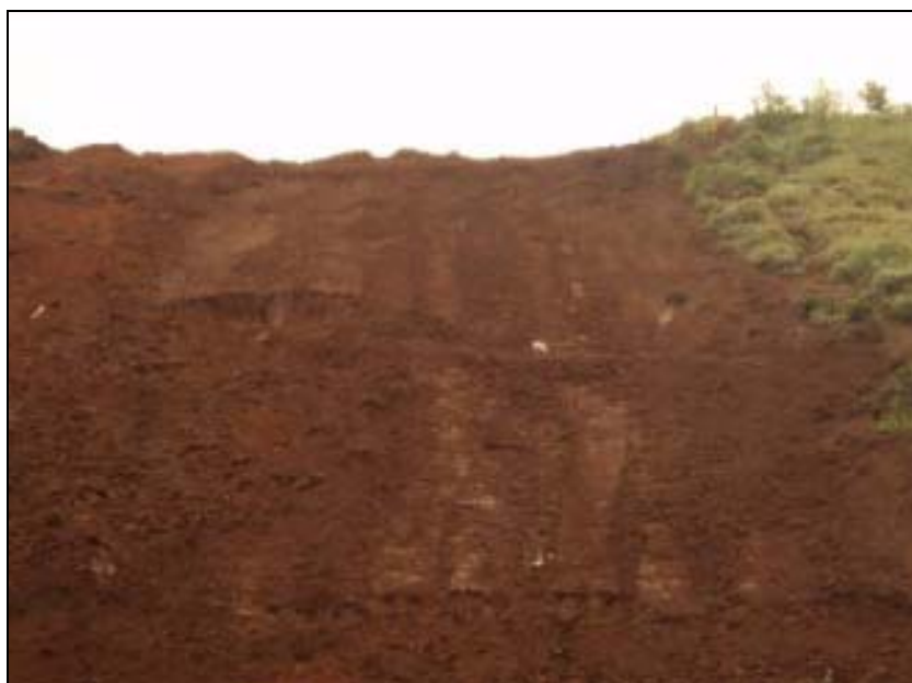
FOTO 6.2-118: Construção de leiras no km 40, coordenadas em UTM N = 7.517.878/E= 631.110 (Fonte: Remma – Azevedo Travassos, fev/10).
