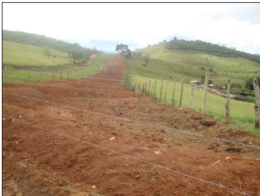
FOTO 6.3-25: Sistema de drenagem definitivo (leiras) e recomposição vegetal (hidrossemeadura) no km 263+950, coordenadas em UTM N= 7.691.162/E= 621.593 (Fonte: Lenc, mar/10).
