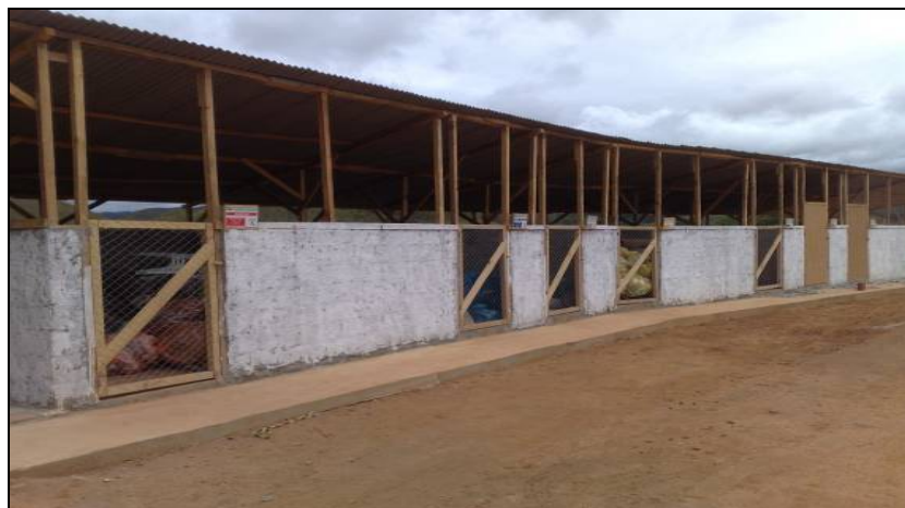
FOTO 6.4.3-4: Baias de armazenamemnto temporário de resíduos, canteiro operacional de Rio das Flores – RJ, coordenadas em UTM N=7.556.630/E= 648.601( Fonte: Remma – Construcap, nov/09).
