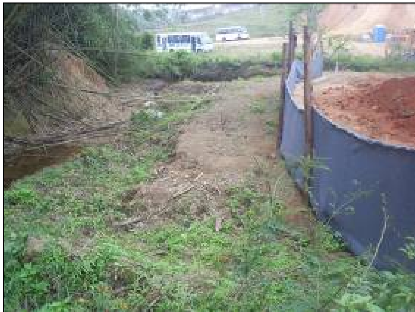
FOTO 6.2-54: Contenção contra carreamento de sedimentos sólidos provenientes da faixa de servidão, no km 09, coordenadas em UTM N= 7.506.854/E= 606.568 (Fonte: Remma Azevedo Travassos, set/09).
