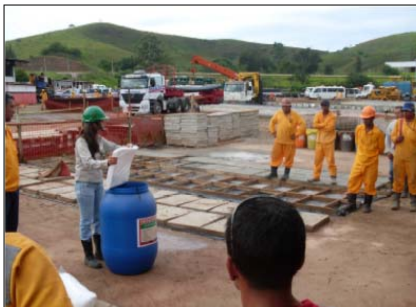
FOTO 6.4.1-11:Treinamento Ambiental no canteiro operacional de Juiz de Fora, coordenadas em UTM N= 7.597.871/E= 661.013 (Fonte: Remma – Construcap, fev/10).
