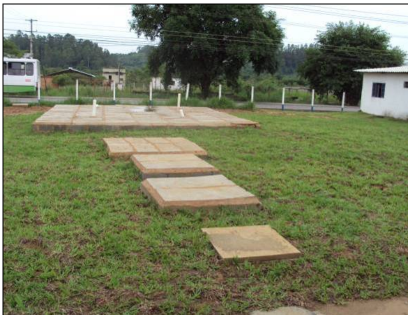
Foto 6.4.4-8: Área de implantação da fossa séptica no canteiro central de Pinheiral, município de Pinheiral/RJ, coordenadas em UTM N= 7.512.069/E= 601.305 ( Fonte: Remma – Azevedo Travassos, dez/09).
