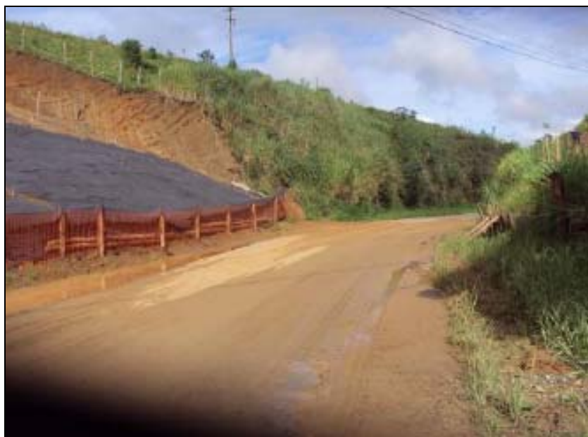
FOTO 6.2-28: Barreiras de contenção com manta geotêxtil para evitar o carreamento de sedimentos sólidos no km 48, coordenadas em UTM N= 7.522.855 / E= 636.451 (Fonte: Remma – Azevedo Travassos, jan/10).
