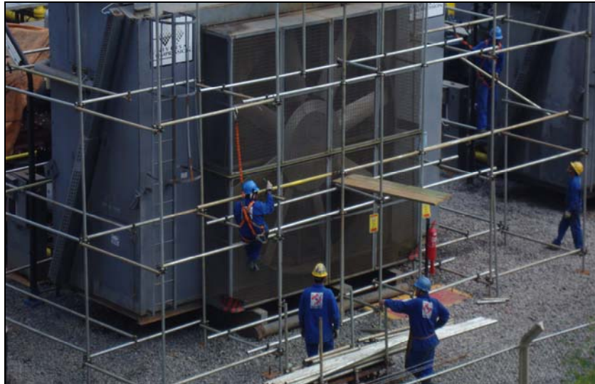
FOTO 7.1.7.2-2: Evidência de colaborador utilizando cinto de segurança para atividades realizadas em locais elevados, no km 200 do empreendimento, coordenadas em UTM: N=7.636.704/E=648.095 (Fonte: LENC, abr/10).
