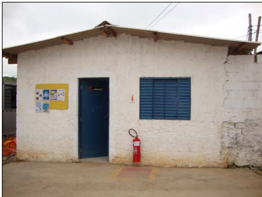
FOTO 6.1.1-93: Ambulatório, coordenadas em UTM N=7.519.877/E=627.938 (Fonte: Fonte: Lenc, mar/10).
