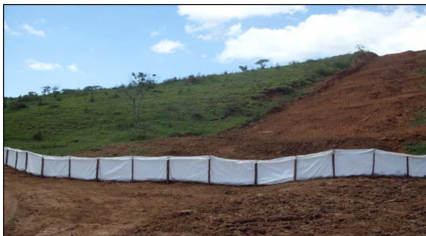
FOTO 6.2-40: Barreiras de contenção para evitar o carreamento de sedimentos sólidos, no km 164, coordenadas em UTM N= 7.607.098/ E= 655.843 (Fonte: Remma - Construcap, fev/10).
