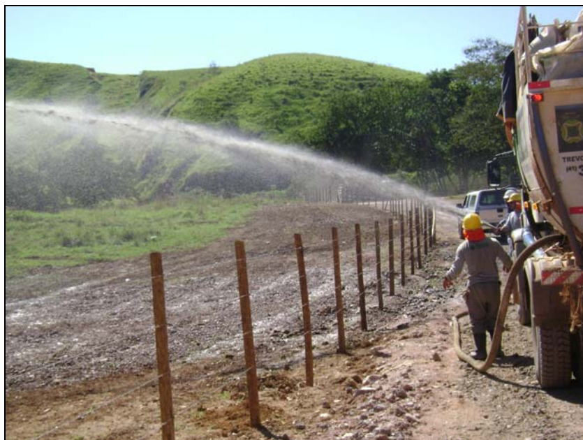
FOTO 6.3-75: Atividade de hidrossemeadura na faixa de servidão no km 111, coordenadas em UTM N= 7.558.141/E= 656.133 (Fonte: Lenc, mai/10).
