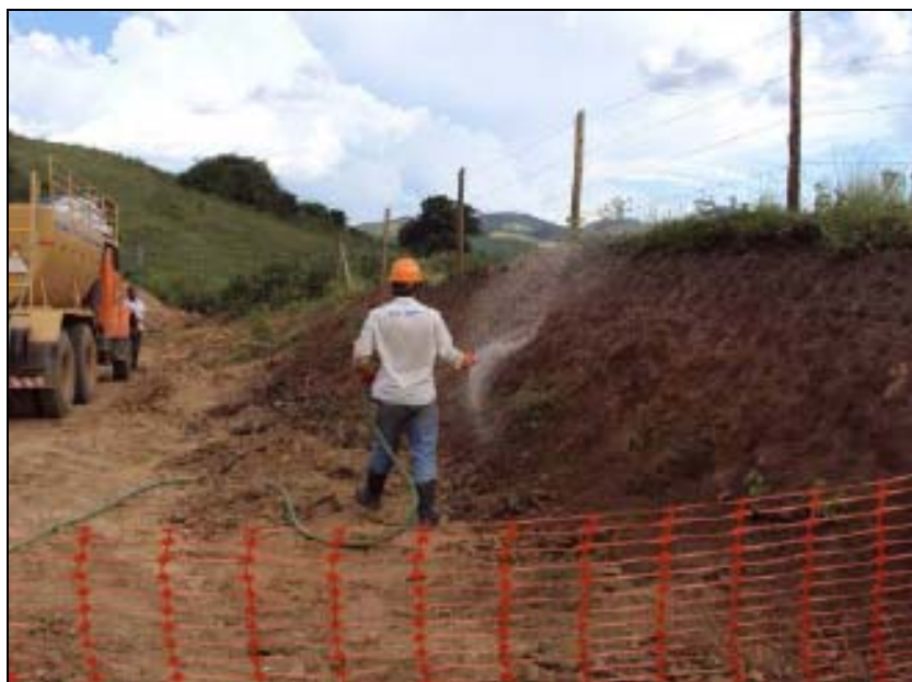
FOTO 6.2-10: Atividades de hidrossemeadura no talude de corte no km 48, coordenadas em UTM N= 7.522.855/E= 636.451 (Fonte: Remma - Azevedo Travassos, fev/10).
