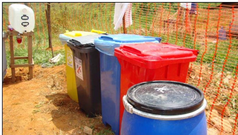
FOTO 6.4.3-45: Kit de coleta seletiva e ambiental localizado no canteiro no km 123, coordenadas em UTM N= 7.568.696 /E= 656.098 (Fonte: Lenc, fev/10).
