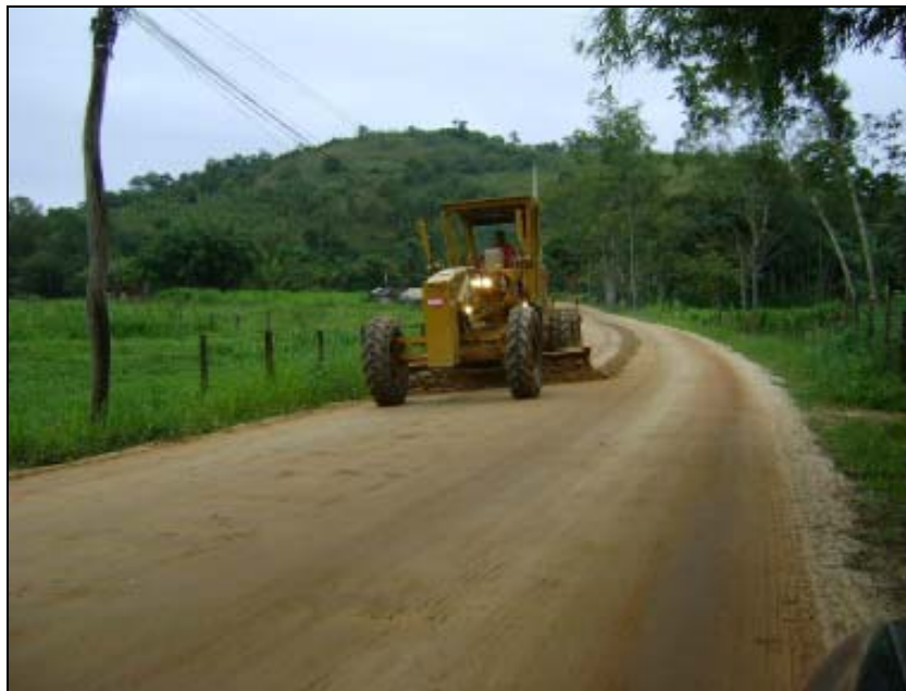
FOTO 6.3-105: Melhoria do acesso ao km 124 da faixa de servidão (comunidade de Fortaleza), coordenadas em UTM N= 7.569.619/E= 656.242 (Fonte: Remma – GDK, fev/10).
