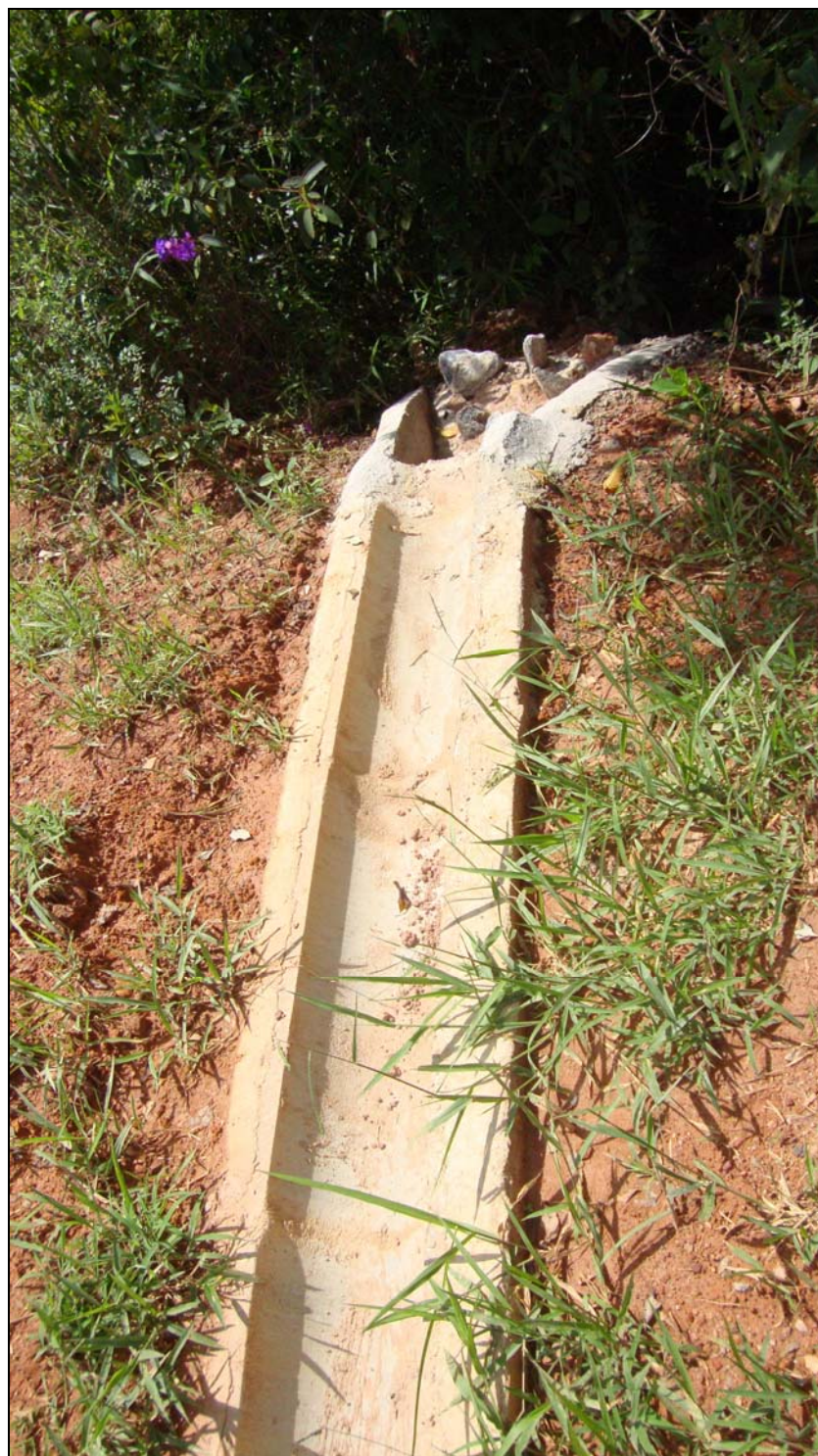
FOTO 6.3-34: Dispositivo definitivo de drenagem, canaletas de descida d'água no km 242, coordenadas em UTM N= 7.670.862/E= 625.295 (Fonte: Lenc, mar/10).
