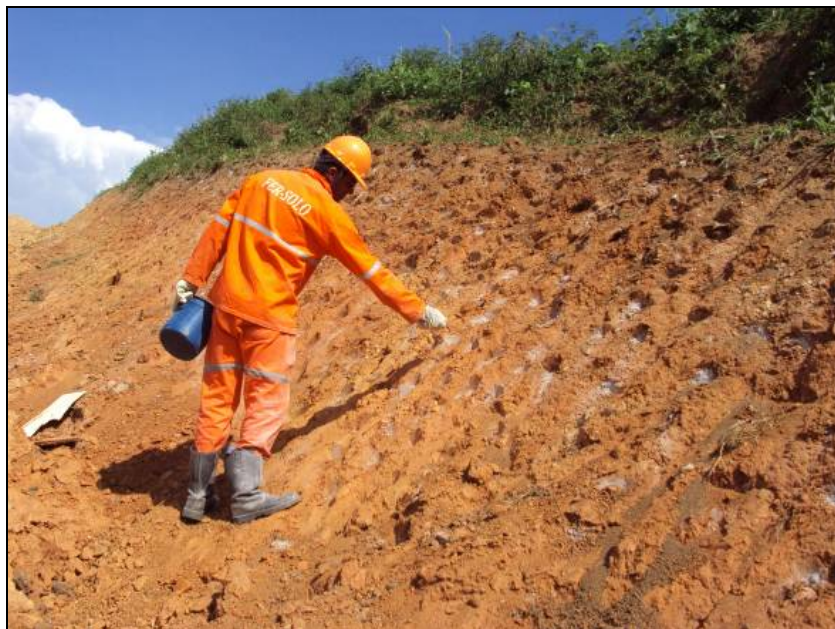
FOTO 6.3-44: Atividade de aplicação de semeadura manual no talude no km 7+000, coordenadas em UTM N= 7.506.302/E= 604.743 (Fonte: Remma Azevedo Travassos, Nov/09).
