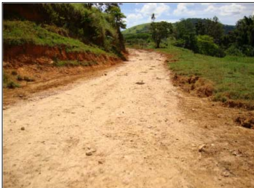
FOTO 6.3-99: Melhoria do acesso ao km 111 da faixa de servidão na Fazenda Independência, coordenadas em UTM N= 7.557.223/E= 655.101 (Fonte: Remma – Construcap, fev/10).
