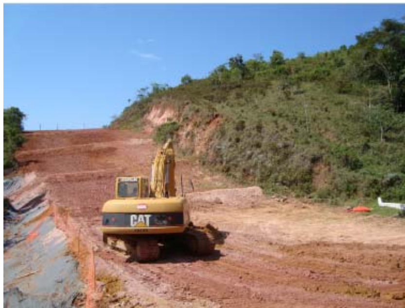
FOTO 6.2-124: Instalação de leiras no km 124+120, coordenadas em UTM N= 7.569.736/E= 656.270 (fonte: Remma - GDK, mar/10).
