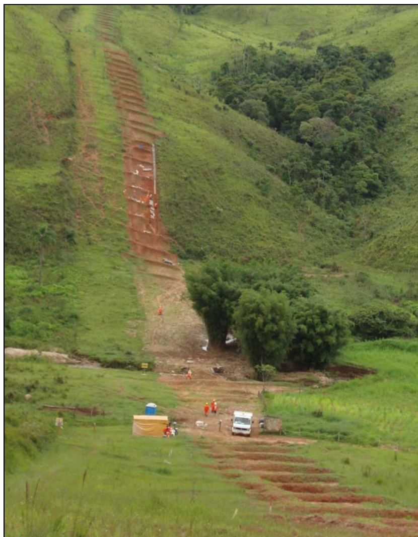
FOTO 6.2-107: Sistema de drenagem provisória (leiras transversais) no km 201+900, coordenadas em UTM: N= 7.638.341/E= 646.979 (Fonte: Lenc, nov/09).
