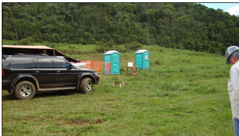
FOTO 6.4.4-22: Banheiros químicos no km 143, coordenadas em UTM N= 7.588.125/ E= 655.381 (Fonte: Lenc, fev/10).
