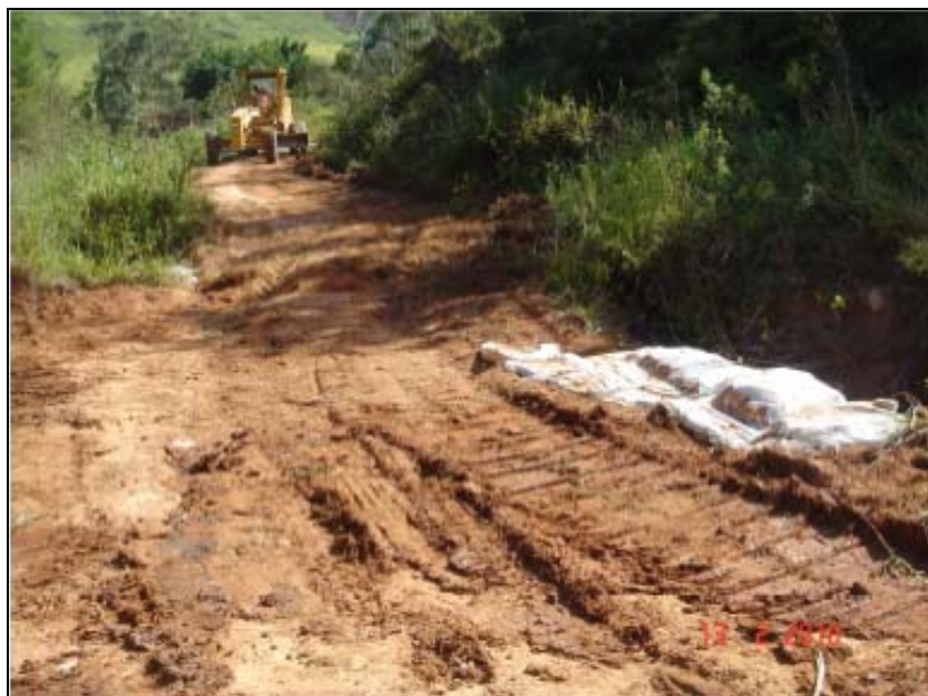
FOTO 6.3-109: Controle de aspectos ambientais no acesso ao km 128, coordenadas em UTM N= 7.573.401/E= 655.699(Fonte: Remma – GDK fev/10).
