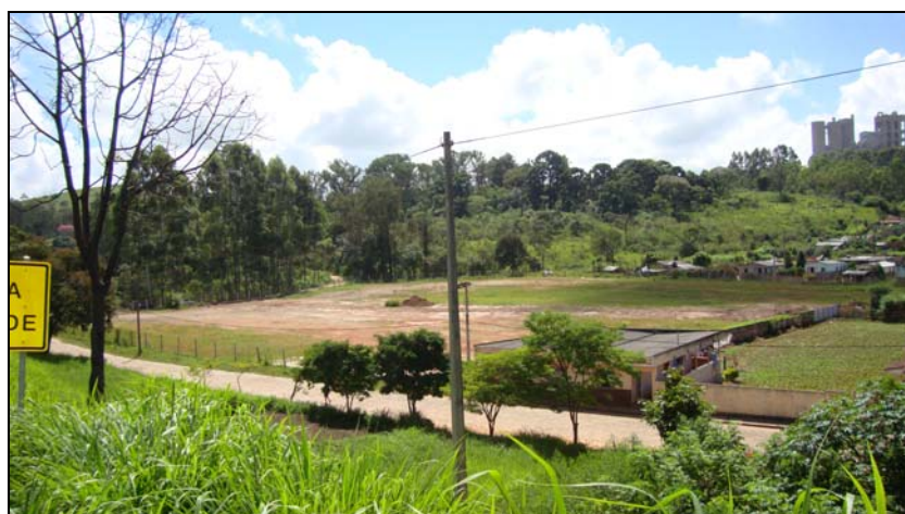
FOTO 6.1.1-2: Vista do Canteiro Pulmão de Tubos de Pedra do Sino após desmobilização, coordenadas em UTM N=7.688.225/E=621.993 (Fonte: Lenc, mar/10).
