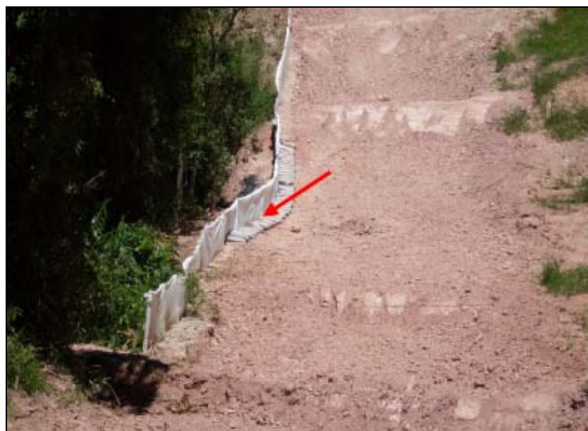
FOTO 6.2-46: Manutenção de barreira de contenção para conter carreamento de sedimentos sólidos, no km 108, coordenadas em UTM N= 7.554.526/E= 657.087(fonte: Remma - Construcap, mar/10).
