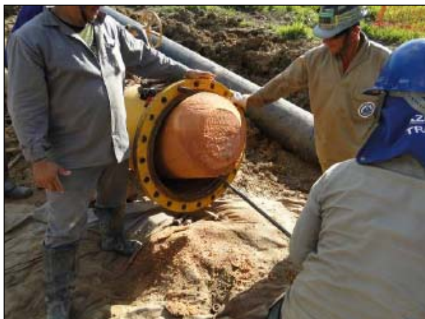
FOTO 6.1.2-61: Secagem da linha do duto no km 82, coordenadas em UTM N=7.542.219 / E= 658.271 (Fonte: Remma Azevedo & Travassos, mar/10).
