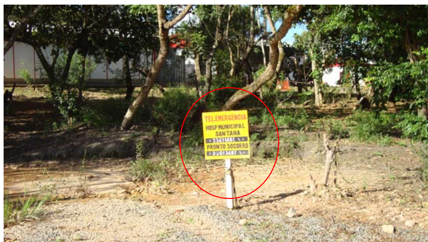
FOTO 6.1.1-9: Placa com telefone do hospital mais próximo, para situações de emergência, implantada no canteiro em local de fácil visibilidade, coordenadas em UTM N=7.688.225/E=621.993 (Fonte: Lenc, mar/10).
