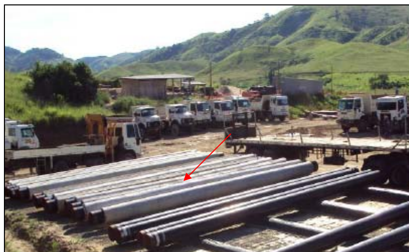
FOTO 6.1.2-33: Armazenamento temporário de tubos concretados, canteiro operacional de Andrade Pinto, Vassouras/RJ, coordenadas em UTM N= 7.536.965/ E=659.432 (Fonte: Remma Azevedo&Travassos, fev/09).
