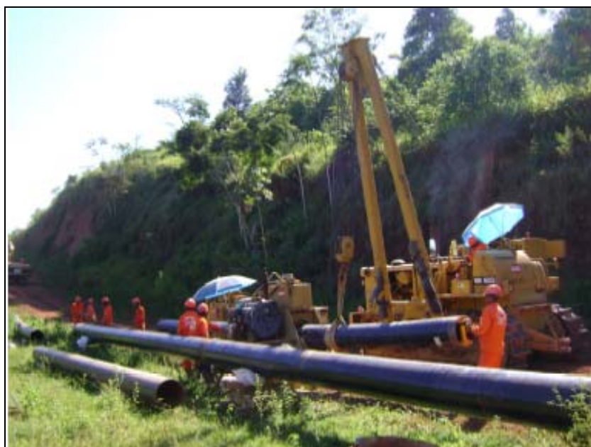
FOTO 6.1.2-38: Curvamento da tubulação no km 130, coordenadas em UTM N=7.575.357/ E=655.541(Fonte: Remma GDK, fev/10).
