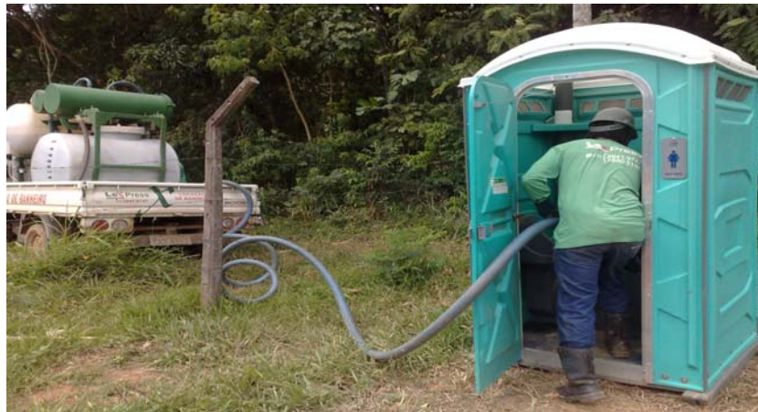
FOTO 6.4.4-20: Limpeza de banheiro químico localizado na faixa de servidão no km 100, coordenadas em UTM N= 7.546.883/E= 658.619 (Fonte: Remma- Construcap, jan/10).
