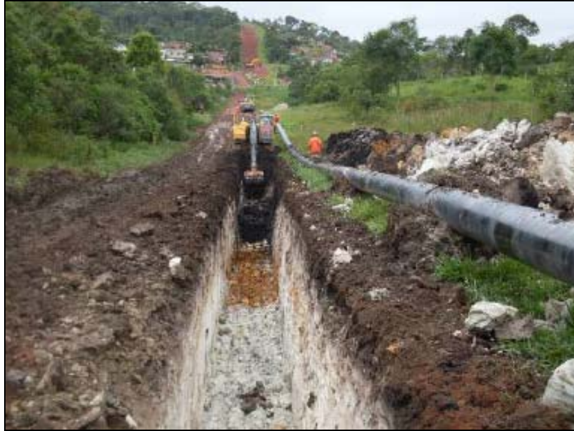
FOTO 5.2-3: Acompanhamento das atividades de abertura de vala no km 201+400m (Fonte: MAEA/UFJF, jan/10).
