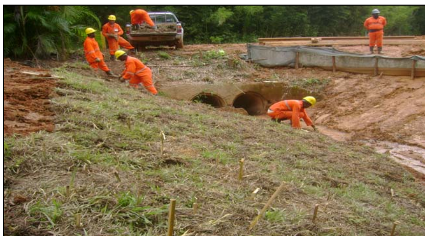
FOTO 6.3-49: Atividades de recomposição vegetal da faixa no km 100 – fixação de placas de grama em APP, coordenadas em UTM N= 7.546.883/E= 658.619 (Fonte: Remma – Construcap, jan/10).
