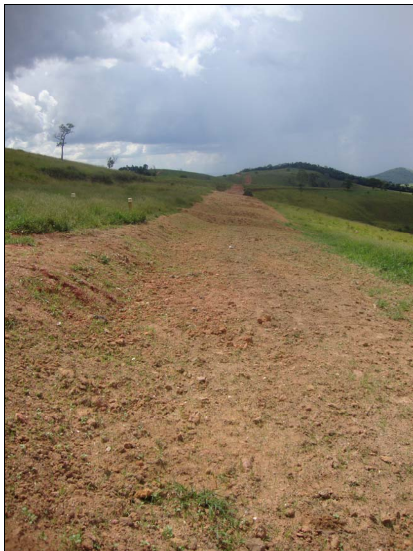
FOTO 6.2-68: Sistema de drenagem definitivo (leiras) e recomposição vegetal (hidrossemeadura) no km 267+520, em estágio inicial, coordenadas em UTM N= 7.694.391/E= 620.279 (Fonte: Lenc, mar/10).
