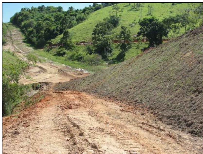
FOTO 6.2-8: Atividade de plantio de grama em placa na saia de aterro no km 81, coordenadas em UTM N= 7.541.308/E= 657.872 (Fonte: Remma - Azevedo Travassos, jan/10).
