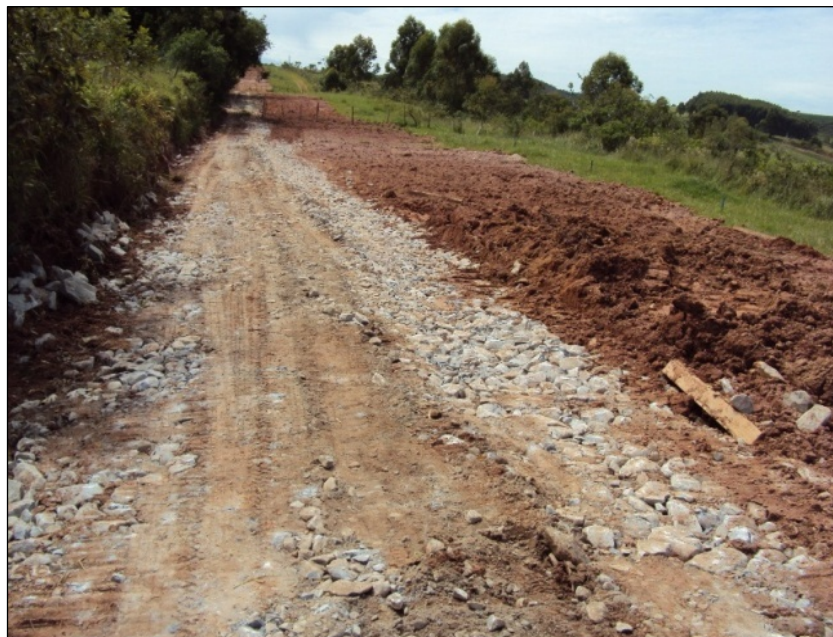
FOTO 6.3-97: Recuperação do acesso ao km 227, coordenadas em UTM N= 7.658.159/E= 632.579 (Fonte: Remma - Egesa, jan/10).
