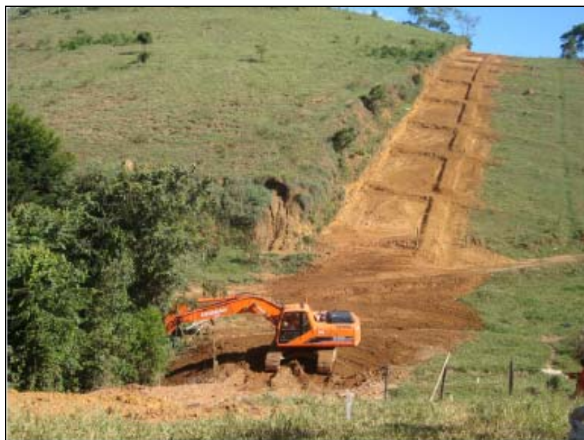
FOTO 6.3-21: Dispositivo de drenagem definitivo (leiras) no km 136, coordenadas em UTM N= 7.581.181 /E= 656.174 (Fonte: Remma – GDK, fev/10).
