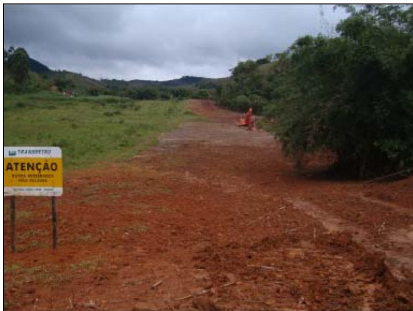
FOTO 6.3.11: Recomposição mecânica da faixa no km 139+630, coordenadas em UTM N= 7.584.537/E= 655.788 (Fonte: Remma - GDK, mar/10).
