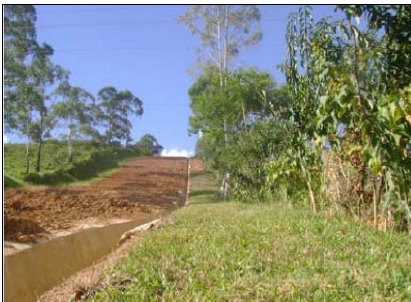
FOTO 6.3-19: Dispositivo de drenagem definitivo (canaletas) no km 153+960, coordenadas em UTM N= 7.597.687 /E= 655.916 (Fonte: Remma - Construcap, jan/10).
