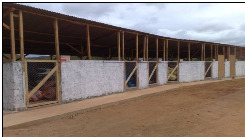
FOTO 6.4.3-21: Baía de acondicionamentos de resíduos, canteiro operacional de Rio das Flores/RJ, coordenadas em UTM N= 7.556.739/E= 648.673 (Fonte:Lenc, dez/09).
