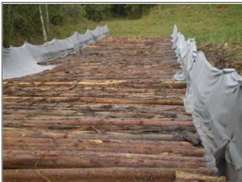
FOTO 6.2-84: Construção de estiva no km 101, coordenadas em UTM: N= 7.547730/E= 658.291(Fonte: Remma Construcap, nov/09).
