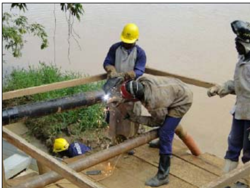
FOTO 6.1.2-58: Montagem de sistema de descarte no km 26, coordenadas em UTM N=7.509.948 / E= 621.018 (Fonte: Remma Azevedo & Travassos, mar/10).
