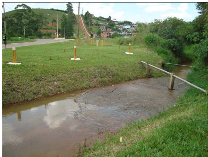
FOTO 6.3-52: APP recuperada (Córrego Igrejinha), coordenadas em UTM N= 7.598.327/ E= 656.158 (Fonte: Lenc, dez/09).
