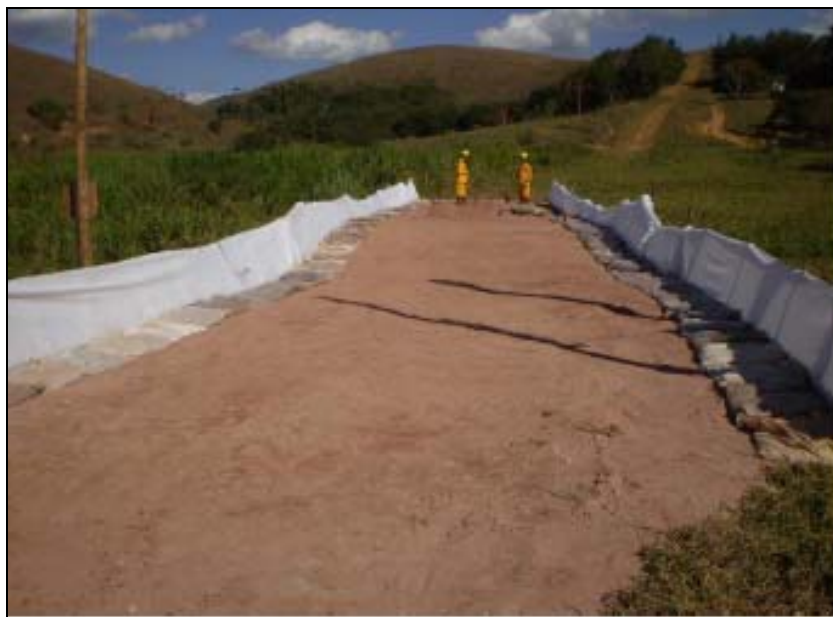
FOTO 6.2-86: Estiva para passagem de máquinas e equipamentos, no km 111, coordenadas em UTM: N= 7.557.213/E= 656.106 (Fonte: Remma Construcap, nov/09).
