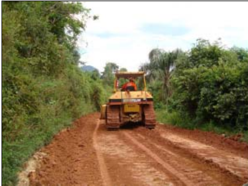
FOTO 6.1.1-127: Melhoria do acesso ao km 127, alargamento do acesso, coordenadas em UTM N=7.572.413/E=655.864 (Fonte: Remma GDK, mar/10).
