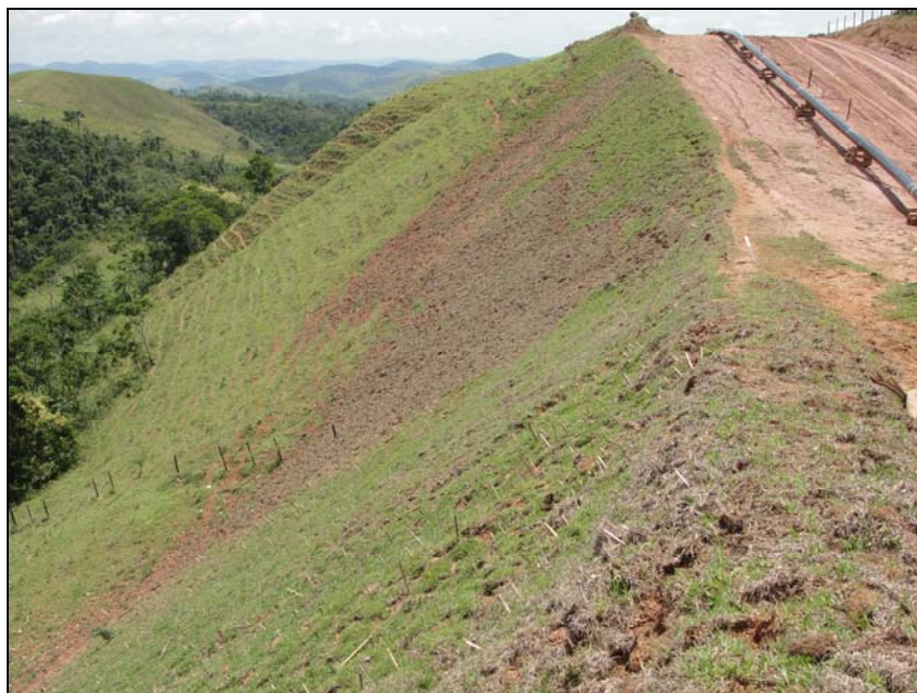
FOTO 6.2-3: Revegetação da saia do aterro com grama em placas, no km 43, coordenadas em UTM N= 7.520.026/E= 632.836 (Fonte: Remma Azevedo Travassos, nov/09).
