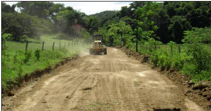
FOTO 6.1.1-128: Melhoria do acesso ao km 38, nivelamento de pista, coordenadas em UTM N=7.516.579/E=630.120 (Fonte: Remma Azevedo & Travassos, mar/10).
