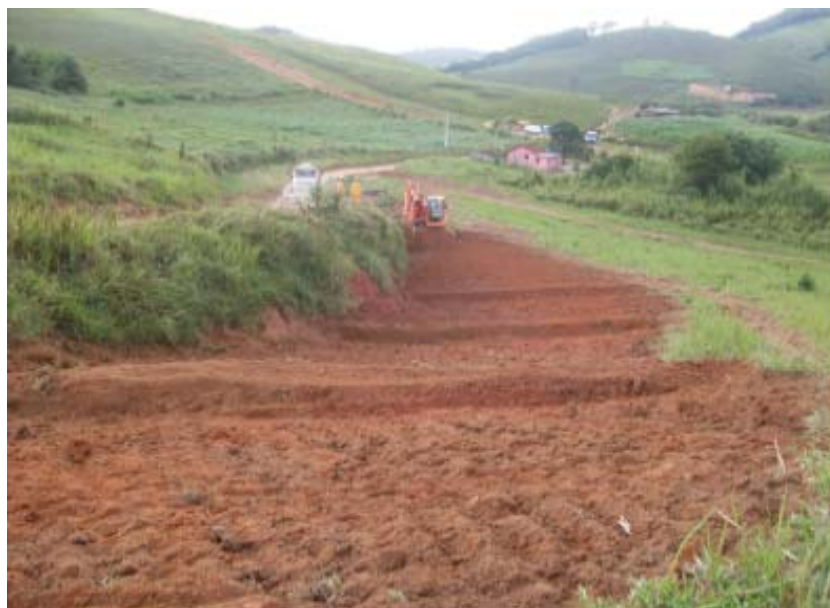
FOTO 6.3-123: Recuperação da área utilizada como bota-fora em Santos Dumont - MG, coordenadas em UTM N= 7.629.549/E= 648.424 (Fonte: Remma - Construcap, mar/10).
