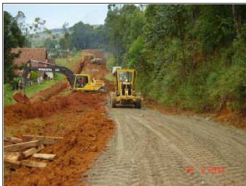
FOTO 6.3-112: Melhoria do acesso ao km 195 da faixa de servidão, coordenadas em UTM N= 7.635.215 /E= 648.166 (Fonte: Remma – Egesa, fev/10).
