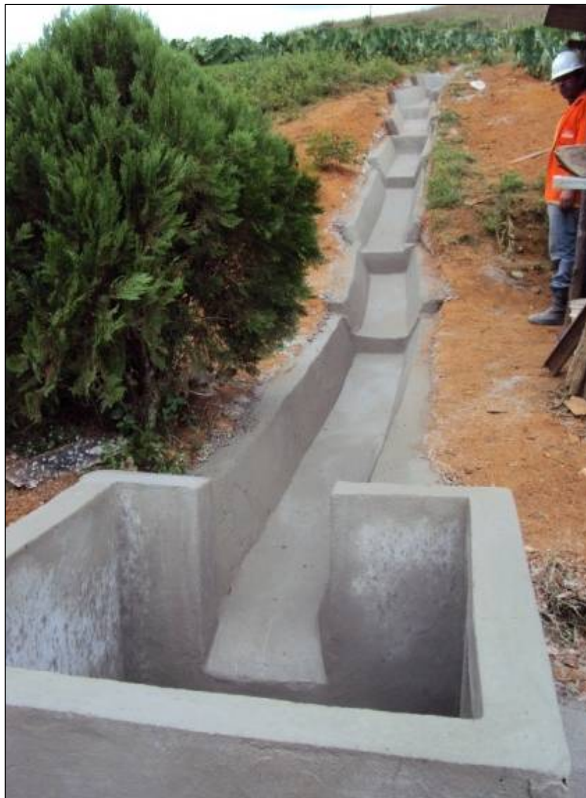
FOTO 6.3-27: Canaleta de direcionamento de águas pluviais no km 202+185, coordenadas em UTM N= 7.638.341/E= 646.979 (Fonte: Lenc, jan/10).
