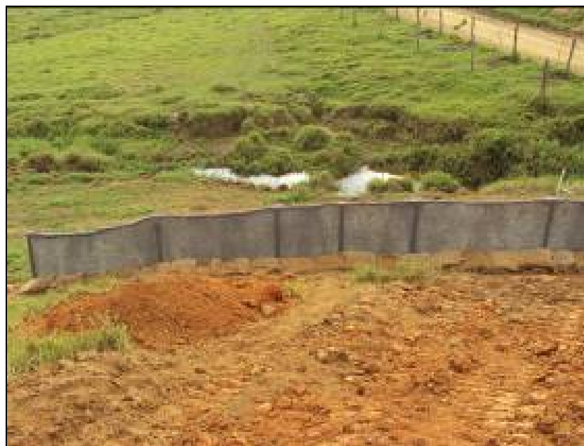
FOTO 6.2-53: Estruturas de contenção contra assoreamento de curso d'água com manta geotêxtil, no km 08, coordenadas em UTM N= 7.506.556/E= 605.959 (Fonte: Remma Azevedo Travassos, jul/09).
