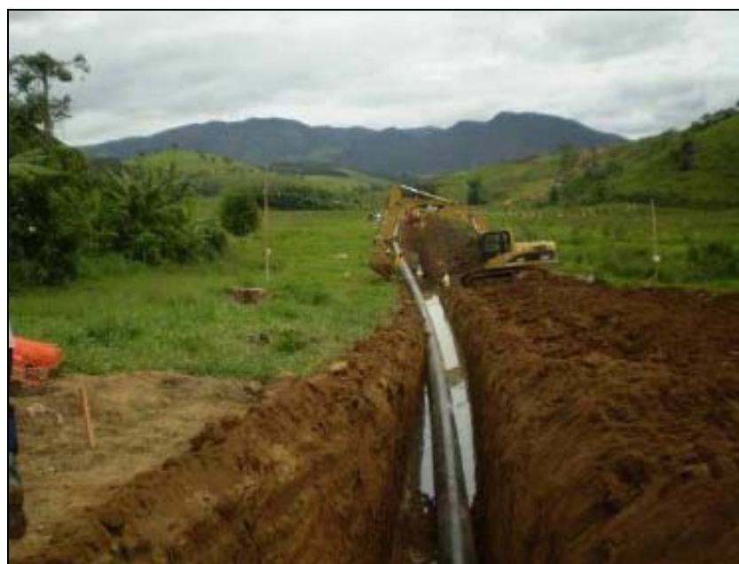
FOTO 5.2-7: Abaixamento de tubulação no km 100+150m (Fonte: MAEA/UFJF, fev/10).
