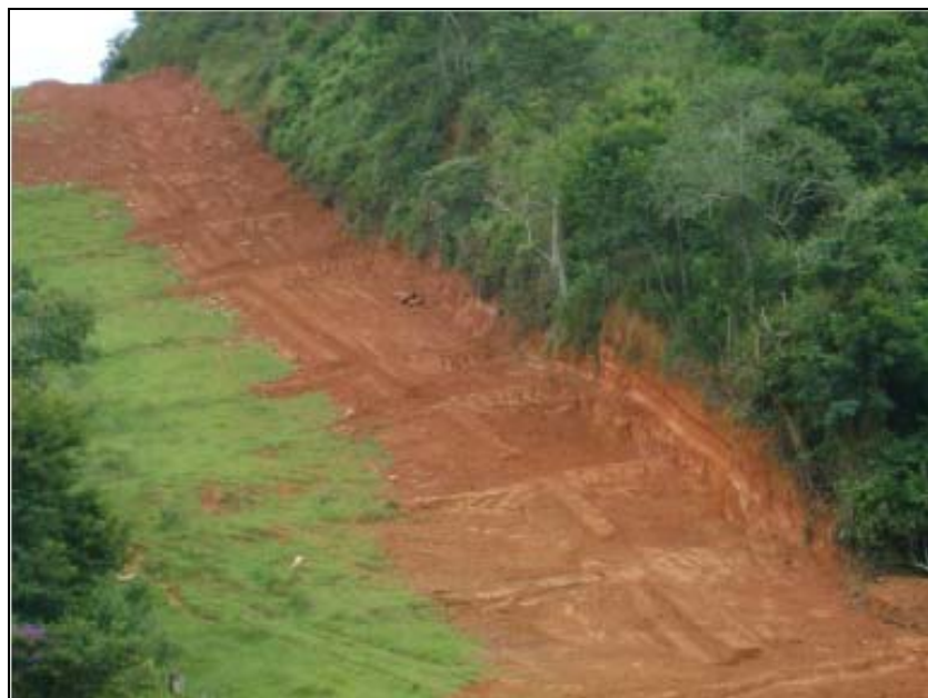
FOTO 6.3-22: Dispositivo de drenagem definitivo (leiras) no km 123, coordenadas em UTM N= 7.568.645 /E= 656.082 (Fonte: Remma - GDK, fev/10).
