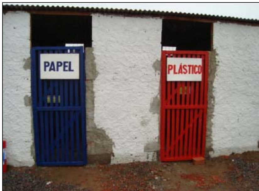
FOTO 6.4.3-41: Baias de acondicionamento de resíduos no canteiro de obras de Juiz de Fora/MG (Fonte: Remma – GDK, fev/10).
