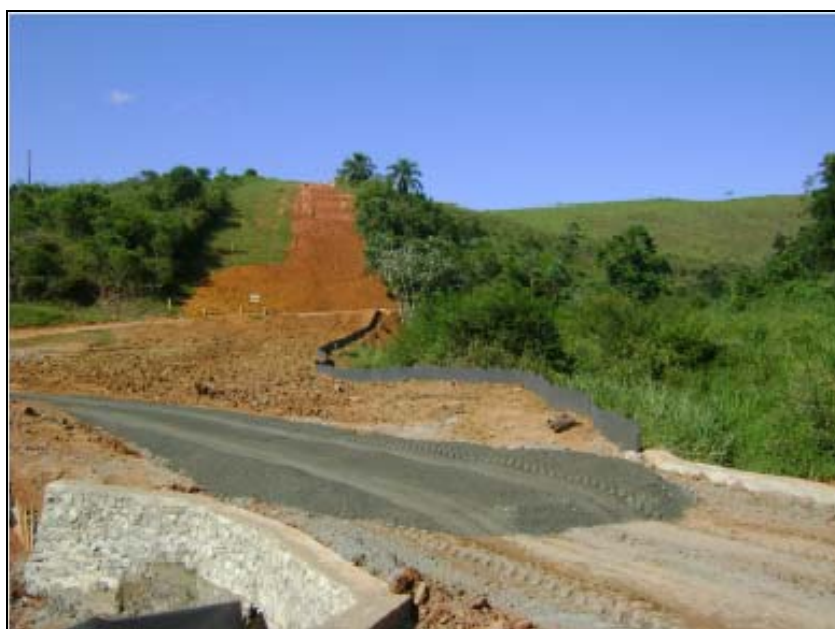
FOTO 6.3-118: Melhoria do acesso ao km 131 da faixa de servidão, coordenadas em UTM N= 7.576.276/E= 655.909(Fonte: Remma – Gdk, mar/10)
