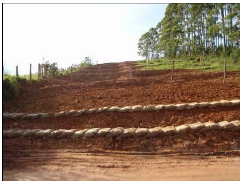
FOTO 6.2-34: Barreiras de contenção com sacos de aniagem no km 257+755, coordenadas em UTM N= 7.685.579/E= 621.619 (Fonte: Remma - Egesa, jan/10).
