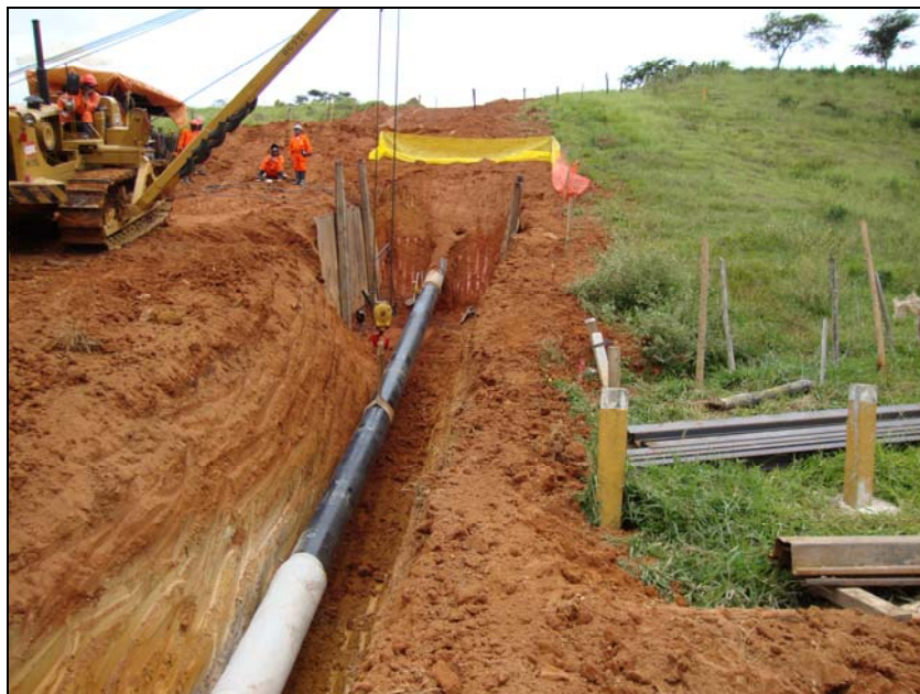
FOTO 6.1.2-49: Abaixamento de coluna soldada km 123+600, coordenadas em UTM N=7.569.334 / E=656.142 (Fonte: Lenc, fev/10).
