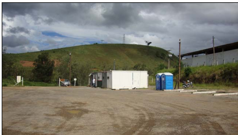
FOTO 6.1.1-36: Escritórios de apoio (containers) e banheiros químicos, coordenadas em UTM N=7.628.775/E=649.474 (Fonte: Lenc, abr/10).
