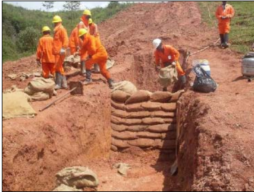
FOTO 5.2-8: Construção de dique no km 243 (Fonte: MAEA/UFJF, fev/10).
