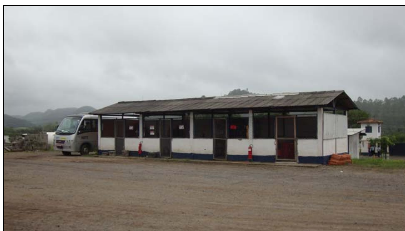
FOTO 6.1.1-109: Baias de armazenamento de produtos inflamáveis, coordenadas em UTM N=7.512.069/E=601.305 (Fonte: Lenc, mar/10).
