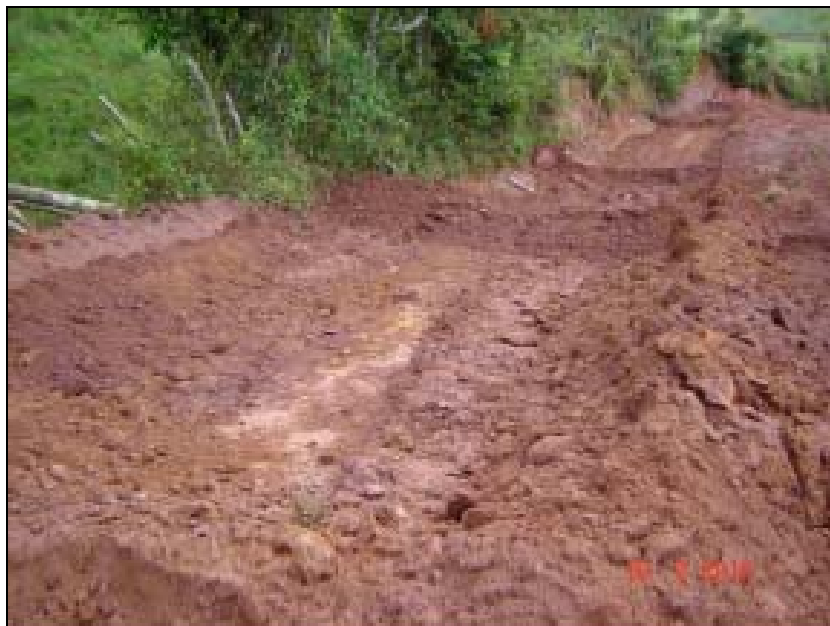
FOTO 6.2-122: Dispositivo de drenagem provisória (leiras), no km 191 (fonte: Remma - Egesa, fev/10).
