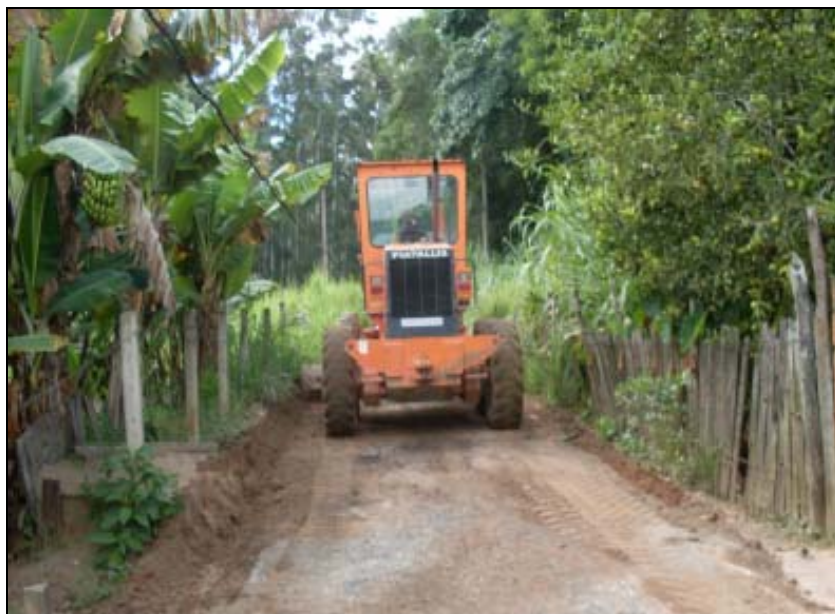
FOTO 6.3-103: Melhoria do acesso ao km 168 da faixa de servidão, coordenadas em UTM N= 7.610.672/E= 654.533 (Fonte: Remma – Construcap, fev/10).
