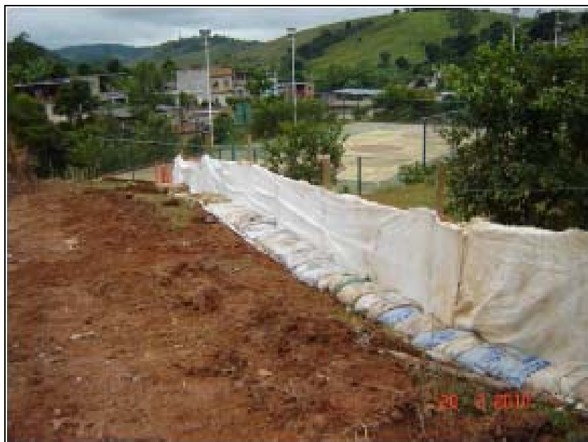
FOTO 6.2-42: Barreira de contenção com bidim para evitar o carreamento de sedimentos sólidos, no km 187(fonte: Remma - Egesa, fev/10).
