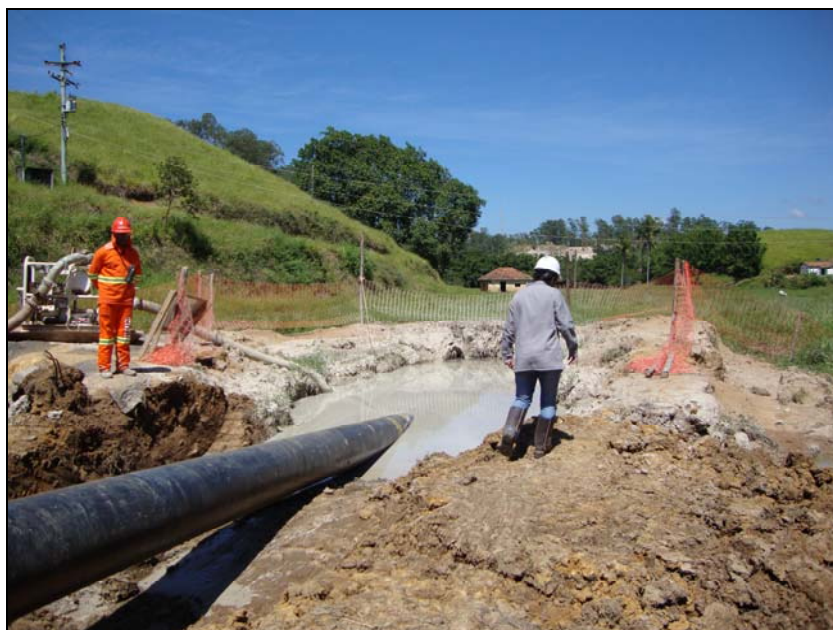
FOTO 6.1.3-1: Realização de travessia por método de furo direcional no km 27 do empreendimento, coordenadas em UTM: N=7.510.193/E=622.697 (Fonte: LENC, fev/10).
