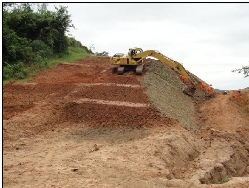
FOTO 6.2-7: Atividade de plantio de grama em placas na saia de aterro no km 81, coordenadas em UTM N= 7.541.308/E= 657.872 (Fonte: Remma - Azevedo Travassos, jan/10).
