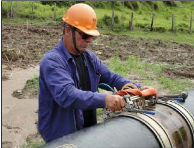
FOTO 6.1.2-44: Atividade de ultrassom, km 64+780, coordenadas em UTM N=7.530.369/ E=649.635 (Fonte: Remma Azevedo & Travassos, mar/10).
