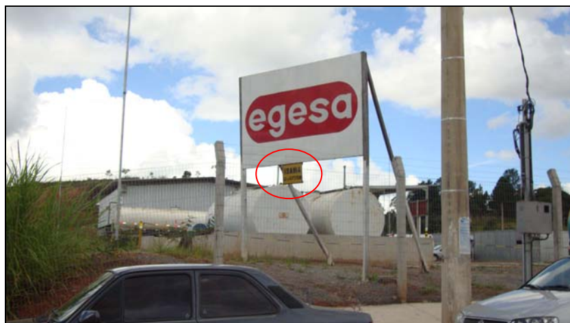
FOTO 6.1.1-24: Placa contendo órgão licenciador e nº da LI, coordenadas em UTM N=7.652.927/E=630.639 (Fonte: Lenc, mar/10).
