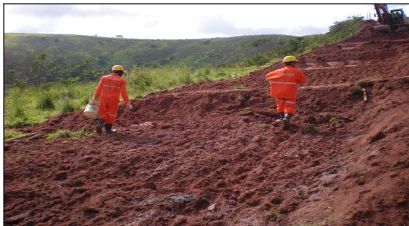
FOTO 6.3-48: Atividades de semeadura manual no km 101, coordenadas em UTM N= 7.547.730/E= 658.291 (Fonte: Remma - Construcap, dez/09).
