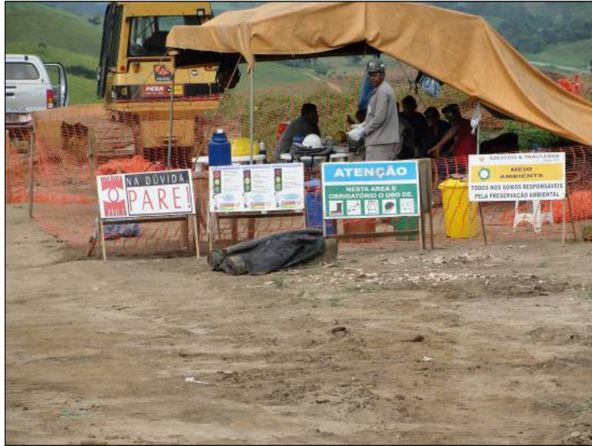
FOTO 7.1.3-2: Sinalização para os colaboradores na área de vivência no km 75 do empreendimento, coordenadas em UTM: N= 7.535.840/ E= 657.538 (Fonte: REMMA Azevedo & Travassos, jan/10).
