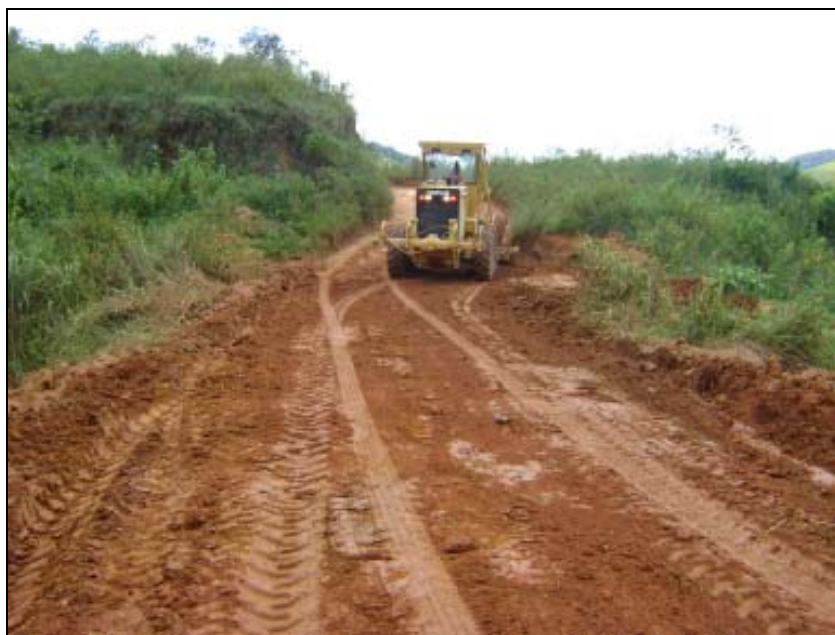
FOTO 6.3-117: Melhoria do acesso ao km 130 da faixa de servidão, coordenadas em UTM N= 7.575.357/E= 655.541(Fonte: Remma – Gdk, mar/10).
