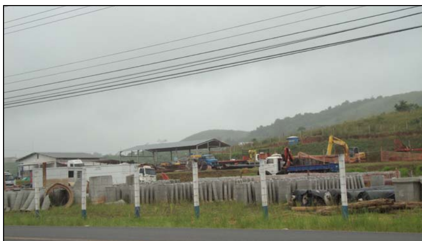
FOTO 6.1.1-98: Vista do canteiro a partir da outra margem da rodovia, coordenadas em UTM N=7.512.069/E=601.305 (Fonte: Lenc, mar/10).
