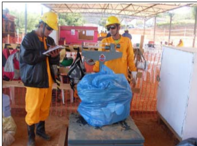
FOTO 6.4.3-8: Kit de coleta seletiva no canteiro operacional de Rio das Flores - RJ, coordenadas em UTM N=7.556.630/E=648.601 ( Fonte: Remma – Construcap, nov/09).
