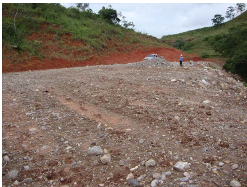
FOTO 6.1.2-9: Área designada para bota-fora (12A), em utilização, coordenadas em UTM N=7.510.554 / E=621.353 (Fonte: Lenc, mar/10).
