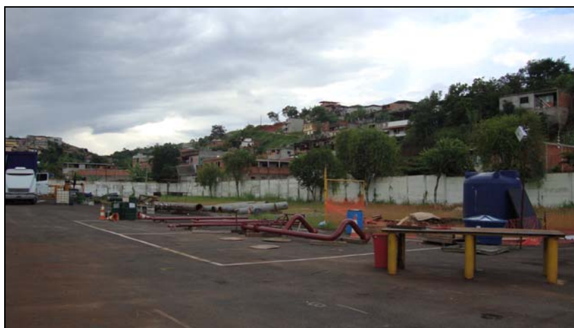
FOTO 6.1.1-60: Área externa do canteiro, coordenadas em UTM N=7.599.026/E=662.201 (Fonte: Lenc, abr/10).
