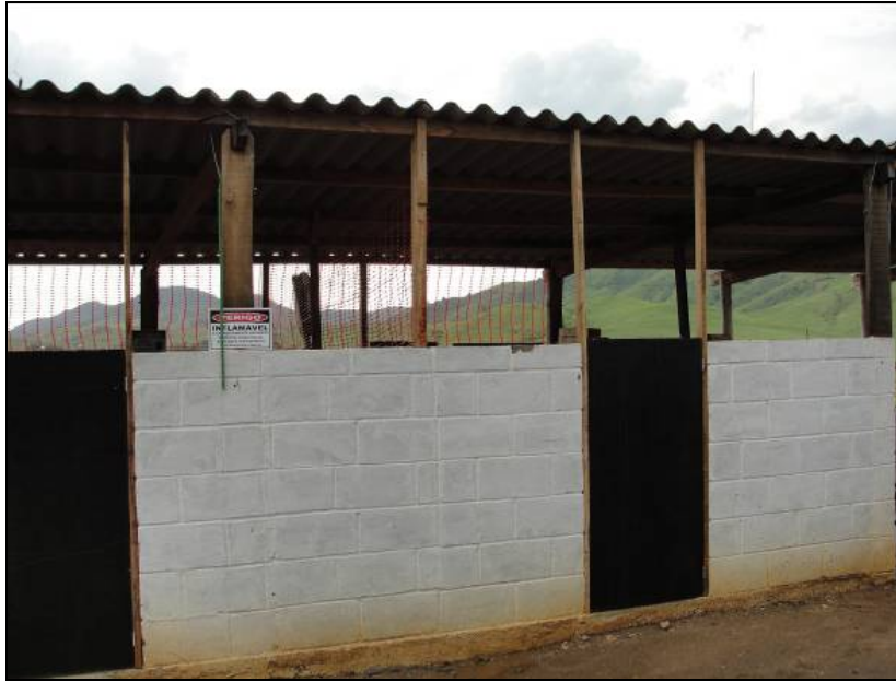
FOTO 6.4.3-1: Baía de armazenamento de resíduos inflamáveis no Canteiro de apoio de Andrade Pinto, município de Vassouras-RJ, coordenadas em UTM N= 7.536.965/E= 659.432 ( Fonte: Remma Azevedo Travassos, Out/09).
