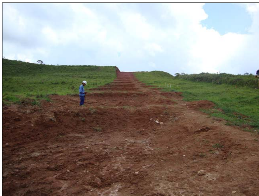
FOTO 6.2-106: Sistema de drenagem provisória (leiras transversais) no km 201+900, coordenadas em UTM: N= 7.638.341/E= 646.979 (Fonte: Lenc, nov/09).
