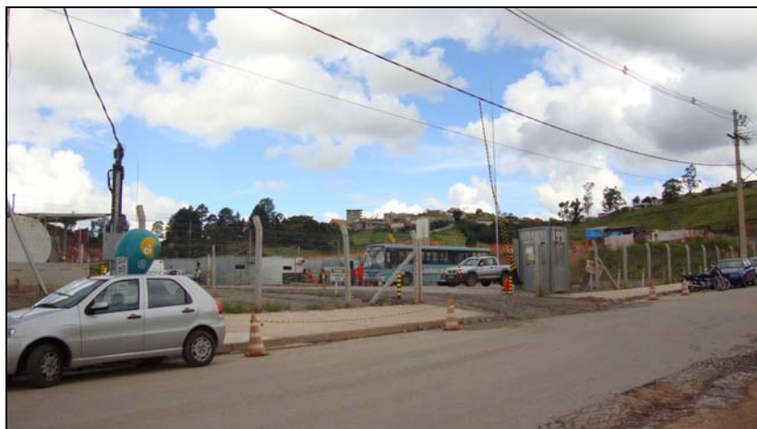
FOTO 6.1.1-23: Vista da entrada do canteiro de Barbacena/MG, coordenadas em UTM N=7.652.927/E=630.639 (Fonte: Lenc, mar/10).
