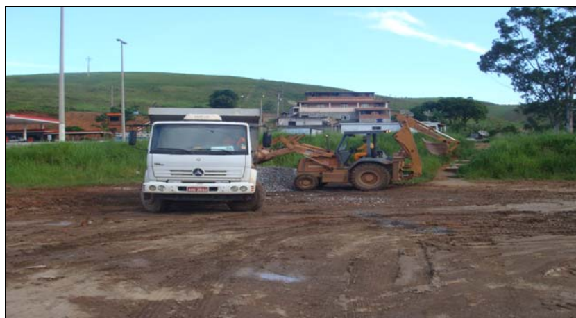
FOTO 6.3-88: Melhoria do acesso ao km 155 da faixa de servidão, coordenadas em UTM N= 7.598.614/E= 656.196 (Fonte: Remma – Construcap, dez/09).
