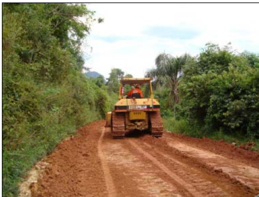
FOTO 6.3-116: Melhoria do acesso ao km 127 da faixa de servidão, coordenadas em UTM N= 7.572.413/E= 655.864(Fonte: Remma – Gdk, mar/10).
