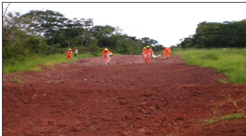
FOTO 6.3-50: Atividades de recomposição vegetal da faixa no km 105 – semeadura manual, coordenadas em UTM N= 7.551.610/E= 657.541(Fonte: Remma – Construcap, jan/10).
