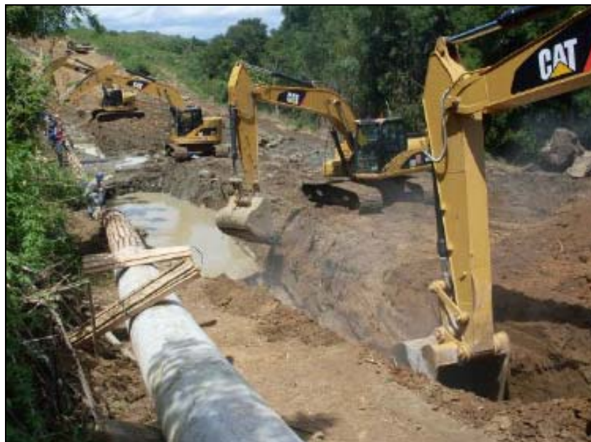
FOTO 5.2-6: Atividade de abertura de vala no km 70 (Fonte: MAEA/UFJF, fev/10).
