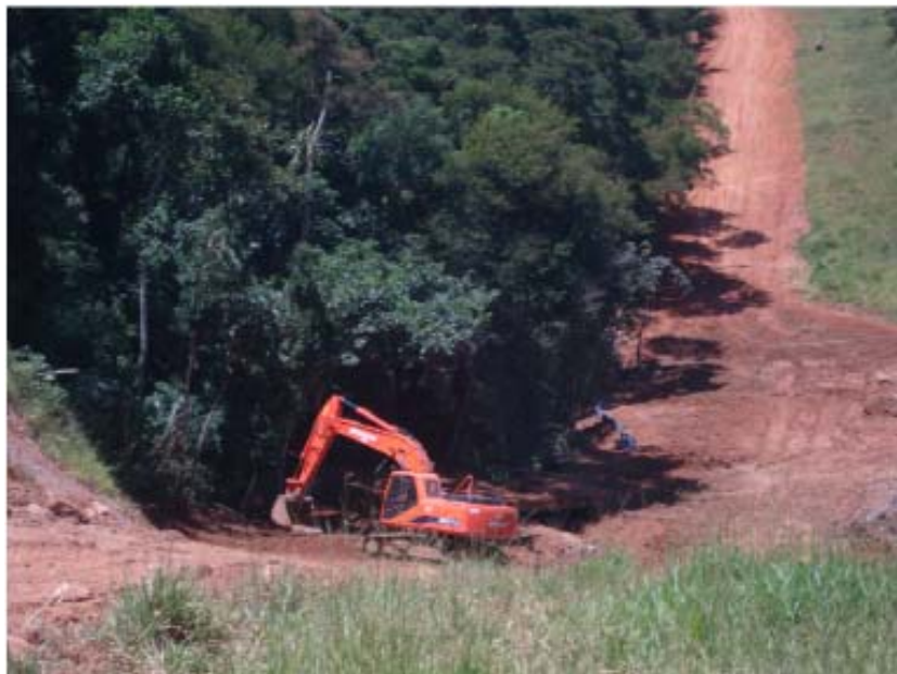
FOTO 6.3-3: Reposição do solo superficial no km 137+300, coordenadas em UTM N= 7.581.962/E= 656.018 (Fonte: Remma - GDK, fev/10).
