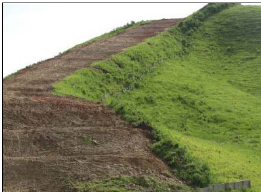
FOTO 6.2-108: Sistema de drenagem provisória (leiras transversais) no km 07, coordenadas em UTM: N= 7.506.302 /E= 604.743 (Fonte: Remma – Azevedo Travassos, dez/09).
