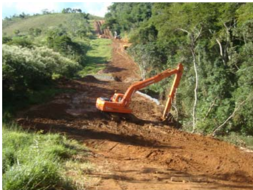
FOTO 6.3-5: Reposição do solo superficial no km 137+100, coordenadas em UTM N= 7.582.051/E= 655.982 (Fonte: Remma - GDK, fev/10).
