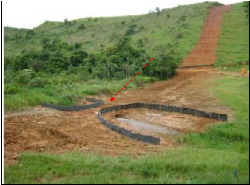
FOTO6.1.2-4: Raspagem do solo superficial apenas na largura correspondente ao percurso da vala (seta), em terras cultivadas ou úmidas, km 132, coordenadas em UTM N= 7.577.083/E=656.288 (Fonte: Remma GDK, mar/10).
