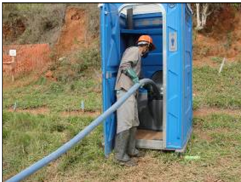
FOTO 6.4.4-4: Controle de efluente sanitário (limpeza de banheiro químico) no km 84, coordenadas em UTM N=7.544.022/E=658.908 (Fonte: Remma – Azevedo Travassos, out/09).
