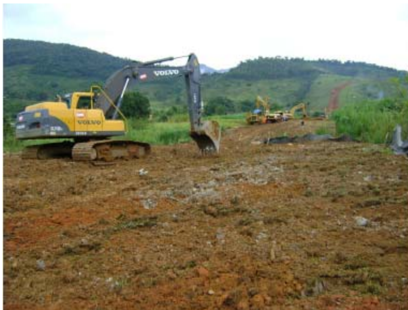
FOTO 6.3-7: Reposição do solo superficial no km 125, coordenadas em UTM N= 7.570.568/E= 656.476 (Fonte: Remma - GDK, fev/10).
