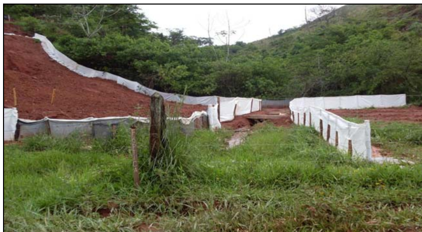
FOTO 6.2-58: Barreira de contenção com o objetivo de evitar o carregamento de sedimentos sólidos para o curso d'água, no km 109, coordenadas em UTM N= 7.555.500/E= 656.946 (Fonte: Remma Construcap, nov/09).
