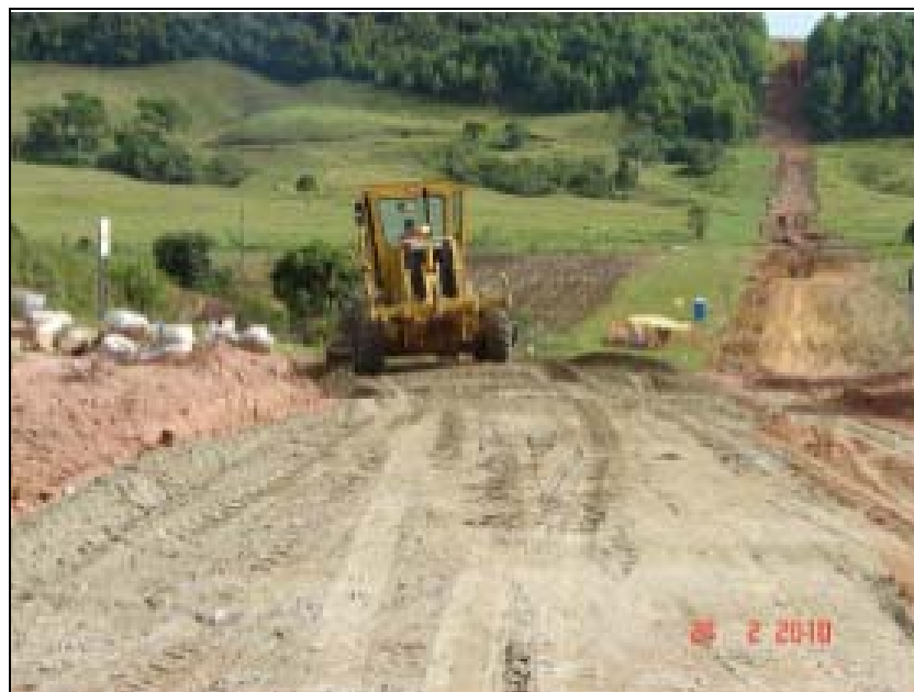
FOTO 6.3-111: Melhoria do acesso ao km 192 da faixa de servidão, coordenadas em UTM N= 7.631.725 /E= 648.339 (Fonte: Remma – Egesa, fev/10).
