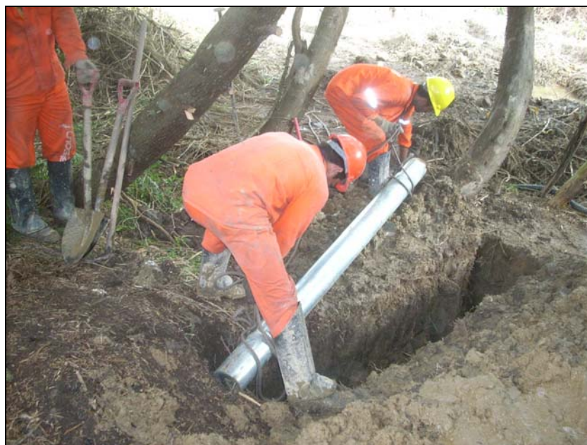
FOTO 6.1.2-62: Instalação de leitos de anodos, km 260, coordenadas em UTM N= 7.687.420/ E=621.487 (Fonte: Petrobrás, mar/10).
