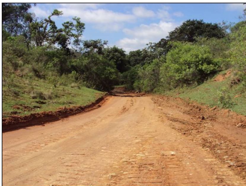
FOTO 6.3-119: Acesso ao bota-fora localizado na fazenda São Felix, município de Barra do Pirai-RJ, coordenadas em UTM N= 7.510.316/E= 621.400 (Fonte: Remma Azevedo Travassos, set/09).
