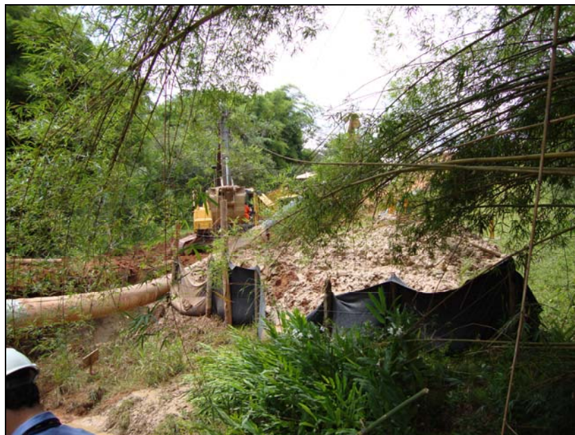
FOTO 6.1.3-38: Dispositivo instalado na margem de curso d'água para contenção de sedimentos na realização da travessia do Gasoduto, coordenadas em UTM N= 7.707.296/E= 614.769 (Fonte: LENC, jan/10).
