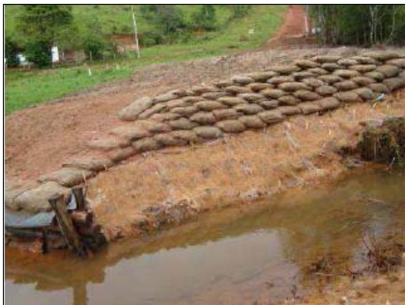
FOTO 6.3-47: Recomposição com rip-rap e revegetação das margens do curso d'água com semeadura no solo e nas sacarias, no km 245+078, coordenadas em UTM N= 7.673.094 /E= 624.004 (Fonte: Egesa, nov/09).
