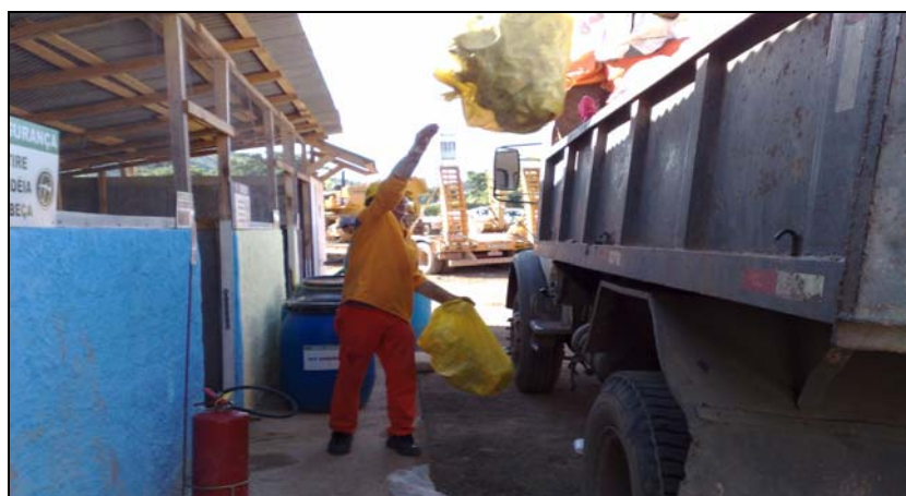
FOTO 6.4.3-24: Recolhimentos de resíduos no canteiro operacional de Juiz de Fora/MG, coordenadas em UTM N= 7.599.146/E= 661.818 (Fonte: Remma – Construcap, jan/10).
