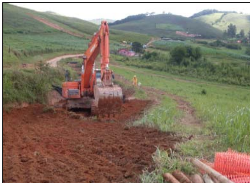
FOTO 6.1.2-30: Área designada para bota-fora (32), durante atividades de recuperação da área, coordenadas em UTM N=7.629.549/E=648.424 (Fonte: Construcap, mar/10).
