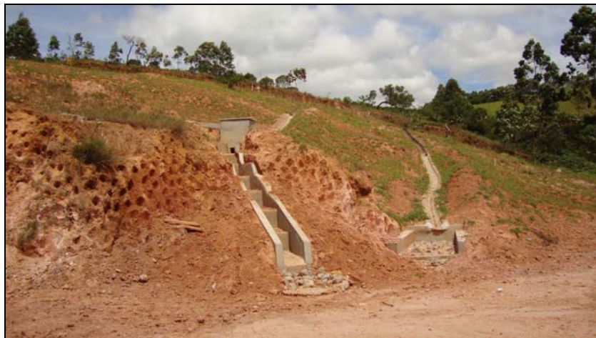
FOTO 6.3-33: Dispositivo definitivo de drenagem, escada e canaleta de descida d'água no km 242, coordenadas em UTM N= 7.670.862/E= 625.295 (Fonte: Lenc, mar/10).
