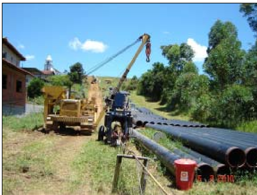
FOTO 6.1.2-37: Curvamento e depósito de tubos próximo ao km 194, coordenadas em UTM N= 7.634.164/ E=648.193 (Fonte: Remma Egesa, fev/10).
