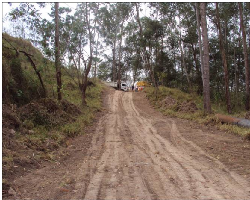
FOTO 6.1.2-10: Área designada para bota-fora (12B), no início da utilização, coordenadas em UTM N=7.510.141 / E=621.915 (Fonte: Remma Azevedo&Travassos, mar/10).
