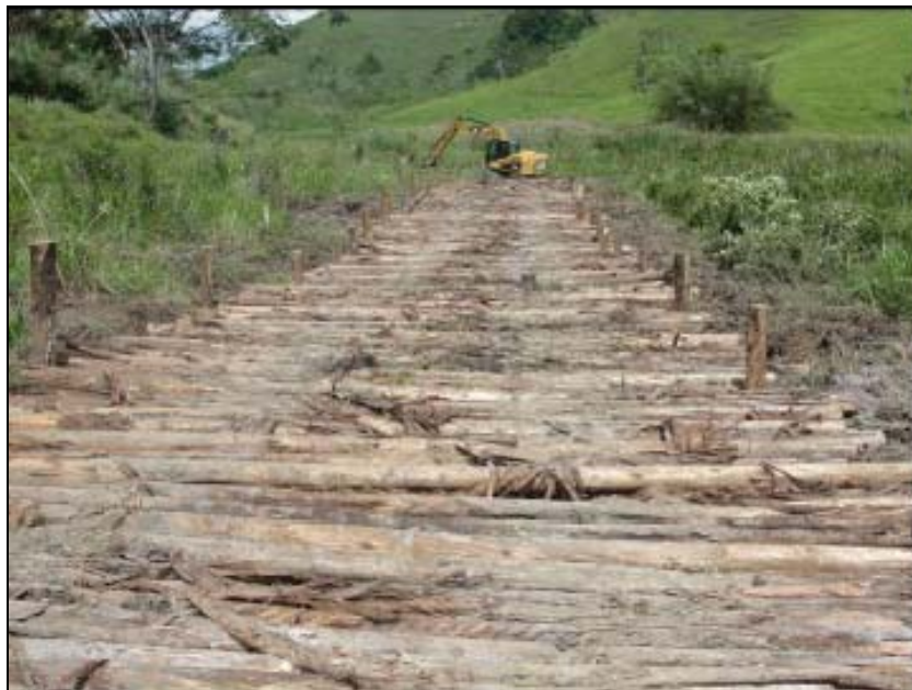
FOTO 6.2-90: Construção de estiva para passagem de máquinas e equipamentos, no km 65+460, coordenadas em UTM: N= 7.530.633 /E= 650.216 (Fonte: Remma – Azevedo Travassos, dez/09).
