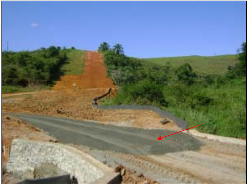
FOTO 6.1.1-130: Melhoria do acesso ao km 131, execução de colchão de pedrisco, coordenadas em UTM N=7.576.276/E=655.909. (Fonte: Remma GDK, mar/10).
