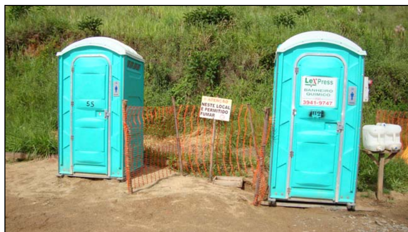
FOTO 6.4.4-17: Banheiro químico localizado na frente de obra, atividades de furo direcional no Rio do Peixe, km 134+700, coordenadas em UTM N= 7.598.319/E=656.161(Fonte: Lenc, jan/10).
