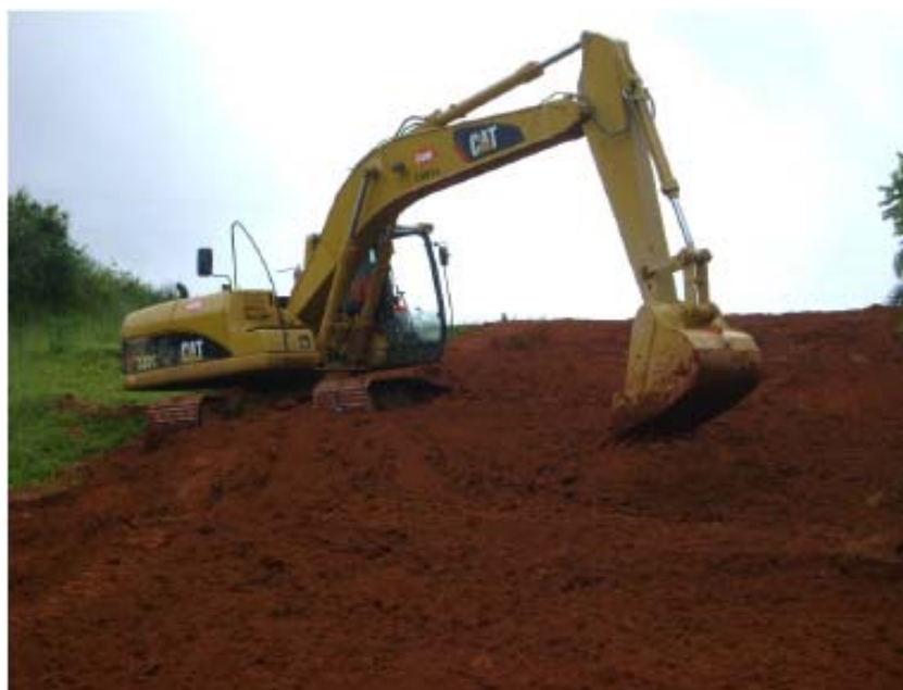
FOTO 6.3-10: Recomposição mecânica da faixa no km 131, coordenadas em UTM N= 7.576.276/E= 655.909 (Fonte: Remma - GDK, mar/10).
