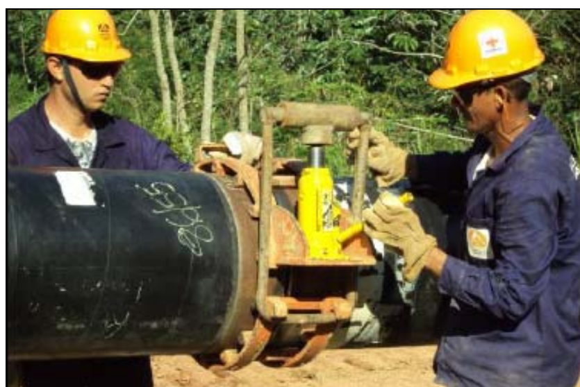
FOTO 6.1.2-39: Acoplamento da tubulação antecedendo a fase de solda, coordenadas em UTM N=7.545.961/ E=658.765 (Fonte: Remma Azevedo & Travassos, mar/10).
