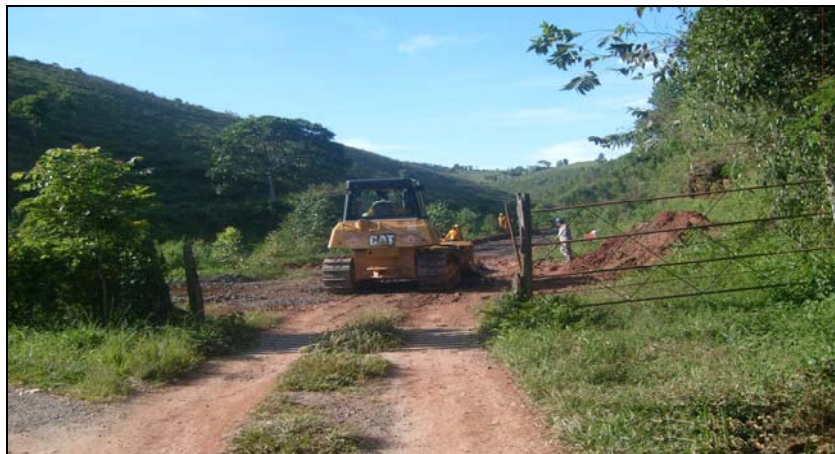
FOTO 6.3-93: Melhoria do acesso ao km 178 da faixa de servidão, coordenadas em UTM N= 7.619.463/E= 651.577 (Fonte: Remma – Construcap, dez/09).
