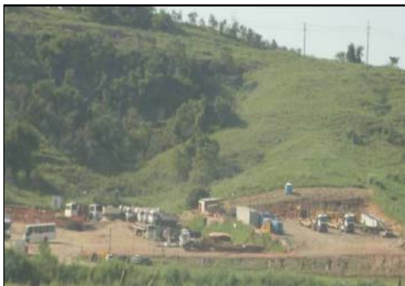
FOTO 6.1.1-71: Vista panorâmica do canteiro de Andrade Pinto, coordenadas em UTM N=7.536.965/E=659.432 (Fonte: Remma Azevedo & Travassos, fev/10).
