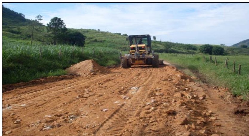
FOTO 6.3-95: Melhoria do acesso ao km 120 da faixa de servidão, coordenadas em UTM N= 7.565.854/E= 655.122 (Fonte: Remma – Construcap, jan/10).
