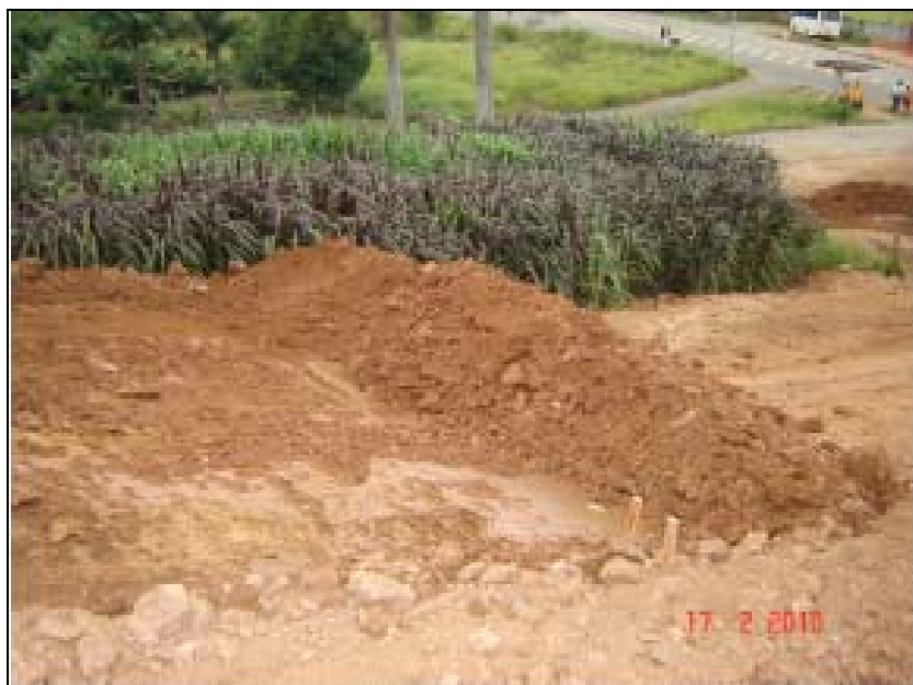
FOTO 6.2-121: Dispositivo de drenagem provisória (leiras) no km 186, coordenadas em UTM N= 7.626.348/E= 647.443 (fonte: Remma - Egesa, fev/10).
