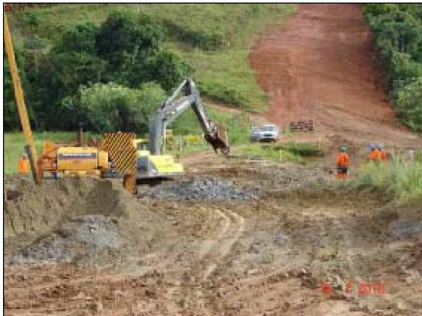
FOTO 6.3-113: Melhoria do acesso à estrada municipal do Pinho, coordenadas em UTM N= 7.629.670 /E= 648.346 (Fonte: Remma – Egesa, fev/10).
