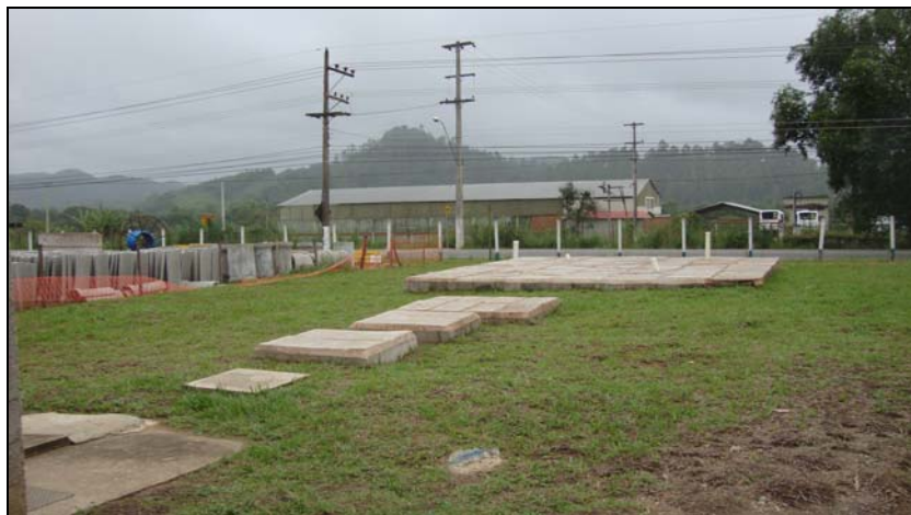
FOTO 6.1.1-105: Fossas-sépticas, coordenadas em UTM N=7.512.069/E=601.305 (Fonte: Lenc, fev/10).
