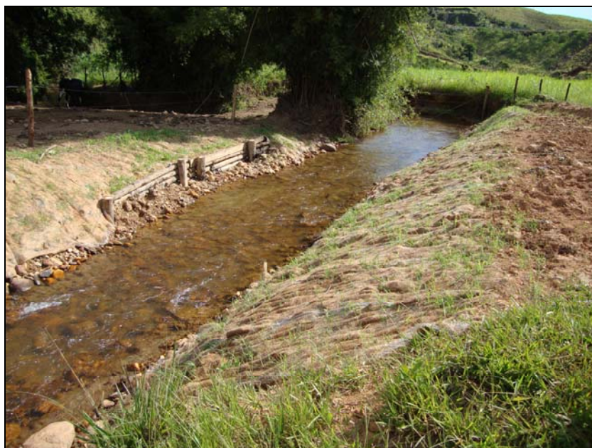
FOTO 6.1.3-4: Biomanta instalada para controle de carreamento de sedimentos no km 202 do empreendimento, coordenadas em UTM: N=7.638.341/E=646.979 (Fonte: LENC, jan/10).
