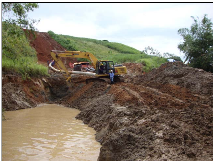
FOTO 6.1.3-2: Travessia de curso d'água realizada por método subterrâneo convencional com lançamento de cavalote, coordenadas em UTM: N=7.522.913/E=636.476 (Fonte: LENC, mar/10).
