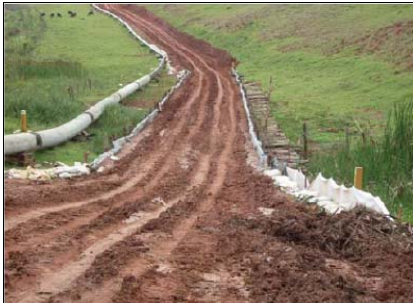
FOTO 6.2-94: Estiva para passagem de máquinas e equipamentos, no km 151, coordenadas em UTM: N= 7.594.874 /E= 655.384 (Fonte: Remma – Construcap, jan/10).
