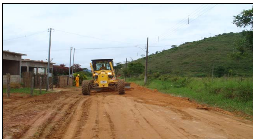
FOTO 6.3-86: Melhoria do acesso ao km 126 da faixa de servidão, coordenadas em UTM N= 7.571.479/E= 656.206 (Fonte: Remma – Construcap, dez/09).
