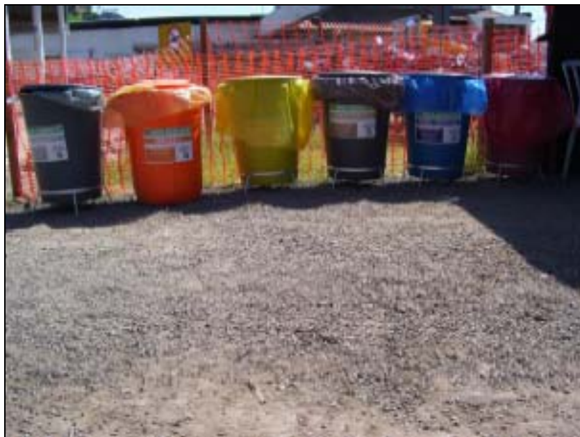
FOTO 6.1.1-52: Kit para coleta seletiva no canteiro, coordenadas em UTM N=7.597.952/E=661.072 (Fonte: Remma Construcap, mar/10).
