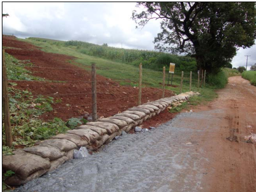
FOTO 6.2-43: Contenção de sedimentos sólidos com sacaria de solo-cimento, no km 260+950, coordenadas em UTM N= 7.688.253/E= 621.723 (Fonte: Lenc, fev/10).
