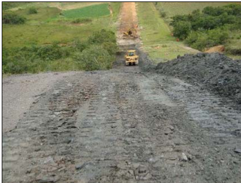
FOTO 6.2-116: Construção de leiras no km 257+105, coordenadas em UTM N= 7.684.833/E= 621.688 (Fonte: Remma - Egesa, jan/10).
