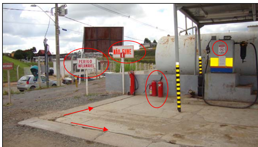
FOTO 6.1.1-25: Local destinado ao abastecimento de veículos. Piso impermeável, canaletas (setas), placas de aviso e extintor de incêndio (círculos), coordenadas em UTM N=7.652.927/E=630.639 (Fonte: Lenc, mar/10).
