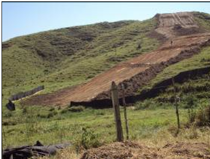
FOTO 6.2-102: Sistema de drenagem provisória (leiras transversais) construídas no km 15+600, coordenadas em UTM: N= 7.509.046/E= 612.398 (Fonte: Remma Azevedo Travassos, set/09).
