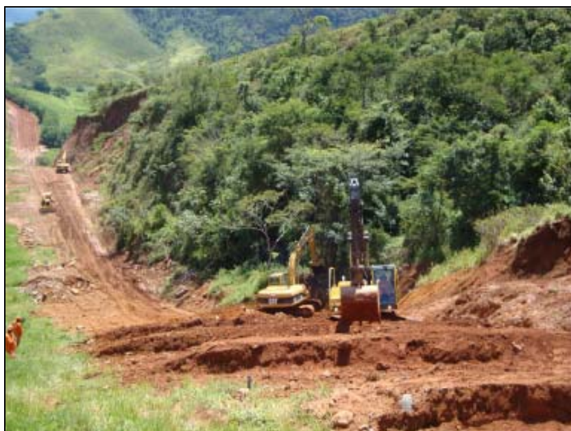
FOTO 6.2-125: Instalação de leiras no km 127+255, coordenadas em UTM N= 7.572.666/E= 655.820 (fonte: Remma - GDK, mar/10).
