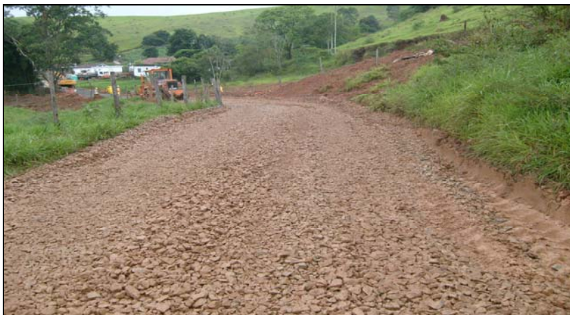
FOTO 6.3-90: Melhoria do acesso ao km 158 da faixa de servidão, coordenadas em UTM N= 7.601.460/E= 655.610 (Fonte: Remma – Construcap, dez/09).
