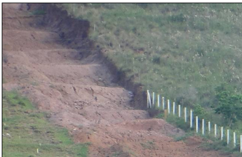
FOTO 6.2-111: Construção de leiras provisórias no km 84, coordenadas em UTM N= 7.544.023/E= 658.921 (Fonte: Remma – Azevedo Travassos, jan/10).
