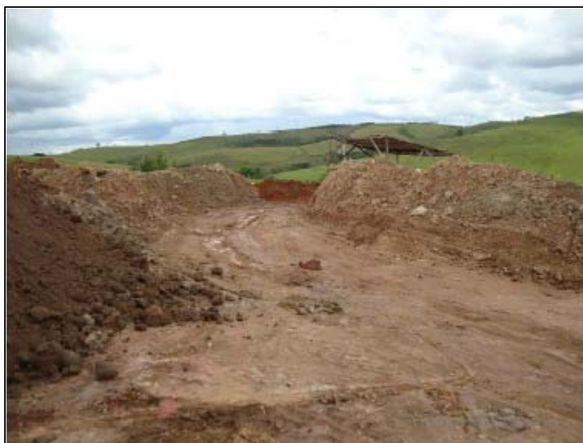
FOTO 6.1.2-32: Material retirado das piscinas de bentonita e levados até a Fábrica de Artefatos Velame, (Fonte: Remma Egesa, mar/10).
