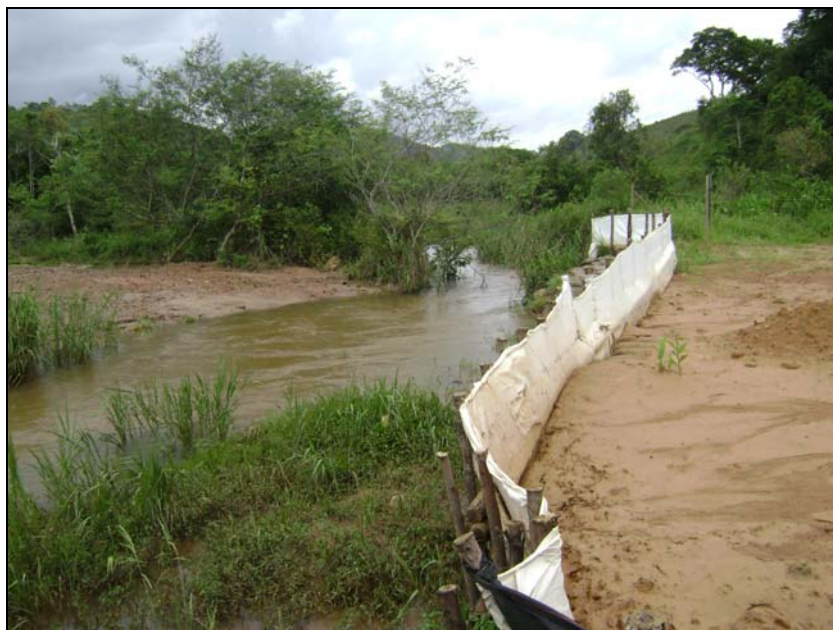
FOTO 6.1.3-3: Tela-filtro instalada para estabilização da margem no km 140+725m do empreendimento, coordenadas em UTM: N=7.585.451/E=655.629 (Fonte: LENC, jan/10).
