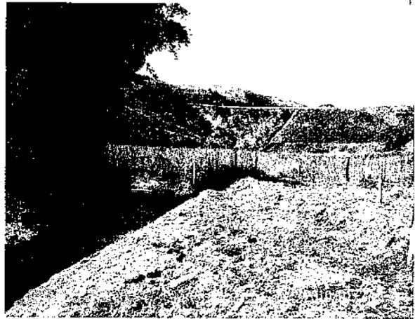
Foto-24 Recuperação do talude à direita do ribeirão Formosinho com instalação de redes/mantas.
