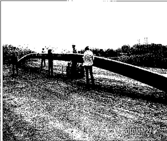
Foto-13 Tubulação exposta aguardando a instalação da válvula de segurança.
