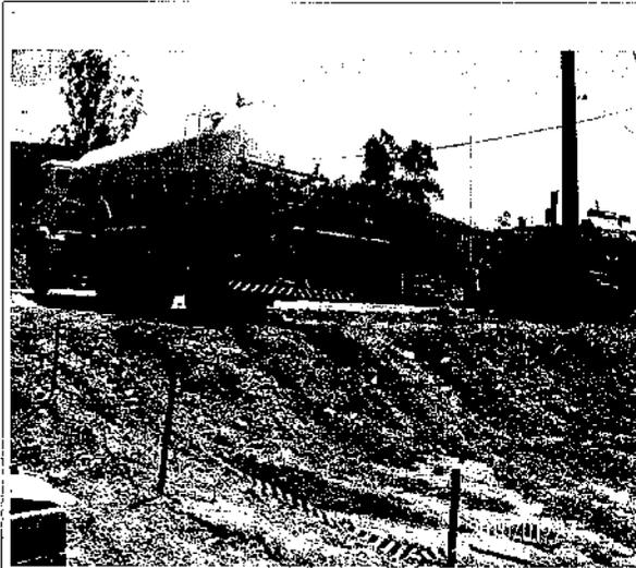
Foto-17 Existência de sulcamentos erosivos no patio de manobras.
