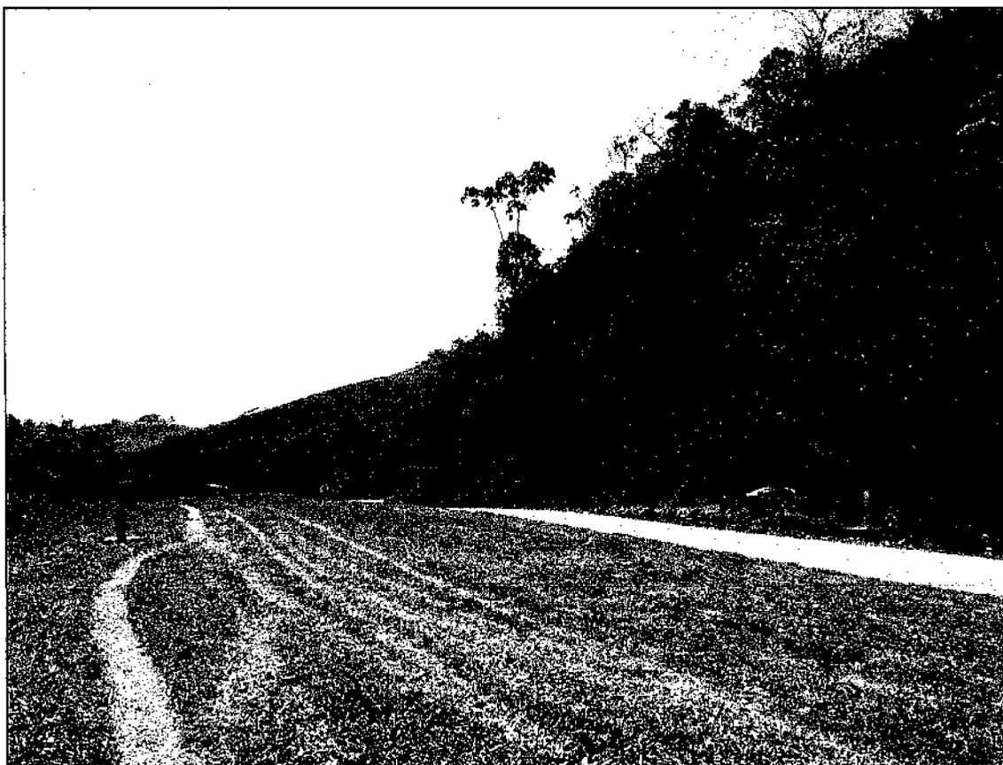
Foto 1 – Ponto 41 (KM 119+515) – Ponto reabilitado. Não foi evidenciado o movimento de massa no local. Neste Ponto não será necessário implementar o PRAD neste ponto.
