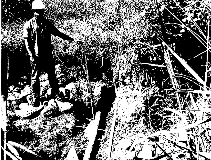
Figura 3: Detalhe do Km 23+800 ANTES da intervenção, com tubo camisa da fibra óptica e camada de proteção de concreto do duto exposto.
