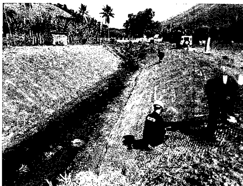
Foto 4: Faixa do GASBEL II, APÓS a retirada dos mourões, suavização dos taludes e revegetação com aplicação de biomanta e tela de proteção. Fonte: Petrobras.
