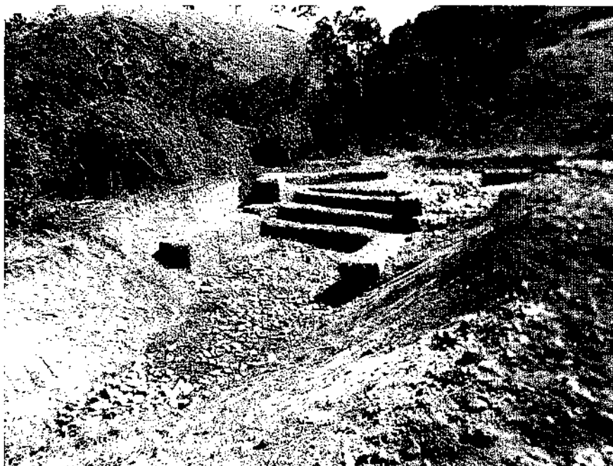
Figura 8: Detalhe do local APÓS a intervenção e conclusão de instalação do muro de gabião e aplicação de rachões.
