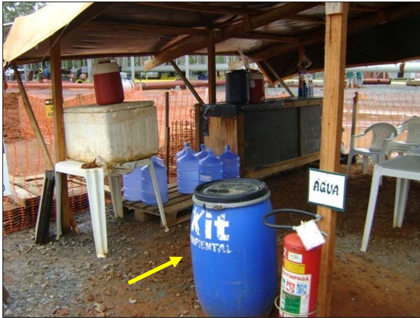
FOTO 2.6.17-2: Extintor de incêndio junto ao kit ambiental em área de vivência (Fonte: Remma GDK, jan/10).
