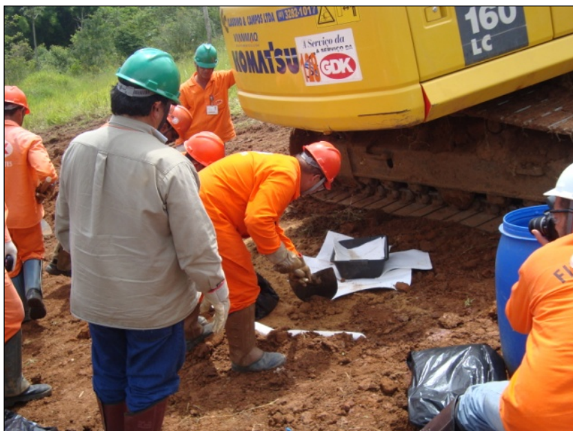
FOTO: 2.6.17-14: Simulação do Recolhimento do material contaminado (Fonte Remma, GDK, fev/10).
