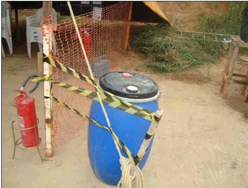
FOTO 2.6.17-4: Kit Ambiental e extintor disposto na frente de trabalho (Fonte: Remma GDK, mai/10).
