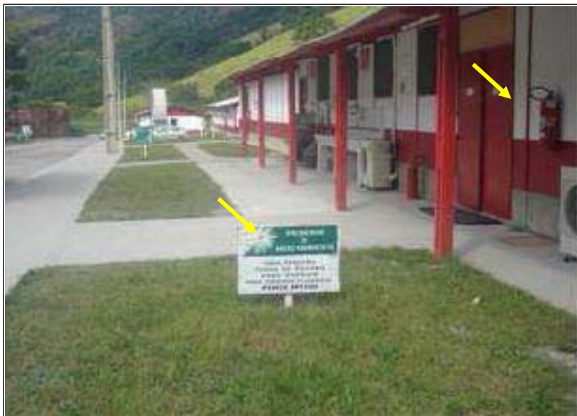
FOTO 2.6.16-16: Sinalização de meio ambiente e extintor de incêndio (Fonte: Remma GDK, mai/10).
