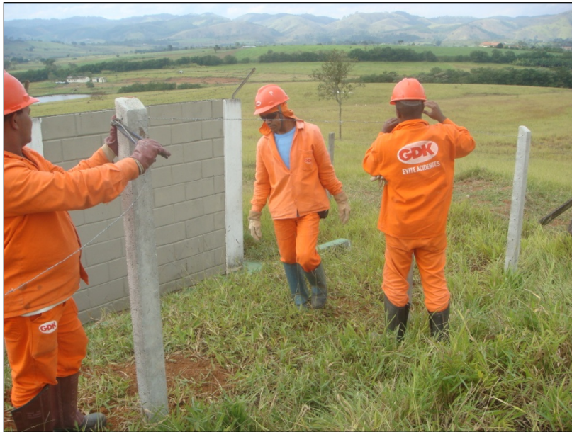
FOTO 2.6.16-11: Trabalhadores utilizando EPIs básicos na colocação de cerca (Fonte: Remma GDK, mai/10).
