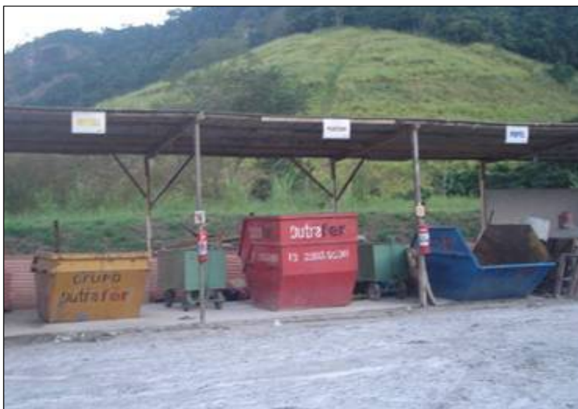
FOTO 2.6.14-24: Bacias para armazenamento de resíduos no canteiro de obras da montadora Schahin (Fonte: Remma Schahin, mai/10).
