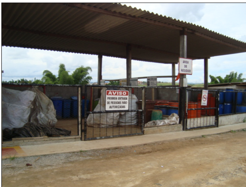
FOTO 2.6.14-21: Baias para armazenamento de resíduos no canteiro de obras da montadora GDK (Fonte: Lenc, mar/10).
