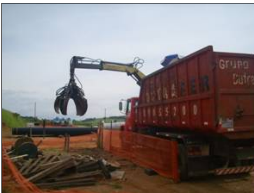
FOTO 2.6.14-26: Coleta de resíduos de madeira (Fonte: Remma Consórcio Gastau, jan/10).
