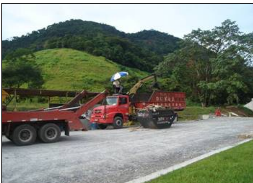
FOTO 2.6.14-28: Coleta de resíduos no canteiro de obras (Fonte: Remma Schahin, fev/10).
