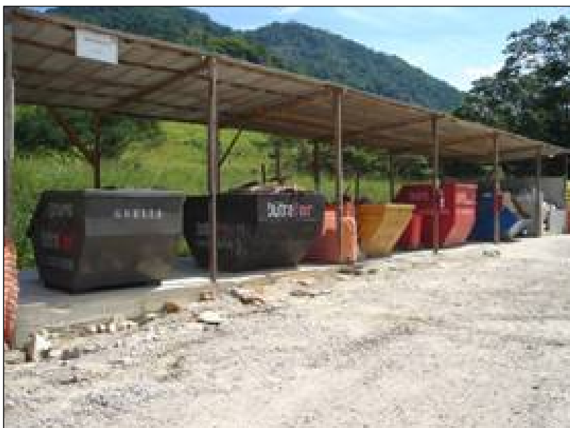
FOTO 2.6.14-23: Baias para armazenamento de resíduos no canteiro de obras da montadora Schahin (Fonte: Remma Schahin, jan/10).
