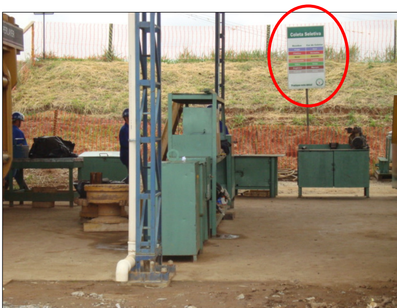
FOTO 2.6.14-11: Orientação de coleta dos resíduos no canteiro de obras do Consórcio Gastau (Fonte: Lenc, mar/10).
