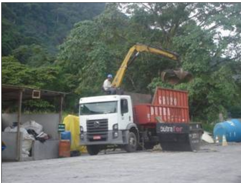
FOTO 2.6.14-27: Coleta de resíduos no canteiro de obras da montadora Schahin (Fonte: Remma Schahin, jan/10).
