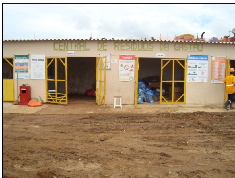
FOTO 2.6.14-17: Baía de armazenamento de resíduos no canteiro de obras da montadora Consórcio Gastau (Fonte: Lenc, mar/10).
