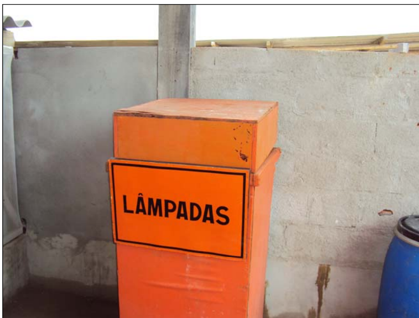
FOTO 2.6.14-22: Armazenamento de lâmpadas em baia de armazenamento de resíduos perigosos no canteiro de obras da montadora GDK (Fonte: Remma GDK, fev/10).
