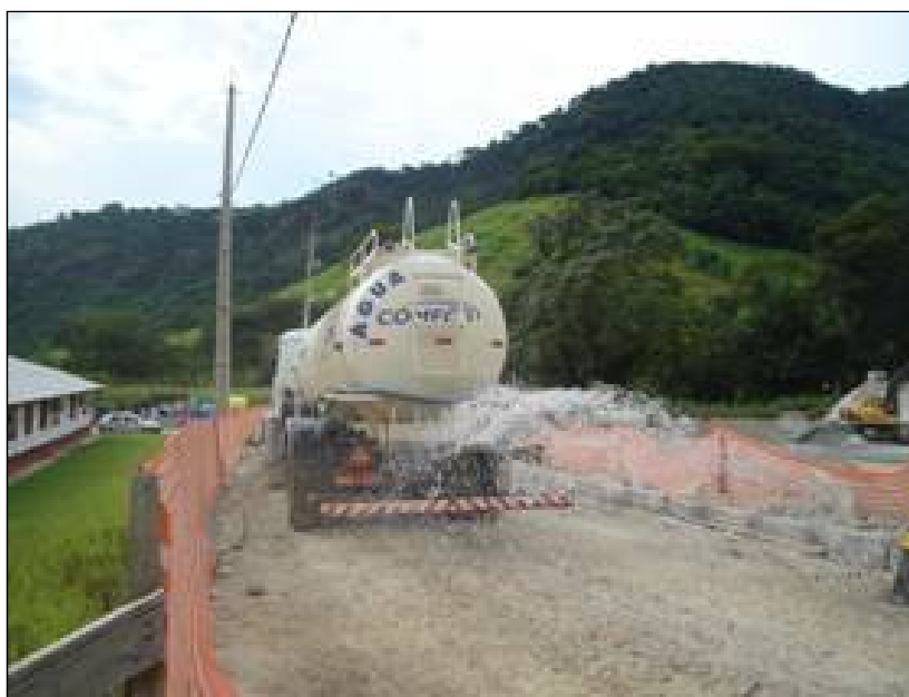
FOTO 2.6.14-57: Umectação do canteiro (Fonte: Remma Schahin, jan/10).
