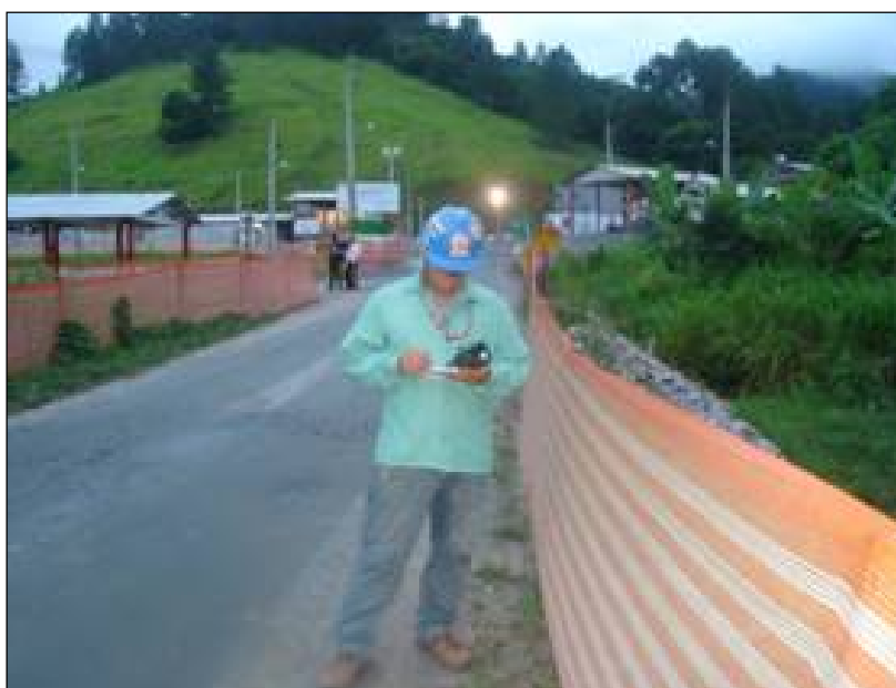
FOTO 2.6.14-62: Medição de ruído no canteiro da Montadora Schahin (Fonte: Remma Schahin, fev/09).
