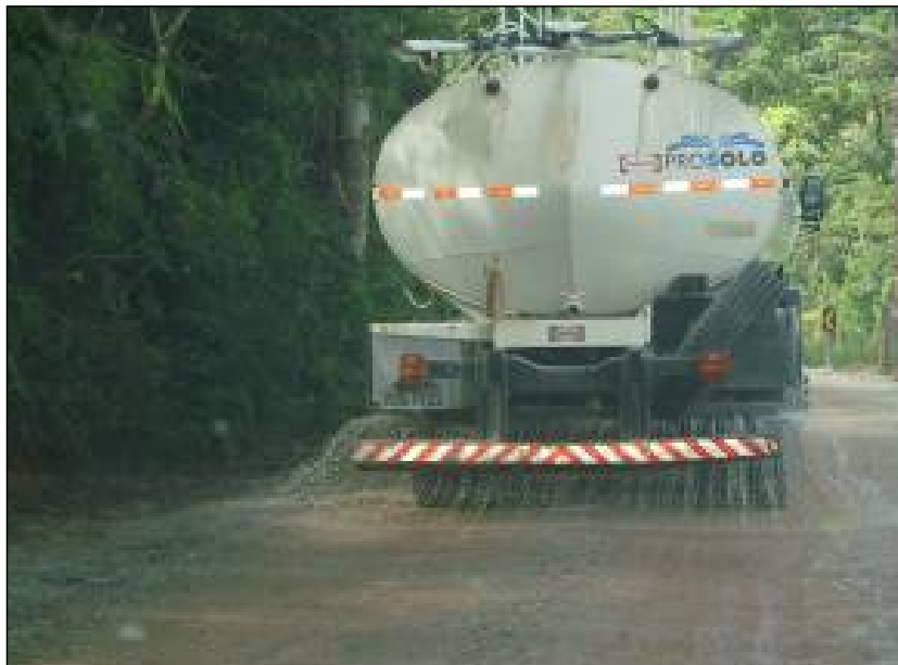
FOTO 2.6.14-59: Umectação de via de acesso ao bota-fora 7B (Fonte: Remma Consórcio Gastau, mar/10).
