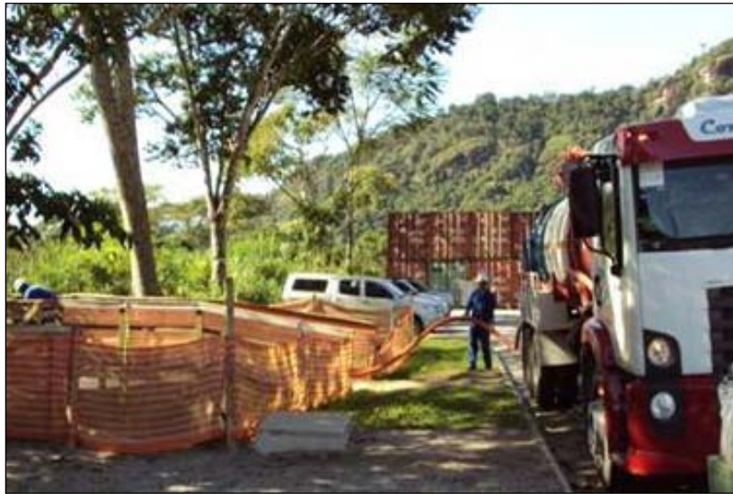
FOTO 2.6.14-39: Esgotamento de fossa séptica no canteiro de obras da Schahin (Fonte: Remma Schahin, abr/10).
