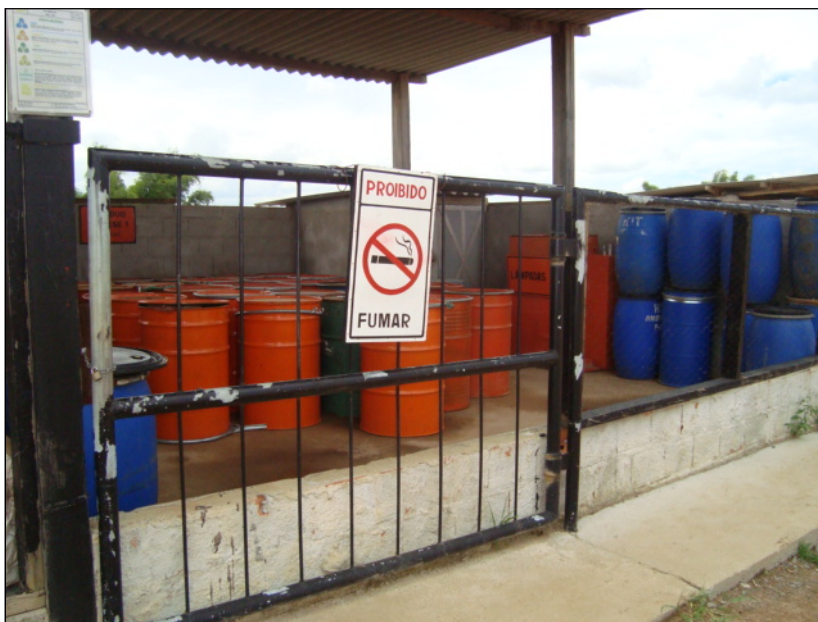
FOTO 2.6.14-20: Baía de armazenamento de resíduos classe I no canteiro de obras da montadora GDK (Fonte: Lenc, mar/10).
