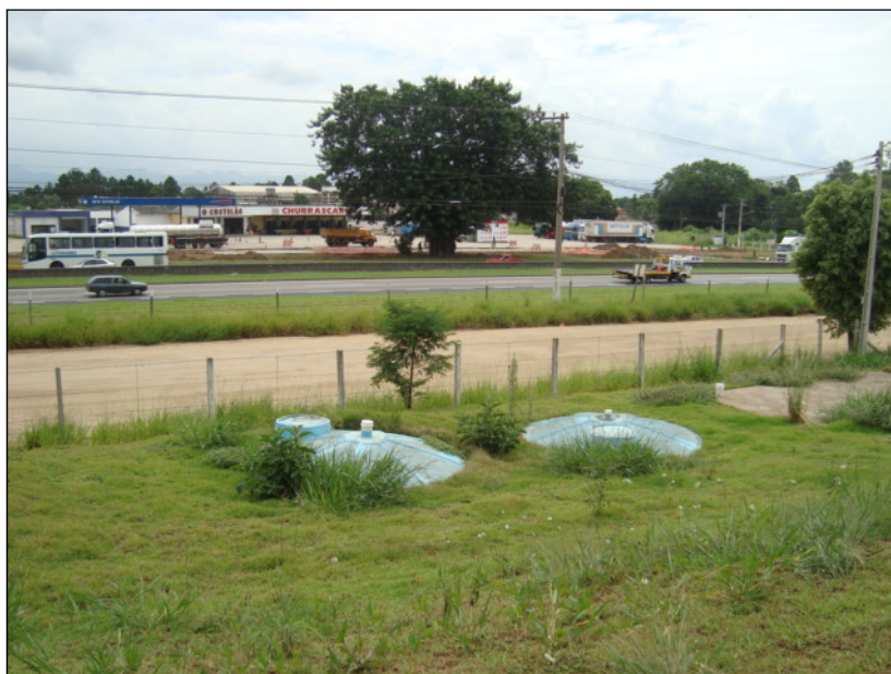
FOTO 2.6.14-32: Fossa séptica de armazenamento de efluentes proveniente dos sanitários, refeitórios, lavatórios e copa localizada no canteiro de obras da GDK (Fonte: Lenc, mar/10).
