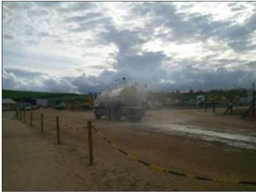
FOTO 2.6.14-60: Umectação de via do canteiro central (Fonte: Remma Consórcio Gastau, abr/10).
