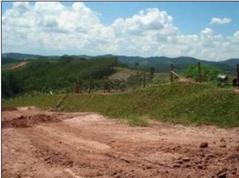
FOTO 2.6.13-95: Plantio de grama em placas no talude do km 42+800 (Fonte: Remma Consórcio Gastau, fev/10).
