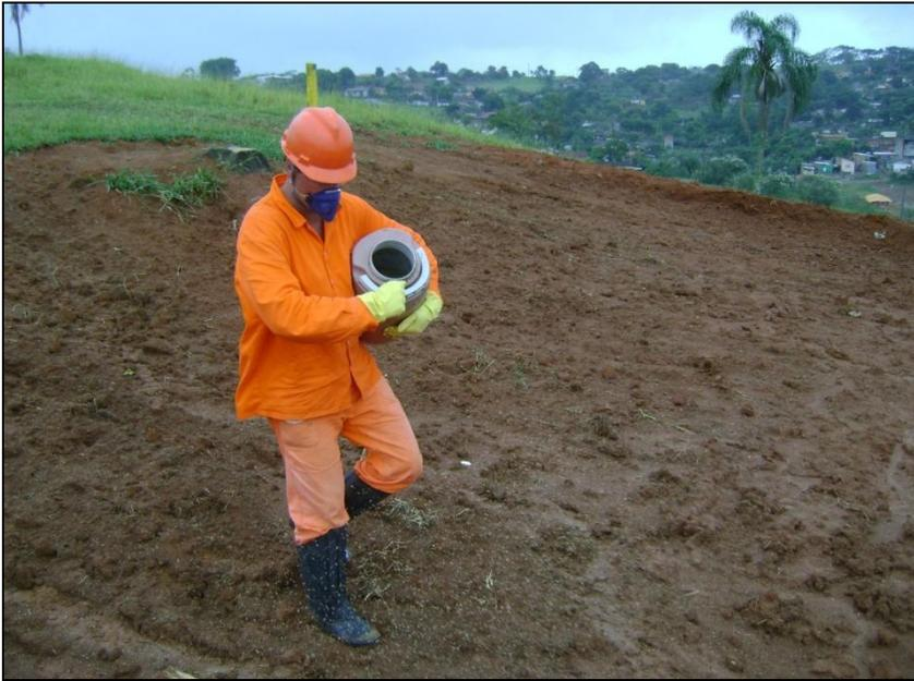
FOTO 2.6.13-82: Execução de semeadura manual, km 73+160 (Fonte: GDK, fev/10).
