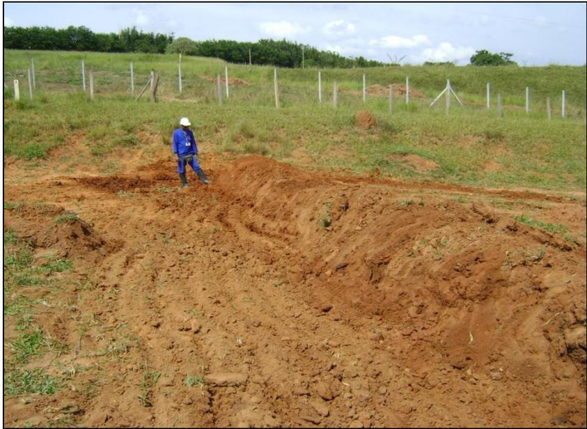
FOTO 2.6.13-28: Reconformação na inclinação das leiras no km 73+160 (Fonte: Remma GDK, abr/10).
