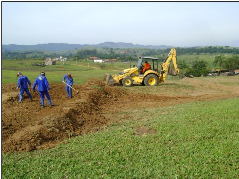
FOTO 2.6.13-29: Reconformação na inclinação das leiras no km 84+160 (Fonte: Remma GDK, abr/10).
