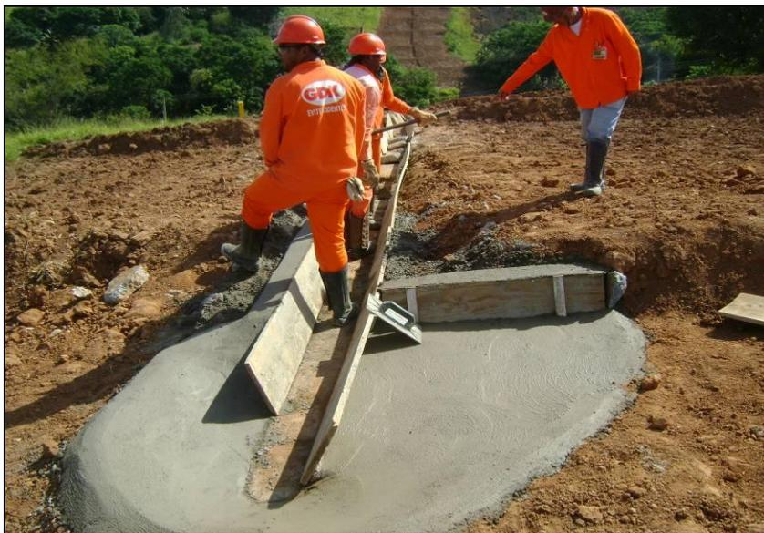
FOTO 2.6.13-137: Construção de canaleta, km 70+160 (Fonte: Remma GDK, fev/10).
