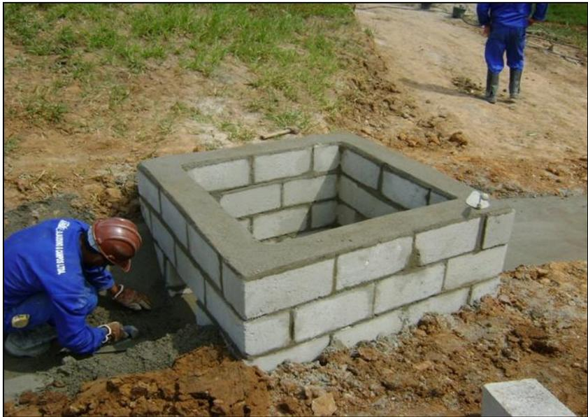
FOTO 2.6.13-141: Construção de caixa de dissipação, km 74+160 (Fonte: Remma GDK, fev/10).
