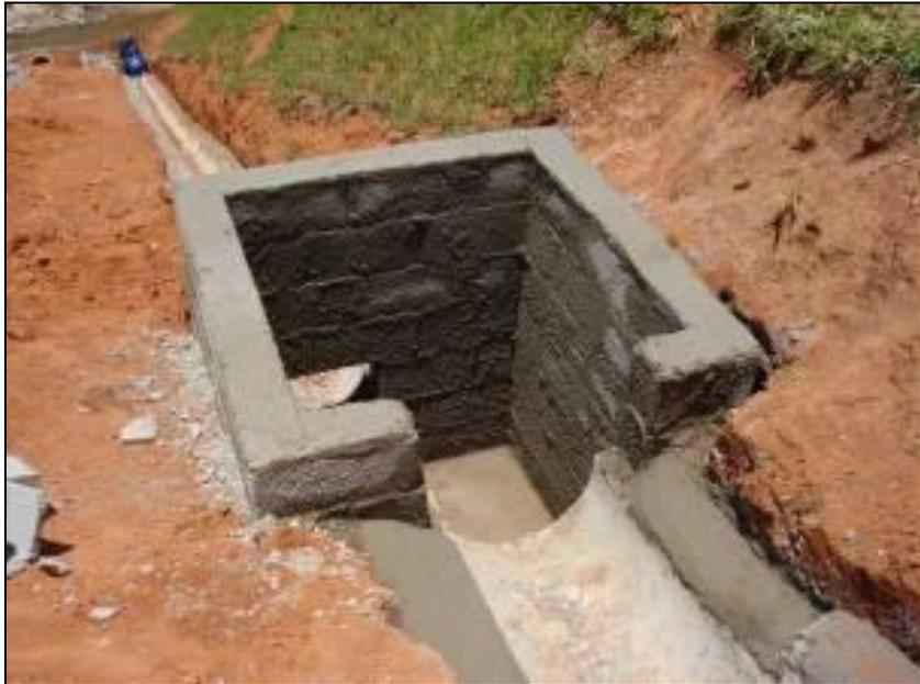
FOTO 2.6.13-132: Construção de caixa de passagem, sistema de drenagem definitivo, km 33+300 (Fonte: Remma Consórcio Gastau, fev/10).
