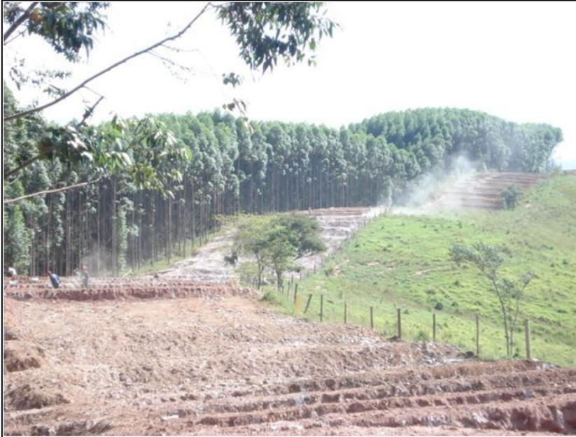
FOTO 2.6.13-64: Aplicação de calagem após a recomposição mecânica, no km 39 (Fonte: Remma Consórcio Gastau, mai/10).
