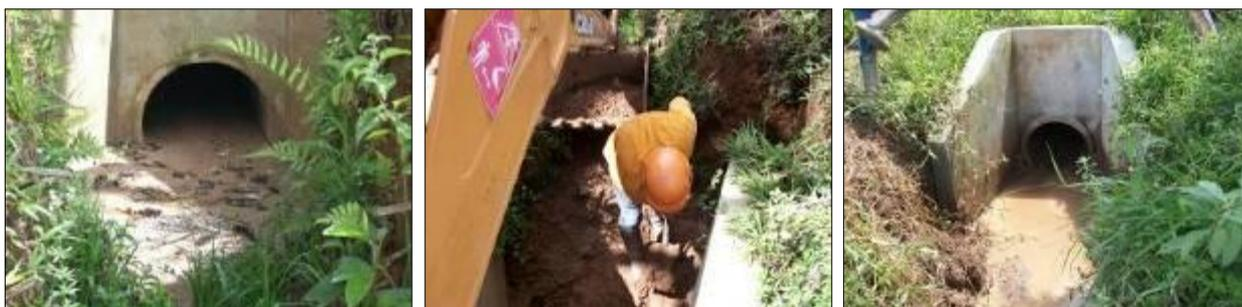
FOTO 2.6.13-43 a 2.6.13-45: Seqüência de fotos, mostrando a limpeza no início da tubulação de drenagem de águas pluviais, no acesso ao Bota-Fora 12A. (Fonte: Remma Consórcio Gastau, jan/10).
