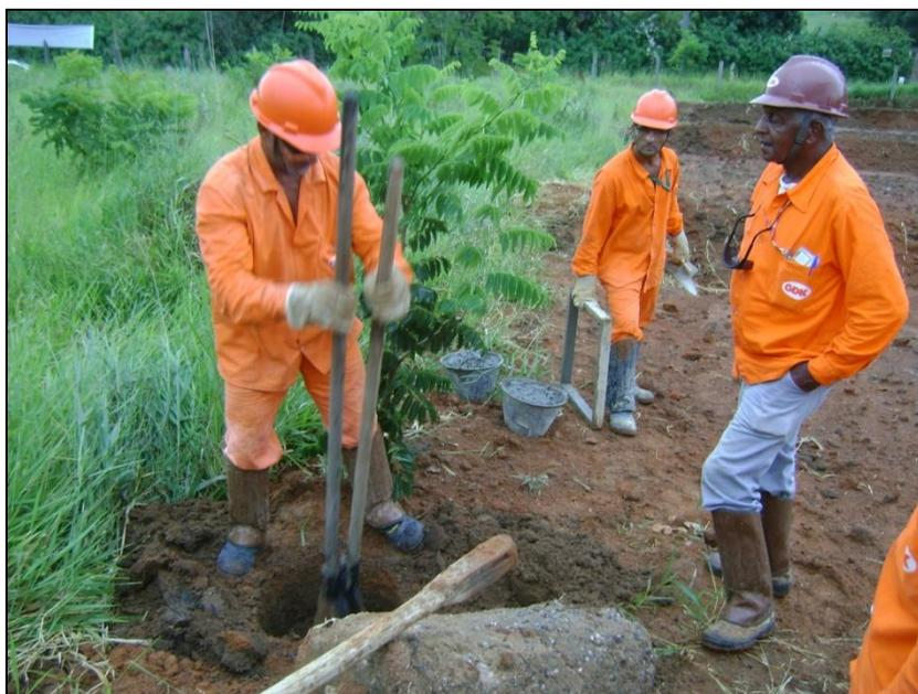
FOTO 2.6.13-127: Instalação de marcos na faixa no km 68+660 (Fonte: Remma GDK, fev/10).
