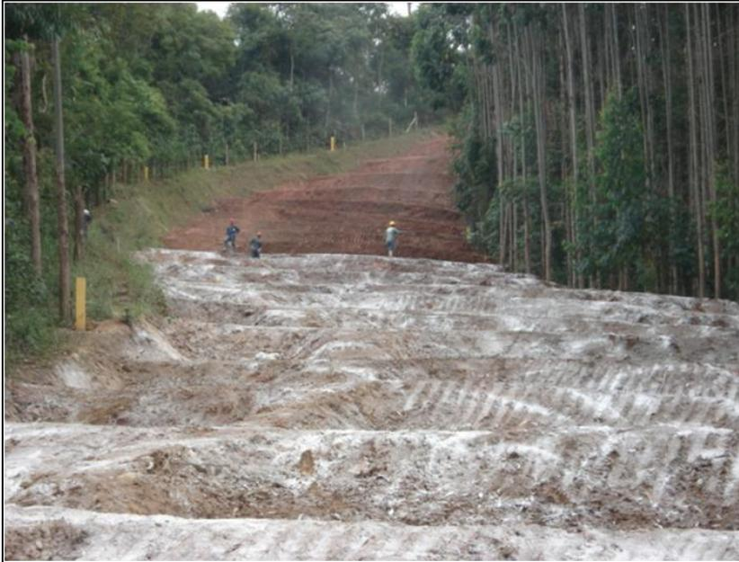
FOTO 2.6.13-62: Atividade de semeadura manual, após o processo de calagem, no km 36 (Fonte: Remma Consórcio Gastau, mai/10).
