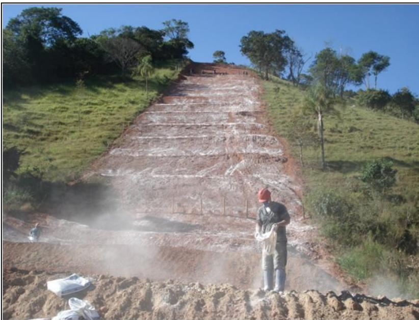
FOTO 2.6.13-63: Aplicação de calagem após a recomposição mecânica, no km 37 (Fonte: Remma Consórcio Gastau, mai/10).
