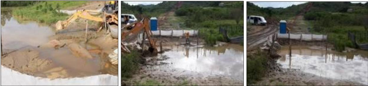
FOTO 2.6.13-161 a 2.6.13-163: Seqüência de fotos, mostrando a limpeza no afluente do rio Alambari e colocação de telas-filtro para contenção de sedimentos, km 60+222 ao km 60+282 (Fonte: Remma Consórcio Gastau, jan/10).
