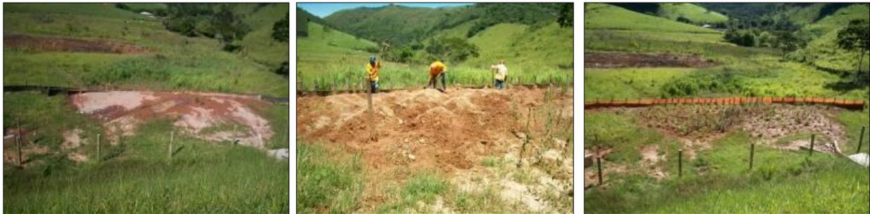
FOTO 2.6.13-56 a 2.6.13-58: Seqüência de fotos, mostrando a limpeza e a restauração da proteção de tela-filtro, no Bota-Fora 14. (Fonte: Remma Consórcio Gastau, fev/10).
