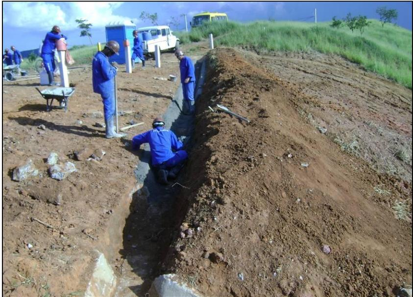
FOTO 2.6.13-138: Construção de canaleta, km 70+160 (Fonte: Remma GDK, fev/10).
