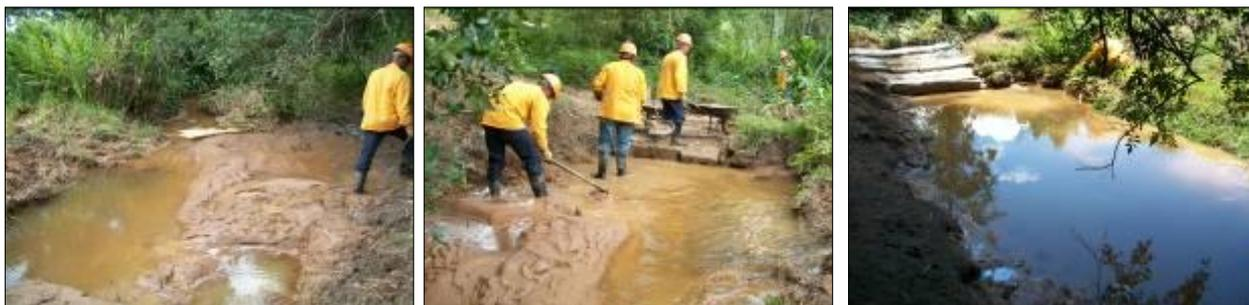
FOTO 2.6.13-173 a 2.6.13-175: Seqüência de fotos, mostrando a limpeza e colocação de uma nova estiva, localizado no afluente do córrego Espírito Santo, no km 29+900 (Fonte: Remma Consórcio Gastau, jan/10).
