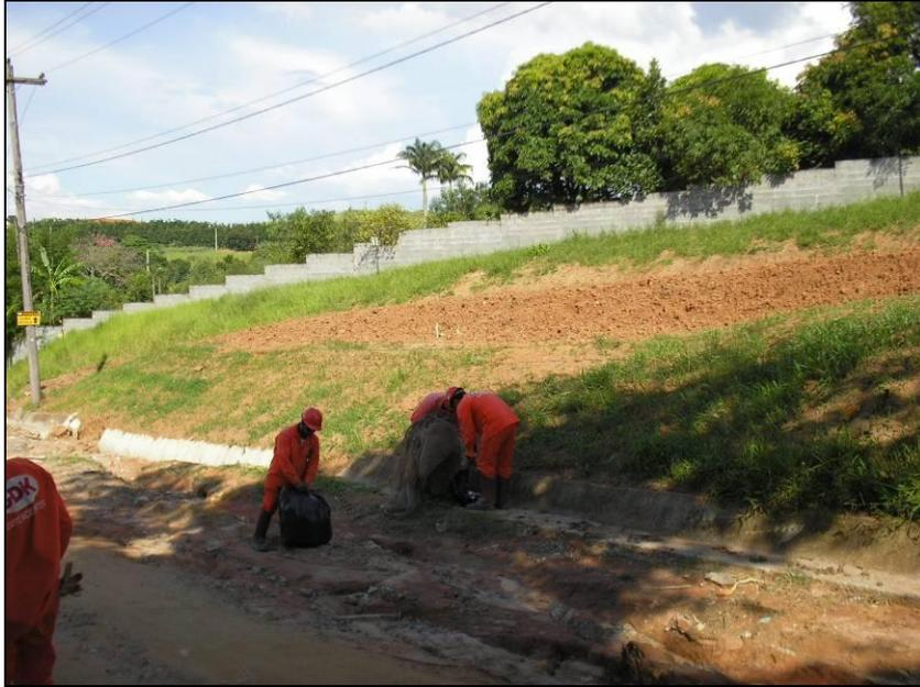
FOTO 2.6.13-109: Retirada da biomanta, após o pegamento das gramíneas, km 74+160 (Fonte: Remma GDK, fev/10).
