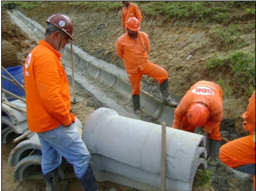
FOTO 2.6.13-139: Execução de sistema de drenagem de águas pluviais, km 73+160 (Fonte: Remma GDK, fev/10).
