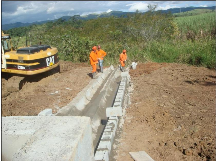
FOTO 2.6.13-142: Construção de canaletas, no km 82+160 (Fonte: Remma GDK, abr/10).
