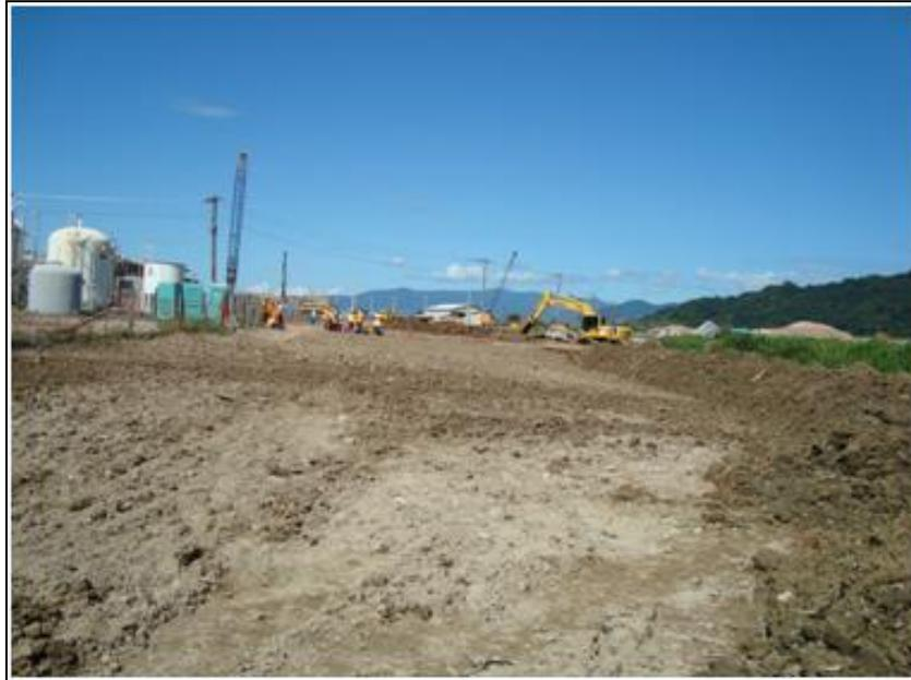
FOTO 2.6.13-5: Recomposição mecânica da faixa, km 0+180 (Fonte: Remma Consórcio Gastau, abr/10).
