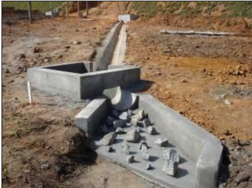
FOTO 2.6.13-130: Instalação de caixa dissipadora, km 29 (Fonte: Remma Consórcio Gastau, fev/10).
