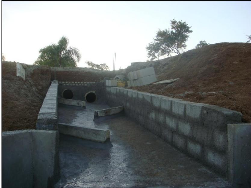
FOTO 2.6.13-144: Construção de canaletas, no km 82+160 (Fonte: Remma GDK, abr/10).
