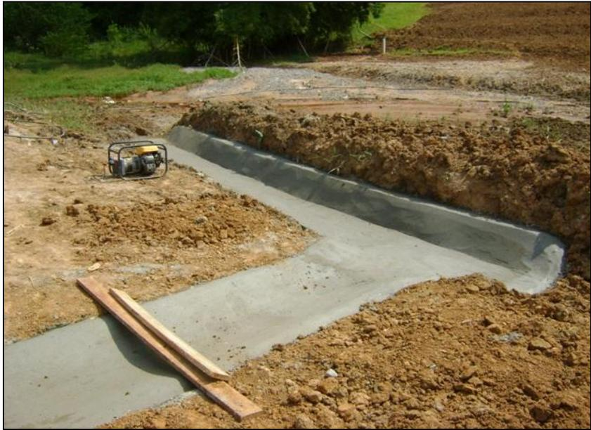
FOTO 2.6.13-140: Construção de canaleta, km 74+160 (Fonte: Remma GDK, fev/10).
