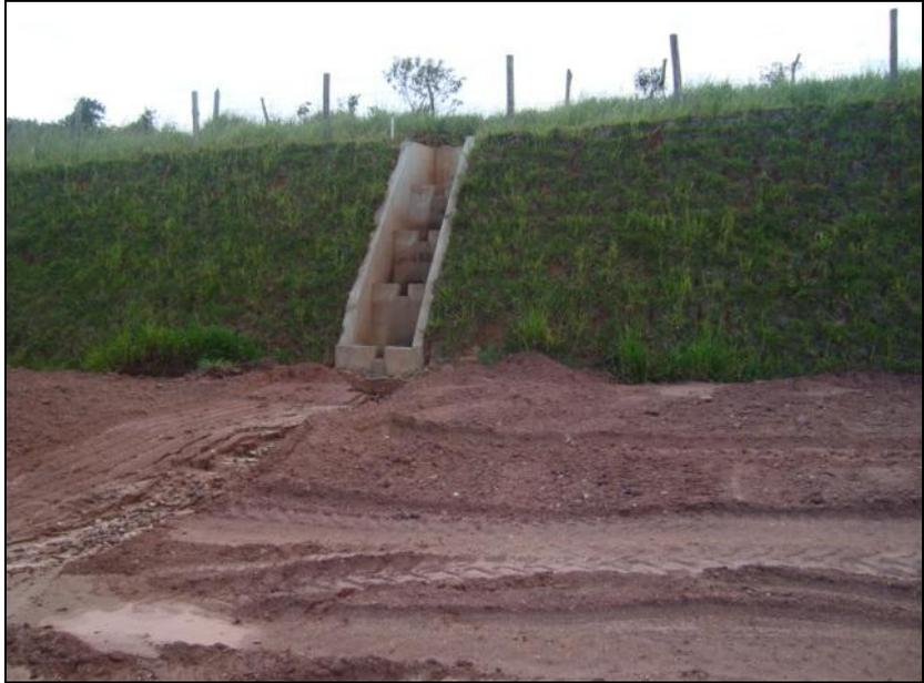
FOTO 2.6.13-135: Escada hidráulica concluída próxima a travessia do rio Capivari, km 53 (Fonte: Lenc, mar/10).
