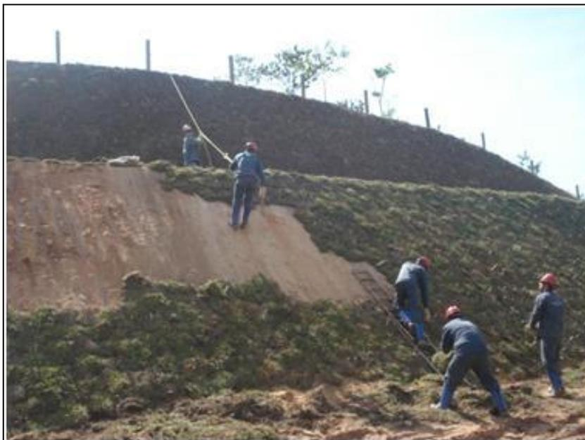
FOTO 2.6.13-100: Plantio de grama em placas no talude do km 65 (Fonte: Remma Consórcio Gastau, abr/10).
