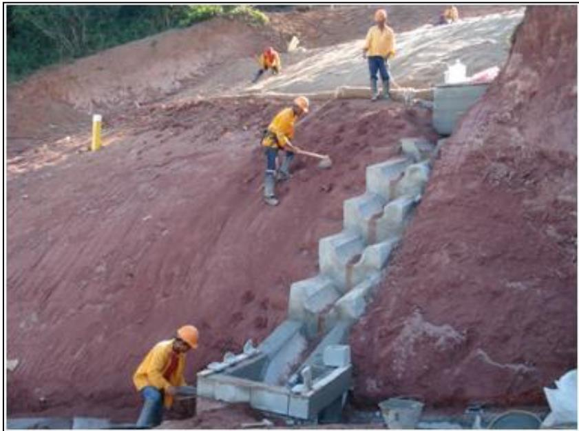
FOTO 2.6.13-133: Introdução de biomanta e construção de sistema de drenagem, no km 44 (Fonte: Remma Consórcio Gastau, abr/10).
