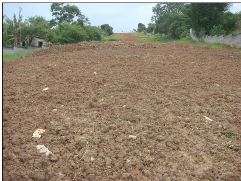
FOTO 2.6.13-4: Recobrimento da faixa com *top-soil*, km 79+160 (Fonte: Remma GDK, jan/10).
