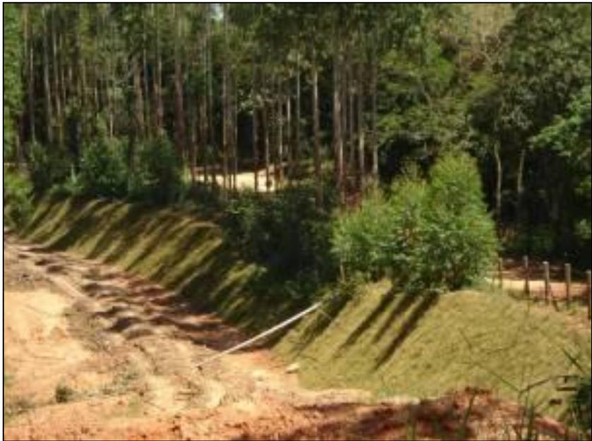
FOTO 2.6.13-97: Plantio de grama em placas no talude do km 58 (Fonte: Remma Consórcio Gastau, fev/10).
