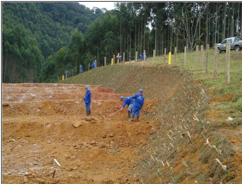
FOTO 2.6.13-91: Plantio de grama em placas e instalação de cercas no talude do km 21+600 (Fonte: Remma Consórcio Gastau, abr/10).
