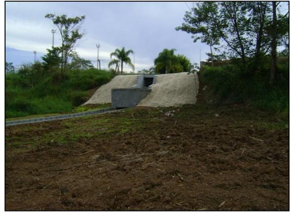
FOTOS 2.6.13-111 e 112: Instalação de biomanta próximo a estrutura de escoamento hidráulico, no km 82+160 (Fonte: Remma GDK, mai/10).
