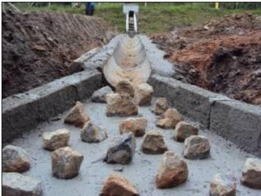
FOTO 2.6.13-131: Construção de sistema de drenagem definitivo, km 30 (Fonte: Remma Consórcio Gastau, fev/10).
