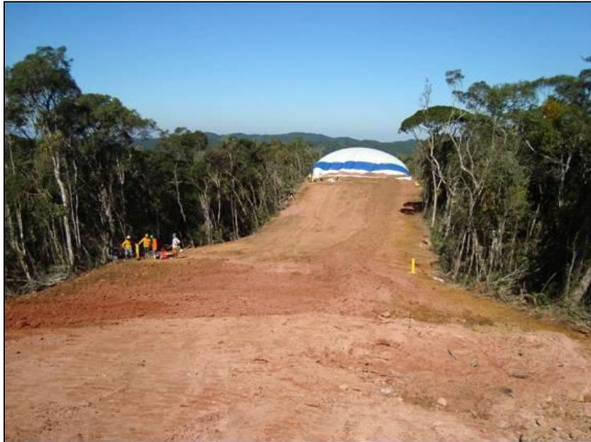
FOTO 2.6.13-7: Recomposição mecânica da faixa, por meio de terraplenagem, km 9+500 (Fonte: Remma Consórcio Gastau, jun/10).
