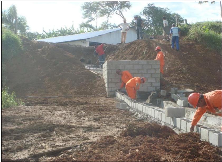
FOTO 2.6.13-143: Construção de canaletas, no km 82+160 (Fonte: Remma GDK, abr/10).
