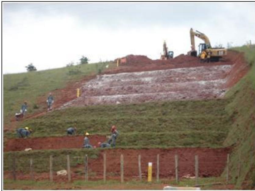
FOTO 2.6.13-69: Aplicação de calagem e recomposição vegetal, no km 50 no cruzamento com a Rodovia dos Tamoios (Fonte: Remma Consórcio Gastau, abr/10).
