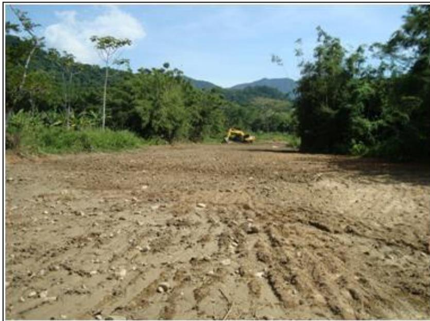
FOTO 2.6.13-6: Recomposição mecânica da faixa, por meio de terraplenagem, km 2+200 (Fonte: Remma Consórcio Gastau, abr/10).
