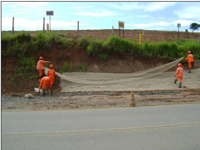
FOTO 2.6.13-110: Aplicação de biomanta, km 79+160 (Fonte: Remma GDK, fev/10).
