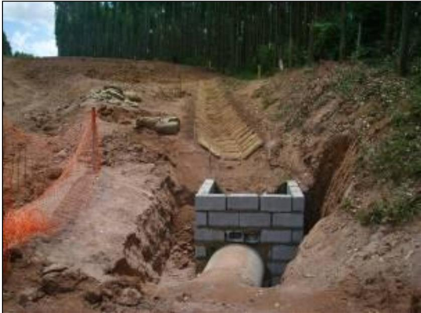
FOTO 2.6.13-136: Construção de sistema de drenagem definitivo, km 58 (Fonte: Remma Consórcio Gastau, fev/10).
