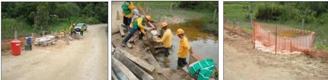
FOTO 2.6.13-40 a 2.6.13-42: Seqüência de fotos, mostrando a proteção em área de APP, com telas filtro, no acesso a faixa do km 12. (Fonte: Remma Consórcio Gastau, jan/10).
