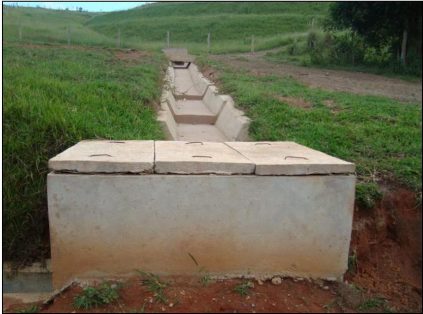
FOTO 2.6.13-134: Caixa de dissipação concluída próxima a travessia do rio Capivari, km 53 (Fonte: Lenc, mar/10).
