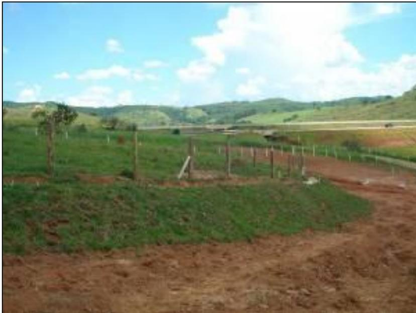
FOTO 2.6.13-99: Plantio de grama em placas no talude do km 62+080 (Fonte: Remma Consórcio Gastau, fev/10).
