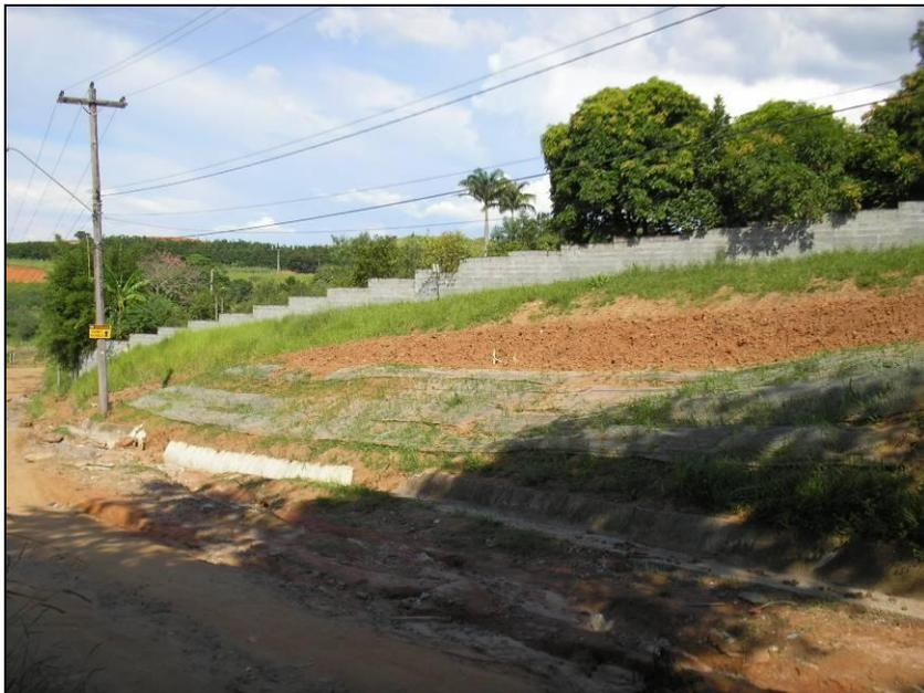
FOTO 2.6.13-108: Revegetação em talude, com o uso de biomanta, km 74+160 (Fonte: Remma GDK, fev/10).
