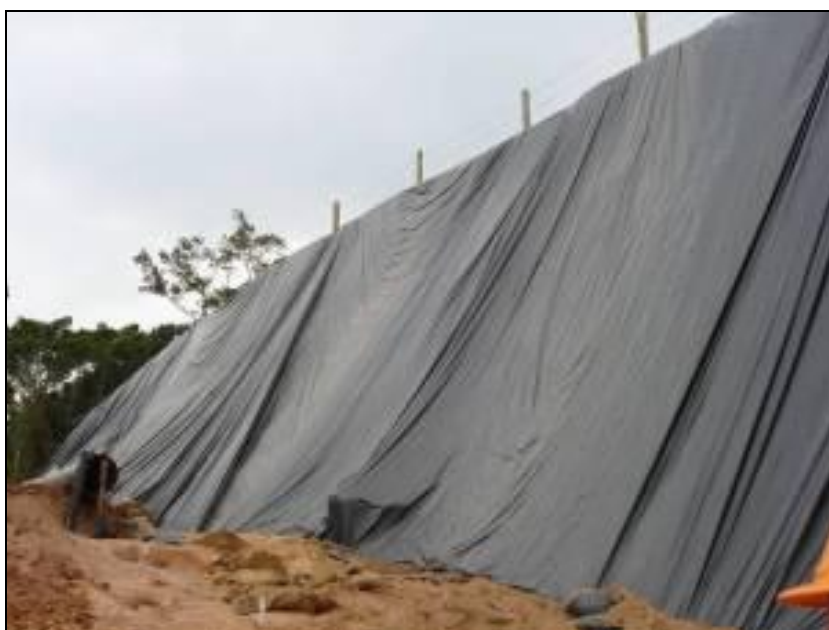
FOTO 2.6.12-11: Controle de processos erosivos em talude, com declividade acentuada, por meio da cobertura de sua superfície com lona plástica, km 22+300 (Fonte: Remma Consórcio Gastau, fev/10).
