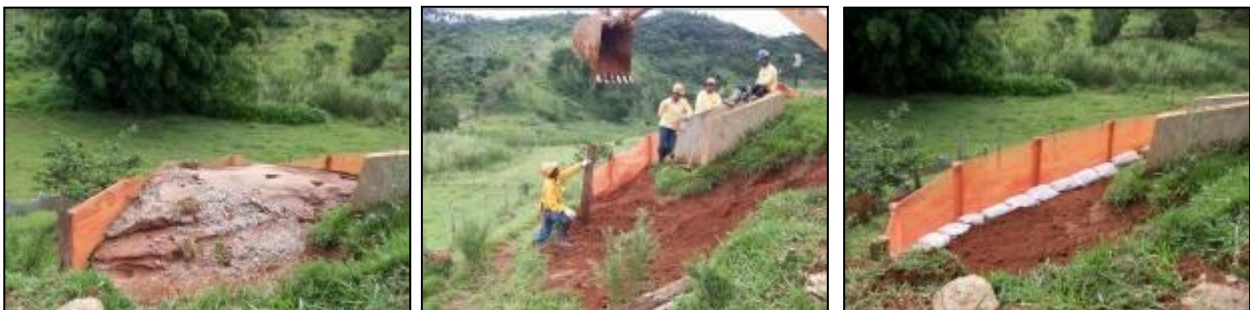
FOTO 2.6.13-81 a 2.6.13-83: Acesso ao Bota-Fora 19A - Seqüência de fotos, mostrando a manutenção e reparação das telas-filtro para contenção de sedimentos (Fonte: Remma Consórcio Gastau, abr/10).
