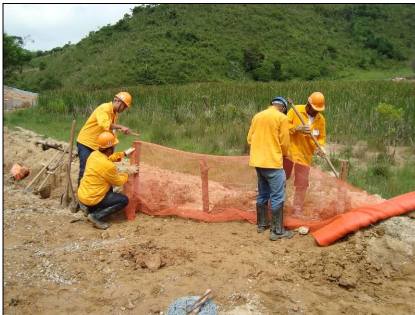
FOTO 2.6.12-49: Equipe de monitoramento ambiental, restaurando as contenções de sedimentos, km 15+100 (Fonte: Remma Consórcio Gastau, jan/10).
