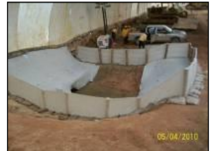
FOTO 2.6.13-7 a 2.6.13-9: Seqüência de fotos, evidenciando contenção de sedimentos em área sensível, sob a cobertura insuflável, no km 11+500 (Fonte: Remma Consórcio Gastau, mai/10).
