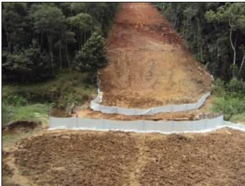
FOTO 2.6.12-10: Contenção de sedimentos instalada para proteção de travessia de curso d'água, km 17+900 (Fonte: Remma Consórcio Gastau, fev/10).
