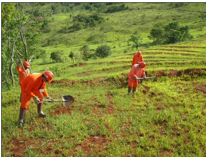
FOTO 2.6.12-74: Manutenção de leiras, km 94+660 (Fonte: Remma GDK, jan/10).
