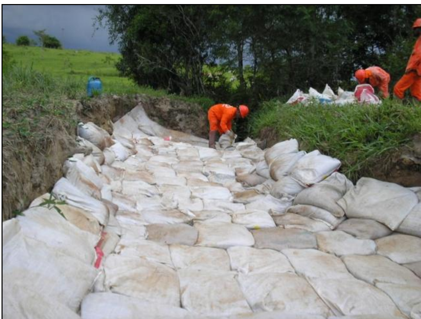
FOTO 2.6.12-23: Implantação de sacarias para impedir o surgimento de processos erosivos, km 83+160 (Fonte: Remma GDK, jan/10).
