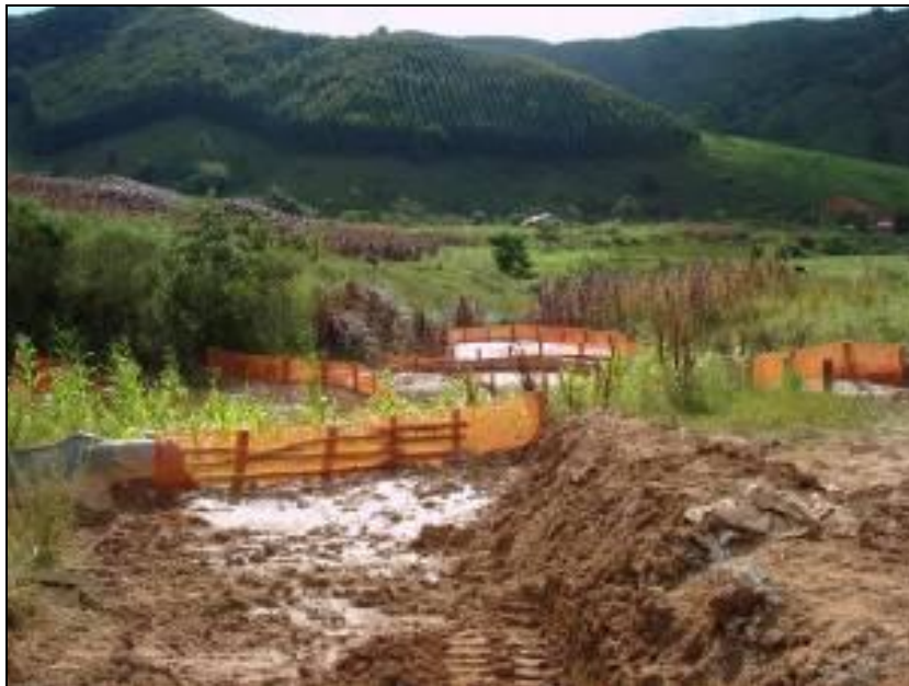
FOTO 2.6.12-16: Contenção de sedimentos instalada para proteção de travessia de cursos d'água, km 37 (Fonte: Remma Consórcio Gastau, fev/10).
