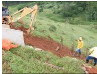
FOTO 2.6.13-70 a 2.6.13-72: Seqüência de fotos, mostrando a manutenção e reparação das estruturas de telas-filtro para contenção de sedimentos, Acesso ao Bota-Fora 19A e km 56 (Fonte: Remma Consórcio Gastau, abr/10).
