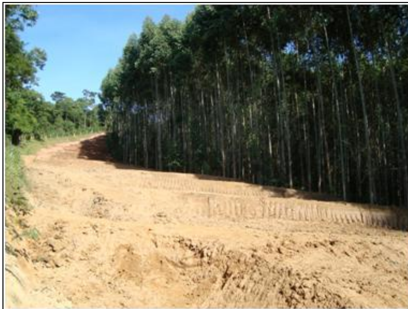
FOTO 2.6.12-35: Recomposição da faixa de servidão com a implantação de leiras, no km 35 (Fonte: Remma Consórcio Gastau, abr/10).
