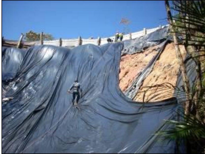
FOTO 2.6.12-6: Controle de processos erosivos em talude com a utilização de lona plástica, km 8+680 (Fonte: Remma Consórcio Gastau, fev/10).
