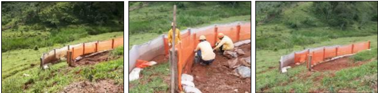
FOTO 2.6.13-78 a 2.6.13-80: Acesso ao Bota-Fora 19A - Seqüência de fotos, mostrando a situação antes, durante e depois da reparação das estruturas de telas-filtro para contenção de sedimentos (Fonte: Remma Consórcio Gastau, abr/10).
