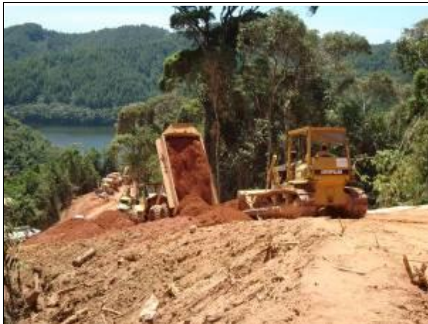
FOTO 2.6.12-4: Terraplenagem do km 8+300 ao km 9+100 (Fonte: Remma Consórcio Gastau, fev/10).
