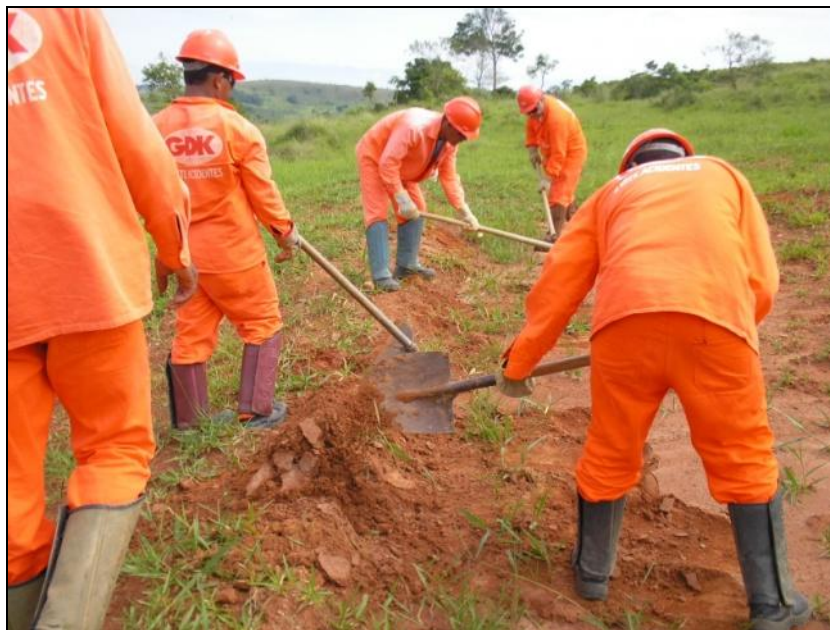
FOTO 2.6.12-73: Manutenção de leiras, km 77+160 (Fonte: Remma GDK, jan/10).
