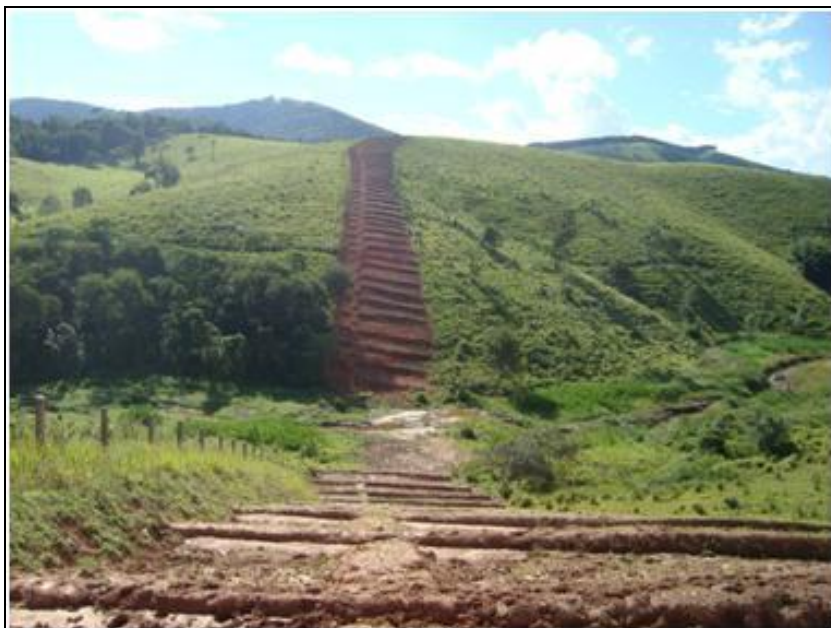
FOTO 2.6.12-34: Recomposição de faixa de servidão com leiras, no km 33+800 (Fonte: Remma Consórcio Gastau, abr/10).
