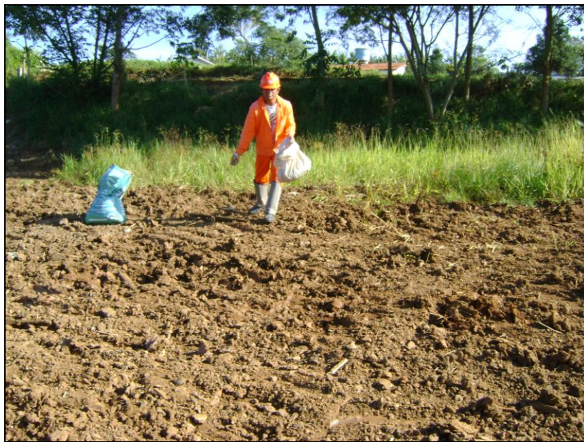
FOTO 2.6.12-87: Faixa de servidão sendo reabilitada por meio de sementeira manual no km 81+160 (Fonte: Remma GDK, abr/10).
