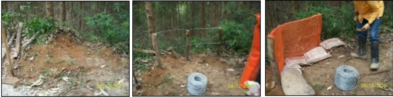
FOTO 2.6.13-75 a 2.6.13-77: Seqüência de fotos, mostrando a introdução de cerquites, para contenção de sedimentos em área íngreme, no acesso ao Bota-Fora 07 (Fonte: Remma Consórcio Gastau, abr/10).
