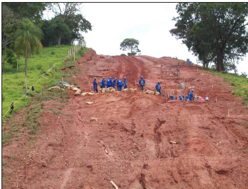
FOTO 2.6.12-17: Construção de diques de contenção de sedimentos em áreas íngremes, km 37+500 (Fonte: Remma Consórcio Gastau, jan/10).
