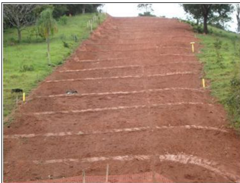
FOTO 2.6.12-36: Leiras definitivas implantadas na faixa, no km 37 (Fonte: Remma Consórcio Gastau, abr/10).
