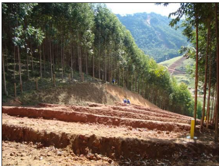
FOTO 2.6.12-84: Revegetação de gramas em placa em talude de corte, para impedimento de carreamento de materiais, km 21 (Fonte: Remma Consórcio Gastau, jun/10).
