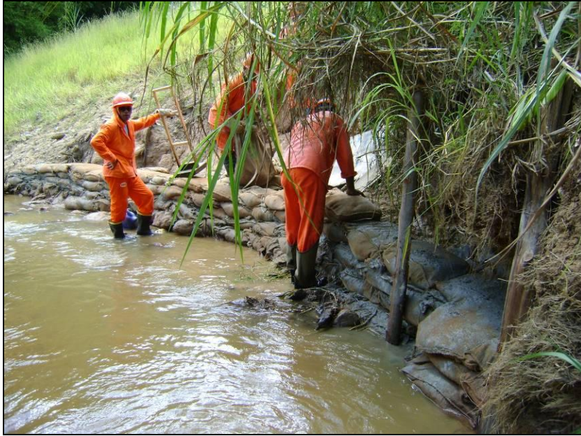
FOTO 2.6.12-24: Implantação de contenções as margens de curso d'água, com sacarias e fragmento de rochas, km 94+660 (Fonte: Remma GDK, fev/10).
