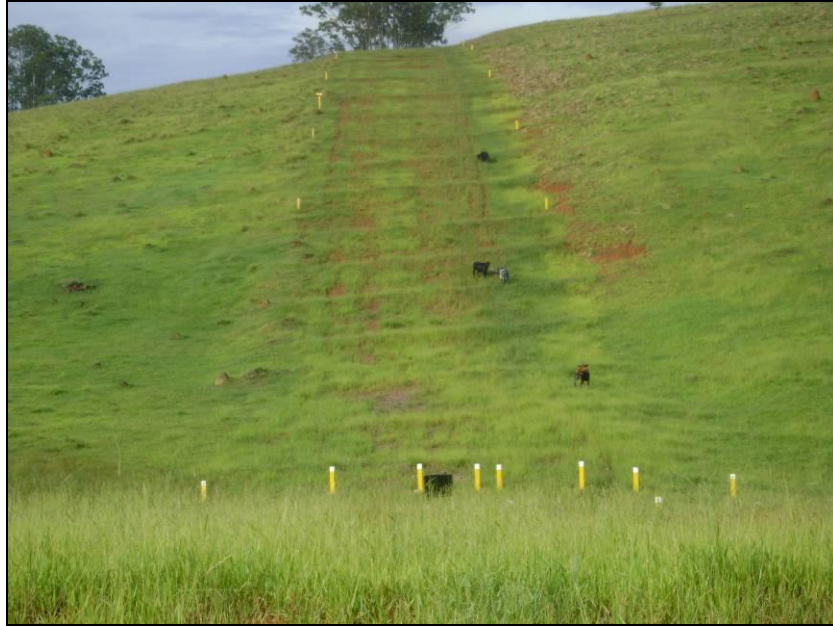
FOTO 2.6.12-3: Faixa executada, reabilitada e reintegrada ao seu uso anterior, km 94+100 (Fonte: Remma GDK, fev/10).
