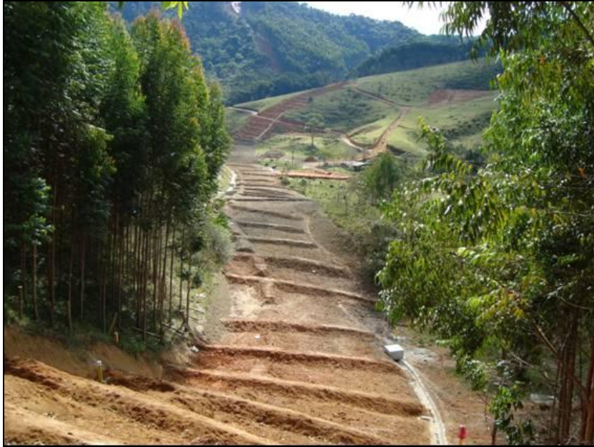
FOTO 2.6.12-33: Recomposição mecânica da faixa de servidão, km 21+000 ao 21+500 (Fonte: Remma Consórcio Gastau, jun/10).
