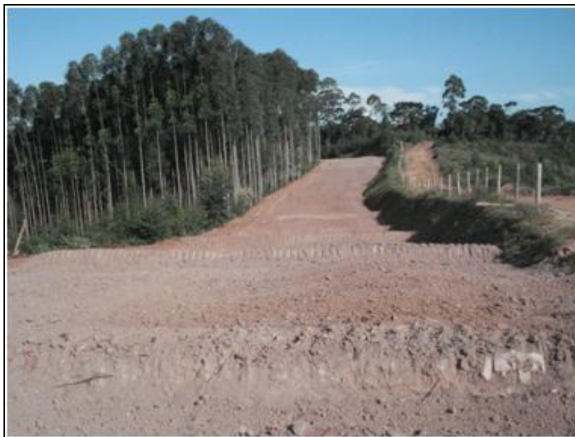
FOTO 2.6.12-38: Leiras definitivas implantadas na faixa, no km 42 (Fonte: Remma Consórcio Gastau, abr/10).
