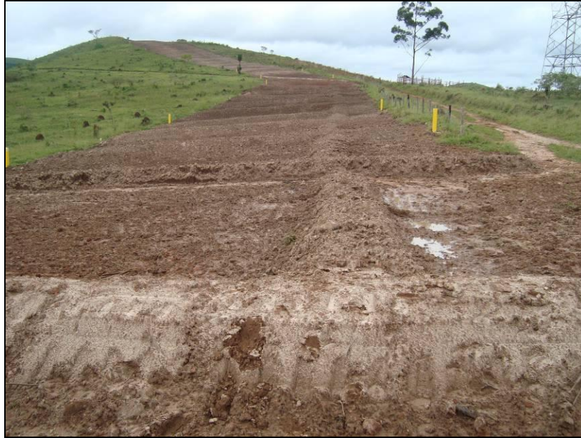
FOTO 2.6.12-45: Faixa de servidão com leiras definitivas e murundus instalados, aguardando a adubação e sementeira, km 92 (Fonte: Lenc, mar/10).
