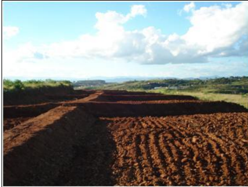
FOTO 2.6.12-39: Leiras definitivas e murundus implantados na faixa, no km 65 (Fonte: Remma Consórcio Gastau, abr/10).
