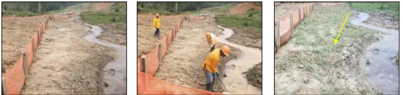
FOTO 2.6.13-57 a 2.6.13-59: Seqüência de fotos, mostrando o plantio de gramíneas nas margens de curso d'água, visando à contenção de sedimentos km 21+300 (Fonte: Remma Consórcio Gastau, abr/10).
