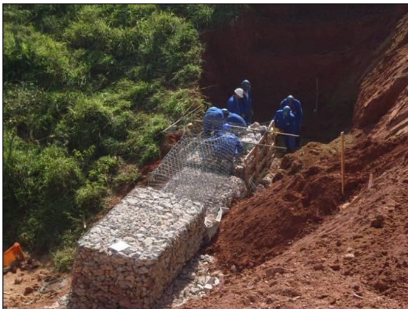
FOTO 2.6.12-19: Construção de gabião ao lado da faixa, no km 46 (Fonte: Remma Consórcio Gastau, jun/10).
