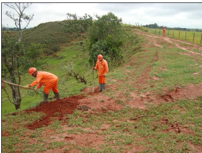
FOTO 2.6.12-50: Monitoramento da faixa de servidão já revegetada, km 15+100 (Fonte: Lenc, mar/10).
