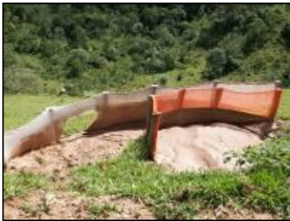
FOTO 2.6.13-70 a 2.6.13-72: Seqüência de fotos, mostrando a manutenção e reparação das estruturas de telas-filtro para contenção de sedimentos, Acesso ao Bota-Fora 19A e km 56 (Fonte: Remma Consórcio Gastau, abr/10).
