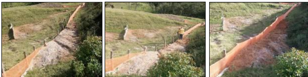
FOTO 2.6.13-60 a 2.6.13-62: Seqüência de fotos, mostrando a manutenção nas estruturas de contenções de sedimentos, no km 21+500 (Fonte: Remma Consórcio Gastau, mai/10).
