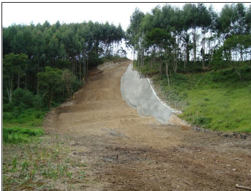
FOTO 2.6.12-15: Instalação de solo grampeado, km 35+600 (Fonte: Consórcio Gastau, mai/10).
