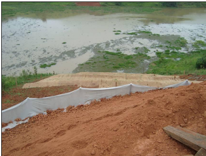
FOTO 2.6.12-20: Contenção de sedimentos com tela-filtro em área com declividade acentuada, próximo ao rio Capivari, km 53+100 (Fonte: Lenc, mar/10).
