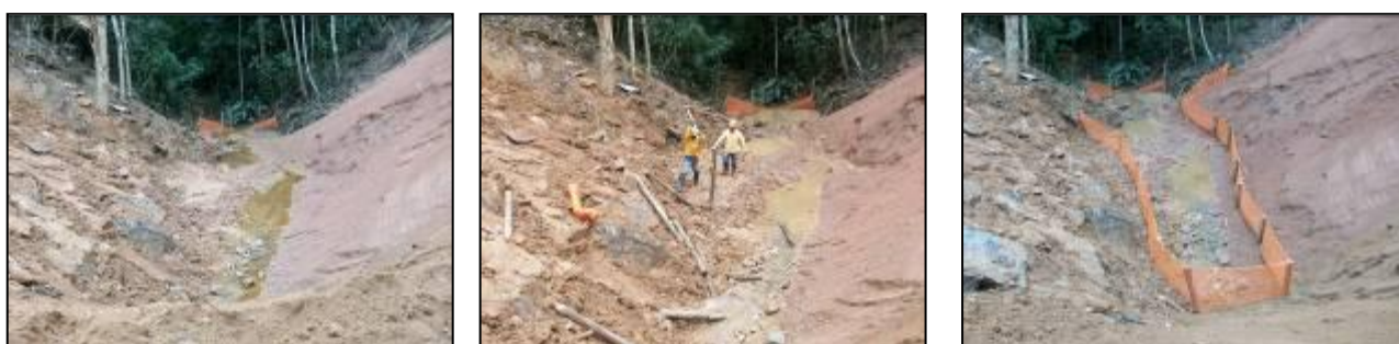
FOTO 2.6.13-63 a 2.6.13-65: Seqüência de fotos, mostrando a limpeza da área e introdução de cerquites, para contenção de sedimentos, km 21+760 (Fonte: Remma Consórcio Gastau, abr/10).
