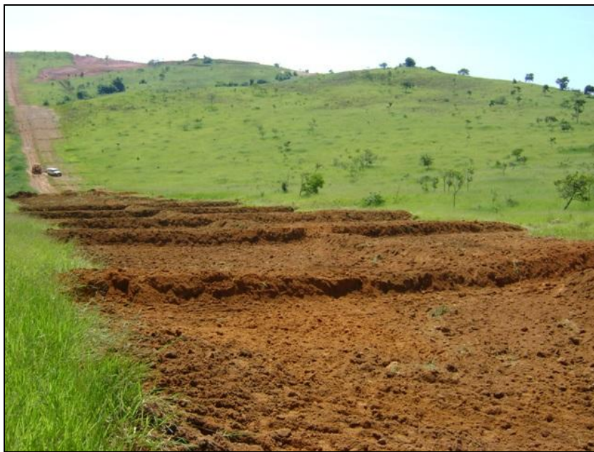
FOTO 2.6.12-42: Leiras definitivas implantadas na faixa, km 70+160 (Fonte: Remma GDK, fev/10).
