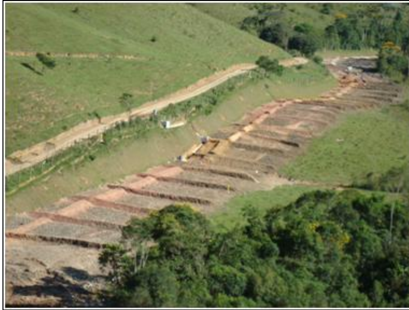
FOTO 2.6.12-31: Recomposição da faixa de servidão, detalhe para as leiras definitivas concluídas, km 12+600 (Fonte: Remma Consórcio Gastau, abr/10).
