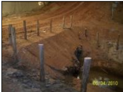
FOTO 2.6.13-7 a 2.6.13-9: Seqüência de fotos, evidenciando contenção de sedimentos em área sensível, sob a cobertura insuflável, no km 11+500 (Fonte: Remma Consórcio Gastau, mai/10).
