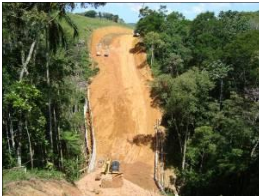
FOTO 2.6.12-5: Terraplenagem no km 22 (Fonte: Remma Consórcio Gastau, fev/10).
