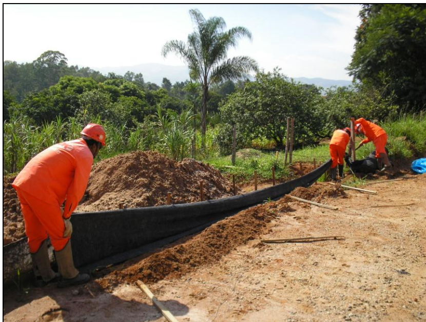
FOTO 2.6.12-22: Instalação de contenção de sedimentos, km 76+160 (Fonte: Remma GDK, jan/10).
