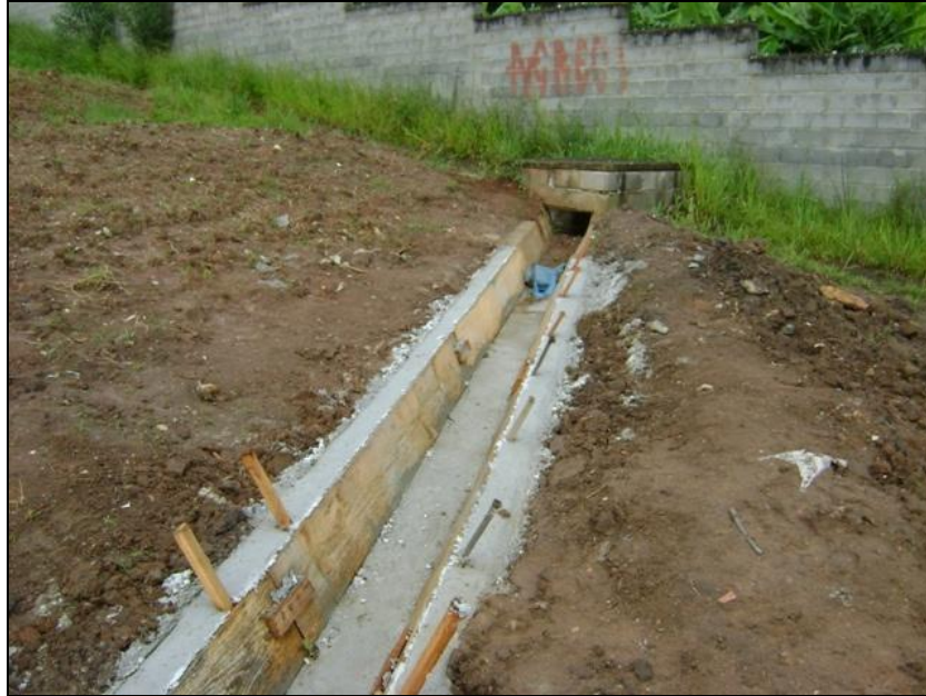
FOTO 2.6.12-29: Construção de canaleta definitiva, km 68+160 (Fonte: Remma GDK, jan/10).
