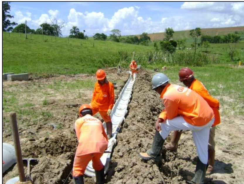
FOTO 2.6.12-30: Construção de canaleta definitiva, km 87+160 (Fonte: Remma GDK, jan/10).
