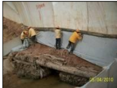
FOTO 2.6.13-7 a 2.6.13-9: Seqüência de fotos, evidenciando contenção de sedimentos em área sensível, sob a cobertura insuflável, no km 11+500 (Fonte: Remma Consórcio Gastau, mai/10).
