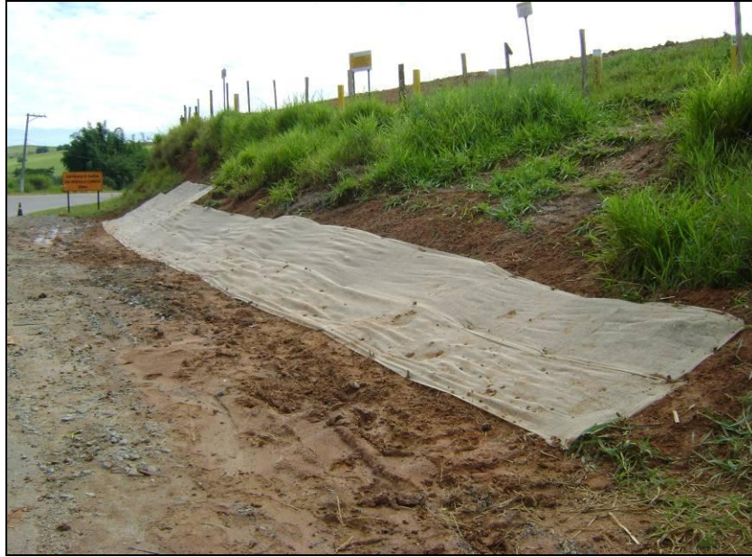
FOTO 2.6.12-86: Exemplo de implantação de biomanta em talude, no km 79+160. (Fonte: Remma GDK, fev/10).
