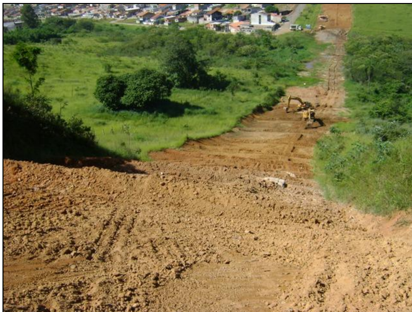
FOTO 2.6.12-40: Construção de leiras definitivas, km 67+160 (Fonte: Remma GDK, fev/10).
