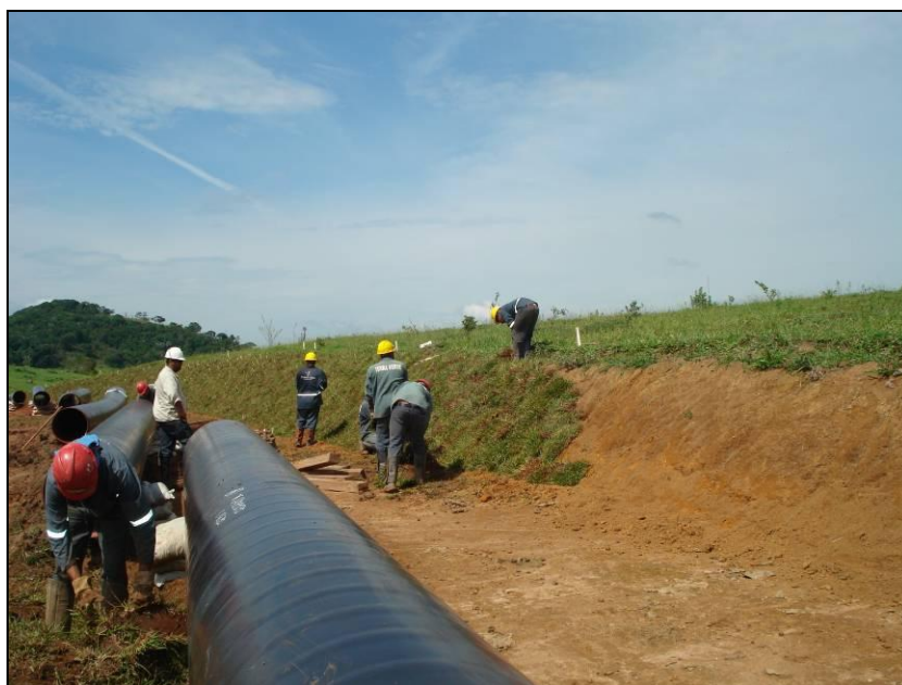
FOTO 2.6.12-85: Exemplo de revegetação de gramas em placa em talude, para impedimento de carreamento de materiais, km 48 (Fonte: Remma Consórcio Gastau, jan/10).
