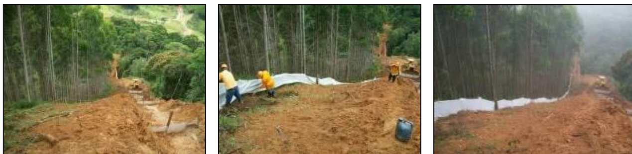
FOTO 2.6.13-66 a 2.6.13-68: Seqüência de fotos, mostrando a situação antes, durante e depois da introdução das estruturas de telas-filtro para contenção de sedimentos em área íngreme, kms 21+780 a 22+200 (Fonte: Remma Consórcio Gastau, mar/10).
