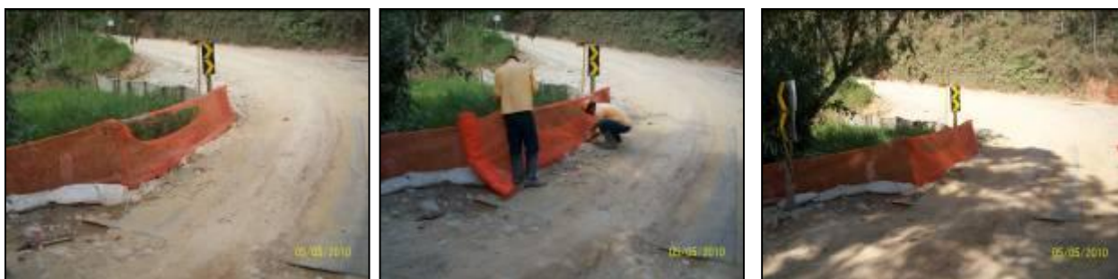
FOTO 2.6.13-26 a 2.6.13-28: Seqüência de fotos, evidenciando a manutenção de contenção de sedimentos no acesso aos Bota Foras 3B e 07. (Fonte: Remma Consórcio Gastau, mai/10).
