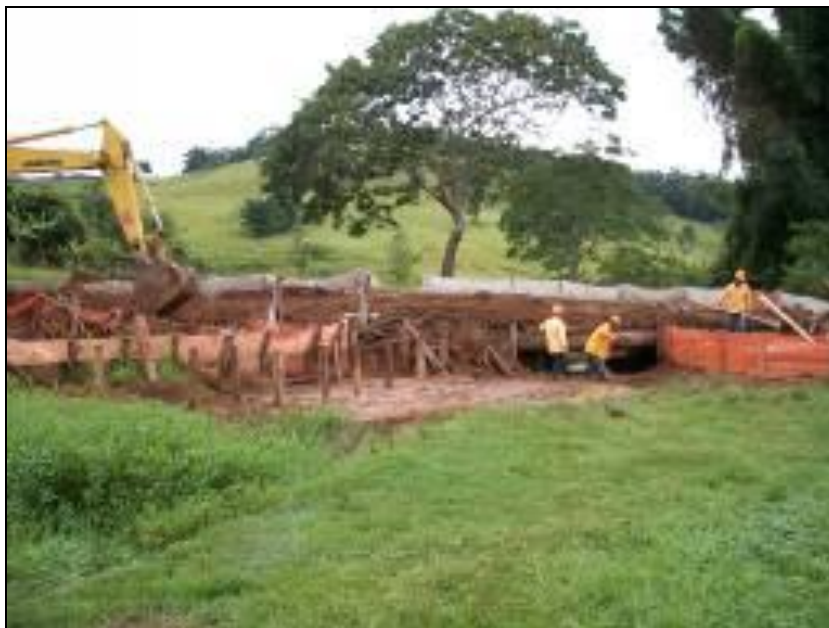
FOTO 2.6.12-12: Contenção lateral de estiva, com telas-filtro e sacarias, km 34 (Fonte: Remma Consórcio Gastau, fev/10).
