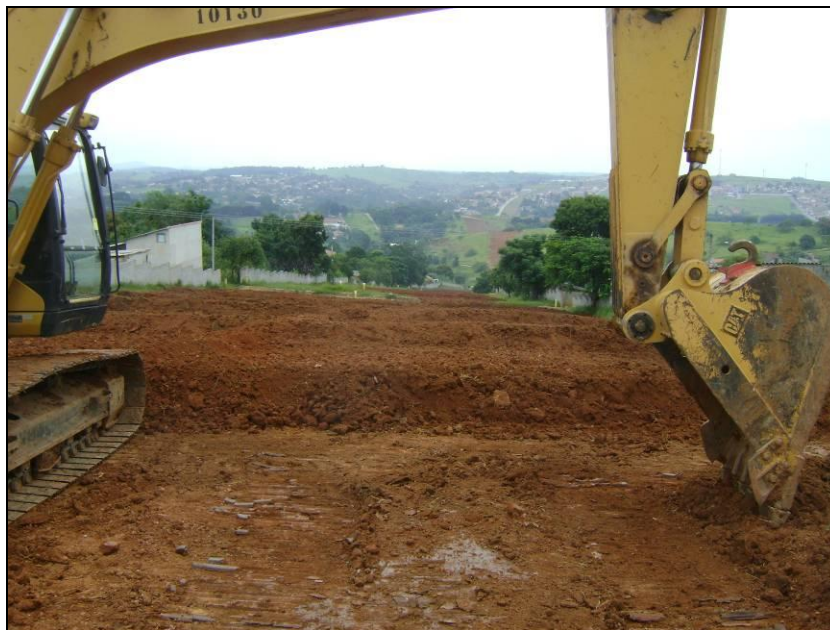
FOTO 2.6.12-43: Construção de leiras definitivas, km 73+160 (Fonte: Remma GDK, jan/10).
