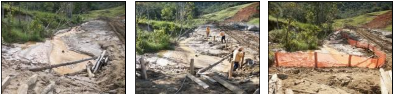
FOTO 2.6.13-54 a 2.6.13-56: Seqüência de fotos, mostrando a limpeza da área e introdução de cerquites, para contenção de sedimentos, km 21+300 (Fonte: Remma Consórcio Gastau, abr/10).
