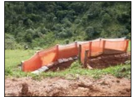
FOTO 2.6.13-70 a 2.6.13-72: Seqüência de fotos, mostrando a manutenção e reparação das estruturas de telas-filtro para contenção de sedimentos, Acesso ao Bota-Fora 19A e km 56 (Fonte: Remma Consórcio Gastau, abr/10).
