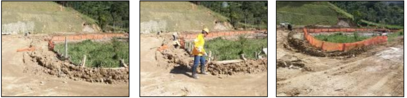
FOTO 2.6.13-51 a 2.6.13-53: Seqüência de fotos, mostrando a manutenção e introdução das telas-filtro para contenção de sedimentos, km 21+300 (Fonte: Remma Consórcio Gastau, abr/10).
